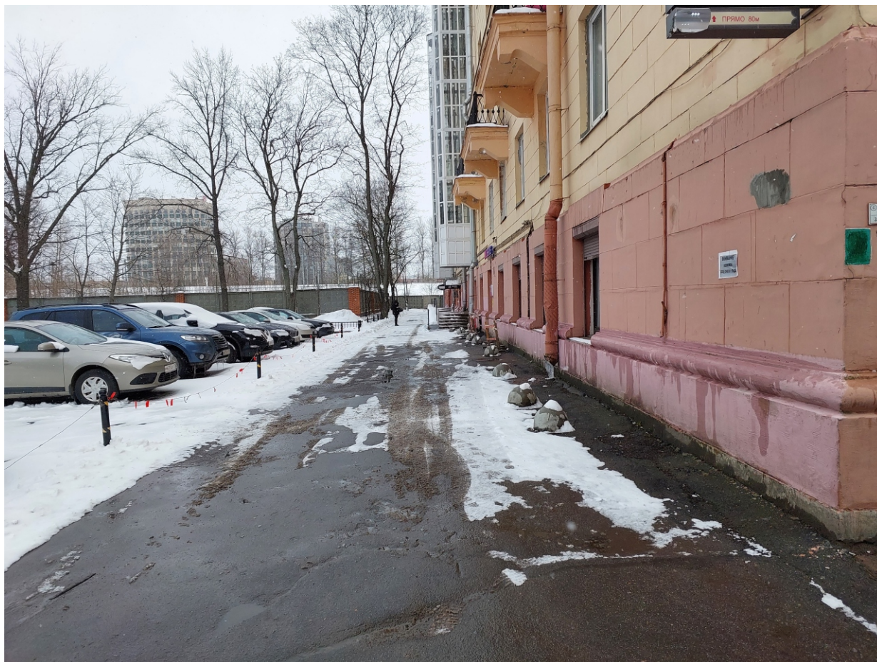
Точка фотофиксации 1. Северная граница территории обследования. Вид с З.
