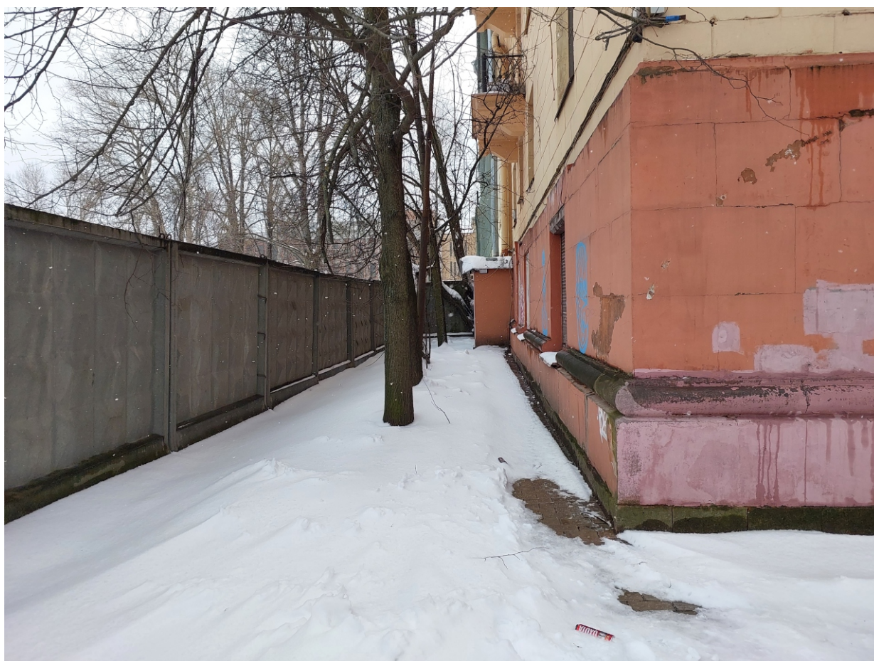
Точка фотофиксации 3. Восточная часть территории обследования. Вид с С.
