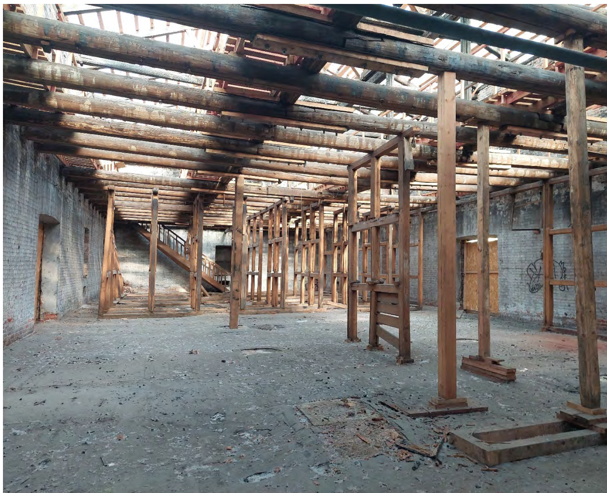
28. Выявленный объект культурного наследия «Комплекс построек Измайловских провиантских складов» по адресу: Санкт-Петербург, Лермонтовский проспект, дом 57-59, лит. А, Б, В, Д. Лит. Б. Общий вид интерьера здания (восточная часть).
