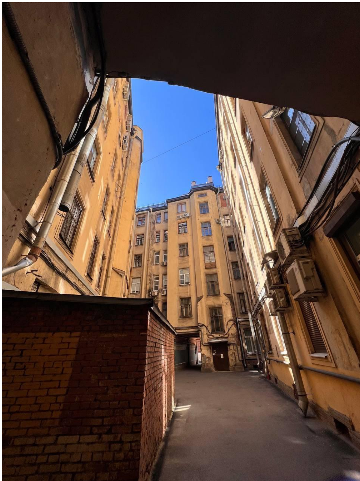
Фото 4. Вид на внутренний северный дворовый фасад.
