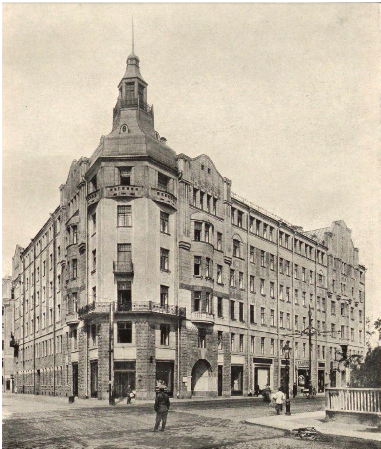
Илл. 21. Вид на угловую часть дома № 54 с юго-востока. Дата: 1912 г. Источник: Ежегодник общества архитекторов-художников, вып. 7, 1912 г.
