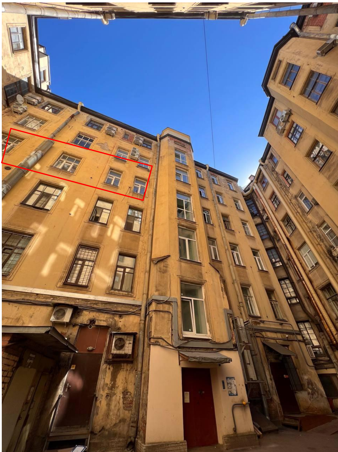
Фото 3. Вид на внутренний западный дворовый фасад.
