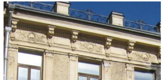
парапетное ограждение крыши- ажурные, кованые звенья с орнаментом растительного характера, расположены между тумбами с профилированным карнизом и штукатурными филенками;
