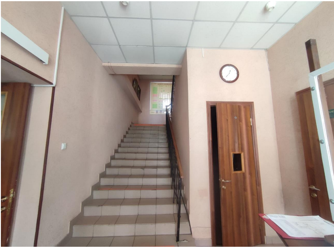
8. Выявленный объект культурного наследия «Народный дом общества попечительства о трезвости», по адресу: Санкт-Петербург, город Павловск, Конюшенная улица, дом 7, литера А. Общий вид пом. 2-Н (1) в уровне 1-го этажа.
