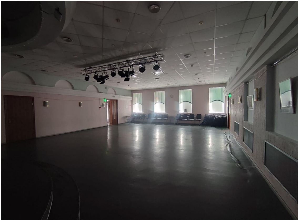
10. Выявленный объект культурного наследия «Народный дом общества попечительства о трезвости», по адресу: Санкт-Петербург, город Павловск, Конюшенная улица, дом 7, литера А. Общий вид пом. 2-Н (2) в уровне 1-го этажа.
