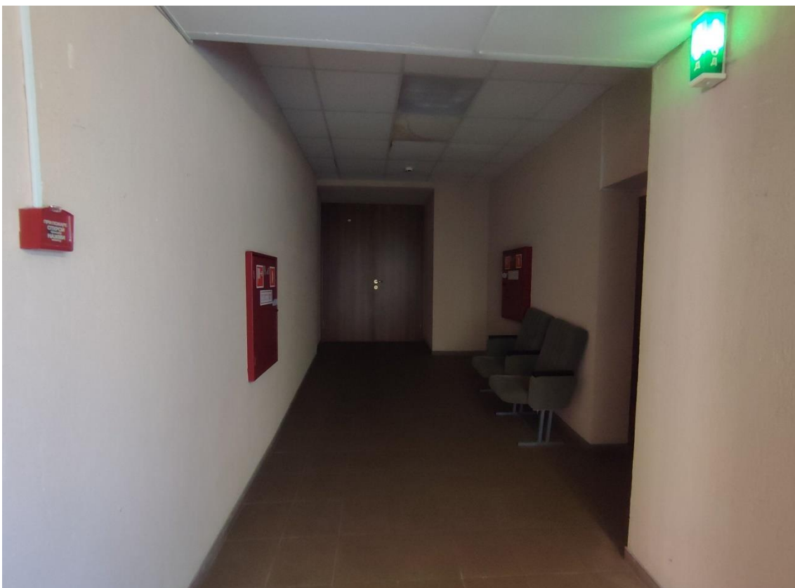
28. Выявленный объект культурного наследия «Народный дом общества попечительства о трезвости», по адресу: Санкт-Петербург, город Павловск, Конюшенная улица, дом 7, литера А. Общий вид пом. 2-Н (28) в уровне 2-го этажа.
