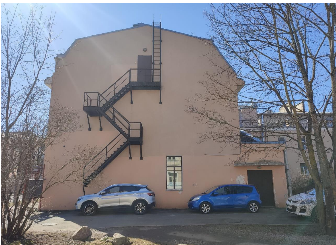
4. Выявленный объект культурного наследия «Народный дом общества попечительства о трезвости», по адресу: Санкт-Петербург, город Павловск, Конюшенная улица, дом 7, литера А. Общий вид северо-восточного торцевого фасада.
