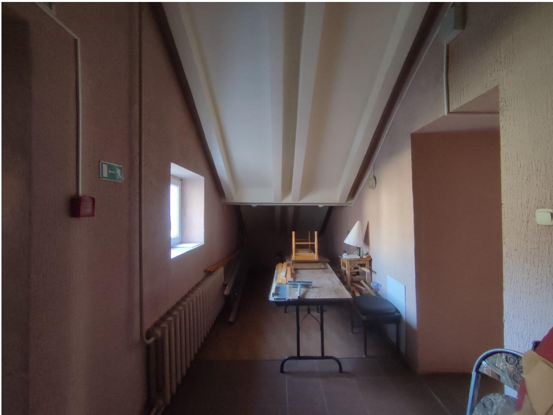
18. Выявленный объект культурного наследия «Народный дом общества попечительства о трезвости», по адресу: Санкт-Петербург, город Павловск, Конюшенная улица, дом 7, литера А. Общий вид пом. 2-Н (23) в уровне 1-го этажа.
