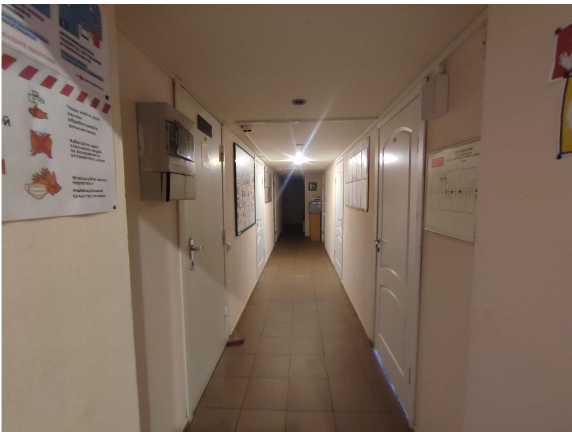
31. Выявленный объект культурного наследия «Народный дом общества попечительства о трезвости», по адресу: Санкт-Петербург, город Павловск, Конюшенная улица, дом 7, литера А. Общий вид пом. 2-Н (42) в уровне мансарды.
