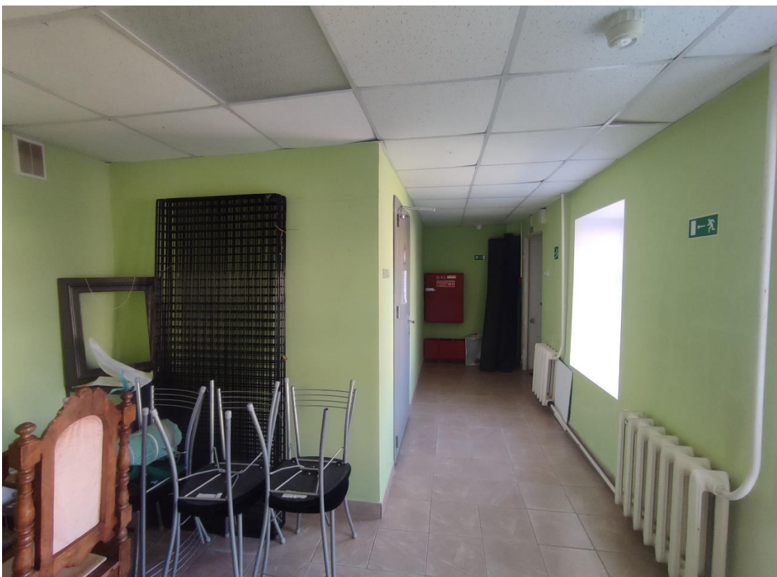
14. Выявленный объект культурного наследия «Народный дом общества попечительства о трезвости», по адресу: Санкт-Петербург, город Павловск, Конюшенная улица, дом 7, литера А. Общий вид пом. 2-Н (9) в уровне 1-го этажа.
