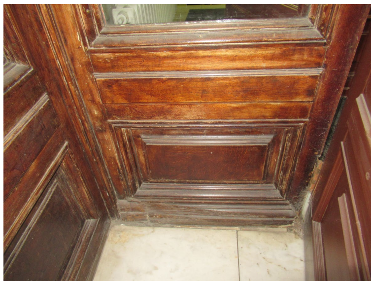
Фото 10. Вид на фрагмент входной группы.
