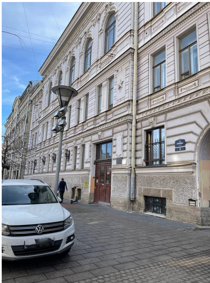
Фото 1. Общий вид главного фасада со стороны ул. Правды.
