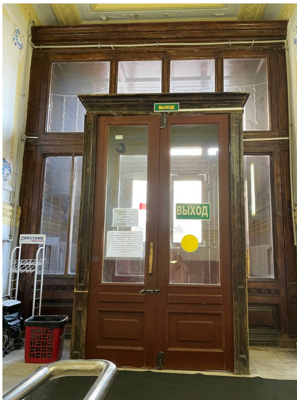
Фото 17. Вид на фрагмент входной группы. Видны несоответствия исторической окраски, отслоение окрасочного слоя, загрязнения.
