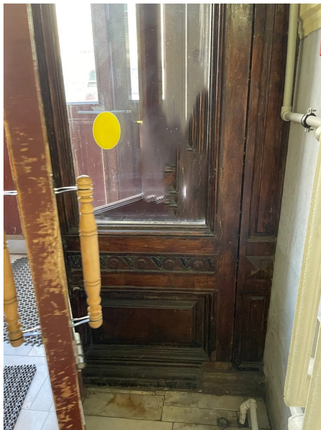
Фото 18. Вид на фрагмент входной группы.
