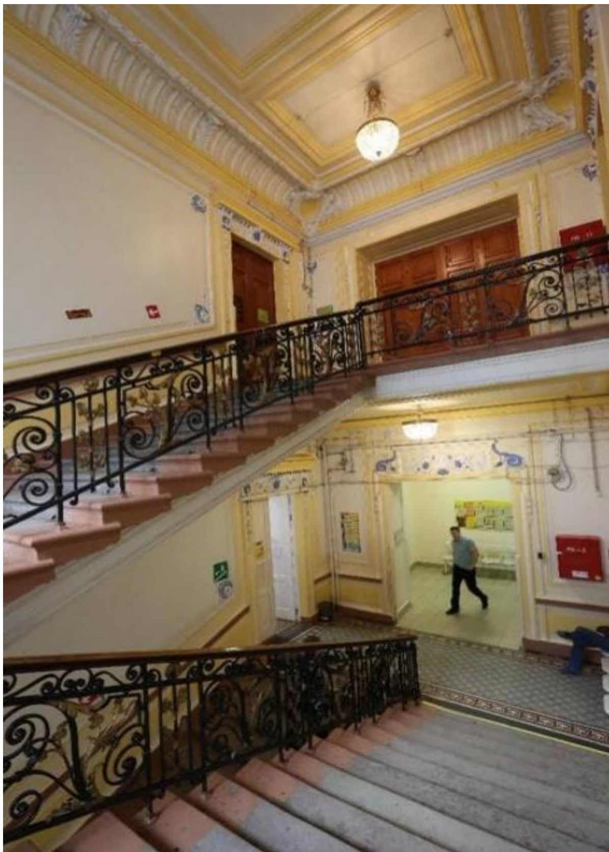
30. Вид на площадки второго и третьего этажей парадной лестницы, фото 2020 г. Акт по результатам ГИКЭ проектной документации на проведение работ по сохранению выявленного объекта культурного наследия «Здание Санкт-Петербургской Губернской Земской управы». СПб., 2020. Раздел «Фотофиксация».
