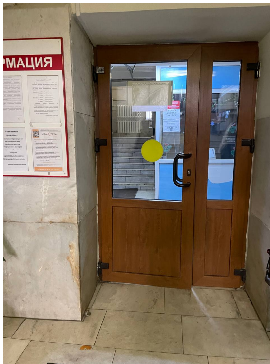
Фото 23. Общий вид помещения.
