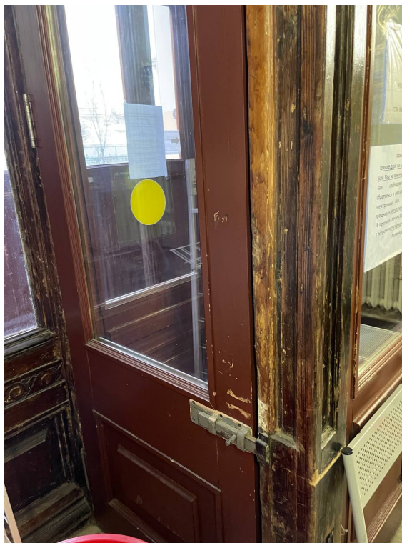
Фото 15. Вид на фрагмент входной группы. Видны несоответствия исторической окраски, отслоение окрасочного слоя, загрязнения.
