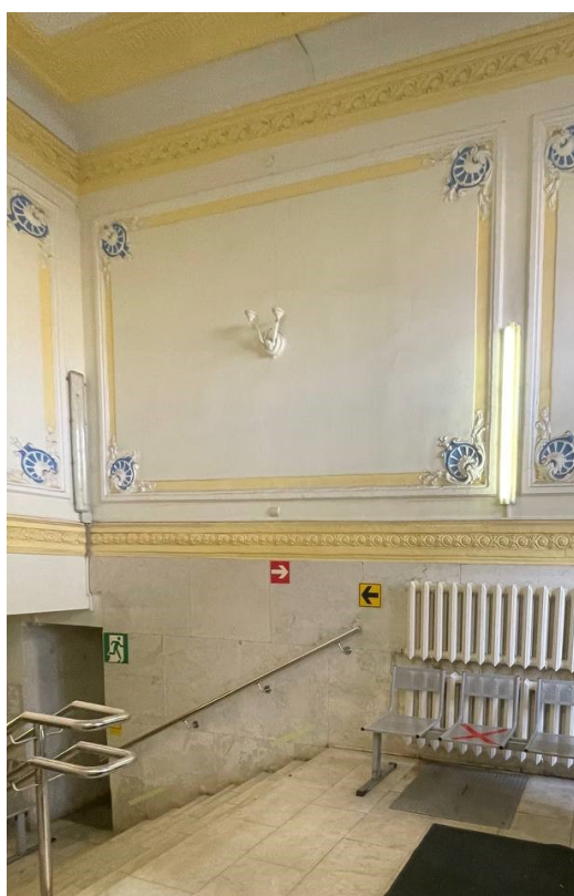
Фото 26. Фрагмент стены по оси 2.
