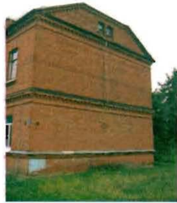
Фото 86. Западный фасад. Общий вид.
