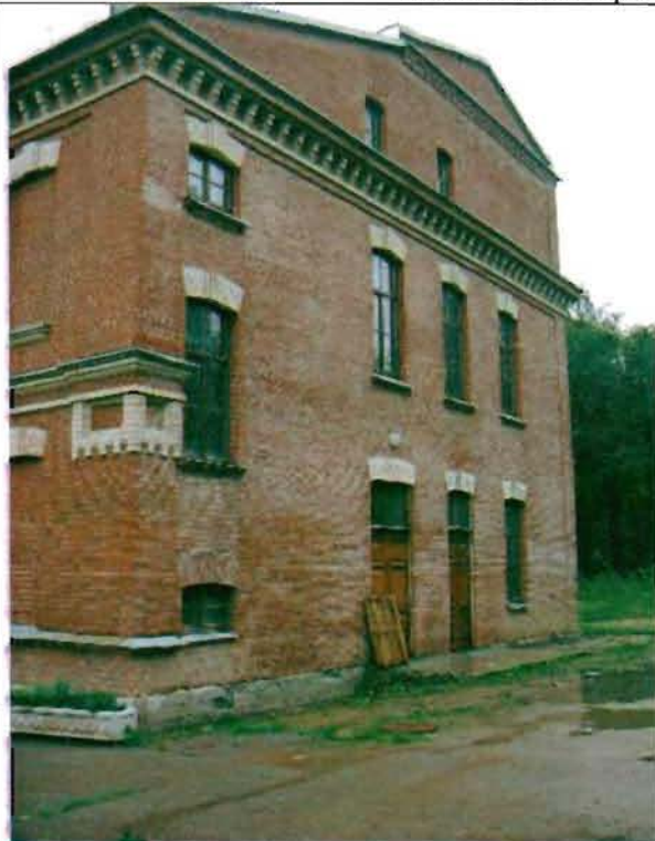
Фото 67. Западный фасад. Общий вид.
