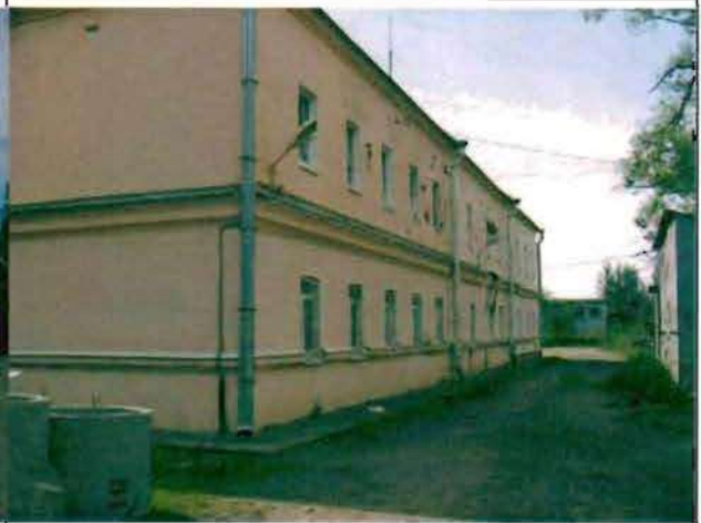
Фото 111. Западный фасад. Общий вид.
