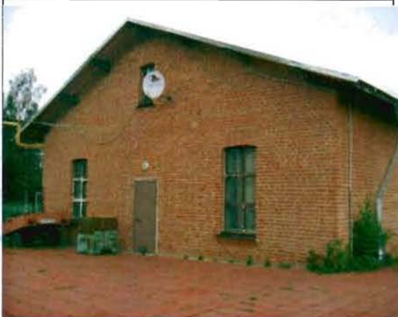
Фото 21. Южный фасад. Общий вид.
