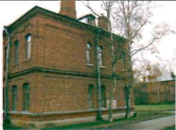
Фото 160. Северный фасад. Общий вид.
