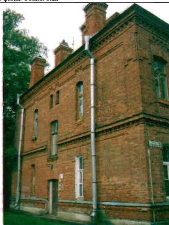
Фото 148. Северный фасад. Общий вид.
