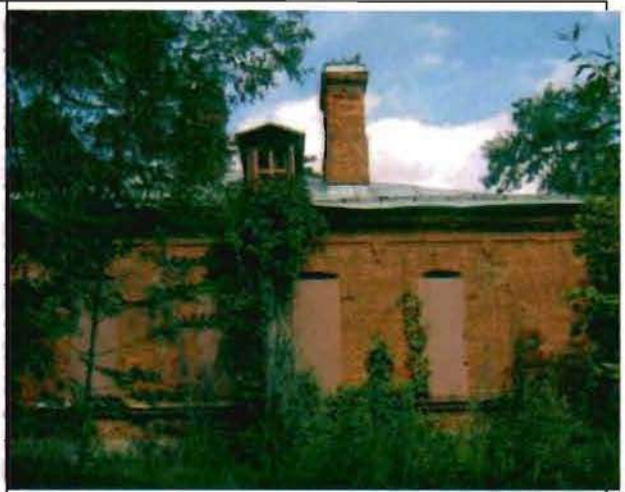
Фото 100. Южный фасад. Фрагмент.
