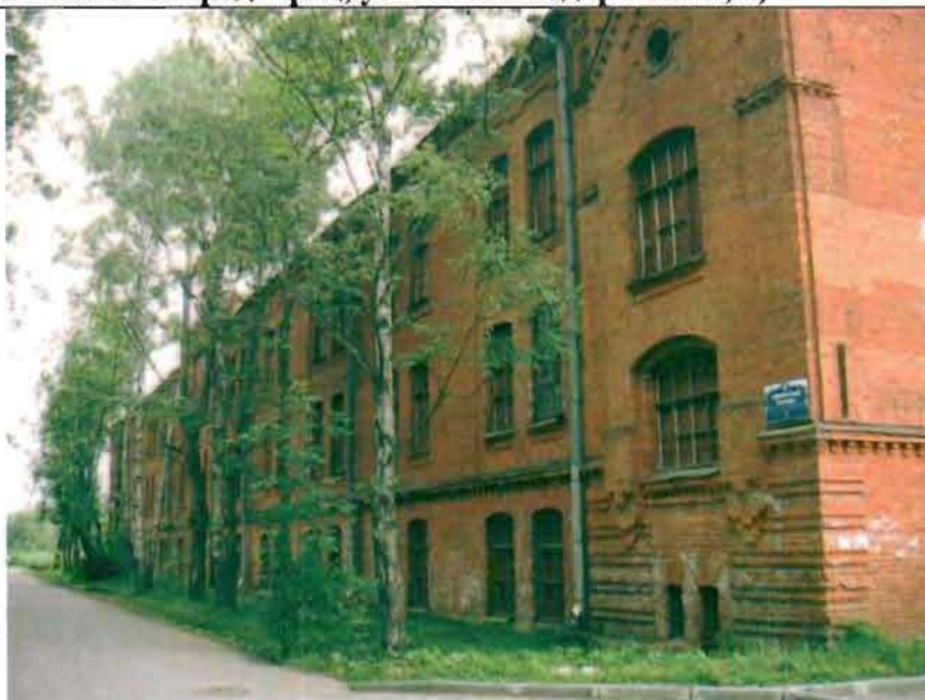
Фото 1. Западный фасад. Общий вид.
