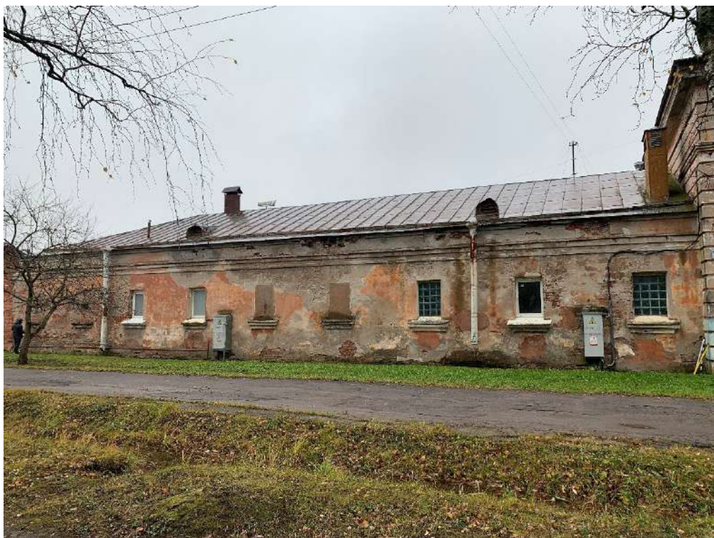
Фото 2. Общий вид фасада по оси А.
