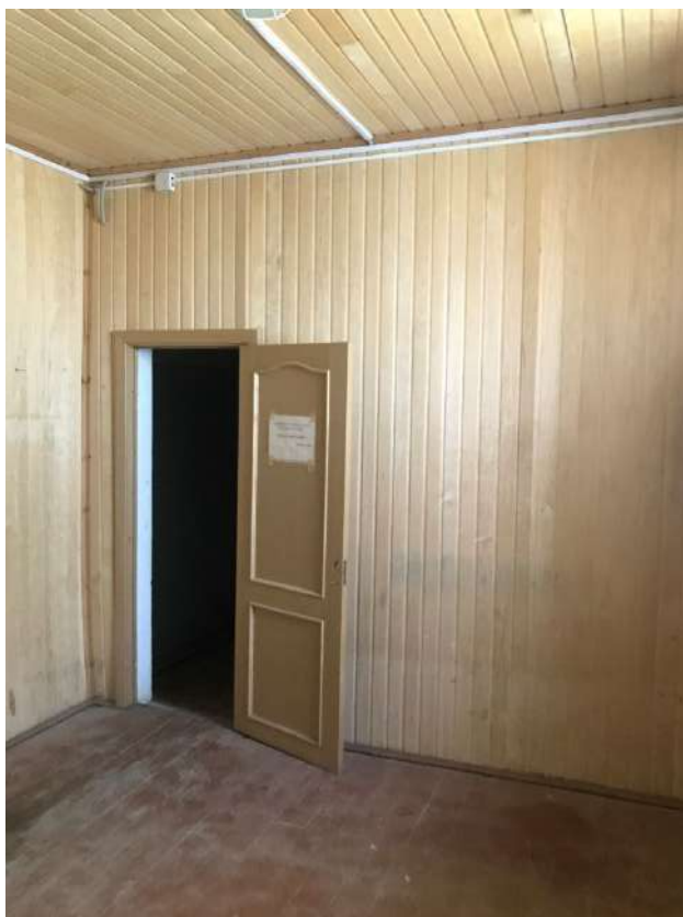
Фото 26. Общий вид помещения №5.
