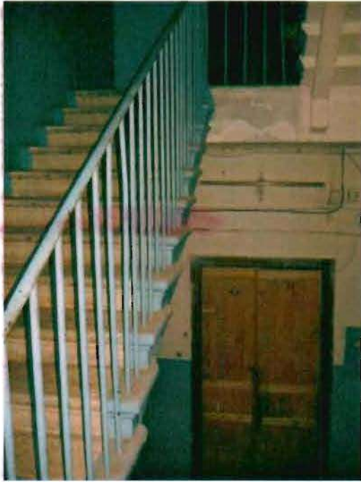
Фото 143. Лестница № 1 в северной части здания. Общий вид.
