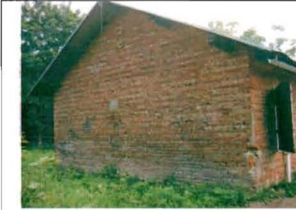
Фото 155. Северный фасад. Общий вид.
