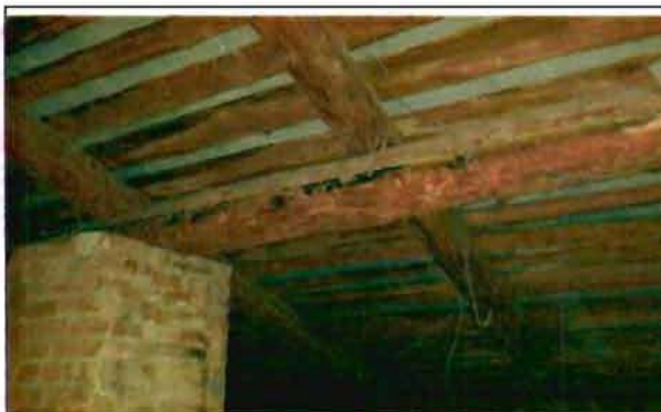
Фото 62. Конструкции крыши. Общий вид.
