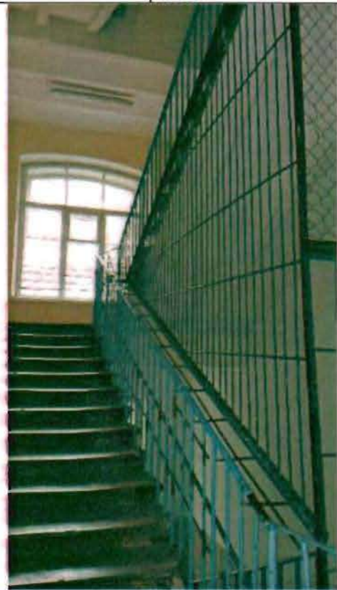
Фото 61. Интерьер. Лестница в южной части здания. Фрагмент.
