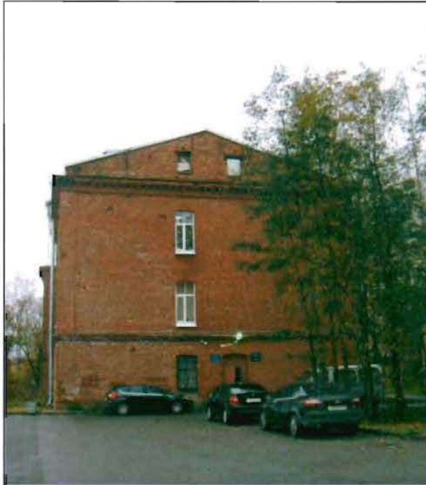
Фото 15. Северный фасад. Общий вид.
