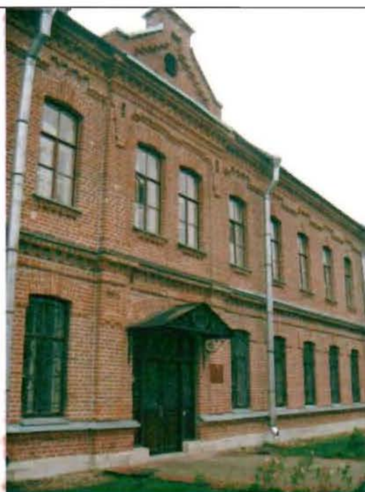
Фото 135. Западный фасад. Фрагмент центральной части фасада.
