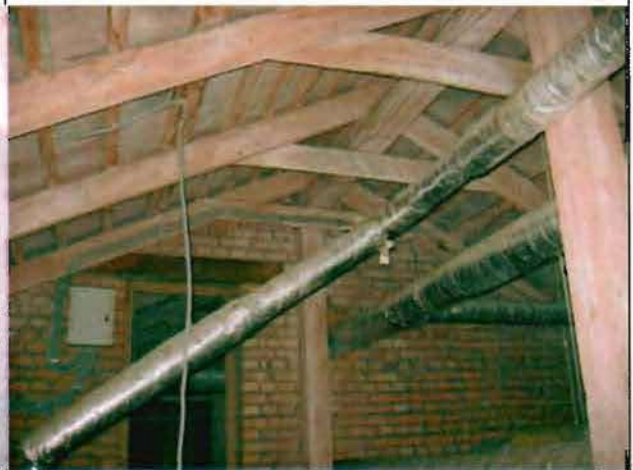
Фото 115. Конструкции крыши. Фрагмент.
