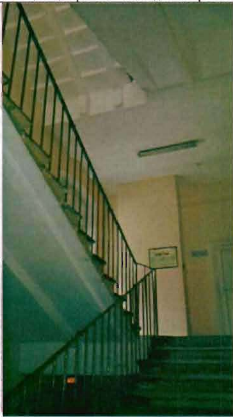
Фото 60. Интерьер. Лестница в южной части здания. Фрагмент.
