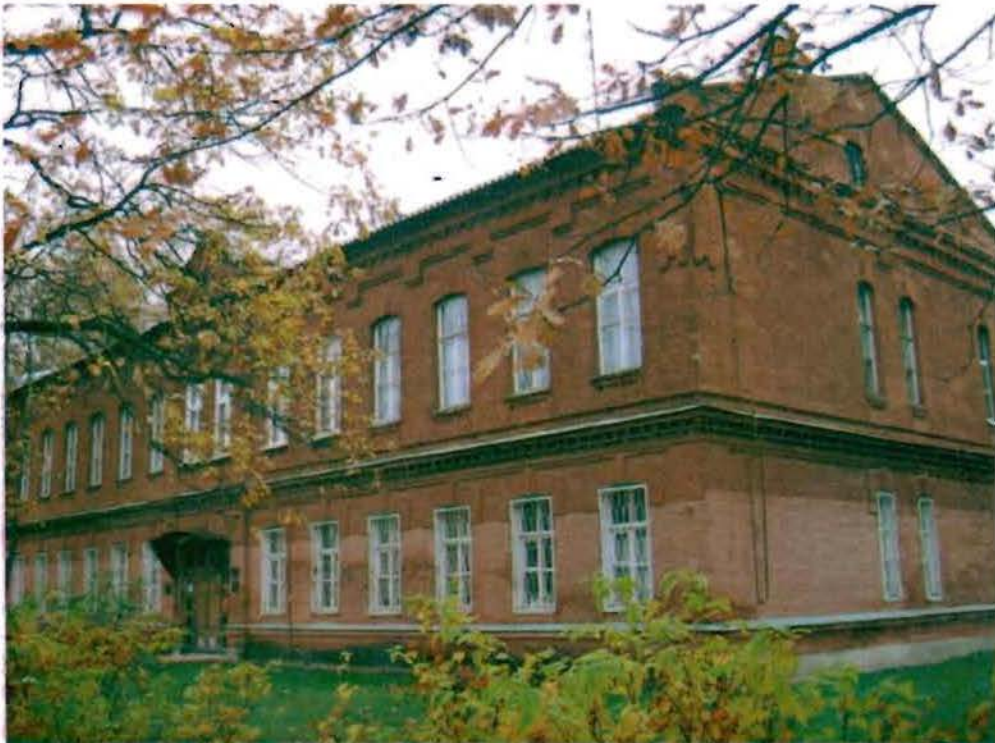
Фото 89. Западный, южный фасады. Общий вид.
