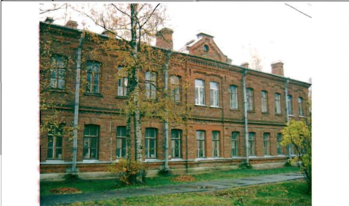
Фото 157. Западный фасад. Общий вид.
