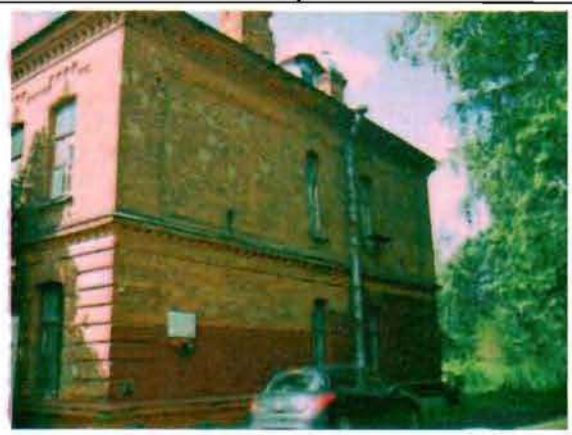
Фото 140. Северный фасад. Общий вид.
