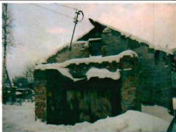
Фото 184. Восточный фасад. Общий вид. 14.01.2015.
