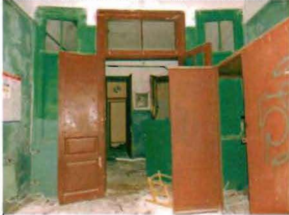
Фото 101. Дверной проем тамбура. Общий вид.
