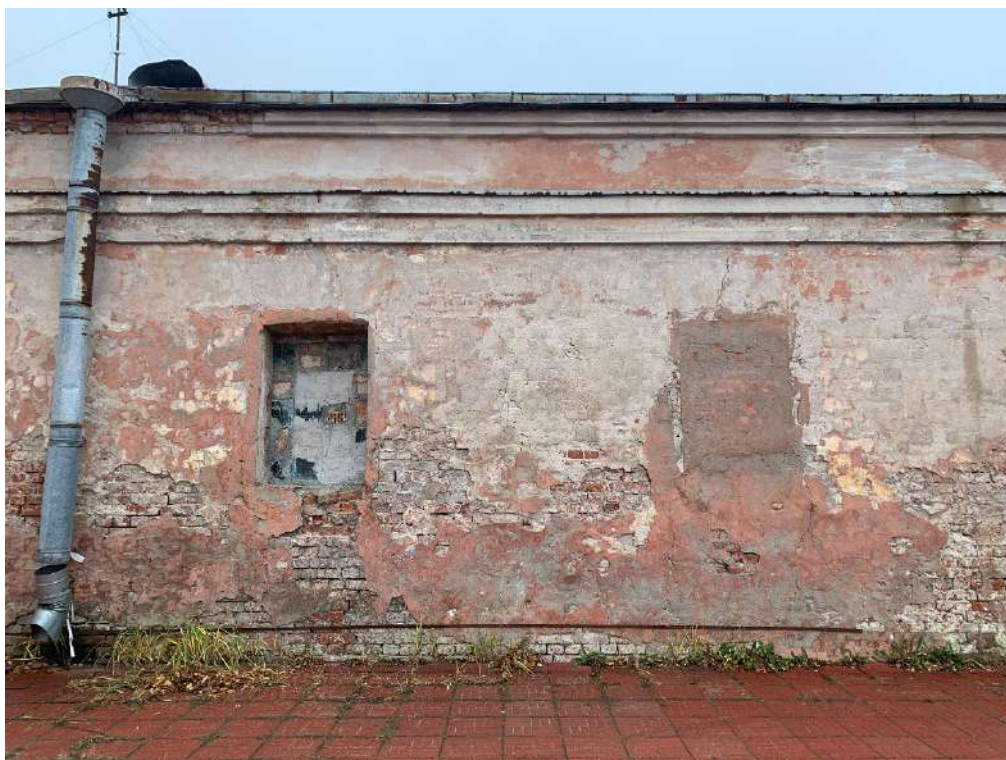
Фото 16. Вид на фрагмент фасада по оси 8.
