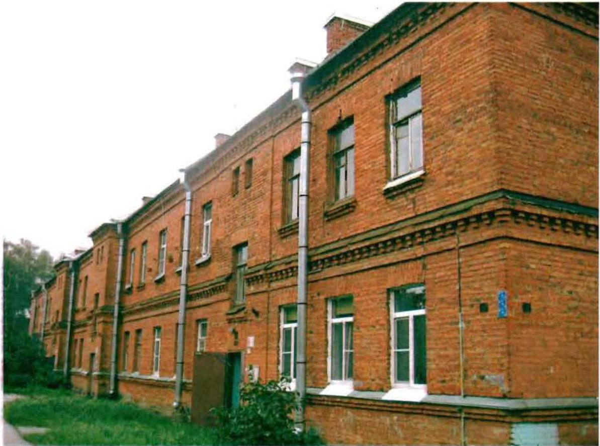
Фото 83. Северный фасад. Общий вид.
