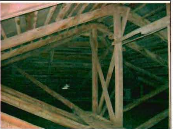
Фото 82. Конструкции крыши. Общий вид.
