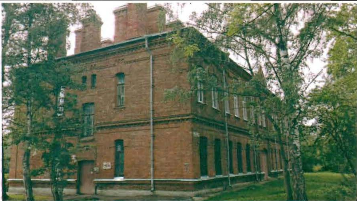
Фото 170. Северный, западный фасады. Общий вид.
