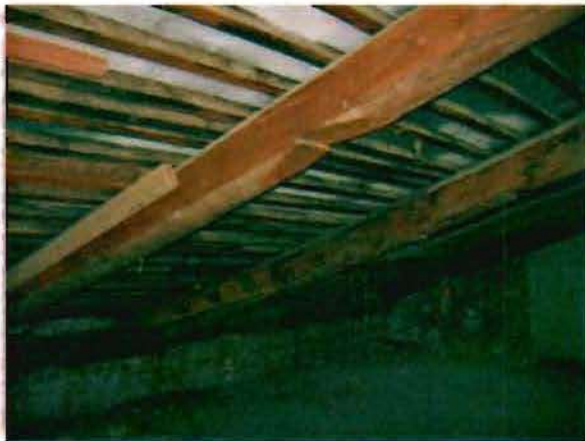
Фото 151. Конструкции крыши. Фрагмент.
