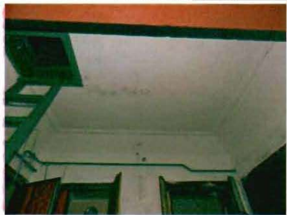
Фото 102. Отделка потолка тамбура. Общий вид.
