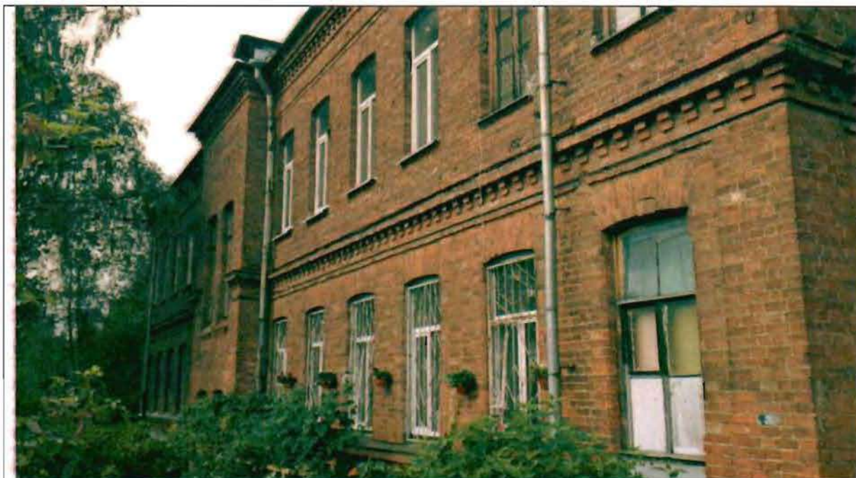
Фото 171. Восточный фасад. Общий вид.
