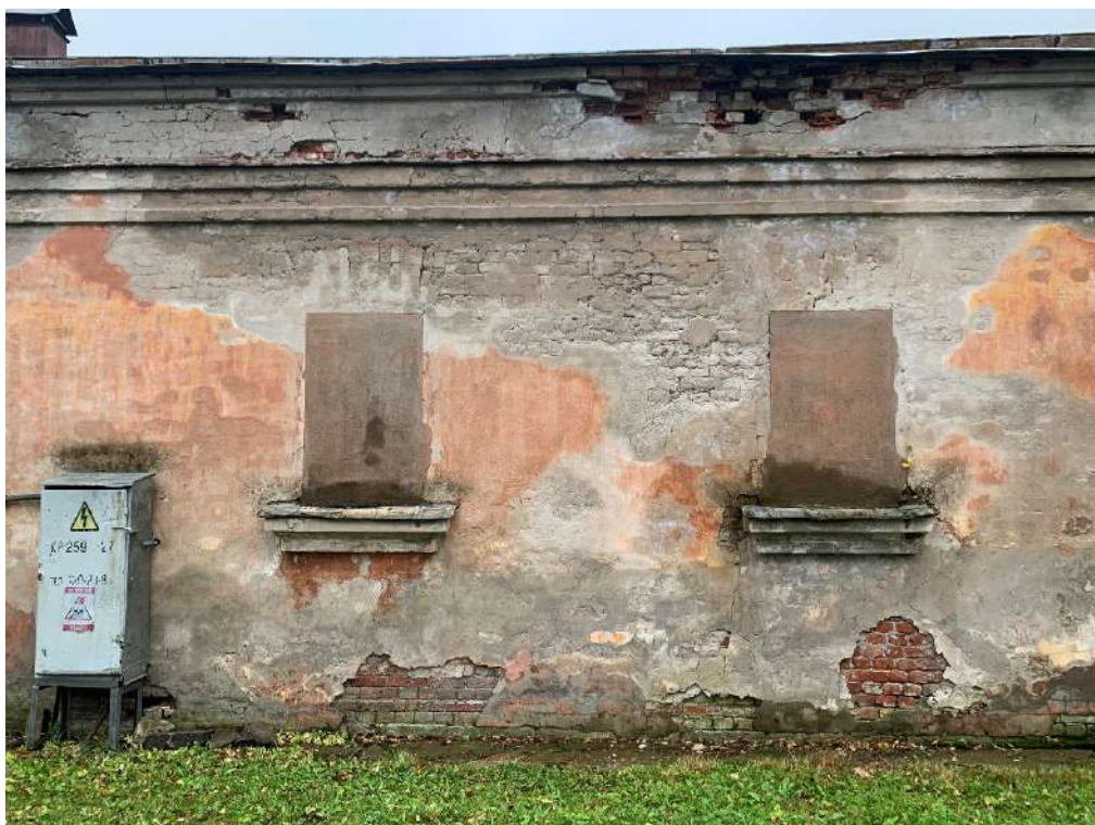
Фото 5. Вид на фрагмент фасада по оси А.
