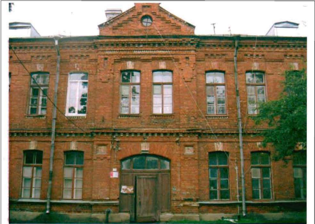
Фото 104. Восточный фасад. Центральная часть. Общий вид.
