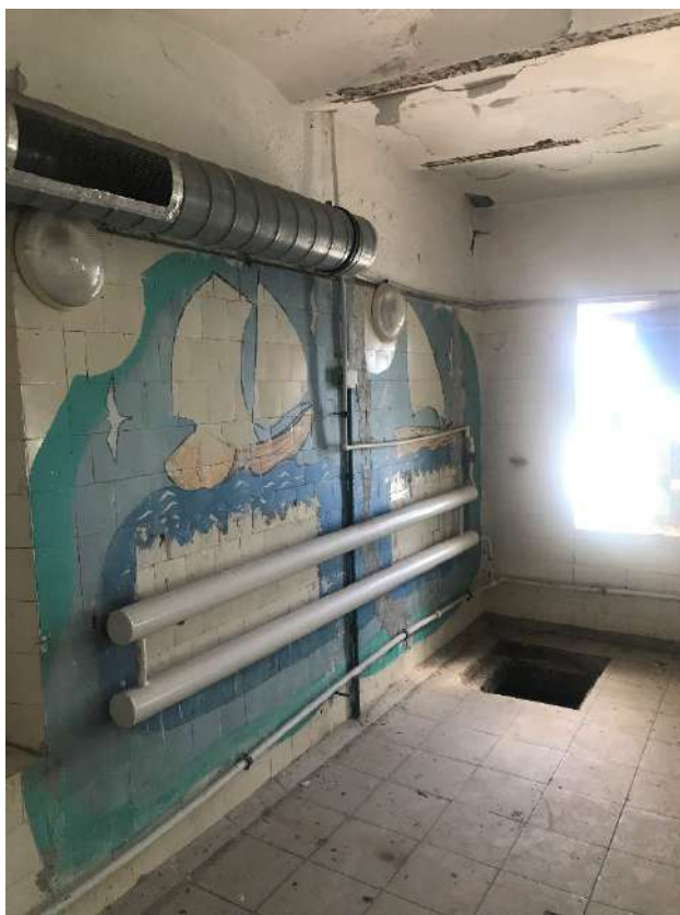
Фото 21. Общий вид помещения №14.
