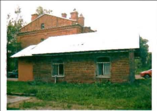
Фото 156. Западный фасад. Общий вид.
