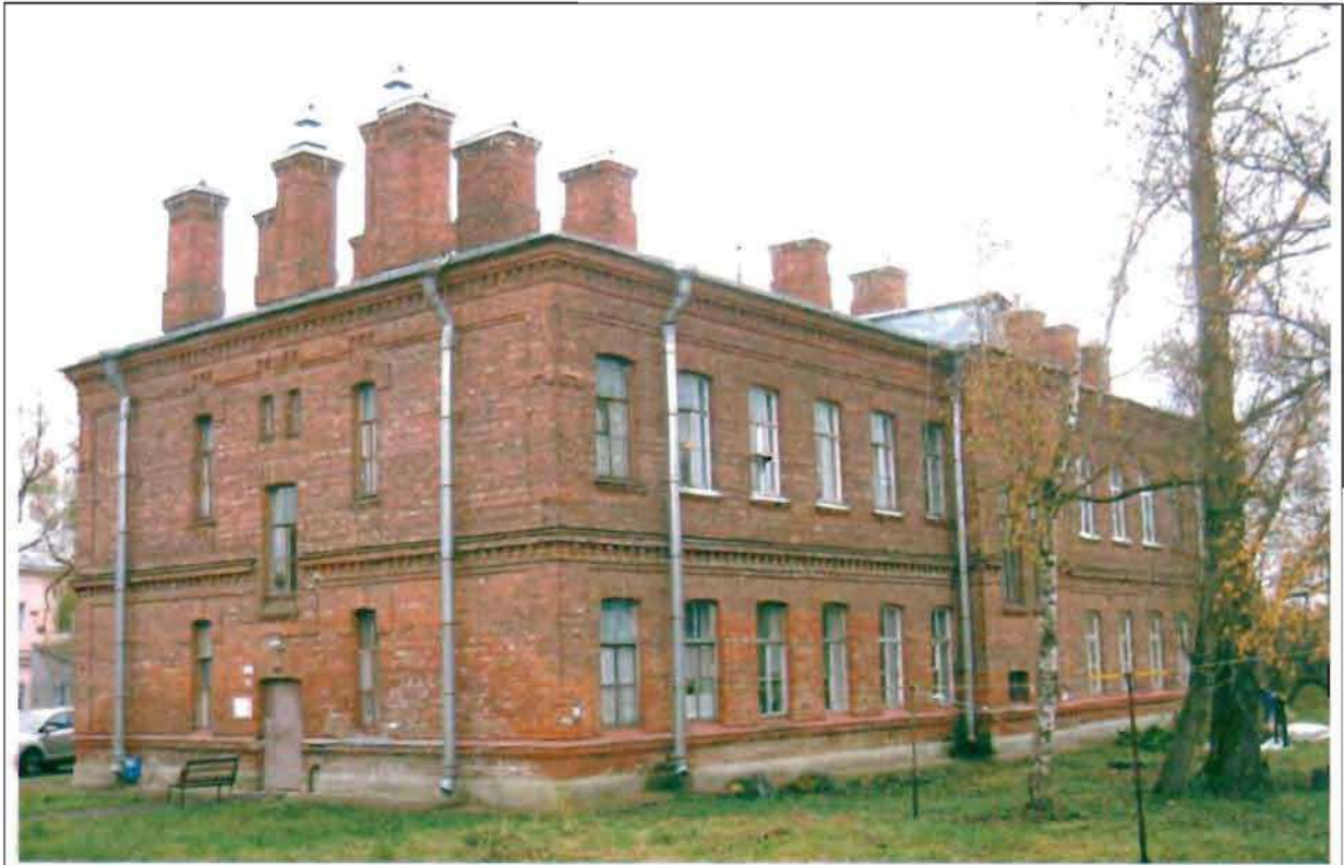
Фото 129. Западный, северный фасады. Общий вид.
