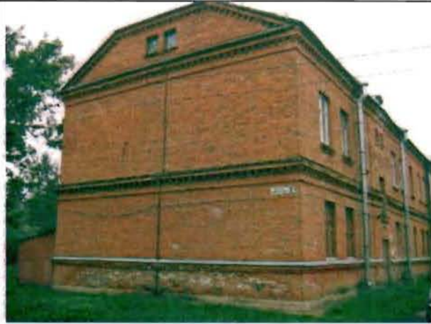
Фото 85. Восточный фасад. Общий вид.
