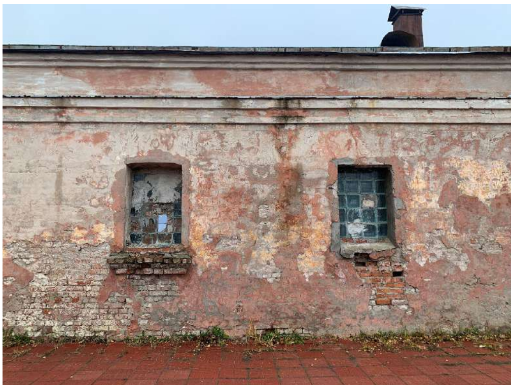
Фото 14. Вид на фрагмент фасада по оси 8.
