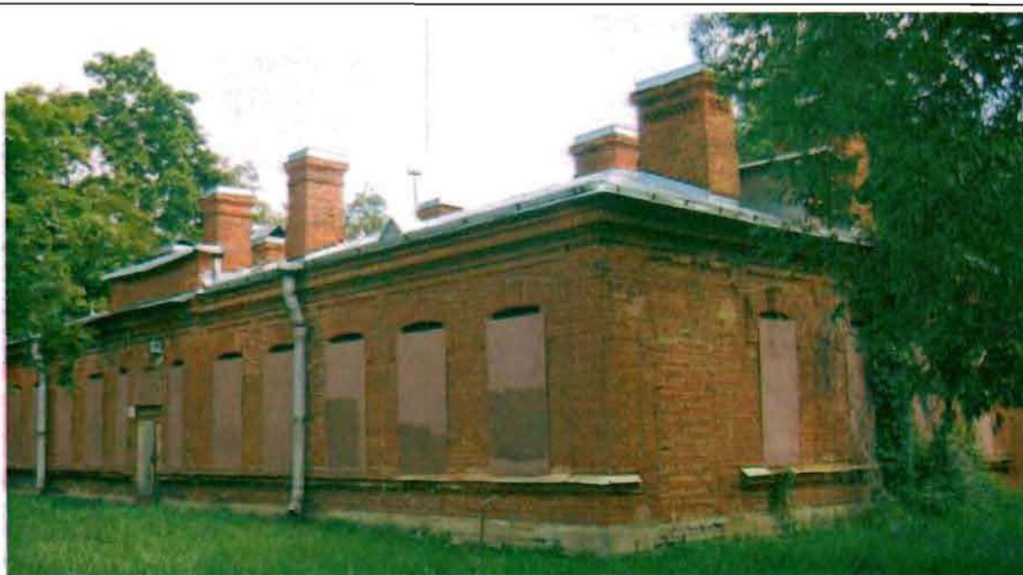
Фото 98. Западный фасад. Общий вид.
