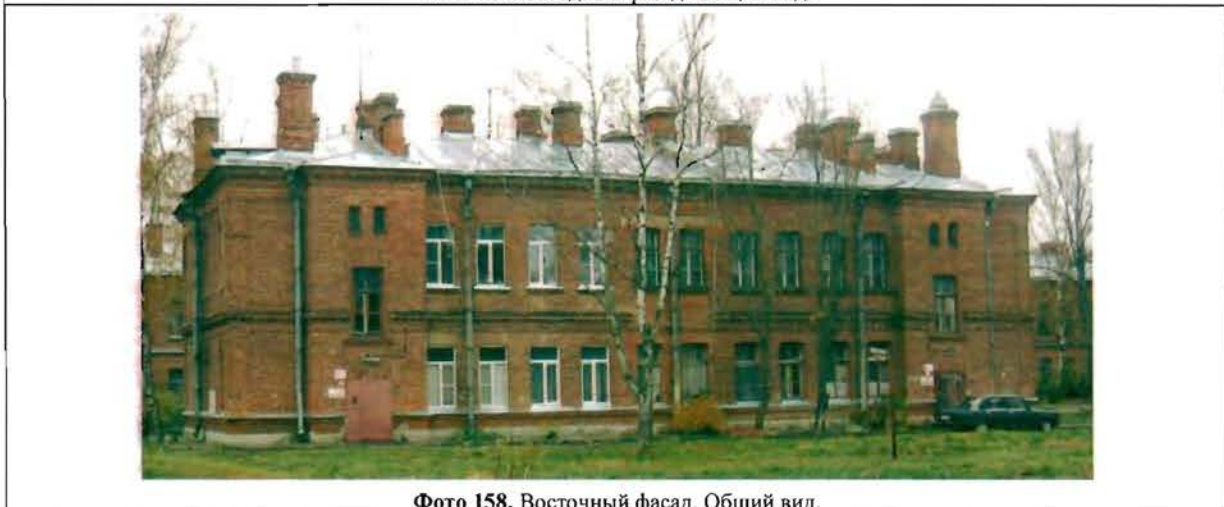
Фото 158. Восточный фасад. Общий вид.
