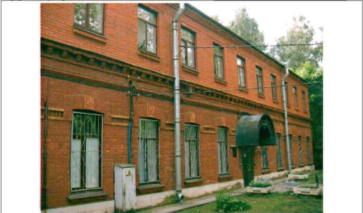
Фото 78. Западный фасад. Общий вид.
