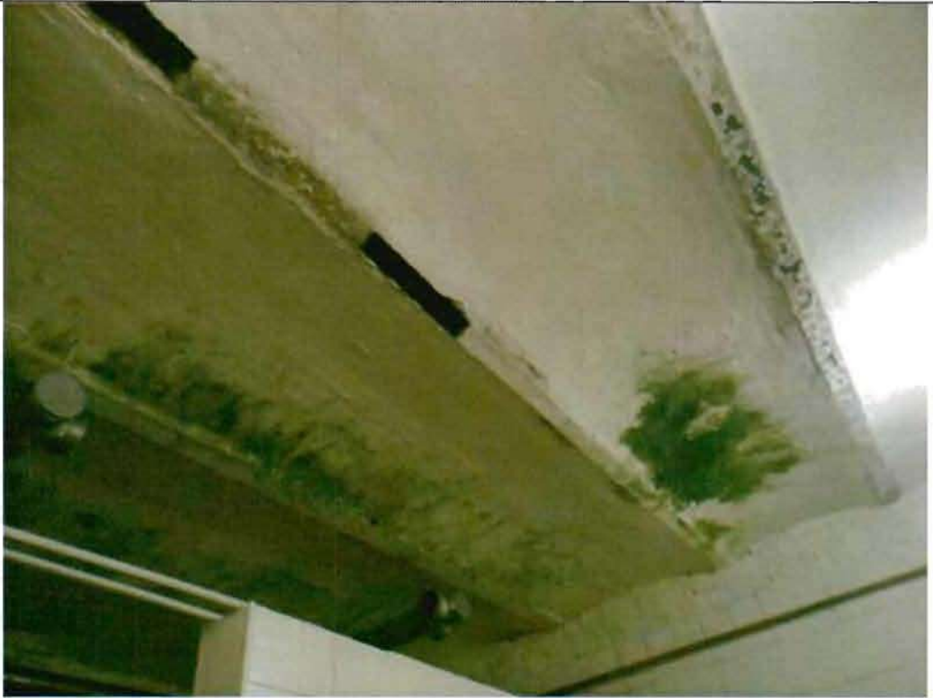
Своды по металлическим балкам. Съемка 27.11.2012, Воронина Н.В.
