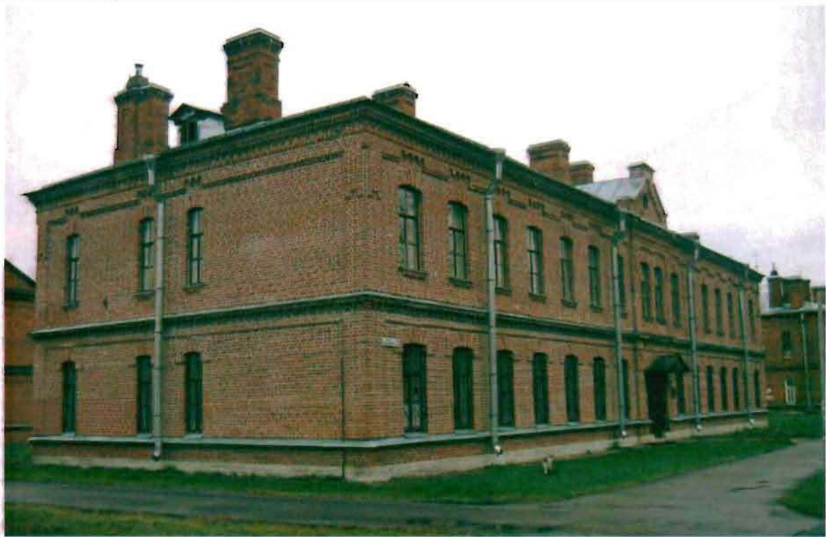
Фото 132. Западный, северный фасады. Общий вид.
