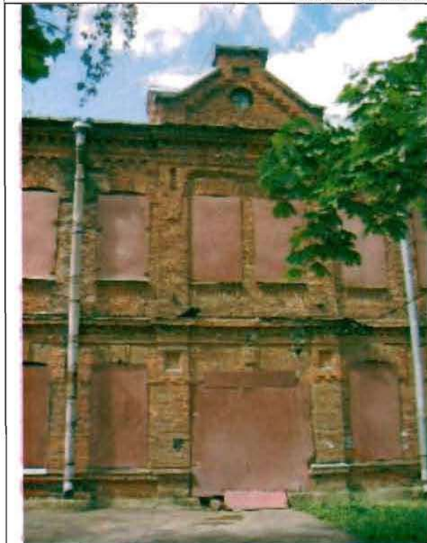
Фото 117. Восточный фасад. Фрагмент центральной части фасада.
