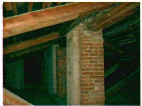
Фото 142. Конструкции крыши. Фрагмент.
