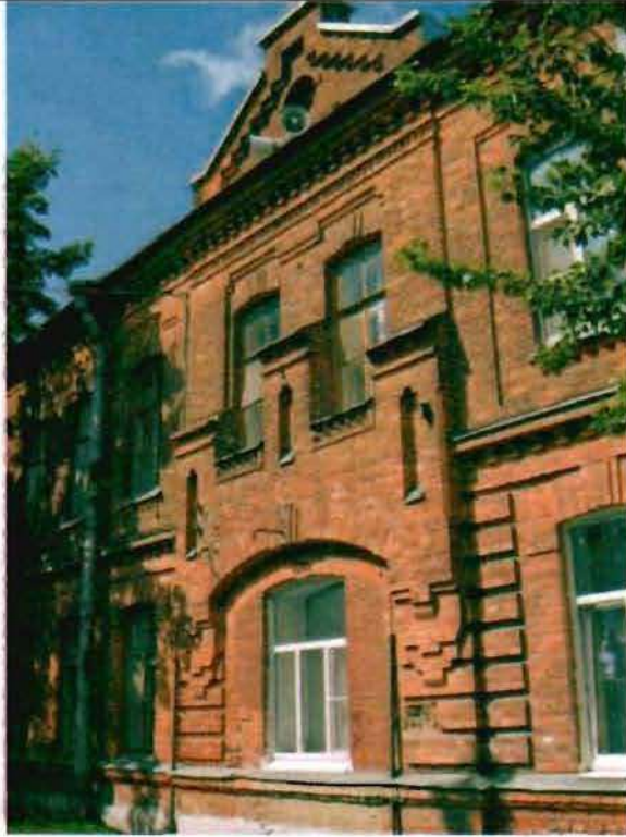
Фото 137. Восточный фасад. Фрагмент.
