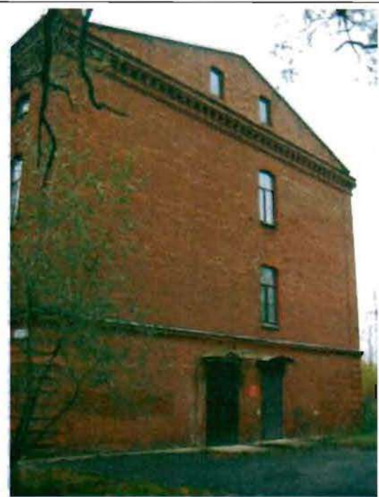
Фото 16. Южный фасад. Общий вид.
