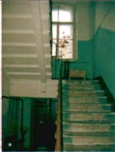
Фото 168. Лестница в южной части здания. Общий вид.
