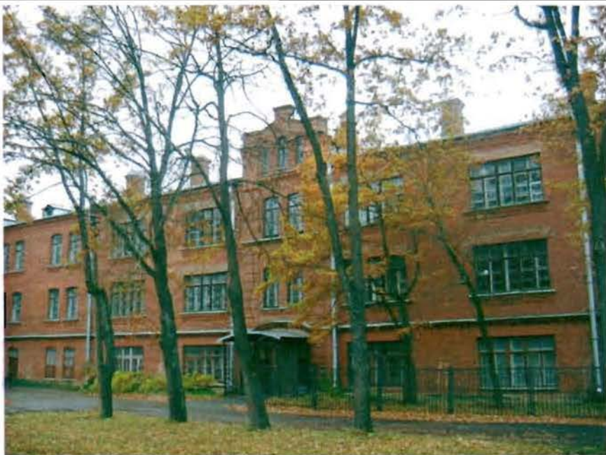
Фото 47. Восточный фасад. Общий вид.
