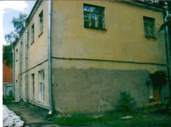
Фото 45. Южный, западный фасад. Общий вид.
