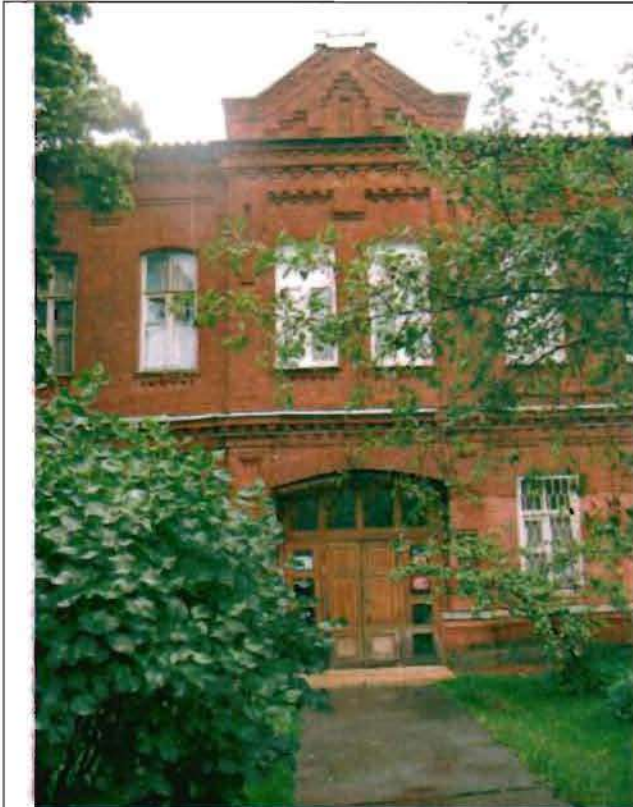
Фото 90. Восточный фасад. Центральная часть. Общий вид.
