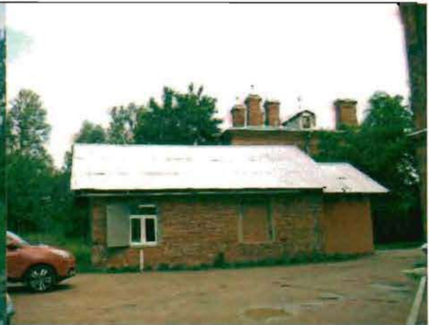
Фото 154. Южный фасад. Общий вид.
