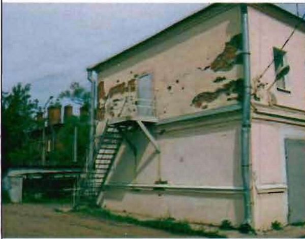
Фото 112. Южный фасад. Общий вид.
