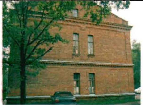
Фото 167. Северный фасад. Общий вид.
