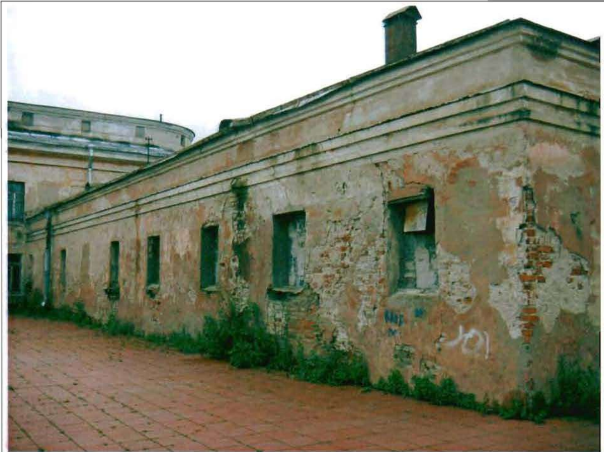
Фото 25. Восточный фасад. Общий вид.
