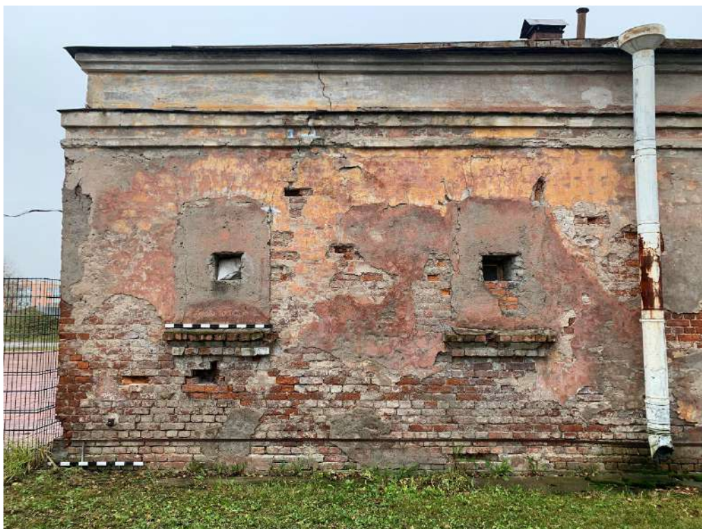
Фото 7. Вид на фрагмент фасада по оси А.
