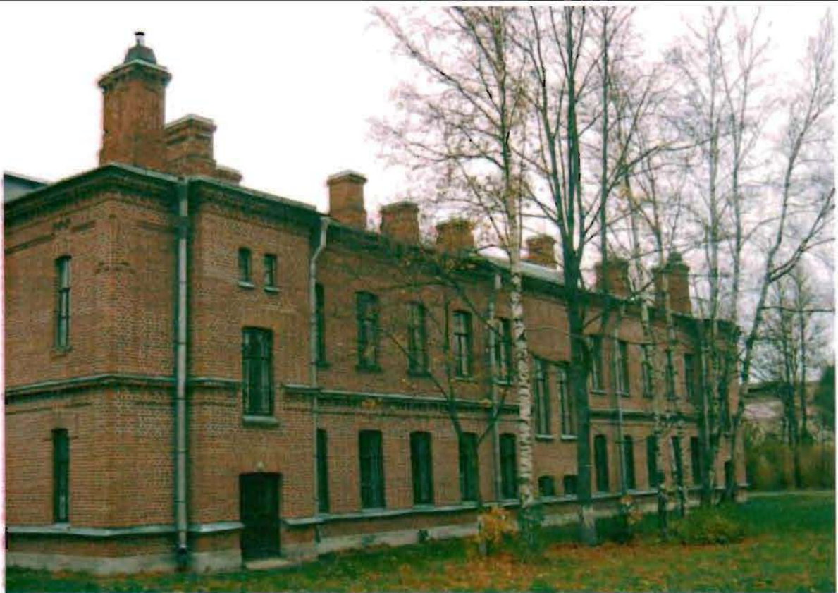
Фото 133. Восточный фасад. Общий вид.
