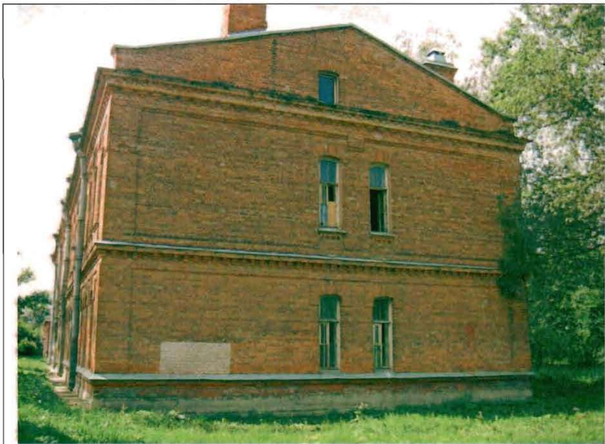
Фото 180. Северный фасад. Общий вид.
