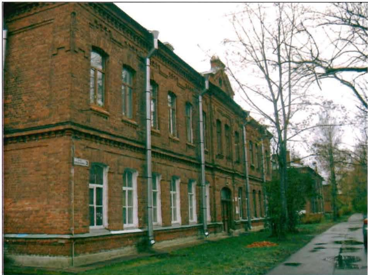
Фото 146. Западный фасад. Общий вид.
