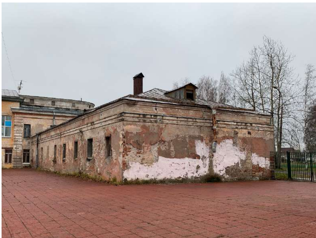
Фото 11. Общий вид фасада по оси 1.
