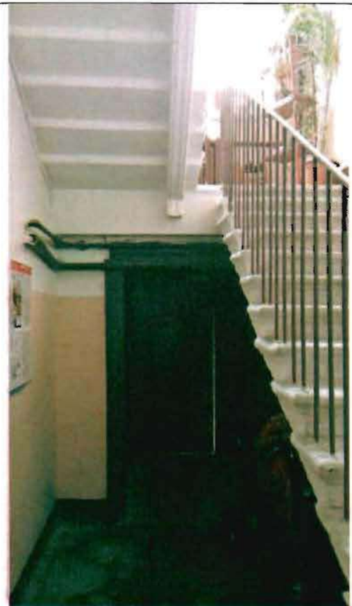
Фото 131. Лестница № 2 в северной части здания. Общий вид.
