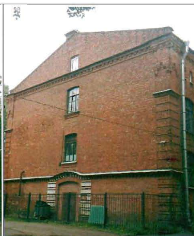
Фото 50. Южный фасад. Общий вид.
