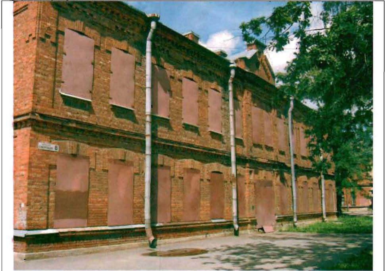
Фото 116. Восточный фасад. Общий вид.
