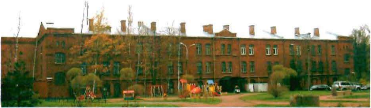
Фото 28. Восточный фасад. Общий вид.
