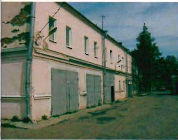
Фото 110. Восточный фасад. Общий вид.
