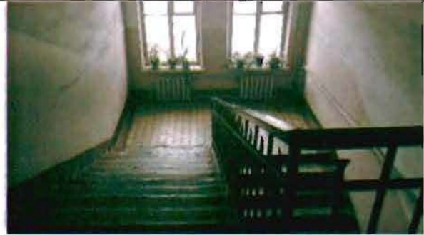
Фото 34. Интерьер. Лестница. Общий вид.
