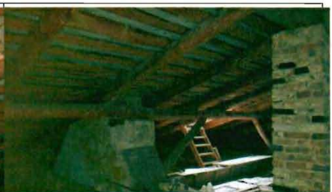
Фото 63. Конструкции крыши. Общий вид.
