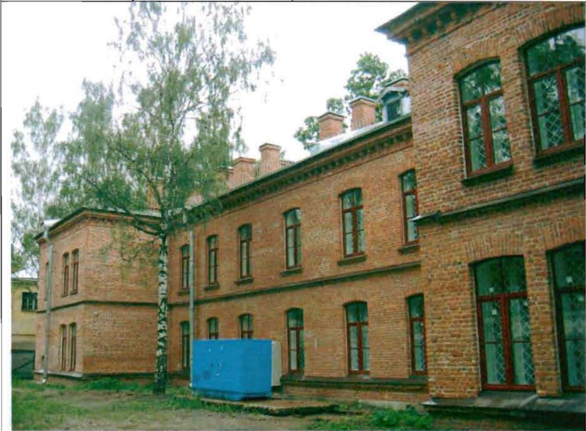
Фото 42. Западный фасад. Общий вид.
