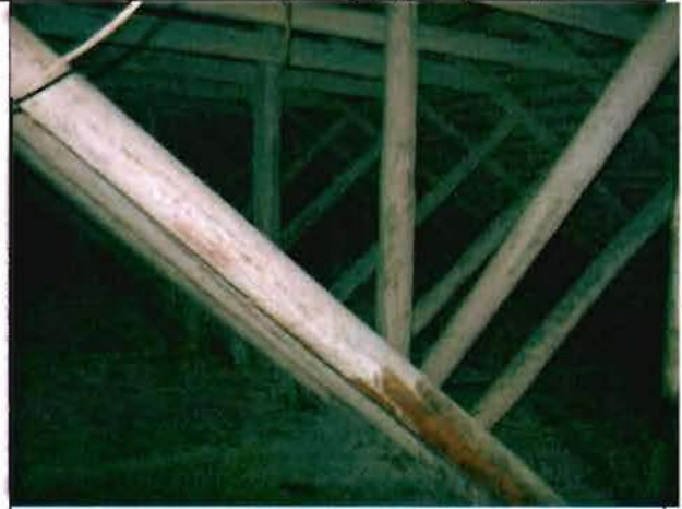
Фото 88. Конструкции крыши. Общий вид.
