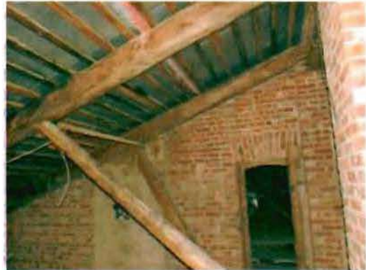
Фото 127. Конструкции крыши. Общий вид.
