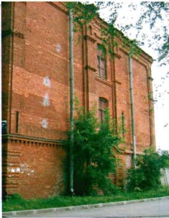
Фото 5. Южный фасад. Общий вид.
