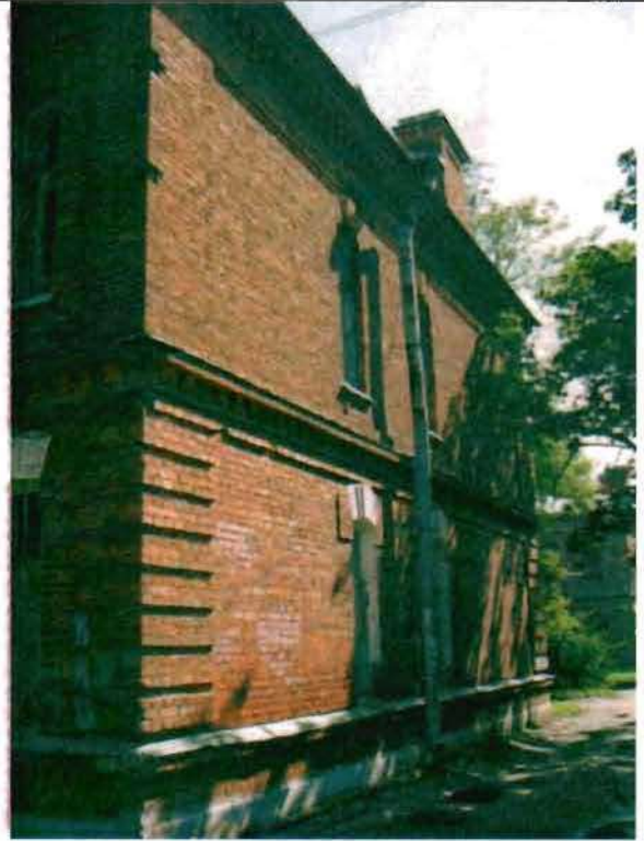
Фото 138. Южный фасад. Общий вид.
