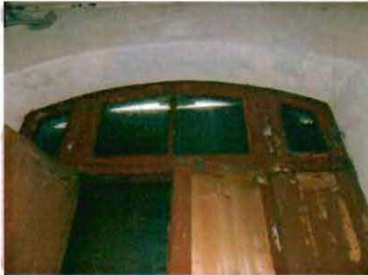
Фото 126. Дверное заполнение центральной части лестницы. Фрагмент.
