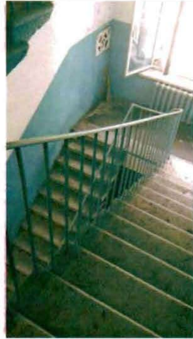
Фото 144. Лестница № 2 в южной части здания. Общий вид.
