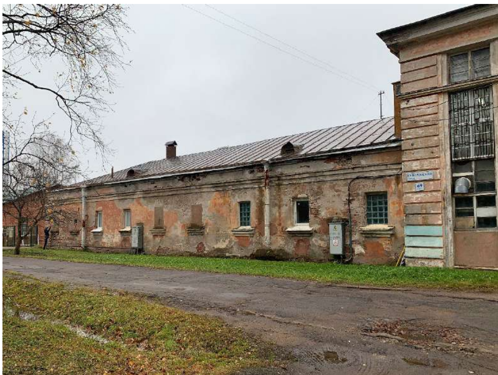
Фото 1. Общий вид фасада по оси А.
