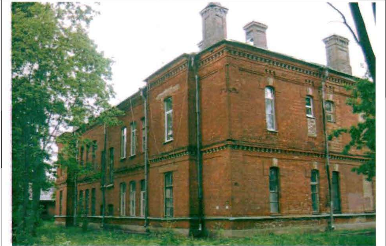
Фото 105. Западный, южный фасады. Общий вид.
