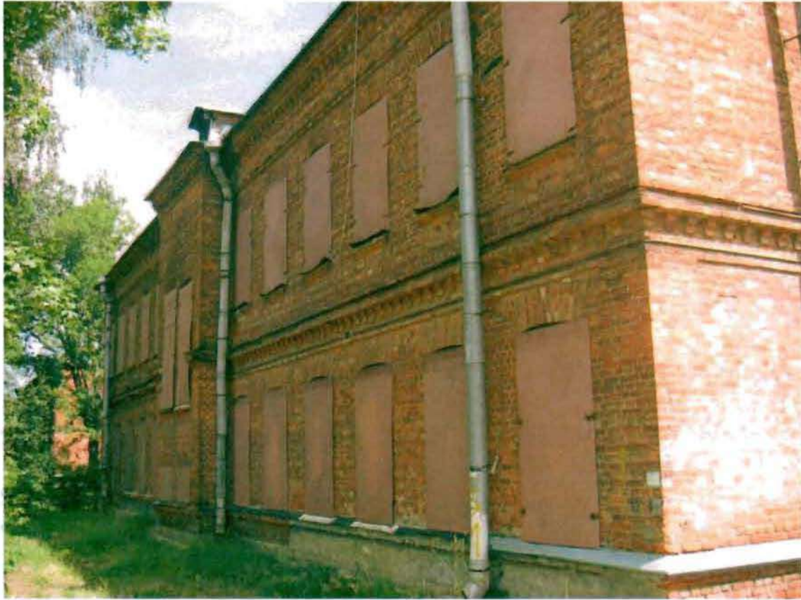
Фото 119. Западный фасад. Общий вид.
