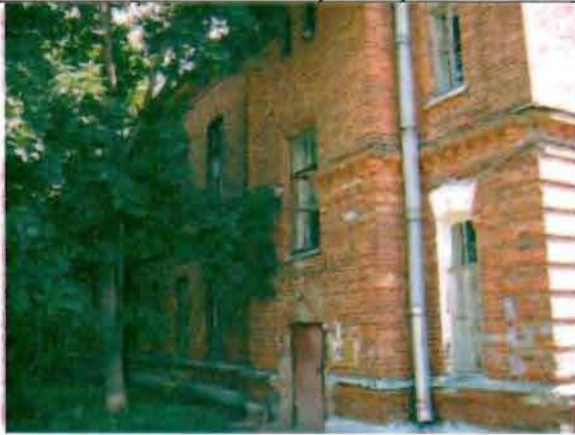
Фото 139. Западный фасад. Фрагмент.
