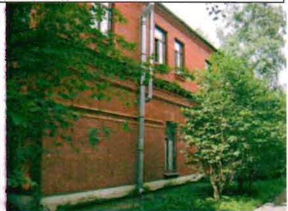
Фото 80. Северный фасад. Фрагмент.
