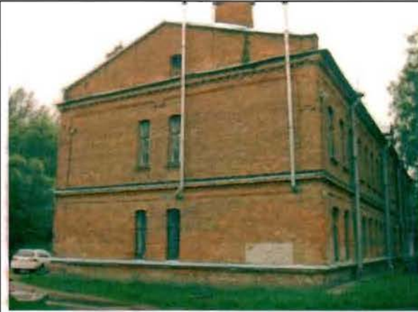
Фото 166. Южный фасад. Общий вид.
