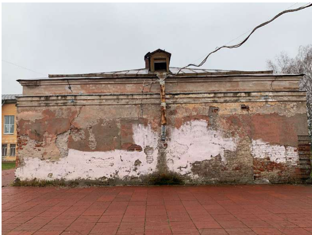
Фото 10. Общий вид фасада по оси 1.
