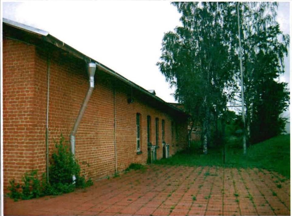
Фото 19. Восточный фасад. Общий вид.
