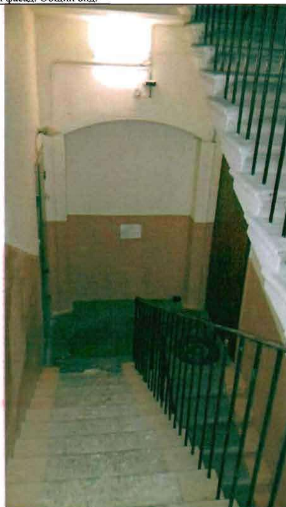
Фото 173. Лестница № 1 в северной части здания. Фрагмент.
