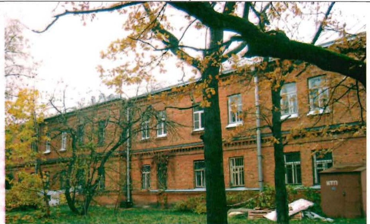
Фото 84. Южный фасад. Общий вид.
