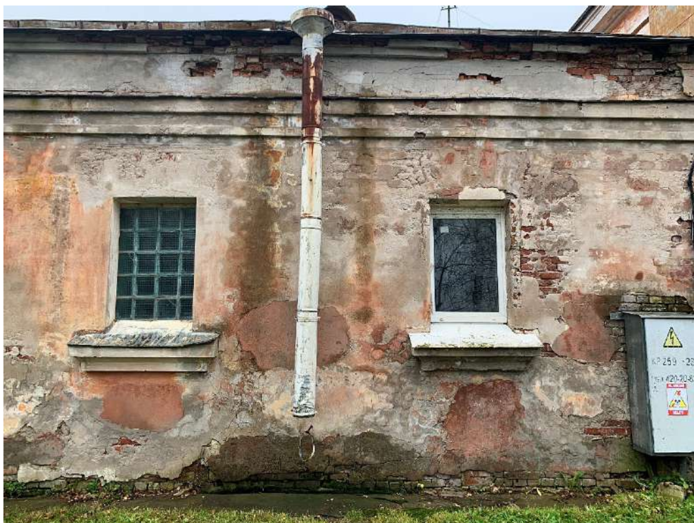
Фото 4. Вид на фрагмент фасада по оси А.
