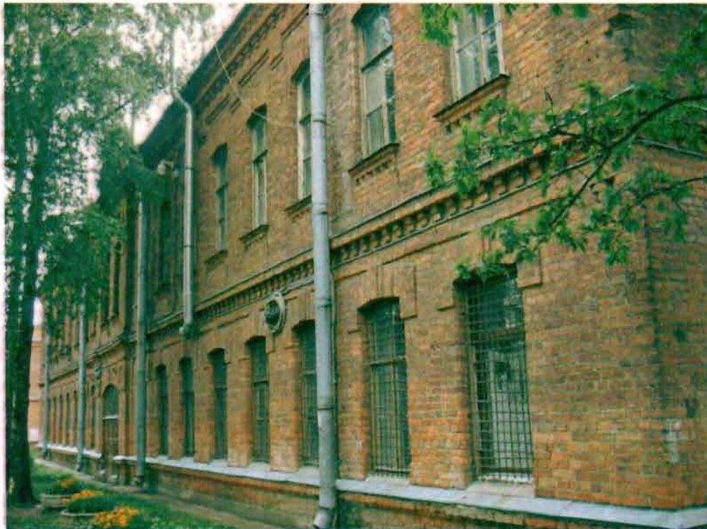
Фото 163. Восточный фасад. Общий вид.
