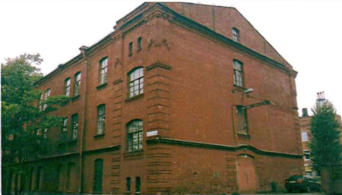
Фото 30. Северный фасад. Общий вид.
