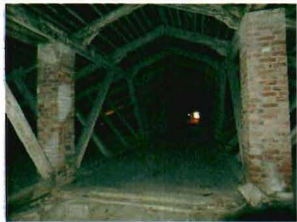
Фото 12. Конструкции крыши. Общий вид. 29.12.2015.
