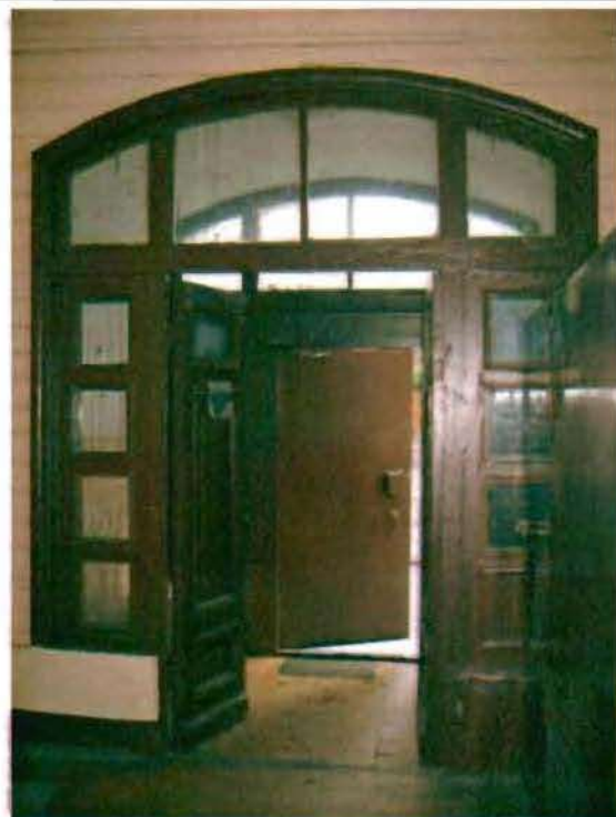
Фото 107. Дверной проем тамбура. Общий вид.
