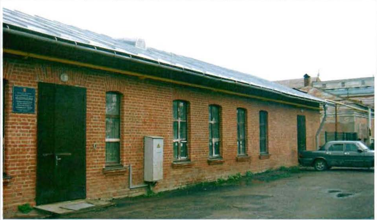
Фото 18. Западный фасад. Общий вид.
