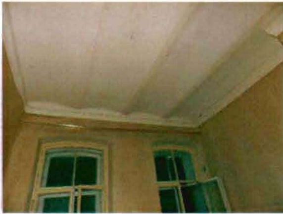
Фото 120. Помещение 1-го этажа. Общий вид.
