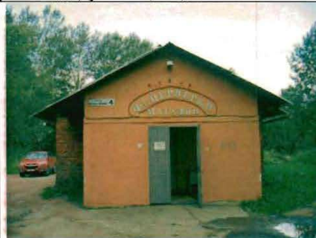
Фото 153. Восточный фасад. Общий вид.
