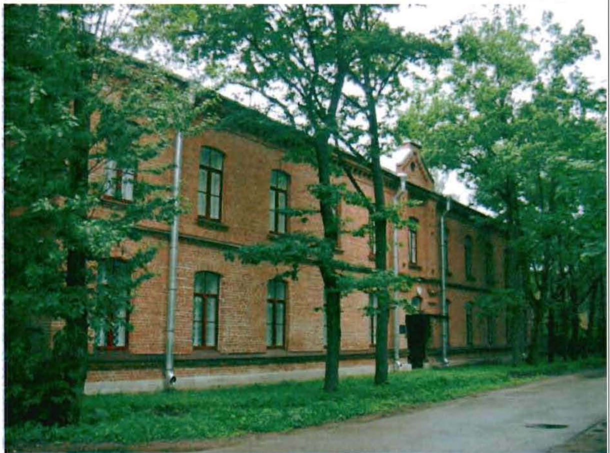
Фото 39. Восточный фасад. Общий вид.
