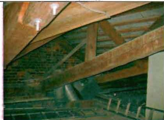
Фото 77. Конструкции крыши. Общий вид.
