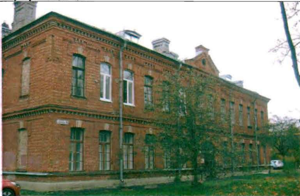
Фото 103. Восточный фасад. Общий вид.
