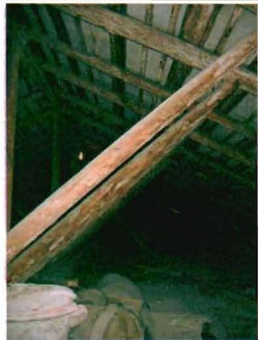
Фото 27. Конструкции крыши. Фрагмент.
