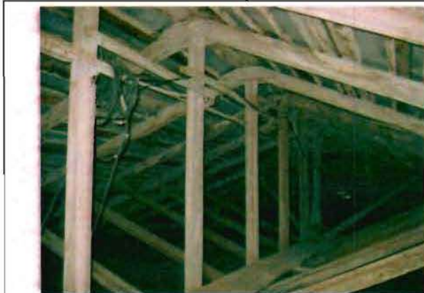
Фото 81. Конструкции крыши. Общий вид.
