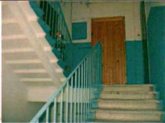
Фото 161. Лестница № 1 в южной части здания. Фрагмент.
