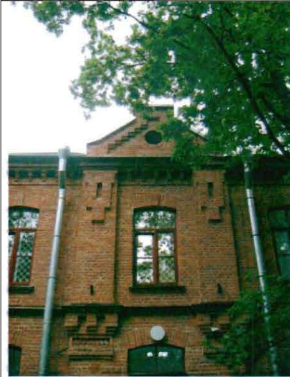
Фото 40. Восточный фасад. Фрагмент центральной части фасада.
