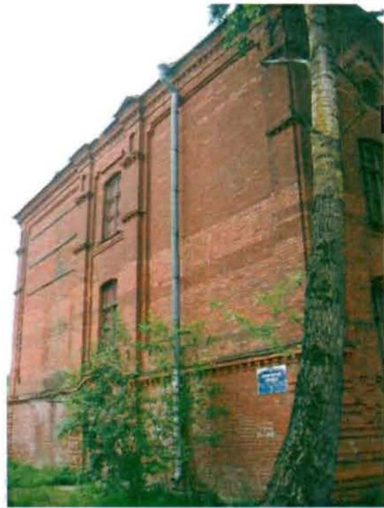
Фото 6. Северный фасад. Общий вид.
