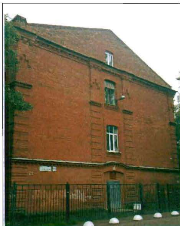
Фото 49. Северный фасад. Общий вид.
