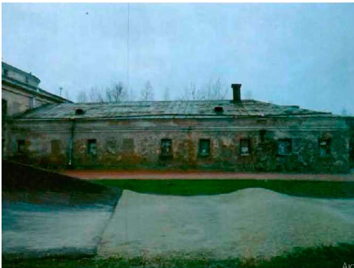
16. Восточный фасад, фото 2012 г. Предмет охраны объекта культурного наследия.
