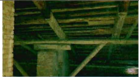
Фото 38. Конструкции крыши. Фрагмент.
