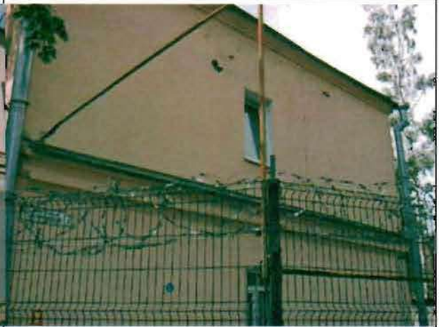
Фото 113. Северный фасад. Общий вид.
