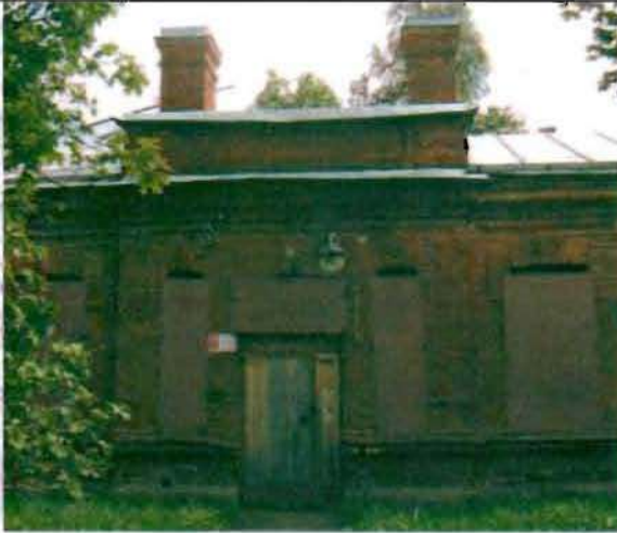
Фото 99. Западный фасад. Центральный часть. Общий вид.
