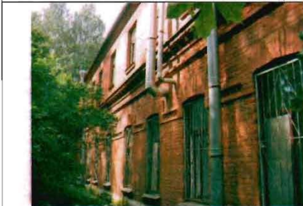
Фото 79. Восточный фасад. Общий вид.
