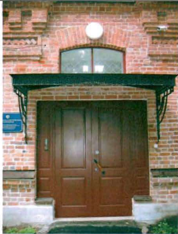
Фото 41. Дверной проем восточного фасада. Общий вид.
