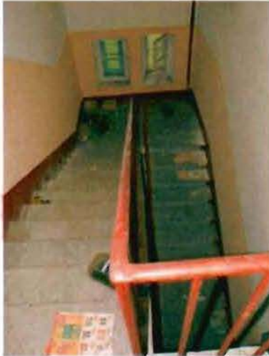
Фото 124. Лестница в южной части здания. Общий вид.
