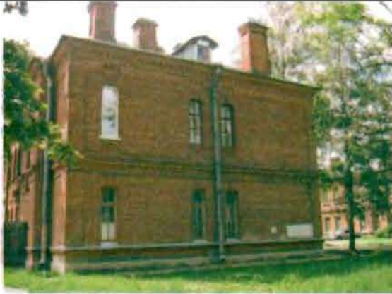
Фото 159. Северный фасад. Общий вид.
