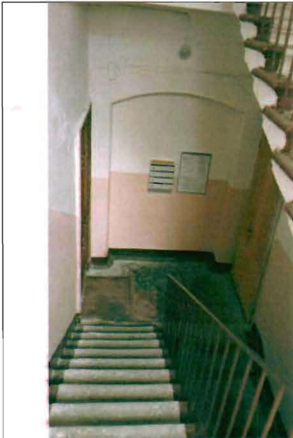
Фото 130. Лестница № 1 в южной части здания. Общий вид.
