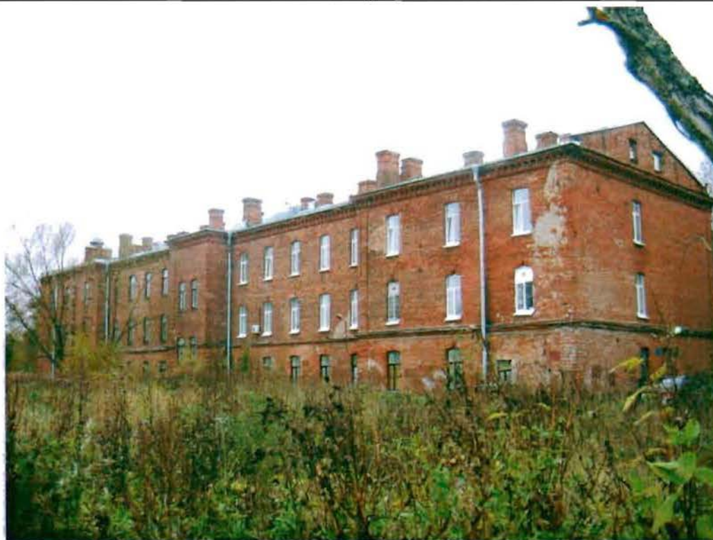
Фото 14. Восточный фасад. Общий вид.
