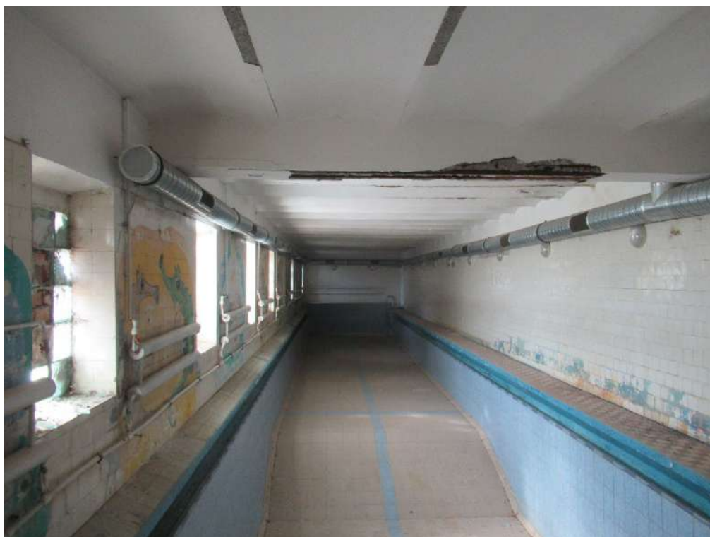
Фото 20. Общий вид помещения №14.
