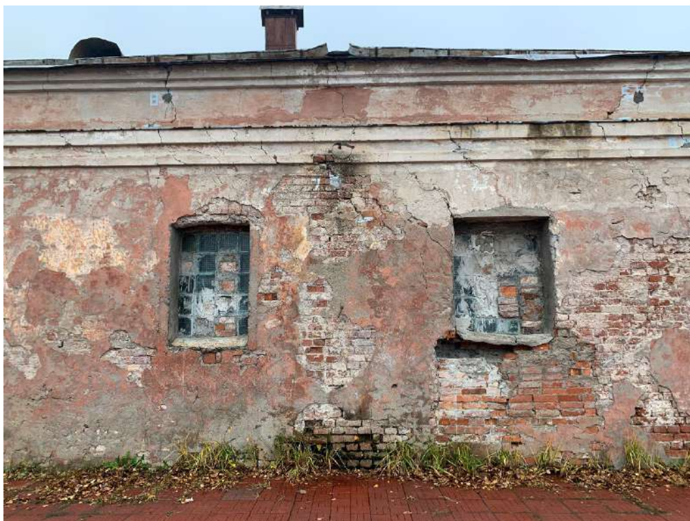
Фото 15. Вид на фрагмент фасада по оси 8.
