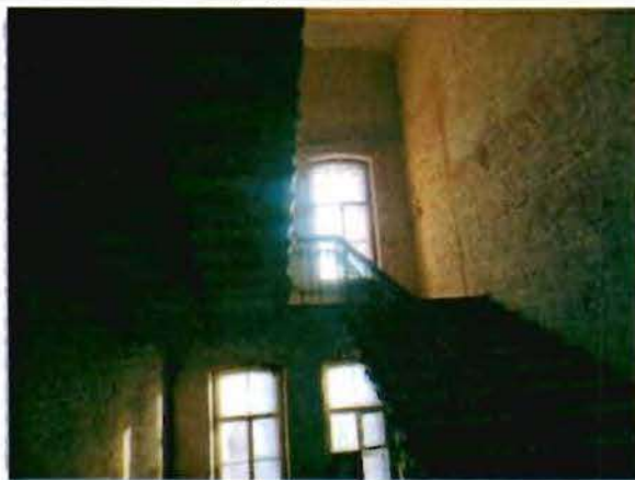
Фото 11. Интерьер. Лестница. Общий вид. 29.12.2015.
