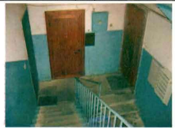
Фото 162. Лестница № 2 в северной части здания. Фрагмент.
