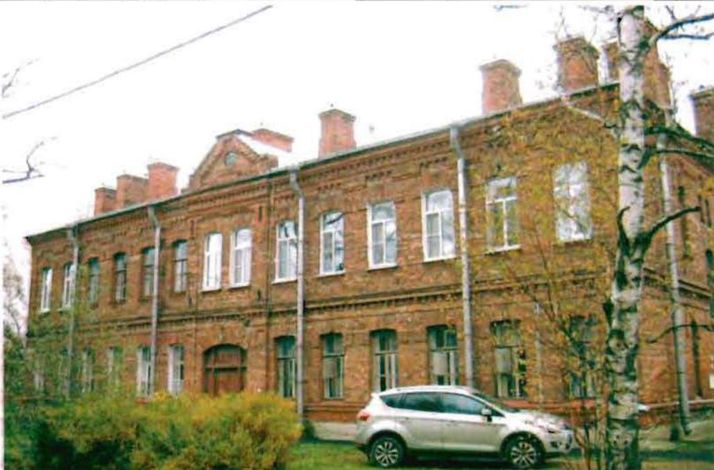
Фото 128. Восточный фасад. Общий вид.
