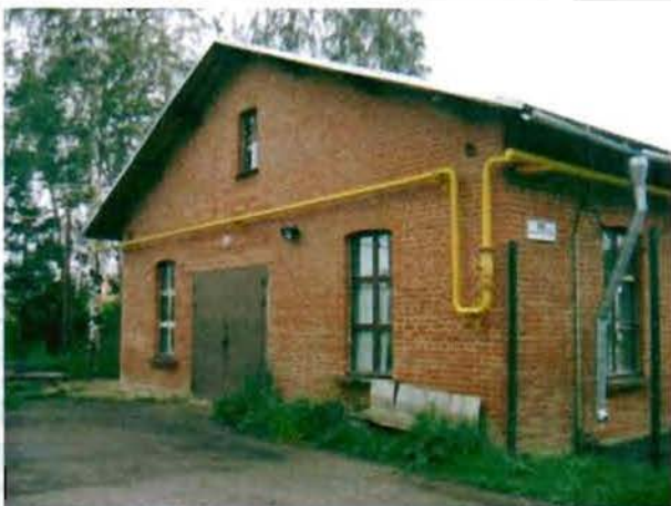
Фото 20. Северный фасад. Общий вид.
