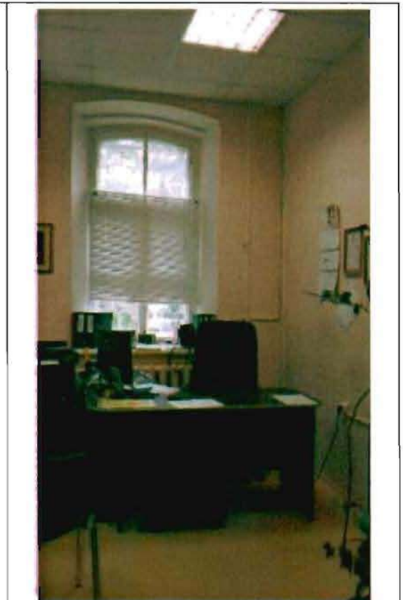
Фото 93. Помещение в уровне 1-го этажа.
