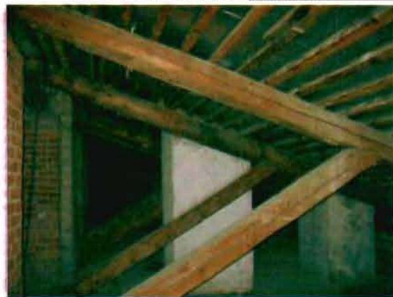
Фото 141. Конструкции крыши. Фрагмент.
