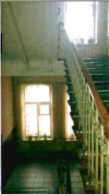
Фото 35. Интерьер. Лестница. Общий вид.
