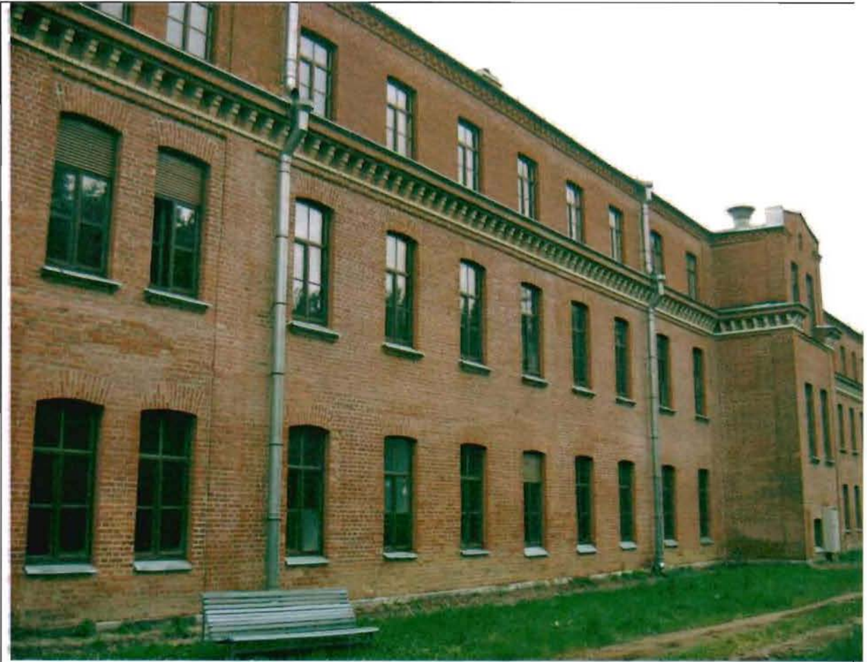
Фото 66. Южный фасад. Общий вид. 05.07.2016.
