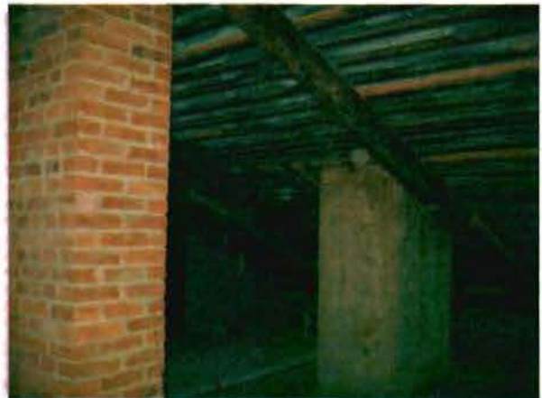
Фото 152. Конструкции крыши. Фрагмент.
