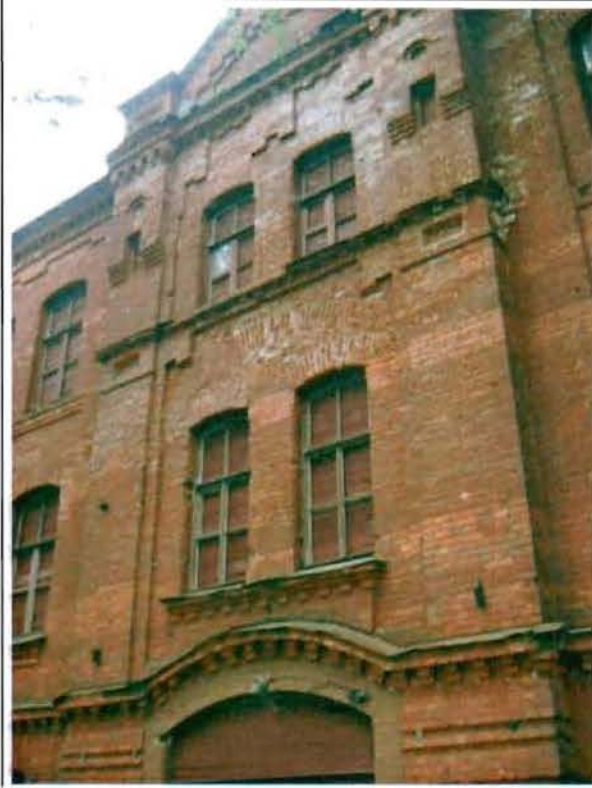
Фото 3. Западный фасад. Фрагмент центральной части фасада.
