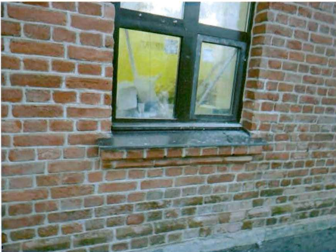
Ступенчатые подоконные доски. Съемка 20.11.2012, Воронина Н.В.
