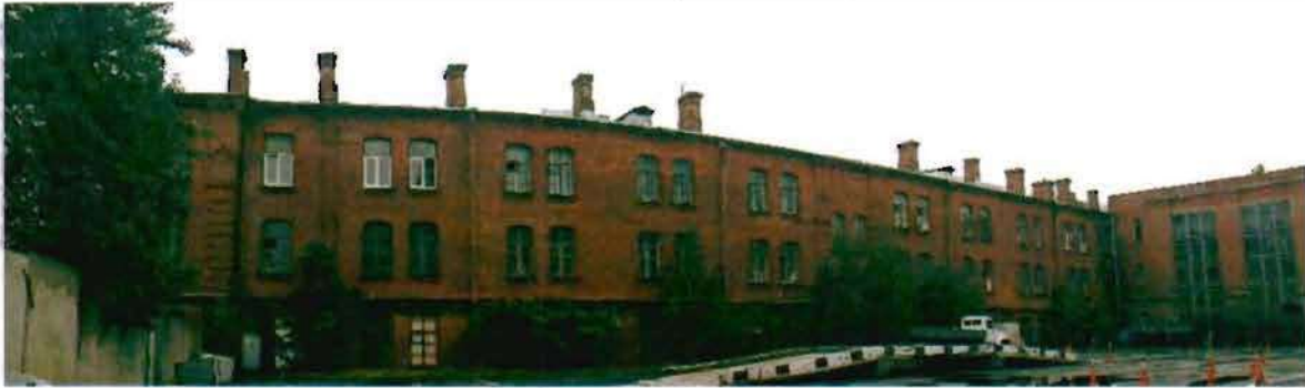
Фото 29. Западный фасад. Общий вид.
