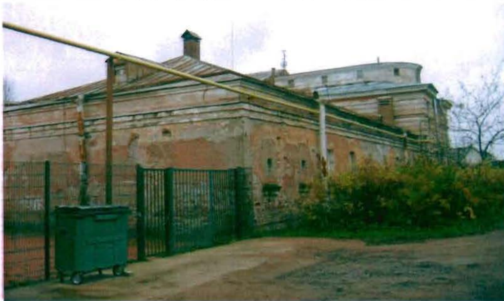
Фото 24. Западный, северный фасады. Общий вид.
