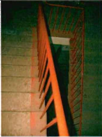
Фото 149. Лестница № 1 в северной части здания. Общий вид.
