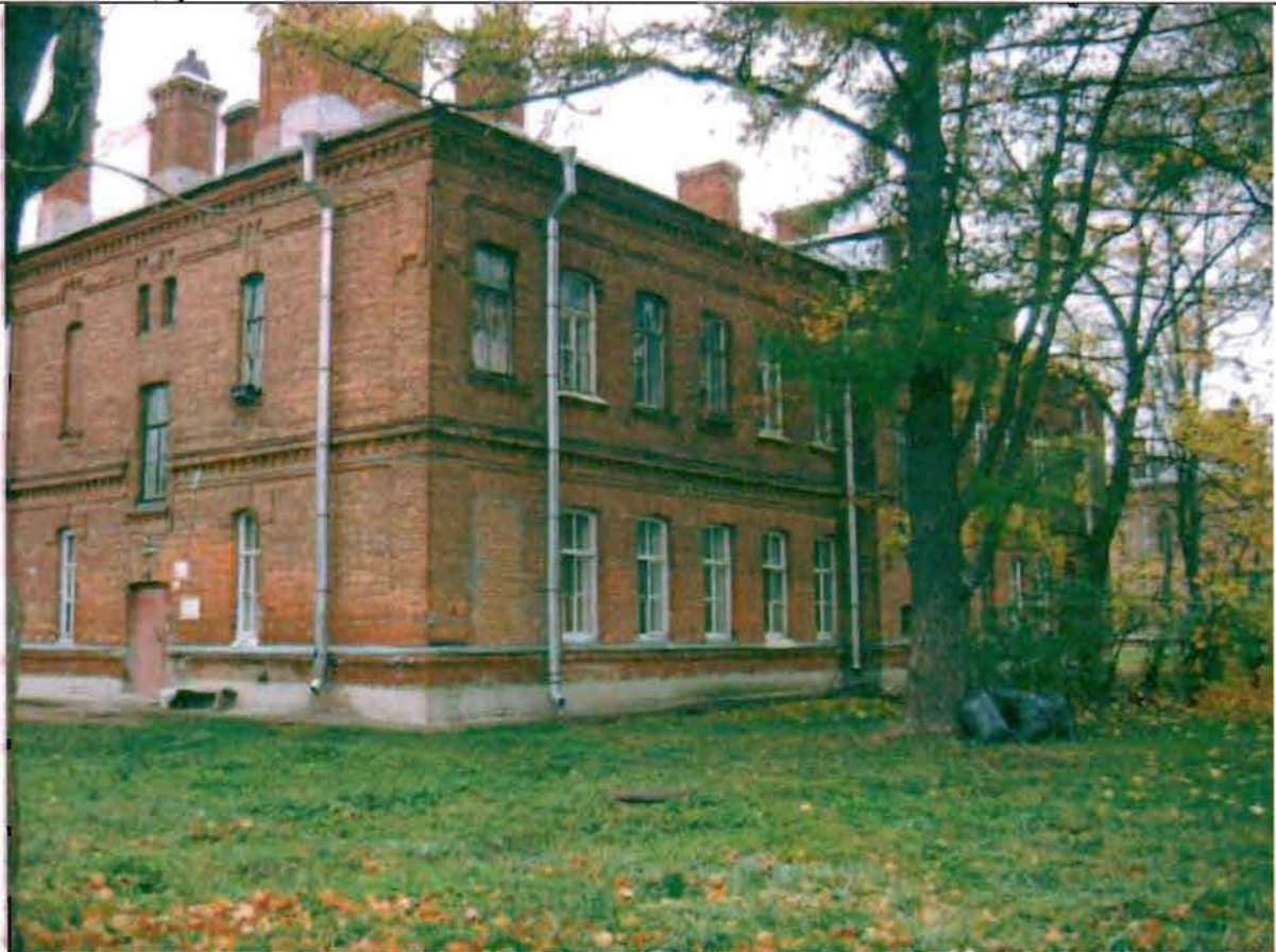
Фото 145. Восточный фасад. Общий вид.
