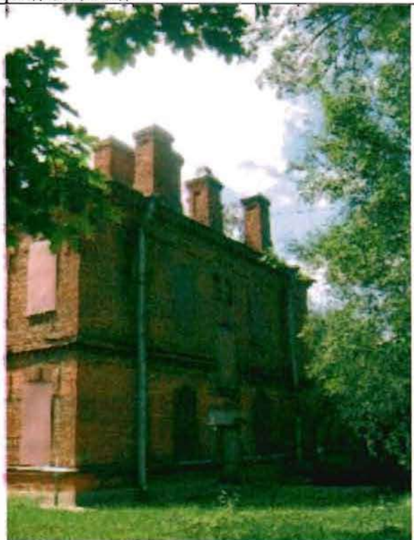
Фото 118. Северный фасад. Общий вид.
