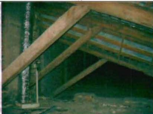
Фото 76. Конструкции крыши. Общий вид.
