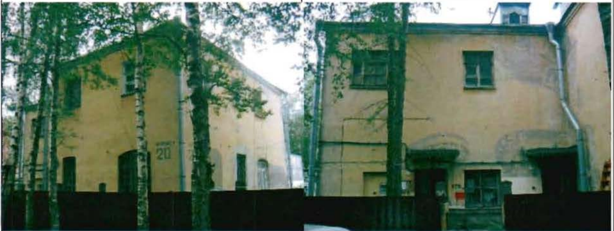
Фото 43. Северный, восточный фасады. Общий вид.
