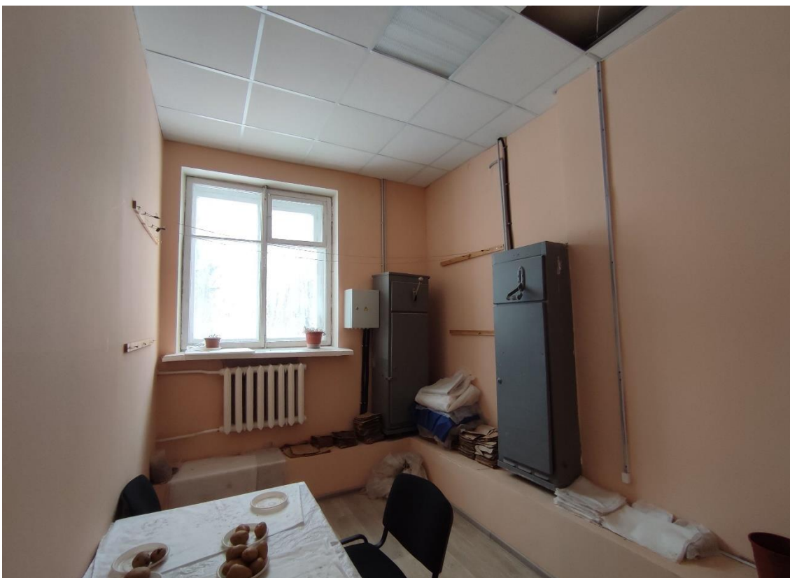
12. Объект культурного наследия федерального значения «Корпус Конюшенный», по адресу: Санкт-Петербург, г. Пушкин, Московское ш., д. 11 (Санкт-Петербург, г. Пушкин, Московское ш., д. 5, лит. Б). Фрагмент пом. 5-Н (2) в уровне 1-го этажа.
