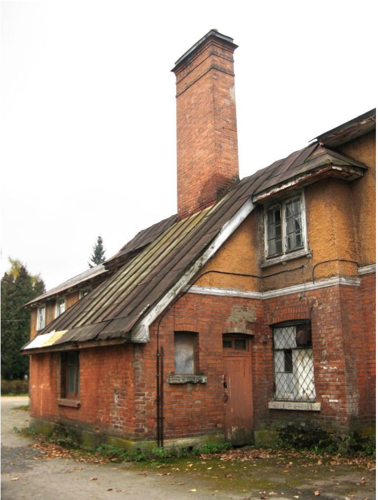
9. Фото 2011 г. Источник: https://www.citywalls.ru
