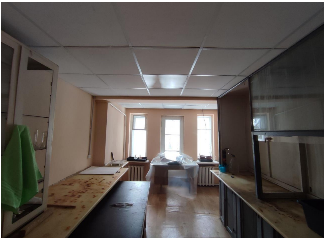
28. Объект культурного наследия федерального значения «Корпус Конюшенный», по адресу: Санкт-Петербург, г. Пушкин, Московское ш., д. 11 (Санкт-Петербург, г. Пушкин, Московское ш., д. 5, лит. Б). Общий вид пом. 6-Н (21) в уровне 2-го этажа.
