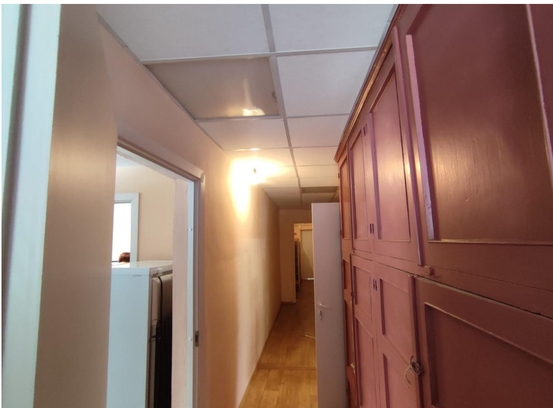
30. Объект культурного наследия федерального значения «Корпус Конюшенный», по адресу: Санкт-Петербург, г. Пушкин, Московское ш., д. 11 (Санкт-Петербург, г. Пушкин, Московское ш., д. 5, лит. Б). Общий вид пом. 6-Н (23) в уровне 2-го этажа.
