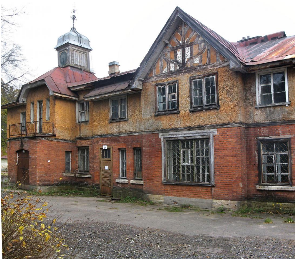
10. Фото 2011 г. Источник: https://www.citywalls.ru
