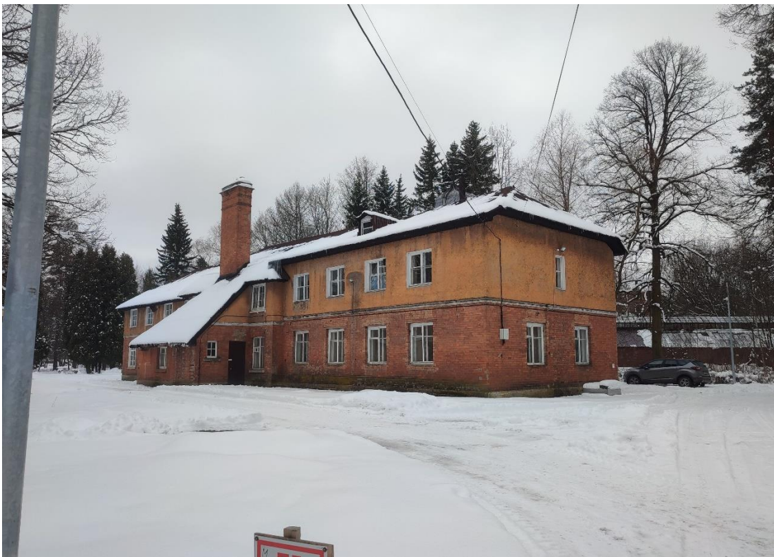
1. Объект культурного наследия федерального значения «Корпус Конюшенный», по адресу: Санкт-Петербург, г. Пушкин, Московское ш., д. 11 (Санкт-Петербург, г. Пушкин, Московское ш., д. 5, лит. Б). Общий вид с севера.
