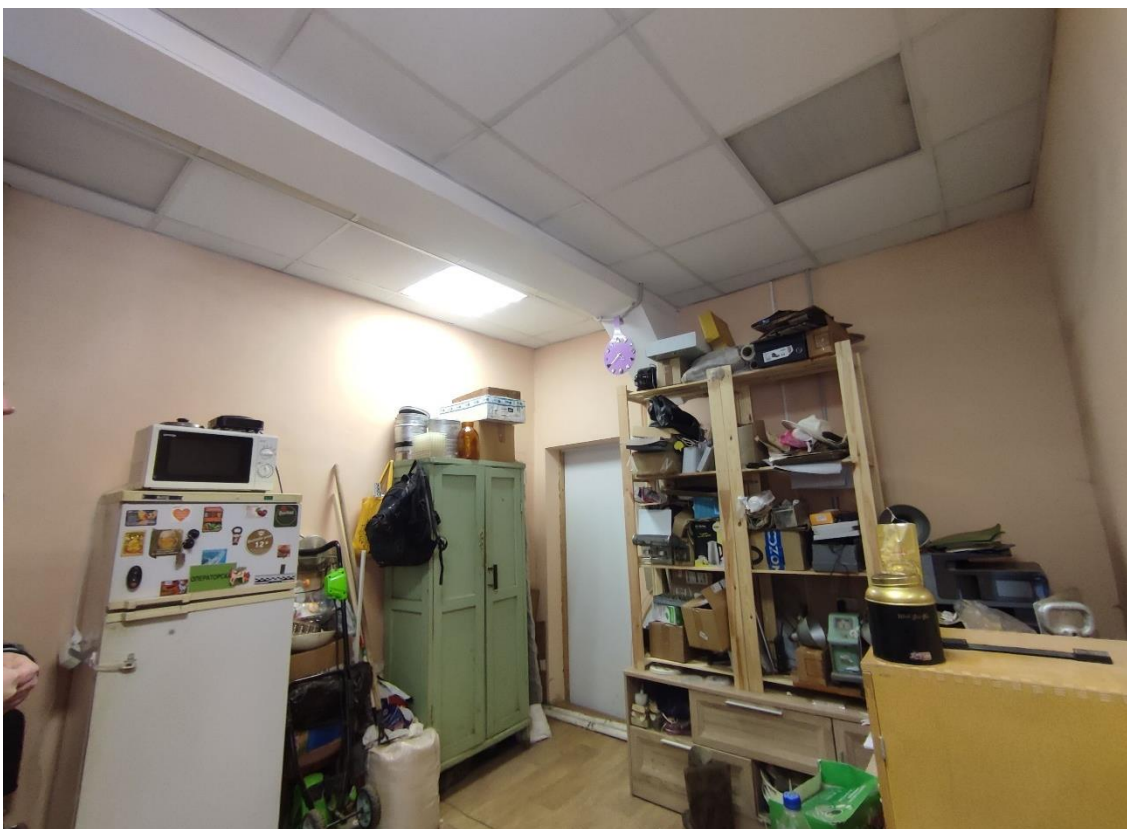
16. Объект культурного наследия федерального значения «Корпус Конюшенный», по адресу: Санкт-Петербург, г. Пушкин, Московское ш., д. 11 (Санкт-Петербург, г. Пушкин, Московское ш., д. 5, лит. Б). Общий вид пом. 2-Н (3) в уровне 1-го этажа.
