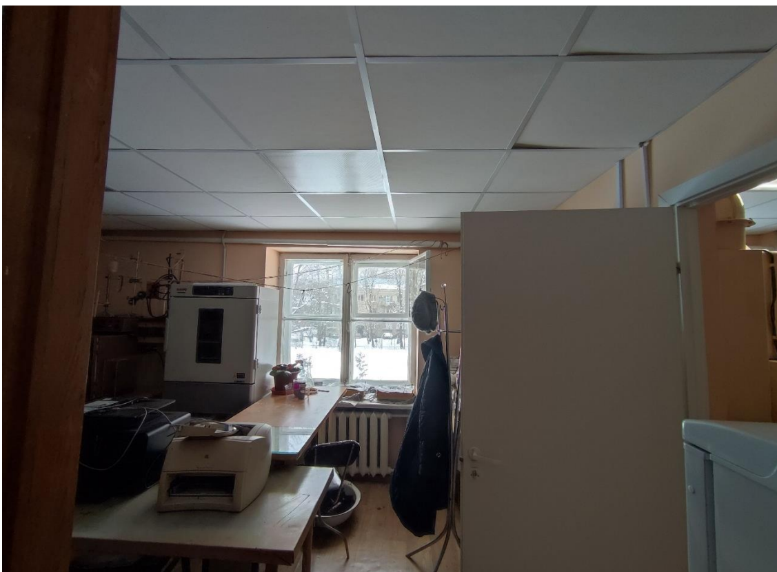
31. Объект культурного наследия федерального значения «Корпус Конюшенный», по адресу: Санкт-Петербург, г. Пушкин, Московское ш., д. 11 (Санкт-Петербург, г. Пушкин, Московское ш., д. 5, лит. Б). Общий вид пом. 6-Н (24) в уровне 2-го этажа.
