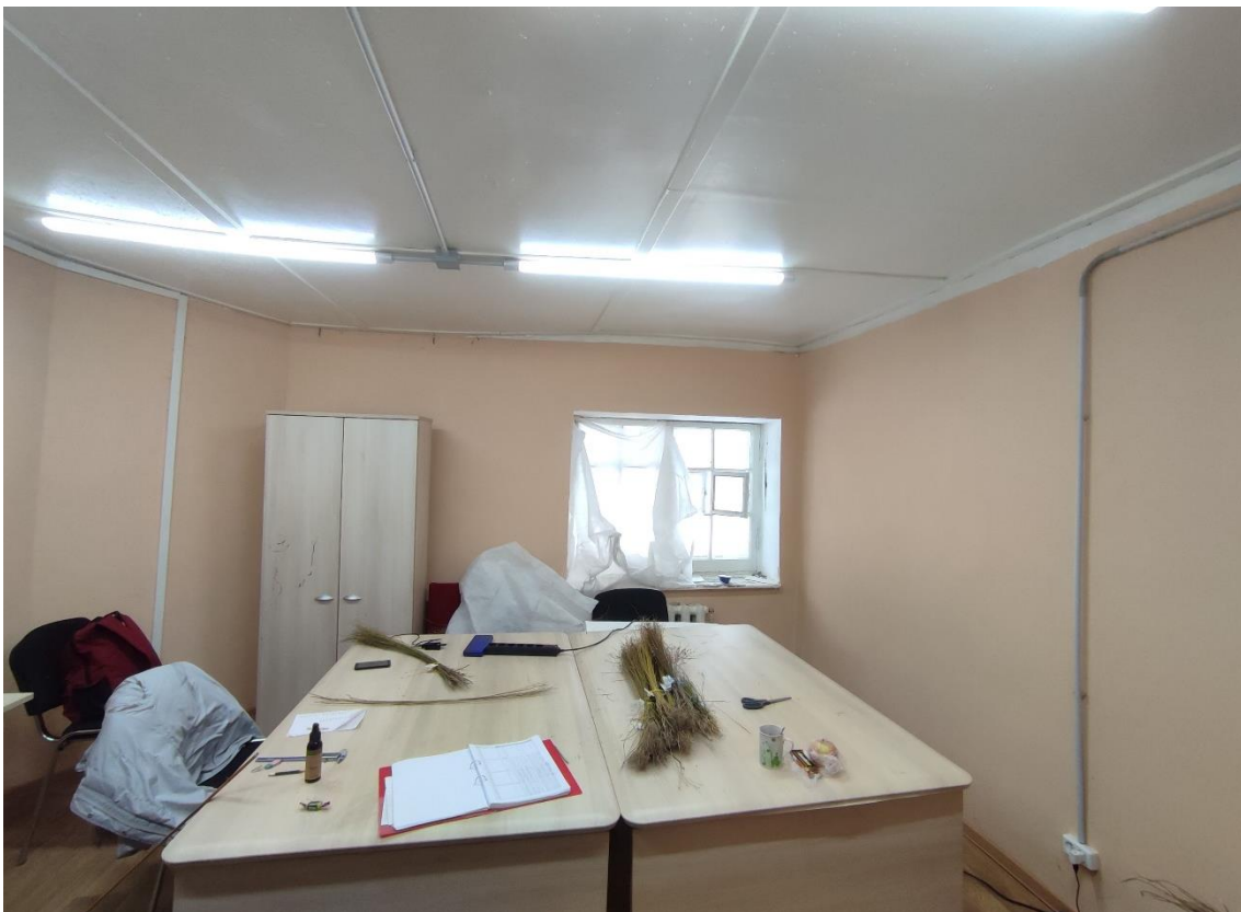
23. Объект культурного наследия федерального значения «Корпус Конюшенный», по адресу: Санкт-Петербург, г. Пушкин, Московское ш., д. 11 (Санкт-Петербург, г. Пушкин, Московское ш., д. 5, лит. Б). Общий вид пом. 6-Н (6) в уровне 2-го этажа.
