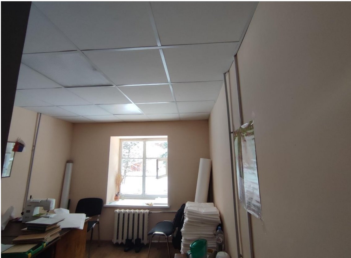
25. Объект культурного наследия федерального значения «Корпус Конюшенный», по адресу: Санкт-Петербург, г. Пушкин, Московское ш., д. 11 (Санкт-Петербург, г. Пушкин, Московское ш., д. 5, лит. Б). Общий вид пом. 6-Н (14) в уровне 2-го этажа.
