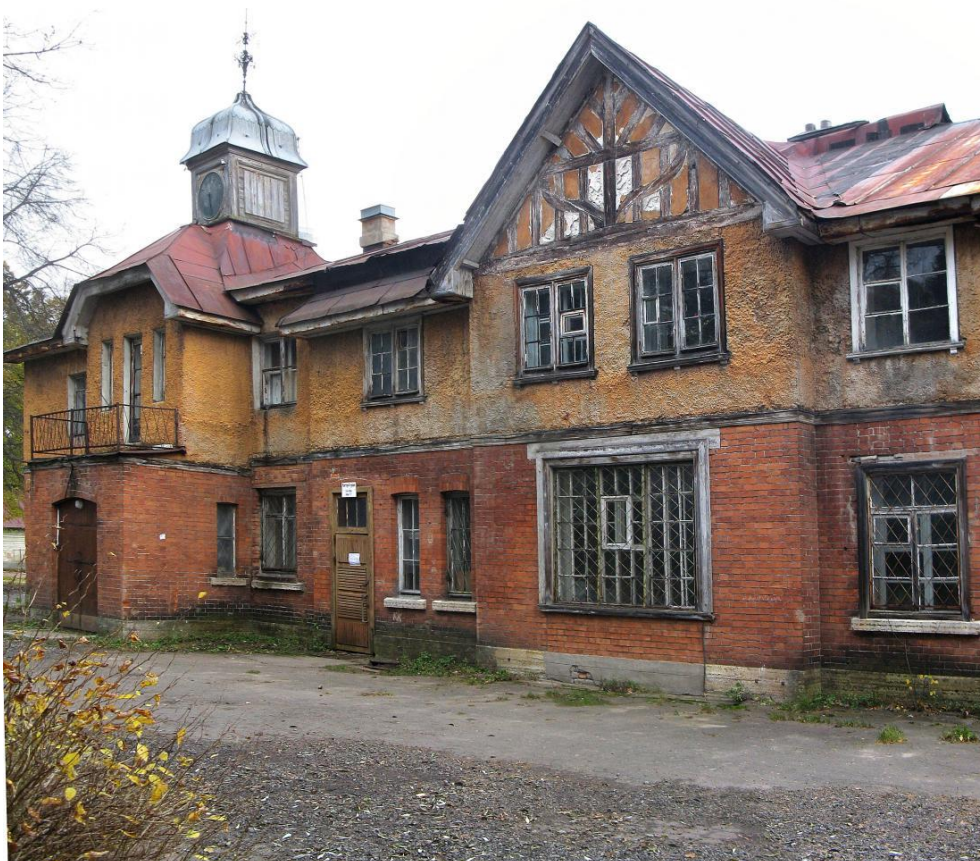
11. Фото 2011 г. Источник: https://www.citywalls.ru
