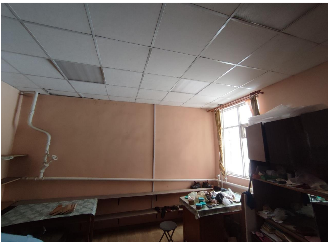
17. Объект культурного наследия федерального значения «Корпус Конюшенный», по адресу: Санкт-Петербург, г. Пушкин, Московское ш., д. 11 (Санкт-Петербург, г. Пушкин, Московское ш., д. 5, лит. Б). Общий вид пом. 2-Н (4) в уровне 1-го этажа.
