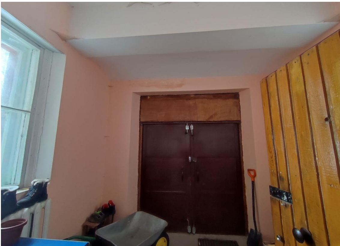
8. Объект культурного наследия федерального значения «Корпус Конюшенный», по адресу: Санкт-Петербург, г. Пушкин, Московское ш., д. 11 (Санкт-Петербург, г. Пушкин, Московское ш., д. 5, лит. Б). Общий вид пом. 5-Н (1) в уровне 1-го этажа.
