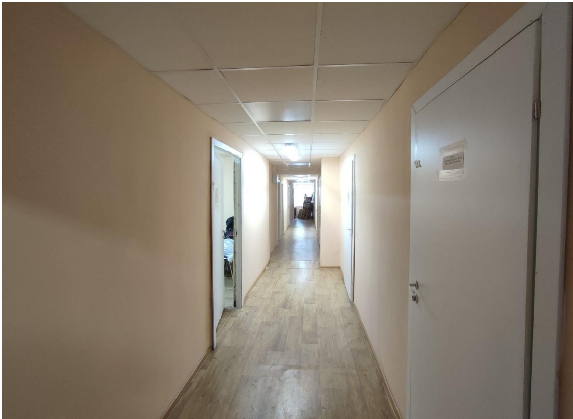
22. Объект культурного наследия федерального значения «Корпус Конюшенный», по адресу: Санкт-Петербург, г. Пушкин, Московское ш., д. 11 (Санкт-Петербург, г. Пушкин, Московское ш., д. 5, лит. Б). Общий вид пом. 6-Н (11) в уровне 2-го этажа.
