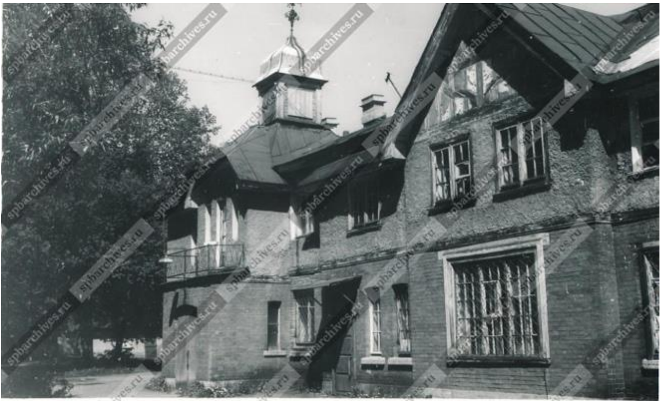
7. ЦГАКФФД СПб. Фотодокумент Ар 248186. Вид части фасада бывшего конюшенного корпуса с часовой башенкой в усадьбе великого князя Бориса Владимировича по Московскому шоссе, 11, корп., 2 (в доме размещается центральная опытная станция ботаники и селекции научно-исследовательского института растениеводства им. Н.И. Вавилова, архитекторы Шернборн, Скотт, С.А. Данини, 1896-1897 гг.). Дата съёмки: 01 июня 1997 г.
