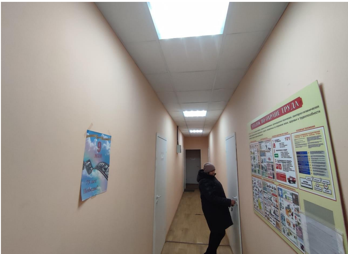
19. Объект культурного наследия федерального значения «Корпус Конюшенный», по адресу: Санкт-Петербург, г. Пушкин, Московское ш., д. 11 (Санкт-Петербург, г. Пушкин, Московское ш., д. 5, лит. Б). Общий вид пом. 1-Н (1) в уровне 1-го этажа.
