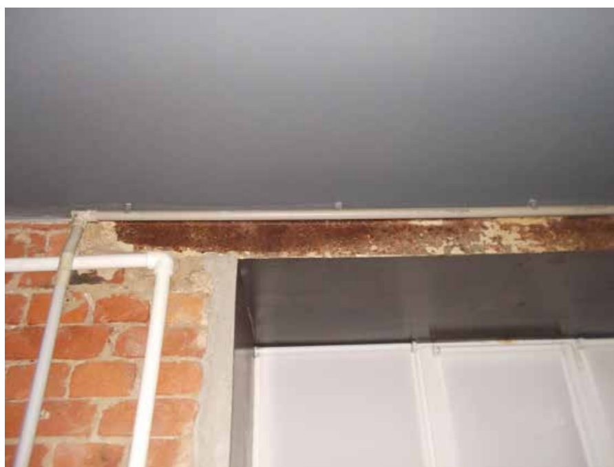
Фото 2 – Фрагмент окна 1580x1750мм. Перемычка Двутавр №13
