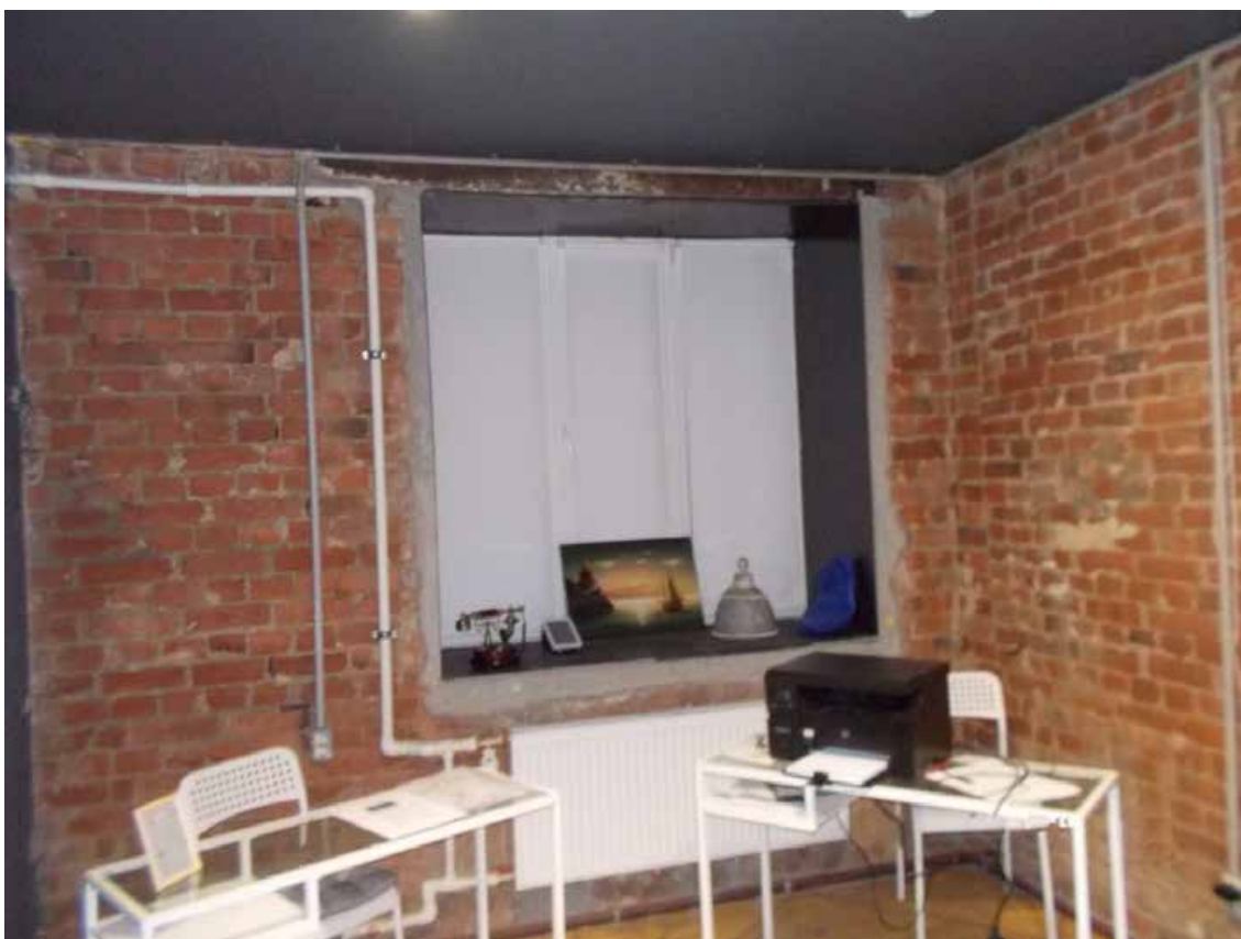
Фото 1 – Внешний вид окна 1580x1750мм со стороны помещения
