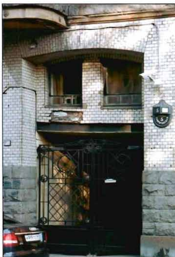
Фото 6. Фрагмент западного фасада. Воротный проезд.
