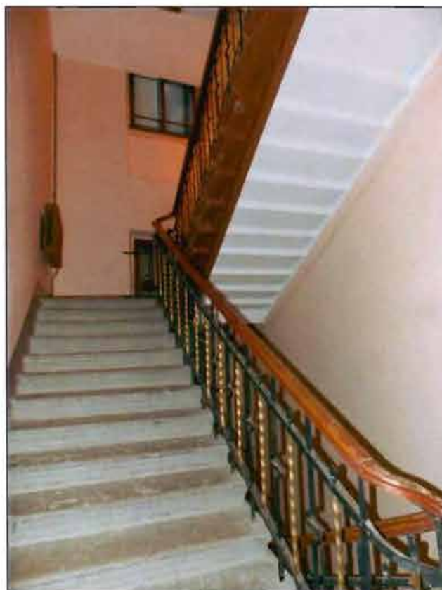
Фото 36. Интерьер. Лестница 2-ЛК.
