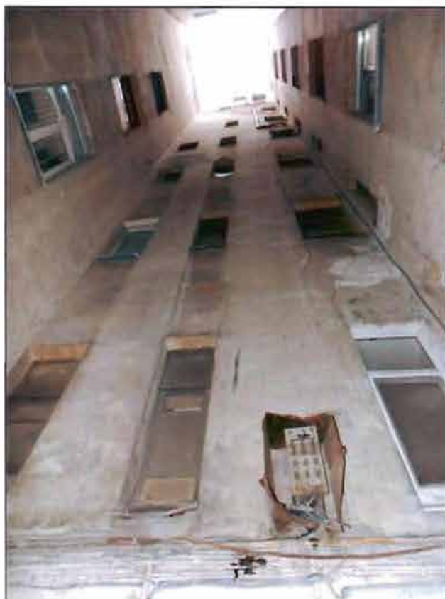
Фото 11. Фрагмент дворового фасада. Середина воротного проезда.
