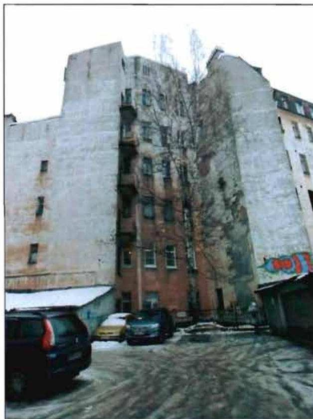
Фото 22. Фрагмент дворового фасада. Восточный двор. Восточный фасад.
