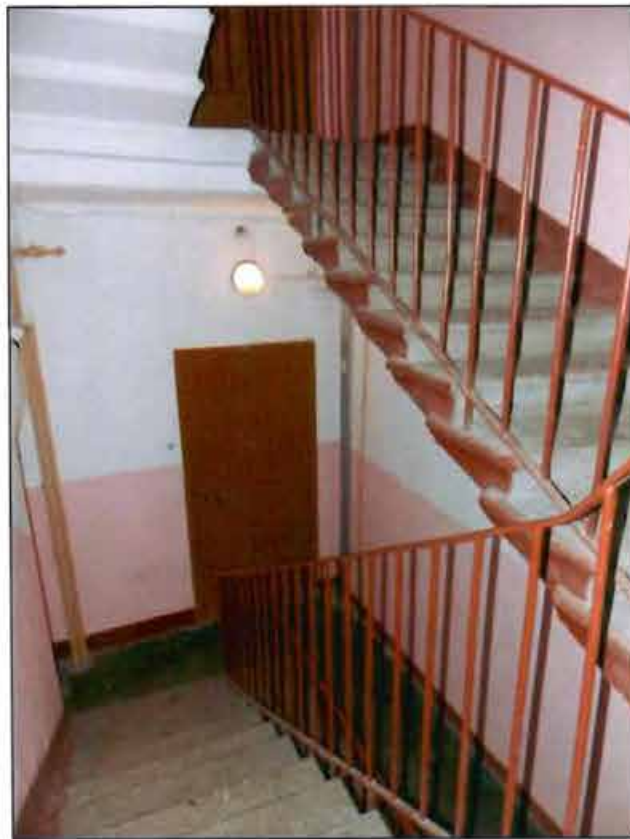
Фото 43. Интерьер. Лестница 6-ЛК.
