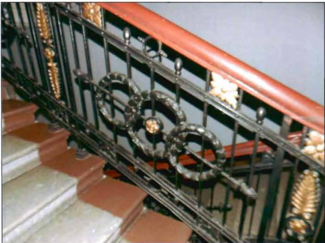
Фото 34. Интерьер. Парадная лестница. Фрагмент ограждения.
