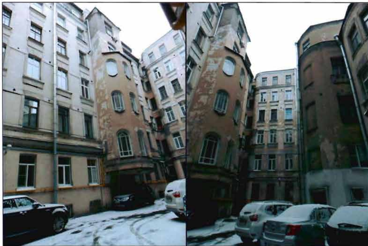
Фото 12-13. Фрагменты дворового фасада. Эркер парадной лестницы. Северный двор. Южный фасад.
