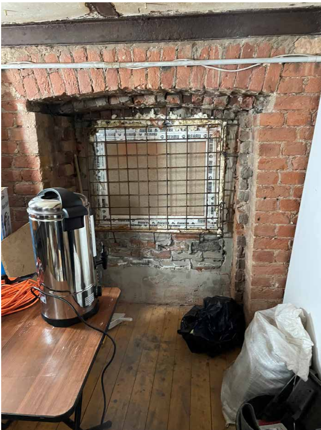
Фото 6 – Внешний вид окна 1050x1210мм со стороны помещения. Заложённая подоконная часть.
