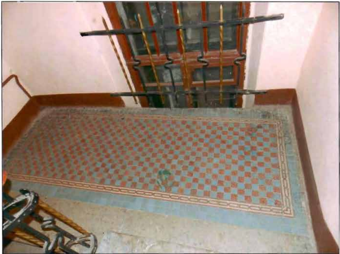
Фото 38. Интерьер. Лестница 2-ЛК.
