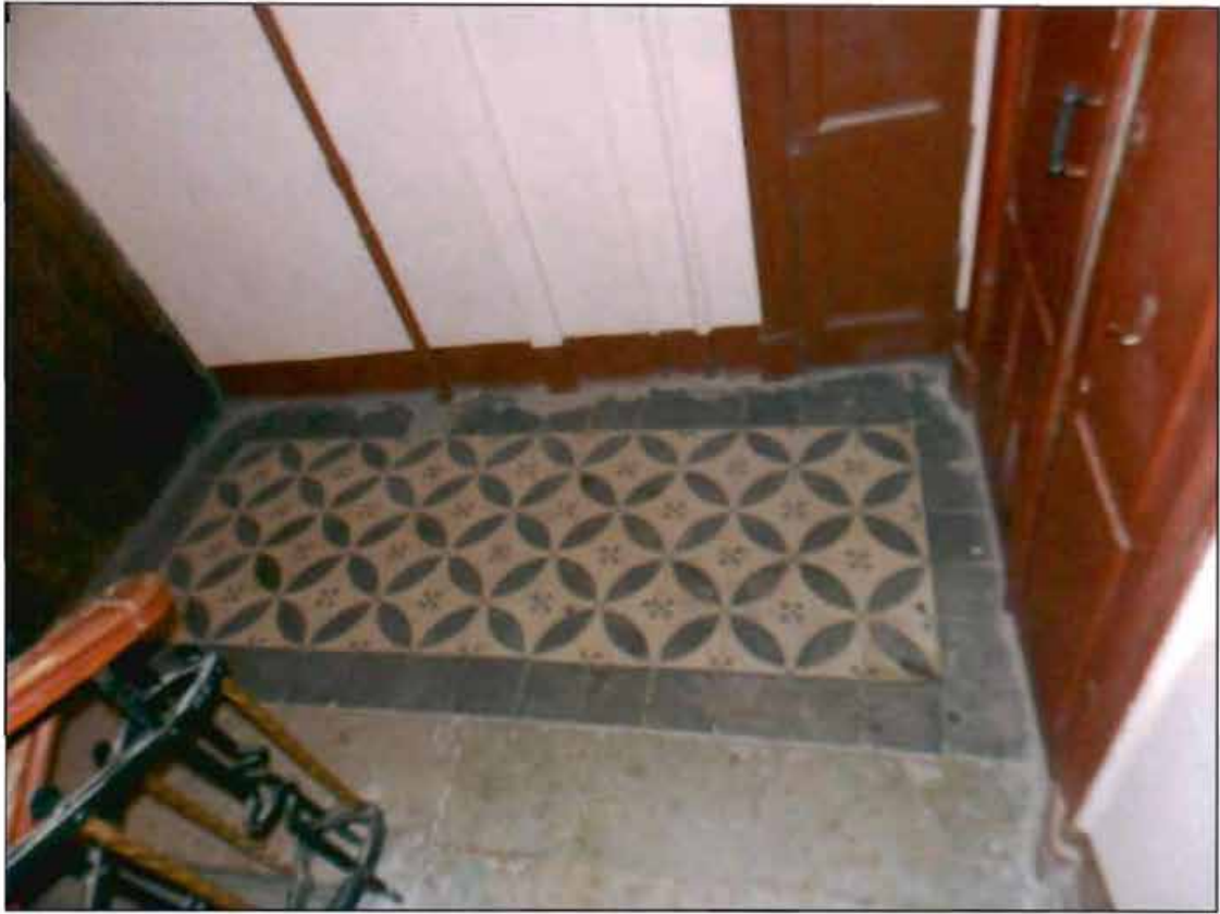
Фото 37. Интерьер. Лестница 2-ЛК.
