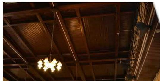
оформление потолка – кессоны с четырьмя круглыми розетками в центральной части, на пересечении балок; историческое заполнение кессонов – тонированный дуб;
