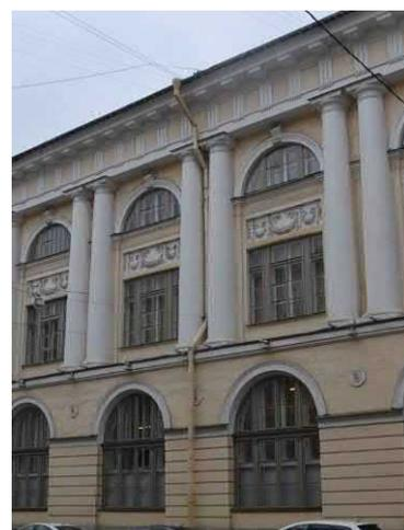
исторические дверные проемы – местоположение (по 16-ой и 31-ой световым осям лицевого фасада по ул. Зодчего Росси), конфигурация (прямоугольные), габариты, оформление (ниши с полуциркульным завершением, оформленные профилированными архивольтами на импостах в виде рустованных лопаток в межконных простенках, с трехчастным замковым камнем – в боковом ризалите);
