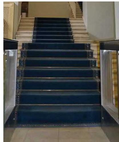
парадная лестница со стороны пл. Ломоносова (подъезд №4) – трехмаршевая на косоурах, с мраморными ступенями, с латунными кольцами и ковродержателями; металлическое литое лестничное ограждение из секций вертикальных прутьев с растительными завитками и розетками в верхнем горизонтальном поясе и декоративными элементами в виде консолей с растительным рисунком, с деревянными поручнями;
