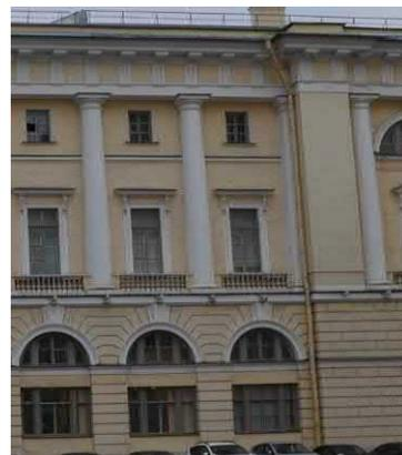
исторический дверной проем – местоположение (в 4-ой световой оси фасада), конфигурация (прямоугольный), габариты, оформление (ниша с полуциркульным завершением, оформленная профилированным архивольтом на импостах с замковым камнем с львиным маскароном, объединяющая дверной проем с полуциркульным (термальным) оконным проемом в верхнем ярусе;
