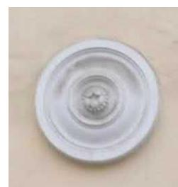
исторический геодезический знак – местоположение (между оконными проемами в 13-ой и 14-ой световых осях, над уровнем цоколя), материал (металл), изображение (НИВЕЛИРОВКА; 1872 г.).
