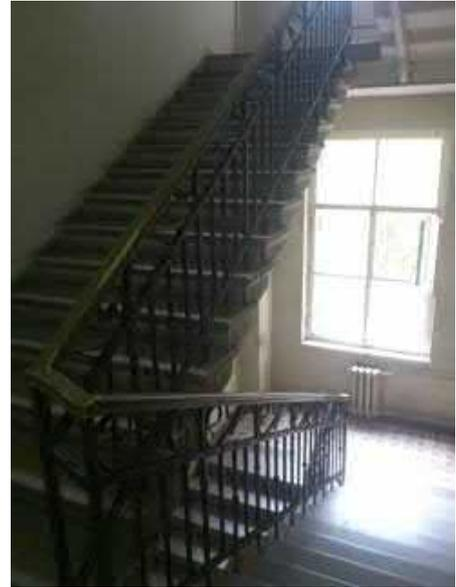
историческая лестница вестибюля парадного входа (подъезд №4) – одномаршевая, на перекрытии, на перепаде отметок пола, с гранитными ступенями;
