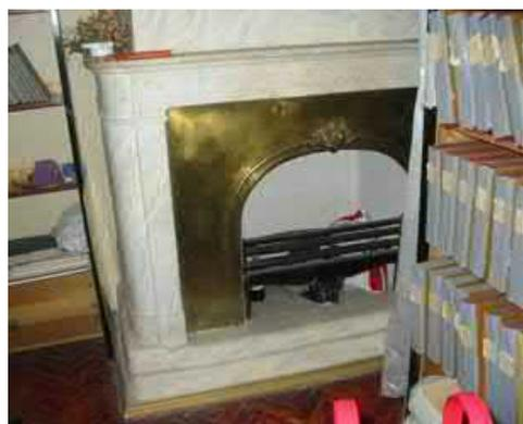
Камин одноярусный, светлого мрамора с прямоугольной полочкой с профилированным краем и углами, оформленными филенчатыми лопатками. Фриз с пальчиковой порезкой в центре и небольших прямоугольных филенок по бокам. Центральная часть – топочное отверстие с лучковым завершением, вписанное в прямоугольное латунное обрамление, декорированное профилированной тягой с растительным орнаментом и прямоугольными филенками с поясом иоников. Таган – чугунный (?).
