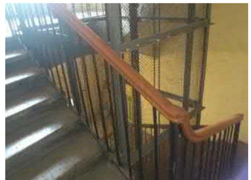
историческая лестница вестибюля парадного входа (подъезд №5) – одномаршевая, на перекрытии, на перепаде отметок пола, с известняковыми ступенями; ограждение лестницы вестибюля парадного входа (подъезд №5) – металлическое с деревянными поручнями, рисунок (фигурные стойки с перехватами на звериных лапах с растительным орнаментом);
