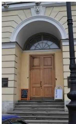
историческое заполнение дверного проема – конструкция (двухстворчатое, глухое), материал (дуб); крыльцо – местоположение (перед дверным проемом), габариты, материал ступеней (известняк);
