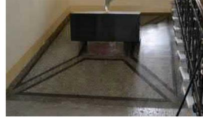
многомаршевая лестница в юго-восточной части юго-восточного дворового флигеля, с маршами по ползучим сводам, с известняковыми ступенями и металлическим литым лестничным ограждением из секций вертикальных прутьев, с угловыми прямоугольными в сечении стойками с шарообразным навершием;
