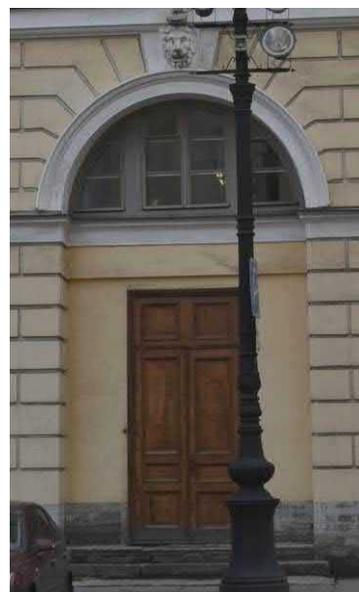
историческое заполнение дверного проема – конструкция (двухстворчатое, глухое),
