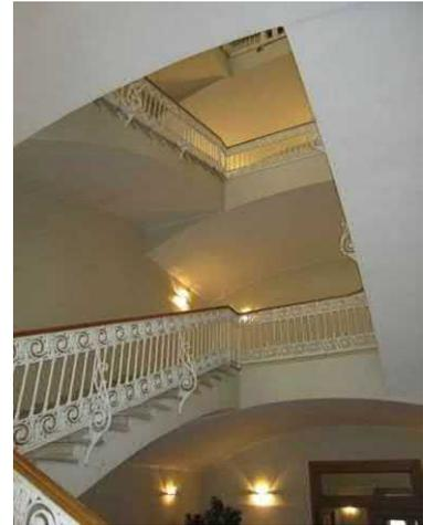
четырёхмаршевая железная лестница в угловой части корпусов по пл. Ломоносова и ул. Зодчего Росси – на косоурах с металлическими межуровневыми площадками с рисунком из концентрических кругов и геометрическим рисунком металлических ступеней, с металлическим литым лестничным ограждением из вертикальных прутьев с перехватами растительного орнамента и деревянными поручнями;
