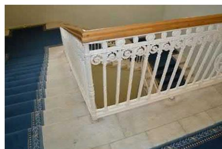
парадная лестница со стороны пл. Островского (подъезд №1) – двухуровневая, распашная, на косоурах, с известняковыми ступенями, с латунными кольцами и ковродержателями, с металлическим литым лестничным ограждением и ограждением верхней площадки из секций вертикальных прутьев с верхним и нижним горизонтальными поясами с орнаментом «волна Витрувия», угловыми, круглыми в сечении стойками с перехватами, с декоративными элементами в виде консолей с растительным рисунком и с деревянными поручнями;
