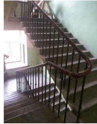
двухмаршевая служебная лестница в юго-западной части корпуса по пл. Островского – на косоурах, с известняковыми ступенями, металлическим литым лестничным ограждением из вертикальных ажурных стоек с растительным орнаментом и деревянными поручнями;
