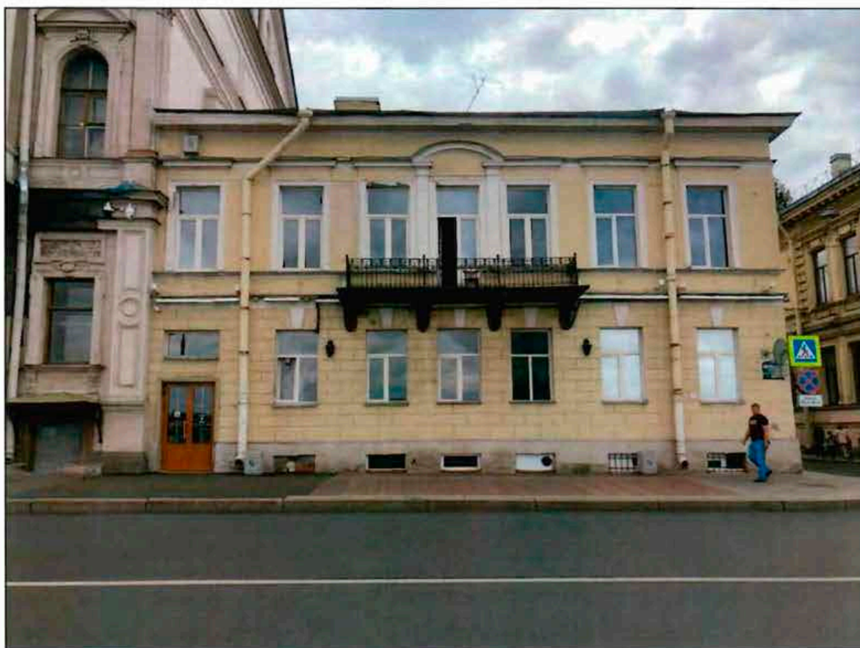
1. Лицевой фасад объекта культурного наследия. Общий вид.
