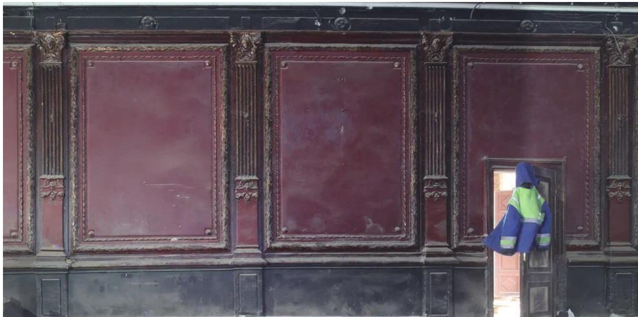
17. Объект культурного наследия регионального значения «Комплекс построек акционерного общества «Особняк З.Д. Мишукова (М.И. Алексеевой)», расположенный по адресу: Санкт-Петербург, Мошков переулок, дом 2, литера А.
