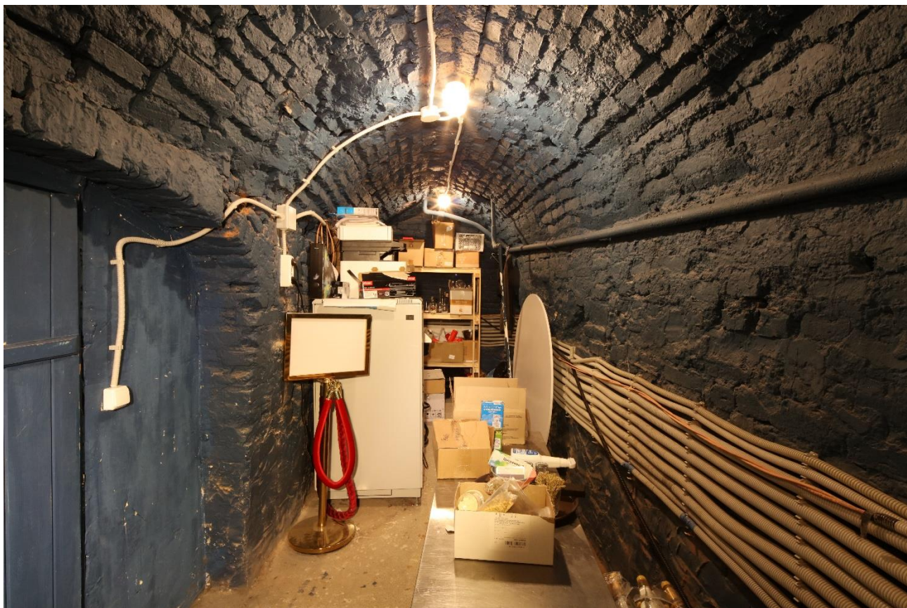
10. Объект культурного наследия регионального значения «Комплекс построек акционерного общества «Особняк З.Д. Мишукова (М.И. Алексеевой)», расположенный по адресу: Санкт-Петербург, Мошков переулок, дом 2, литера А.
