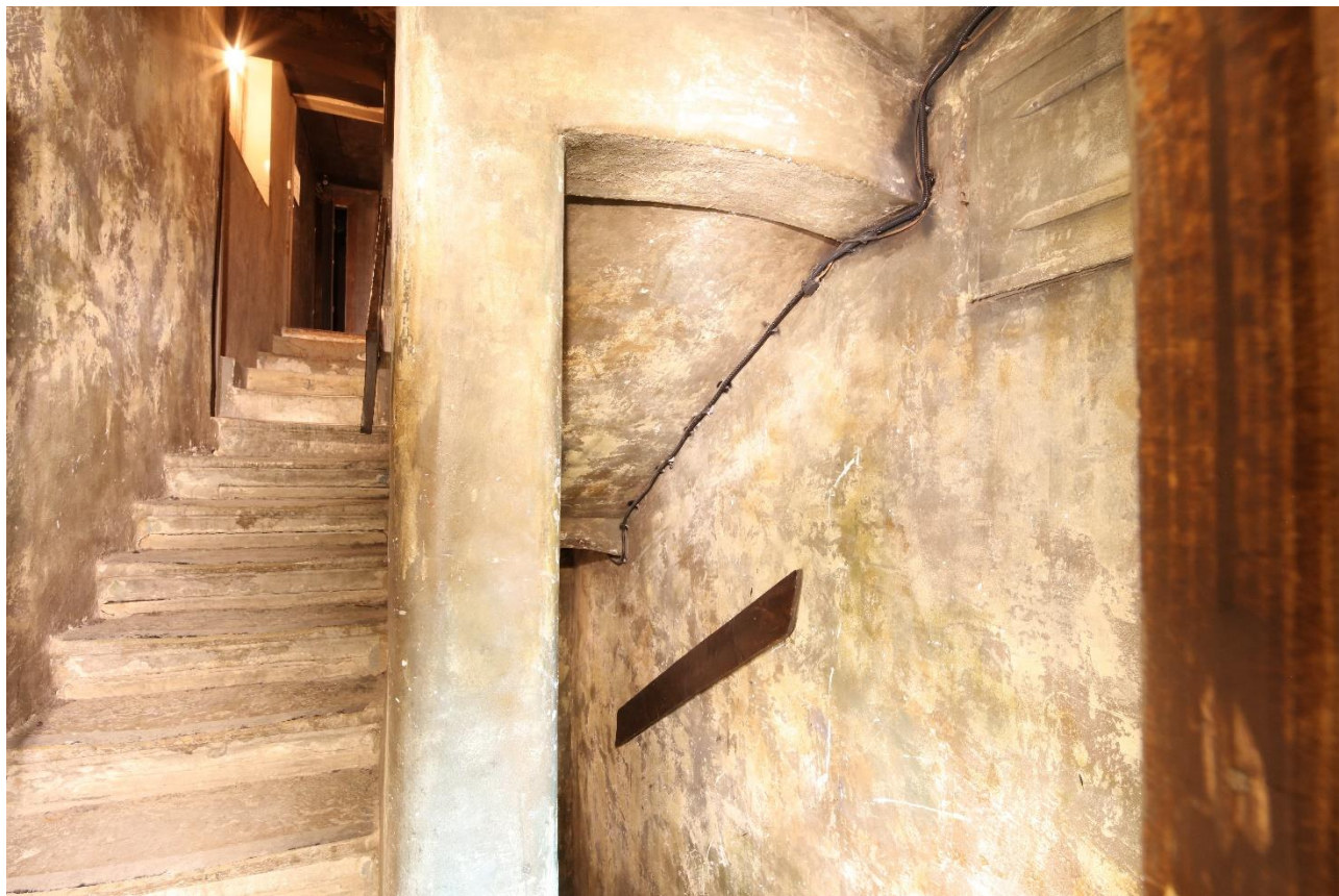
11. Объект культурного наследия регионального значения «Комплекс построек акционерного общества «Особняк З.Д. Мишукова (М.И. Алексеевой)», расположенный по адресу: Санкт-Петербург, Мошков переулок, дом 2, литера А.
