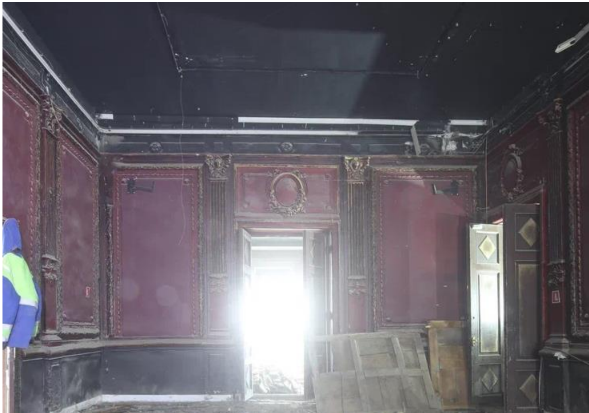
16. Объект культурного наследия регионального значения «Комплекс построек акционерного общества «Особняк З.Д. Мишукова (М.И. Алексеевой)», расположенный по адресу: Санкт-Петербург, Мошков переулок, дом 2, литера А.
