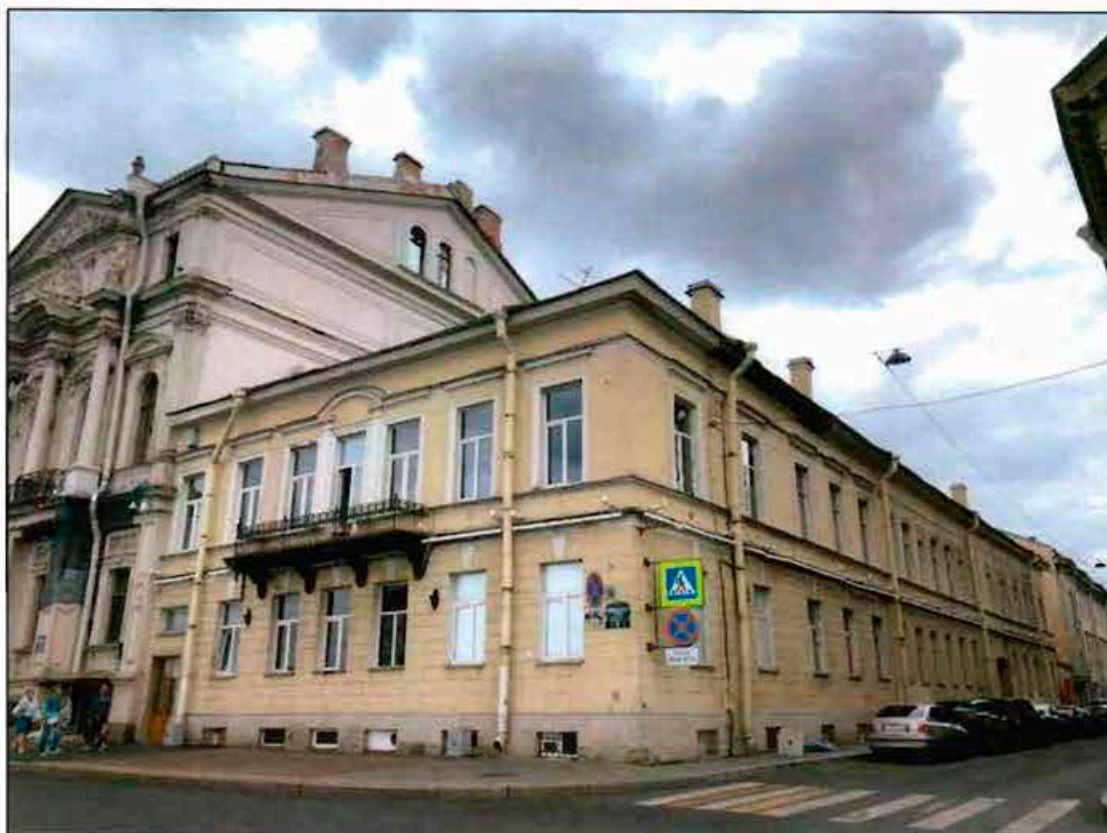
2. Общий вид на объект культурного наследия с северо-запада.
