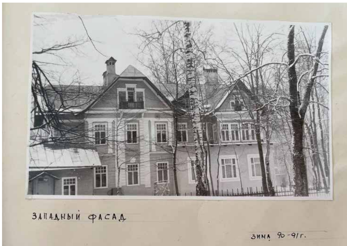
20. Западный фасад. Зима 1990-1991 гг. Архив КГИОП П774/Н-11225
