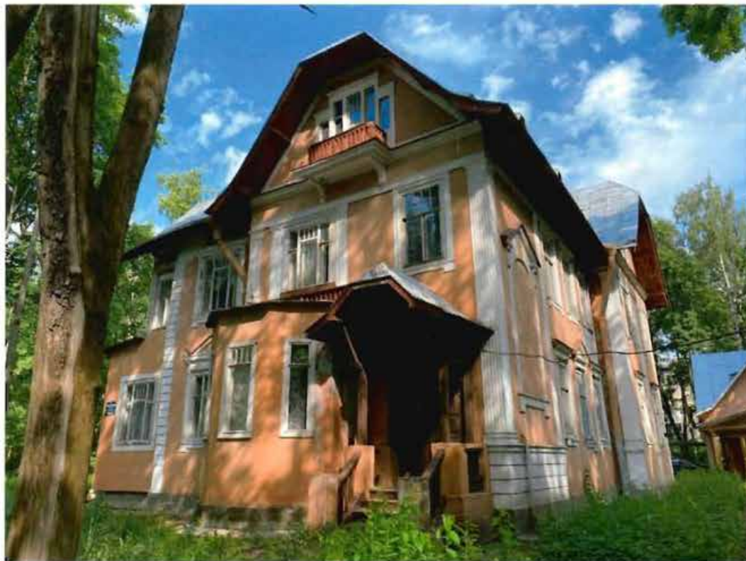
1. Общий вид на объект культурного наследия.
