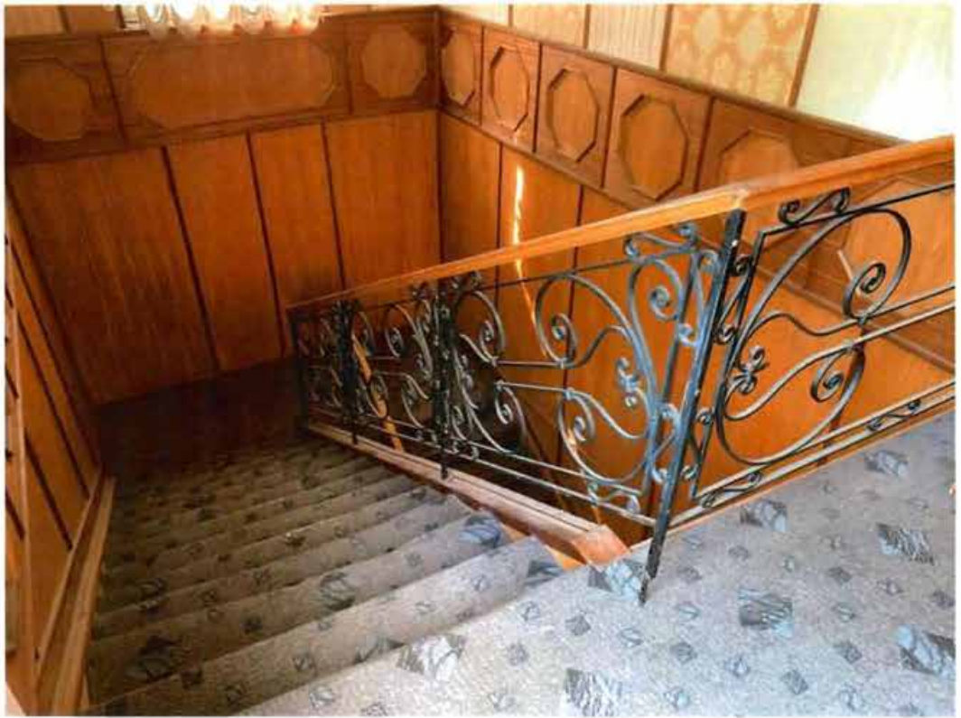
2. Общий вид на лестницу объекта культурного наследия.
