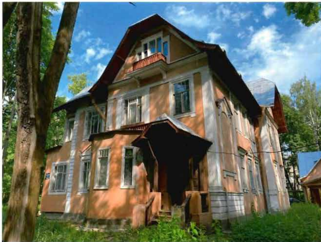
1. Общий вид на объект культурного наследия.
