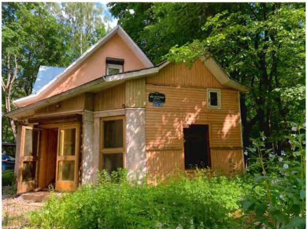
5. Общий вид на объект культурного наследия.
