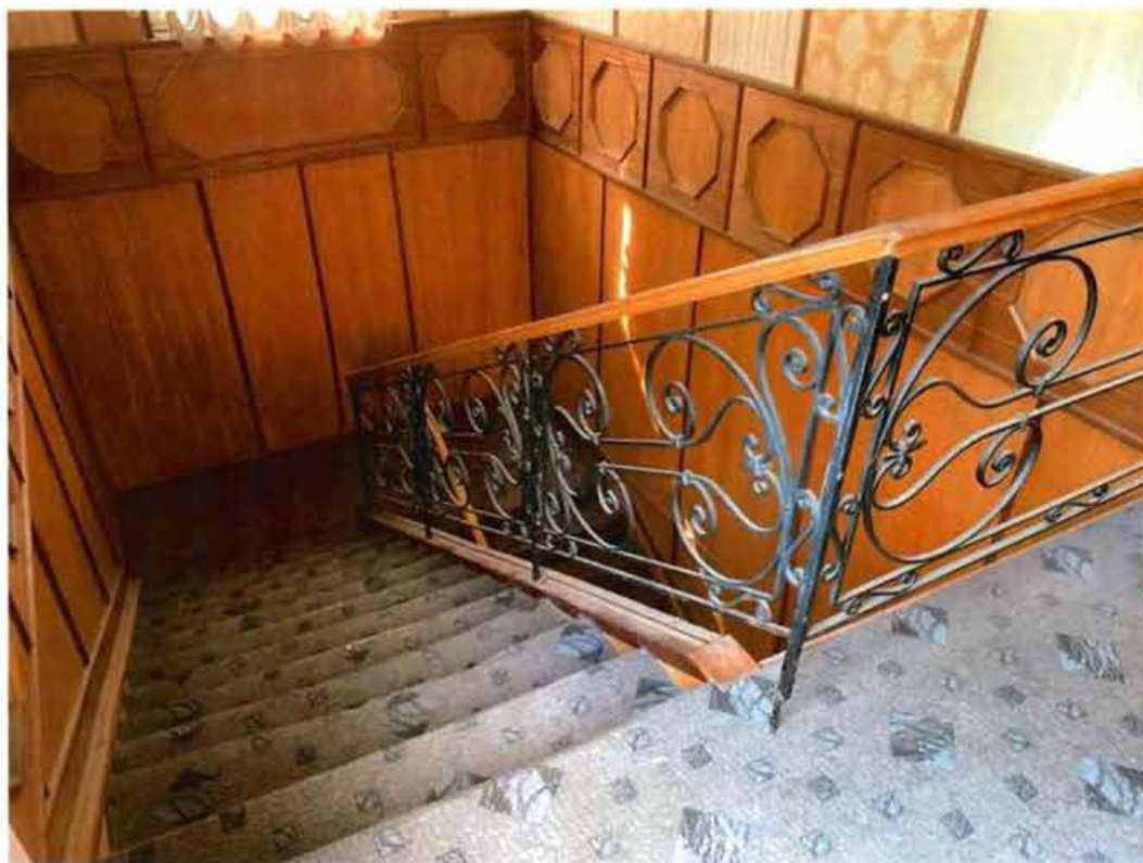
2. Общий вид на лестницу объекта культурного наследия.
