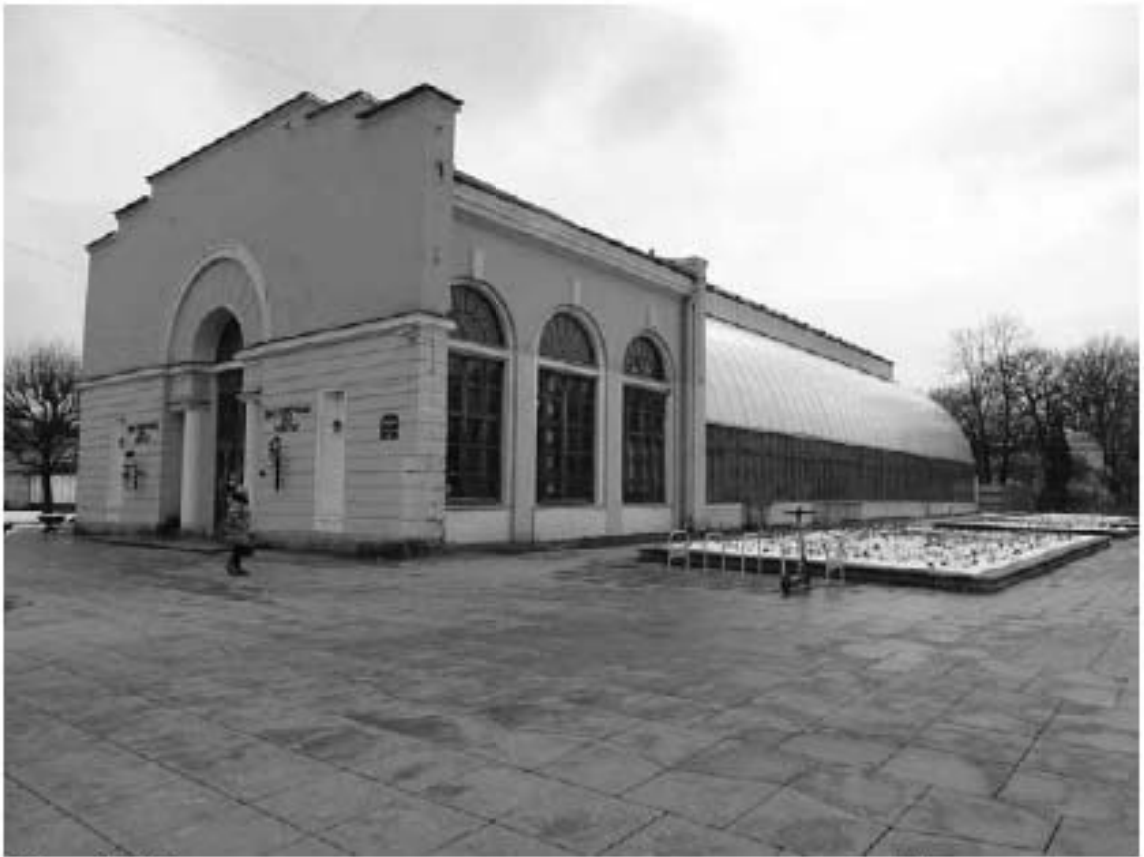
Фото 5. Объект культурного наследия регионального значения «Пальмовая оранжерея (Зимний сад)» (Потемкинская ул., д. 2, лит. Г). Северо-западный фасад. Съемка 28.03.2023 г. Трушковский В.Э.
