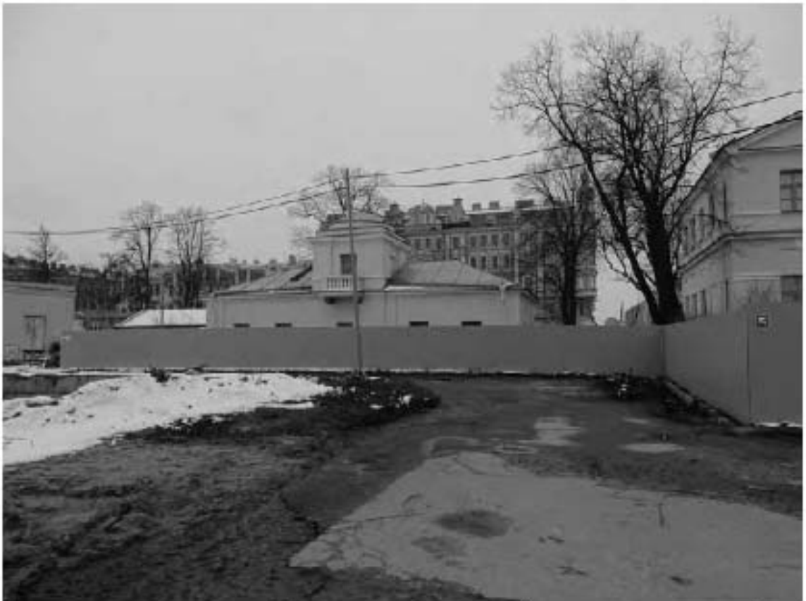
Фото 9. Объект культурного наследия федерального значения «Дом садовника с двумя флигелями», входящий в состав объекта культурного наследия федерального значения «Дворец Таврический». Южный флигель. Съемка 28.03.2023 г. Трушковский В.Э.
