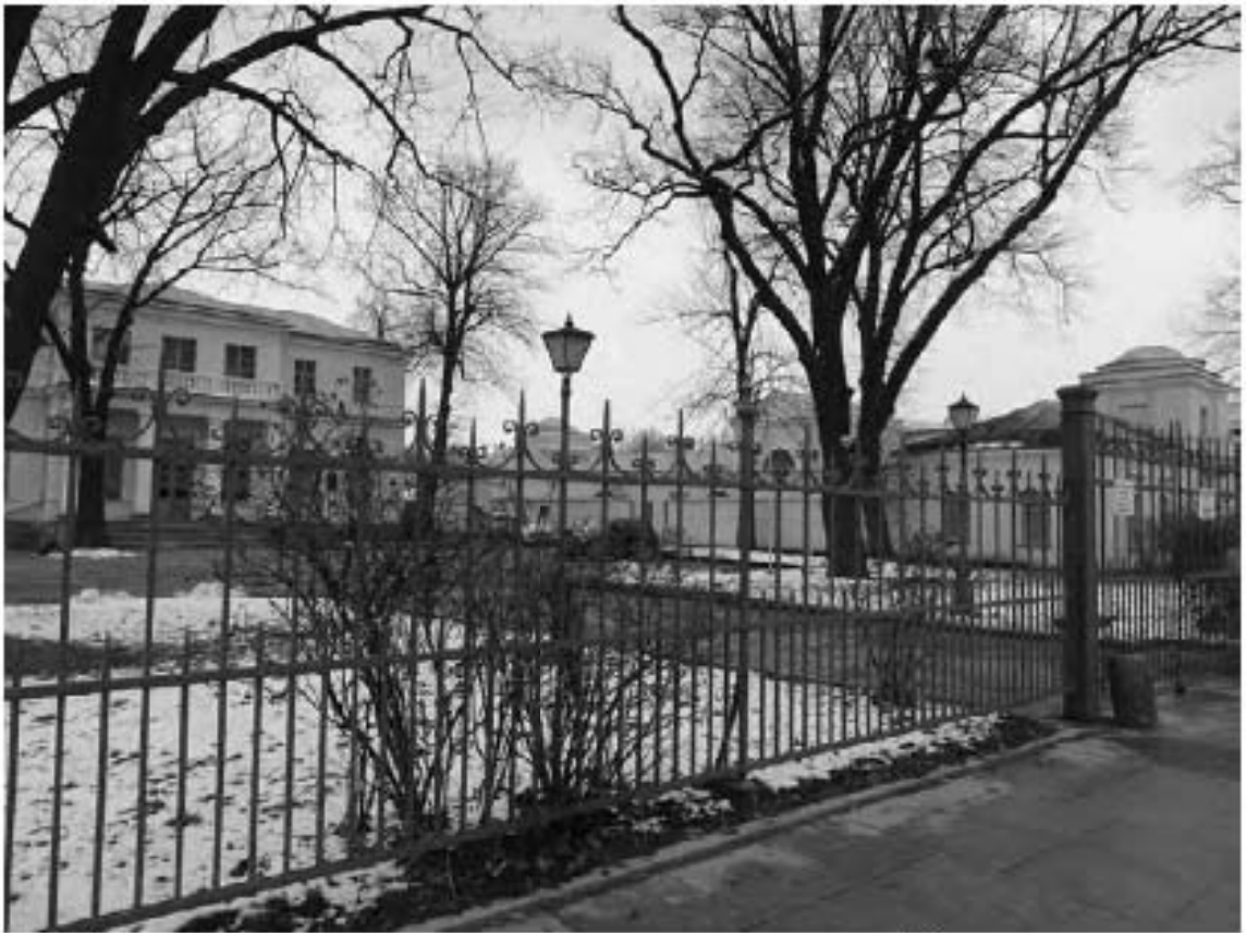
Фото 3. Объект культурного наследия федерального значения «Дом садовника с двумя флигелями», входящий в состав объекта культурного наследия федерального значения «Дворец Таврический». Съемка 28.03.2023 г. Трушковский В.Э.
