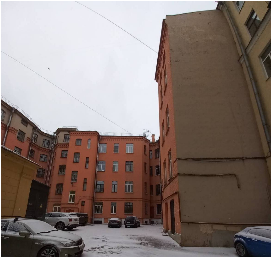
6. Фрагмент западного дворового фасада здания по адресу: Санкт-Петербург, проспект Обуховской обороны, д. 33, Лит. А
