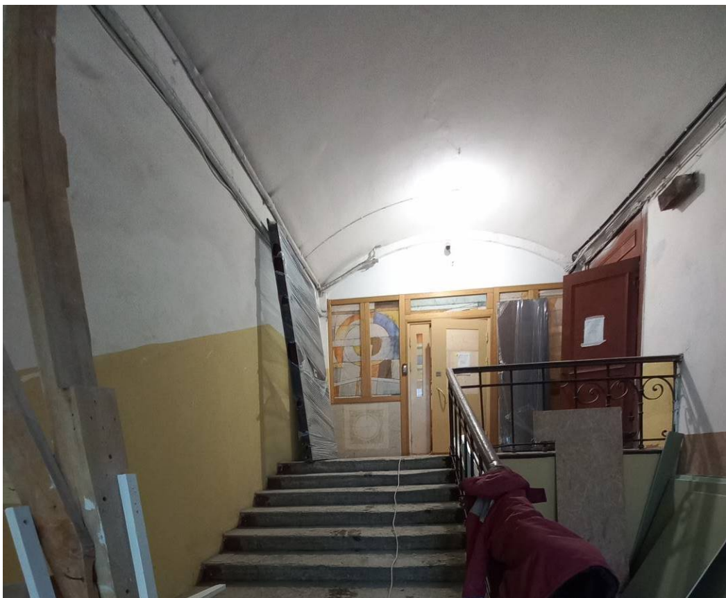
9. Здание по адресу: Санкт-Петербург, проспект Обуховской обороны, д. 33, Лит. А. Общий вид помещения вестибюля парадной лестницы ЛК-1. Коробовый свод
