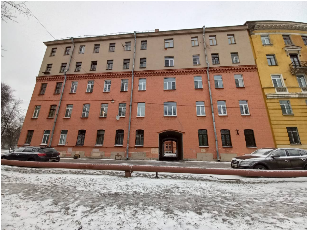
4. Общий вид юго-западного фасада здания по адресу: Санкт-Петербург, проспект Обуховской обороны, д. 33, Лит. А со стороны Стеклоанной улицы
