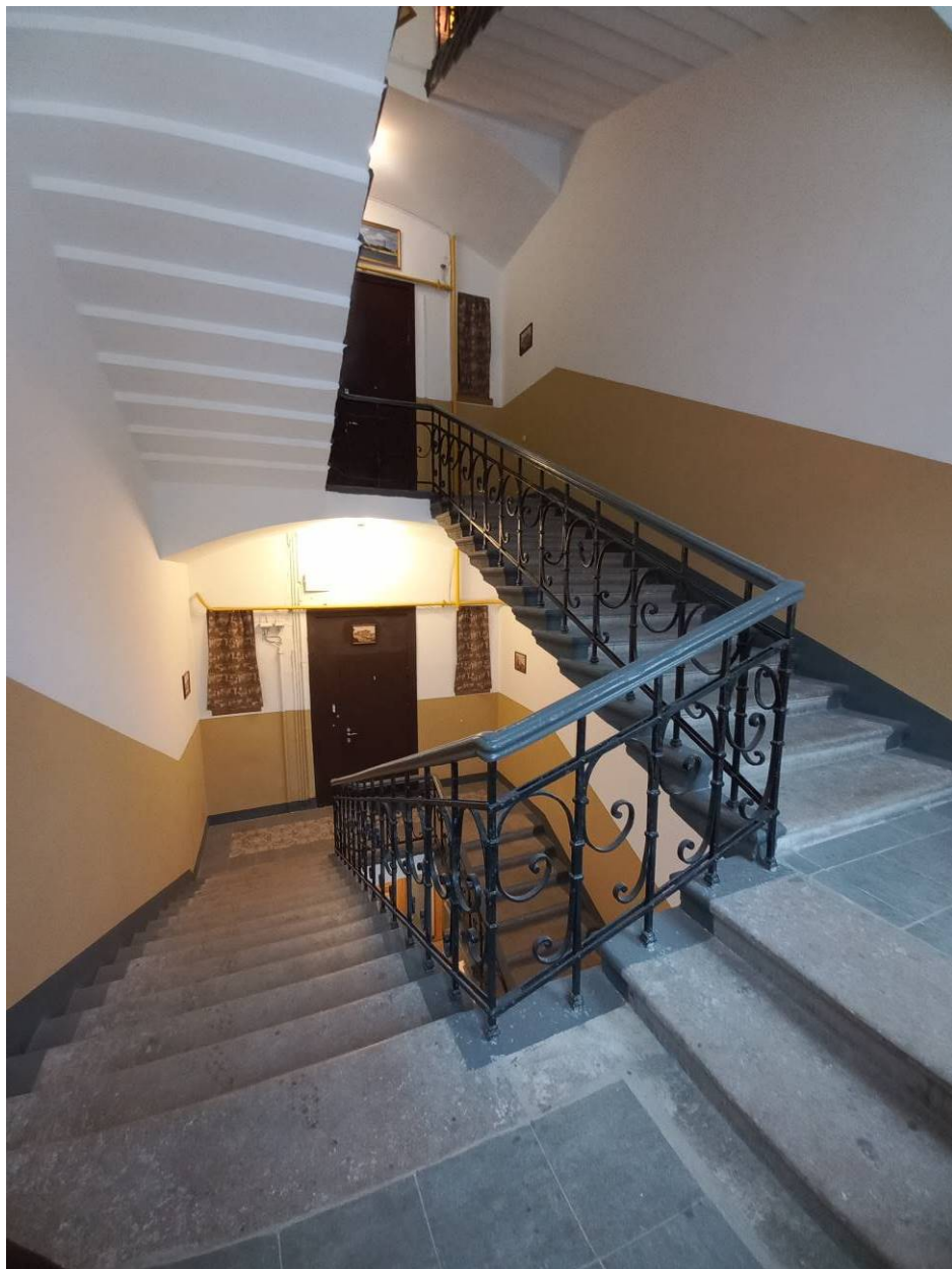
11. Здание по адресу: Санкт-Петербург, проспект Обуховской обороны, д. 33, Лит. А. Общий вид парадную лестничную клетку ЛК-1. Третий этаж.
