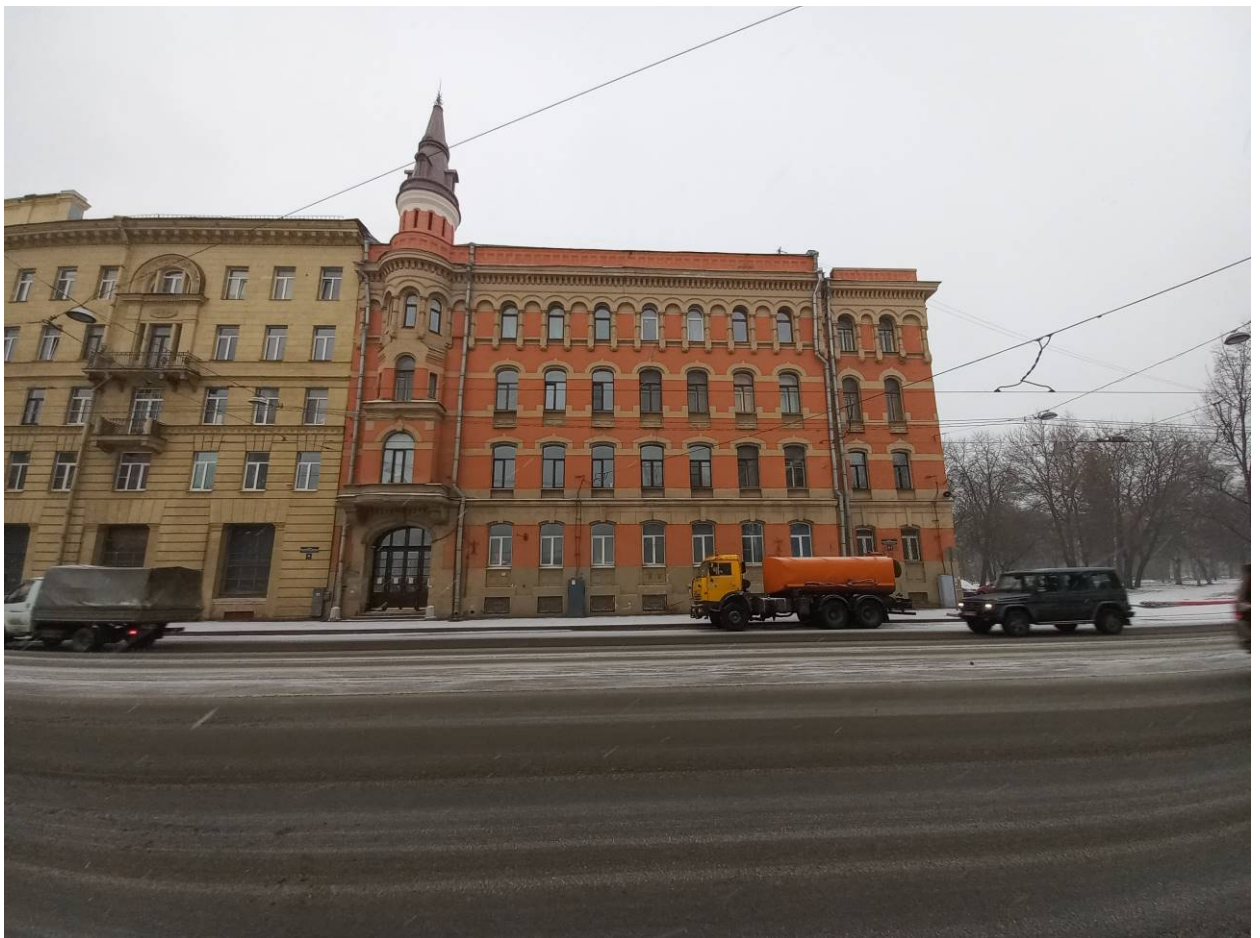
1. Общий вид лицевого фасада здания по адресу: Санкт-Петербург, проспект Обуховской обороны, д. 33, Лит. А
