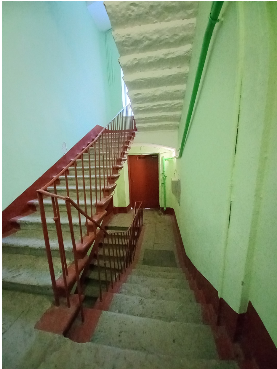
14. Здание по адресу: Санкт-Петербург, проспект Обуховской обороны, д. 33, Лит. А. Общий вид парадную лестничную клетку ЛК-3. Третий этаж.
