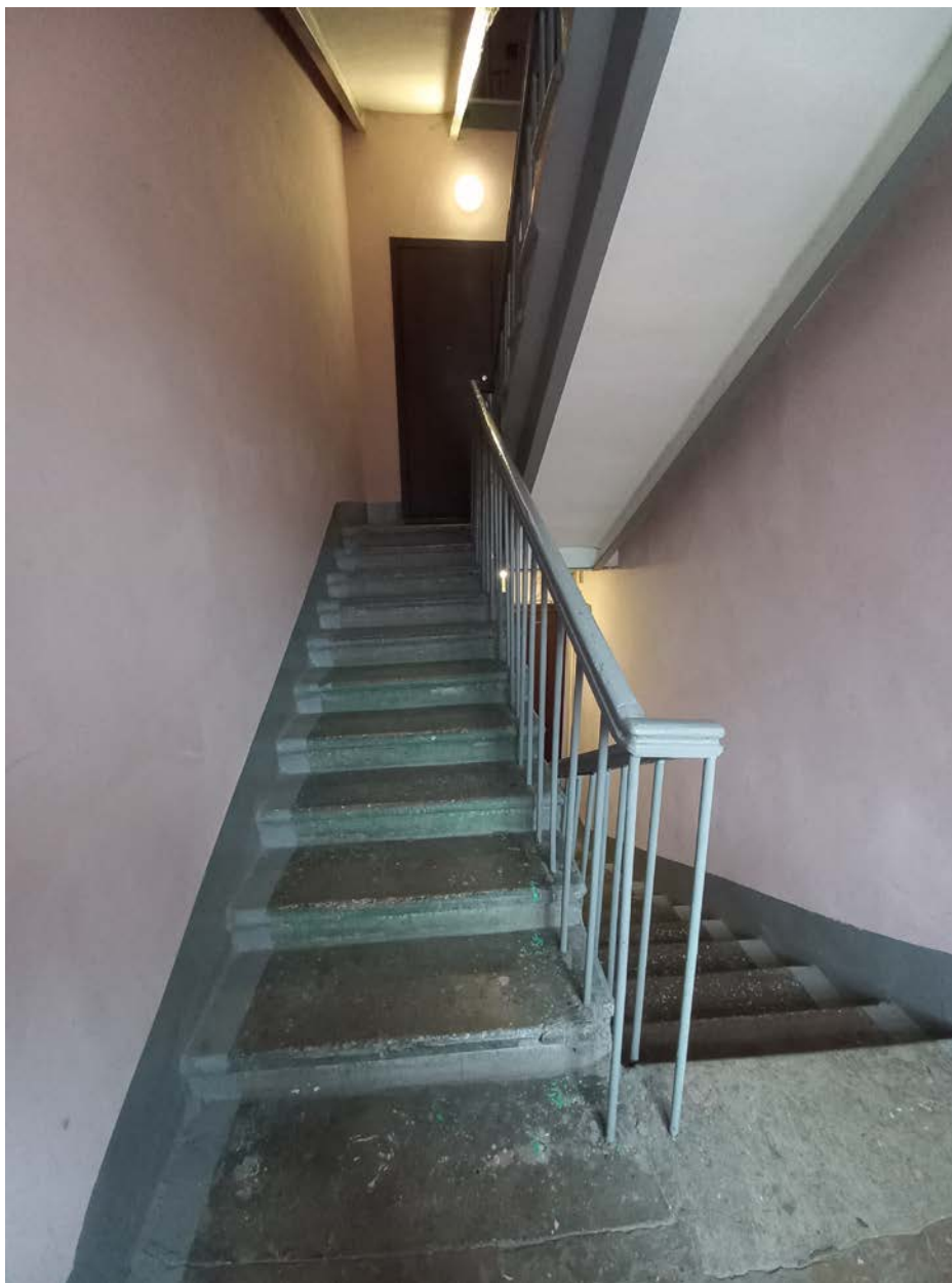
18. Здание по адресу: Санкт-Петербург, проспект Обуховской обороны, д. 33, Лит. А. Общий вид парадную лестничную клетку ЛК-5. Пятый этаж.
