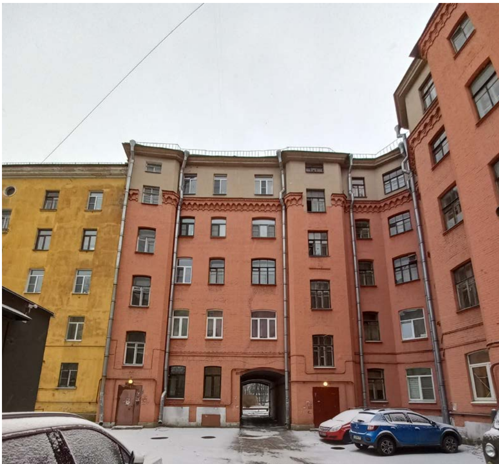
8. Общий вид юго-западного дворового фасада здания по адресу: Санкт-Петербург, проспект Обуховской обороны, д. 33, Лит. А
