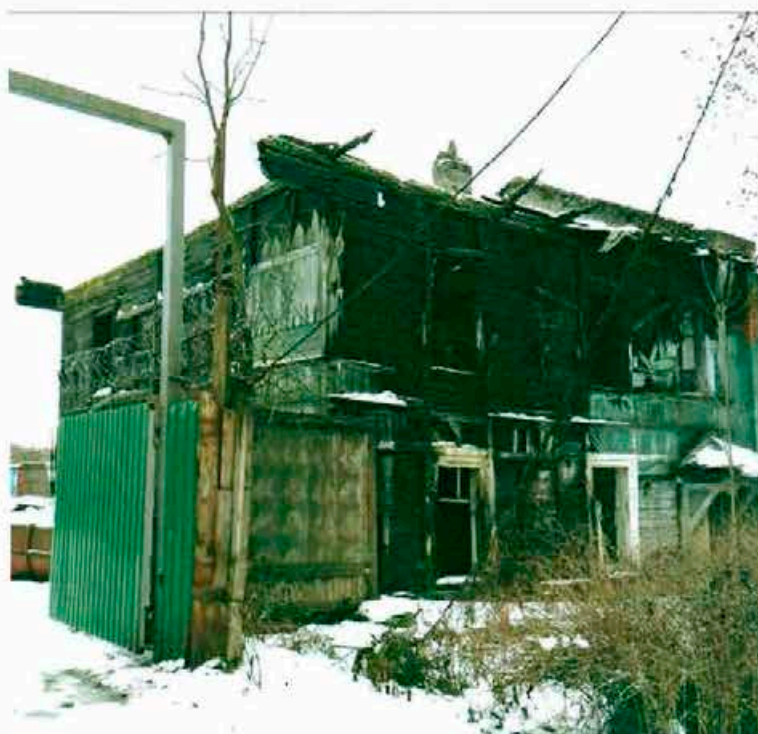
Фото 4. Северный и западный фасад.
