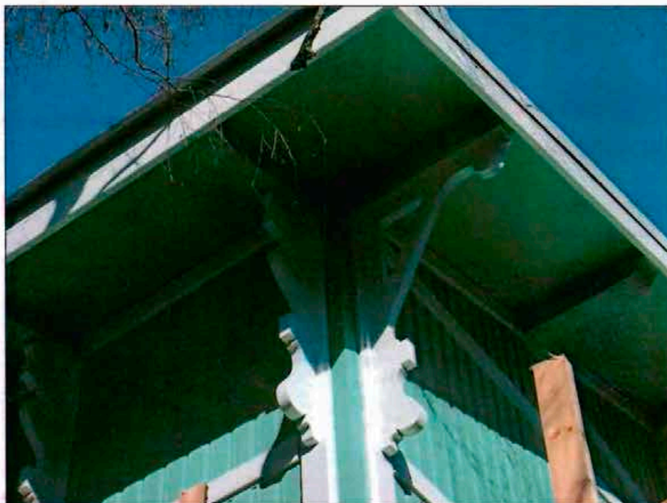
Фото 3. Южный фасад. Фрагмент. Кронштейны венчающего карниза.
