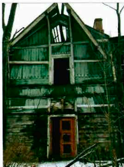
Фото 2. Часть западного фасада.
