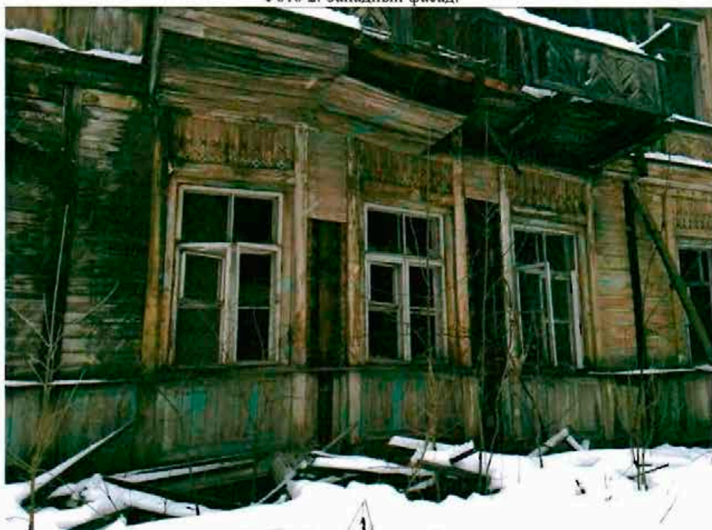
Фото 3. Часть северный фасад.
