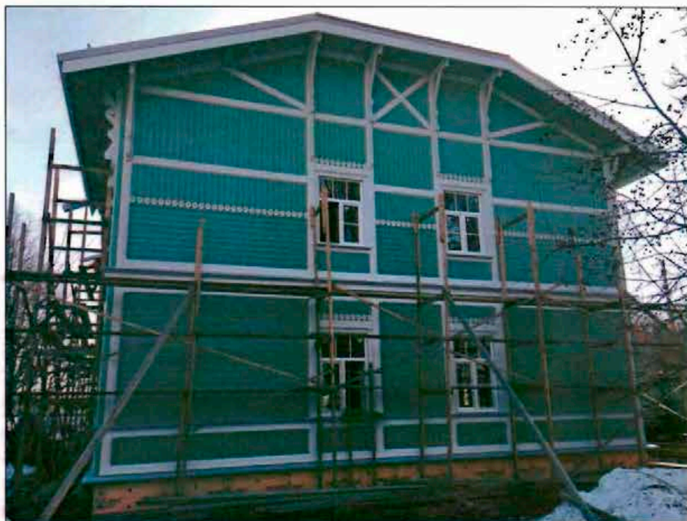
Фото 2. Южный фасад. Общий вид.
