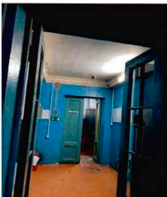
8. Помещения объекта культурного наследия.
