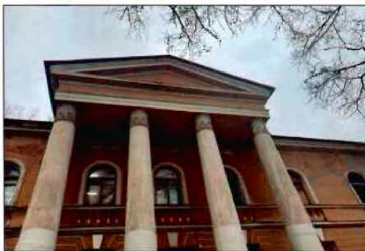
2. Фрагмент портика лицевого фасада объекта культурного наследия.
