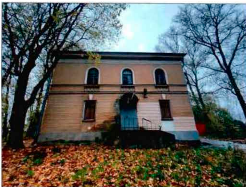
5. Восточный фасад объекта культурного наследия.
