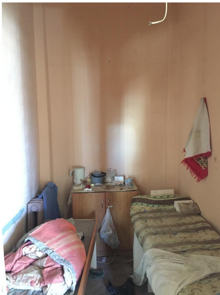
Фото 24. Интерьер квартиры №3 выявленного объекта культурного наследия «Съезжий дом 1-й Адмиралтейской части», ч.п. № 1
