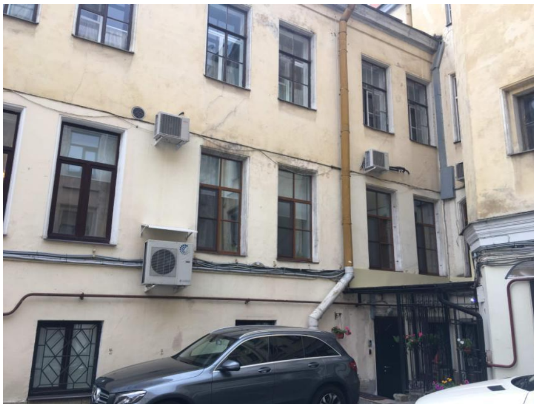
Фото 8. Фрагмент дворового фасада выявленного объекта культурного наследия «Съезжий дом 1-й Адмиралтейской части», оконные заполнения
