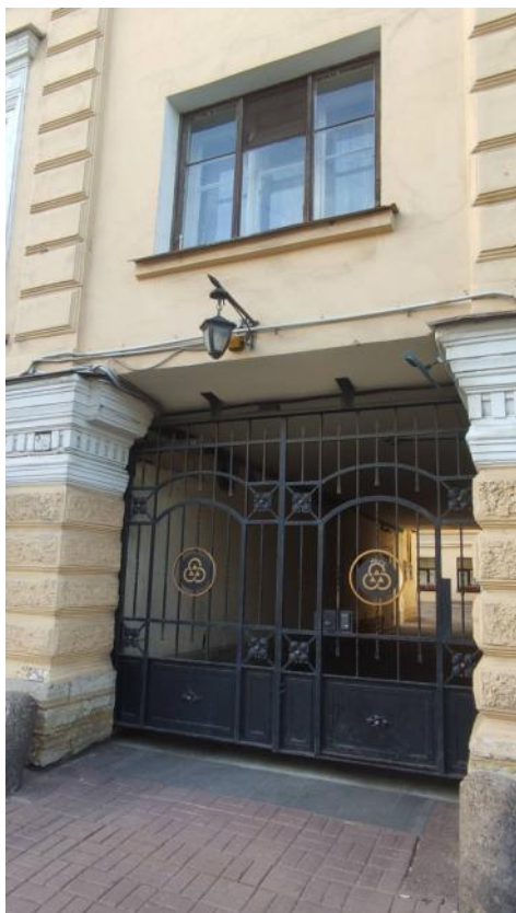
Фото 5. Воротный проезд выявленного объекта культурного наследия «Съезжий дом 1-й Адмиралтейской части», вид со стороны ул. Большой Морской
