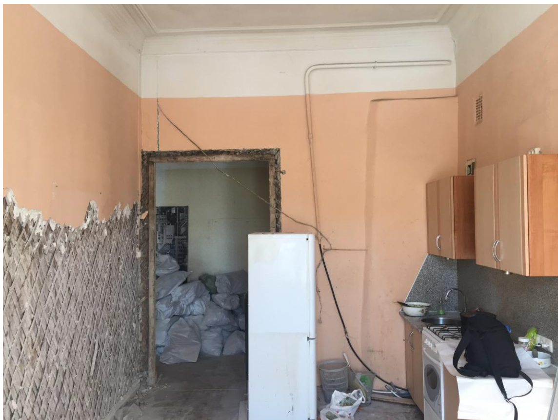
Фото 21. Интерьер квартиры №3 выявленного объекта культурного наследия «Съезжий дом 1-й Адмиралтейской части», ч.п. № 4
