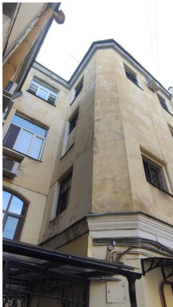
Фото 10. Фрагмент дворового фасада выявленного объекта культурного наследия «Съезжий дом 1-й Адмиралтейской части», скошенный угол корпуса
