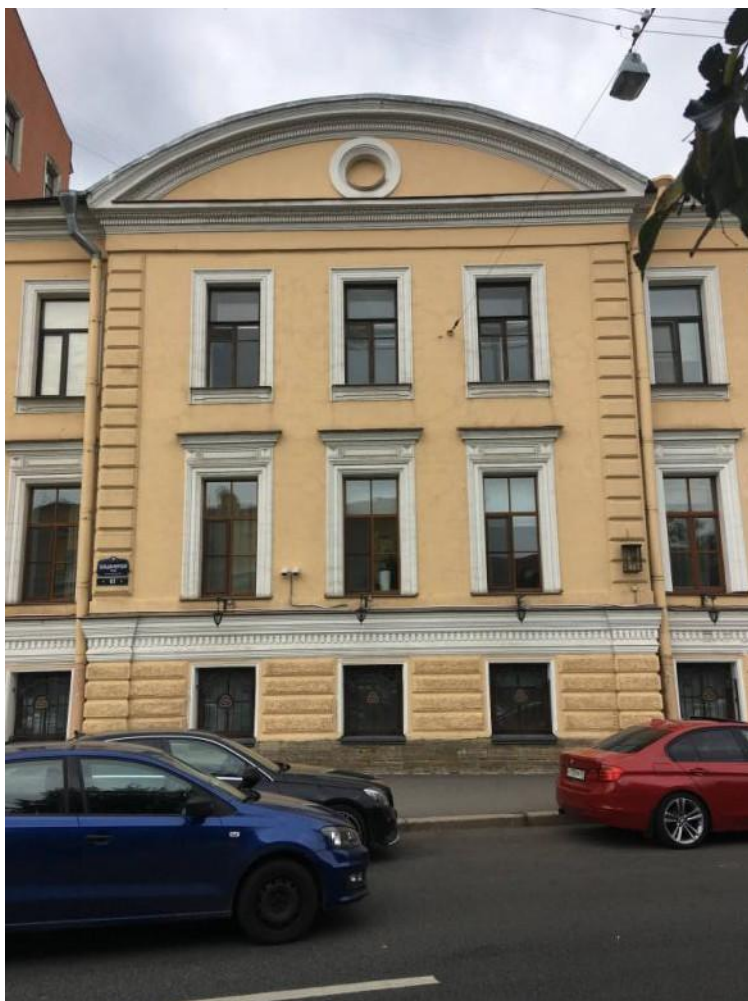
Фото 3. Фрагмент лицевого фасада выявленного объекта культурного наследия «Съезжий дом 1-й Адмиралтейской части», ризалит
