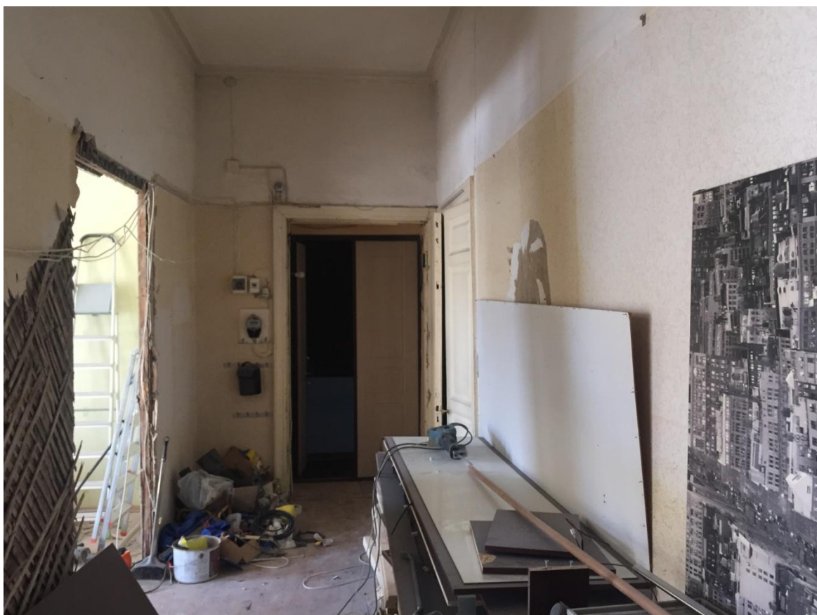
Фото 23. Интерьер квартиры №3 выявленного объекта культурного наследия «Съезжий дом 1-й Адмиралтейской части», ч.п. № 2
