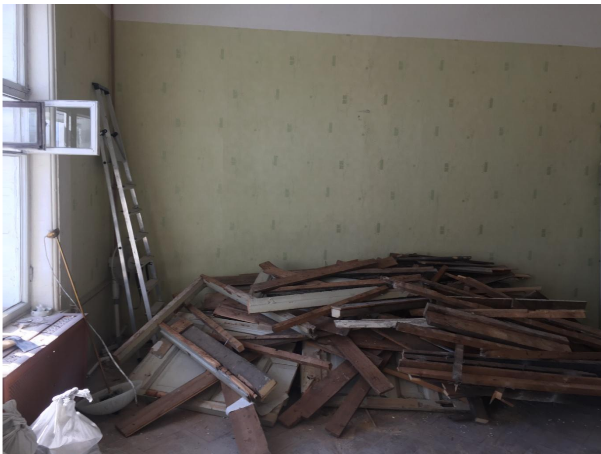
Фото 26. Интерьер квартиры №3 выявленного объекта культурного наследия «Съезжий дом 1-й Адмиралтейской части», ч.п. № 5
