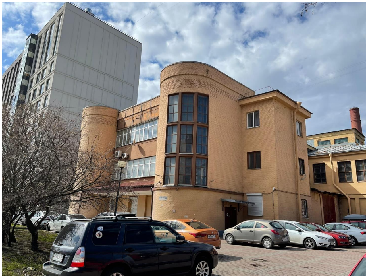
Фото 1. Фасад по Лиговскому пр. Юго-восток.
