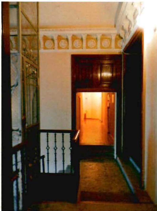
7. Лестничная клетка 3-го этажа
