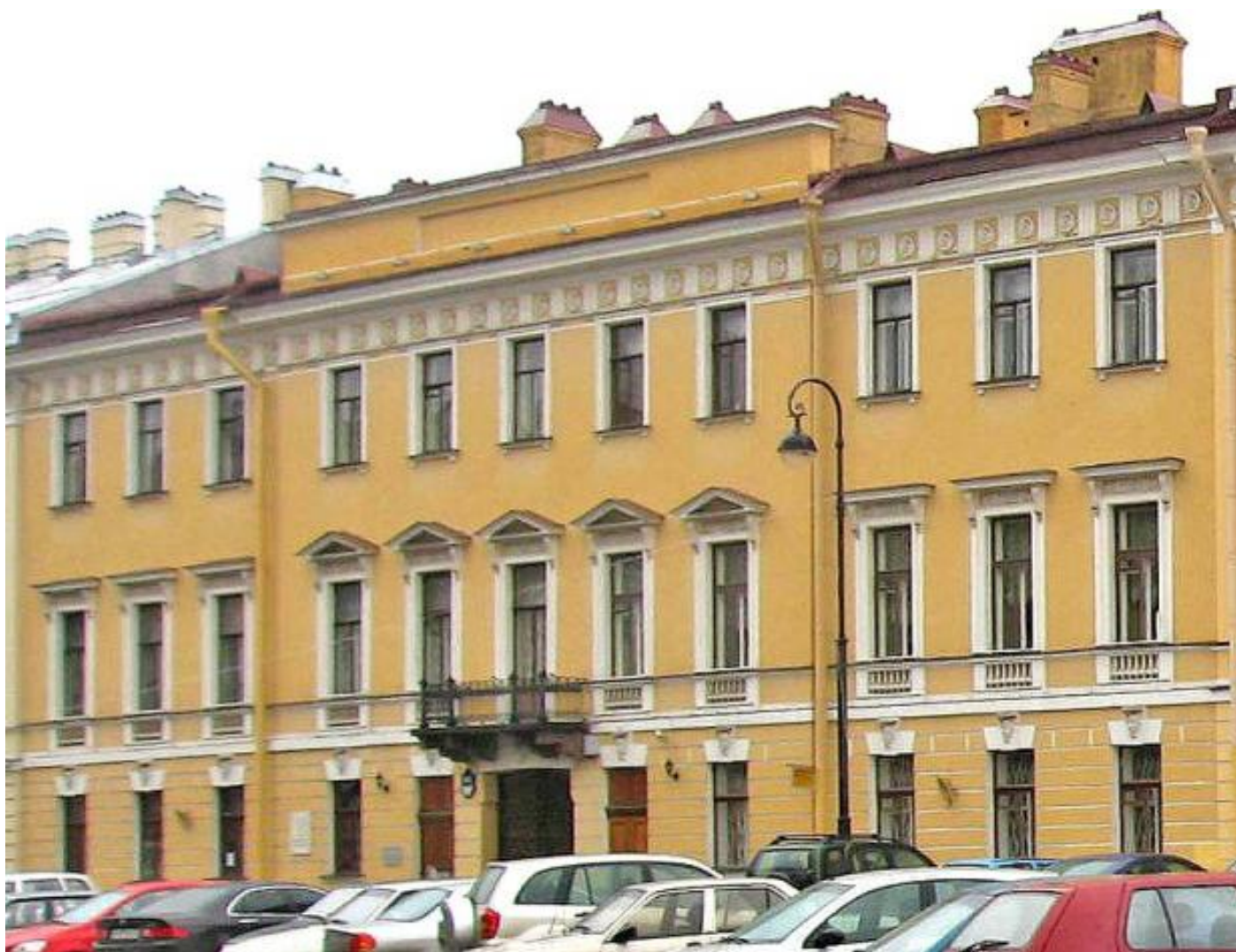
23. Лицевой фасад «Дома П.В. Голенищева-Кутузова». 2006
