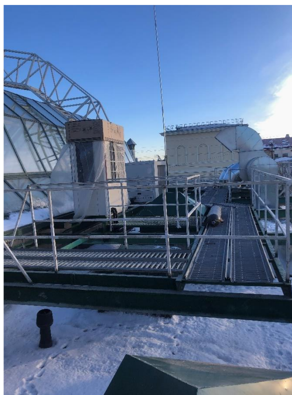
Фото 3. Вид на кровлю.
