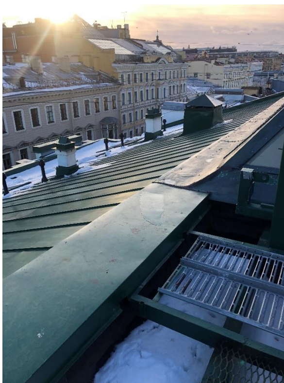
Фото 2. Вид на кровлю.
