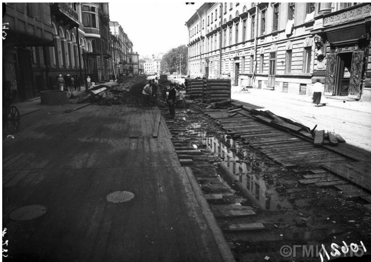
Илл. 51. Дорожные работы. Снятие деревянной мостовой на улице Ракова (Итальянской улице). 1925 г. ГМИ СПб 221178
