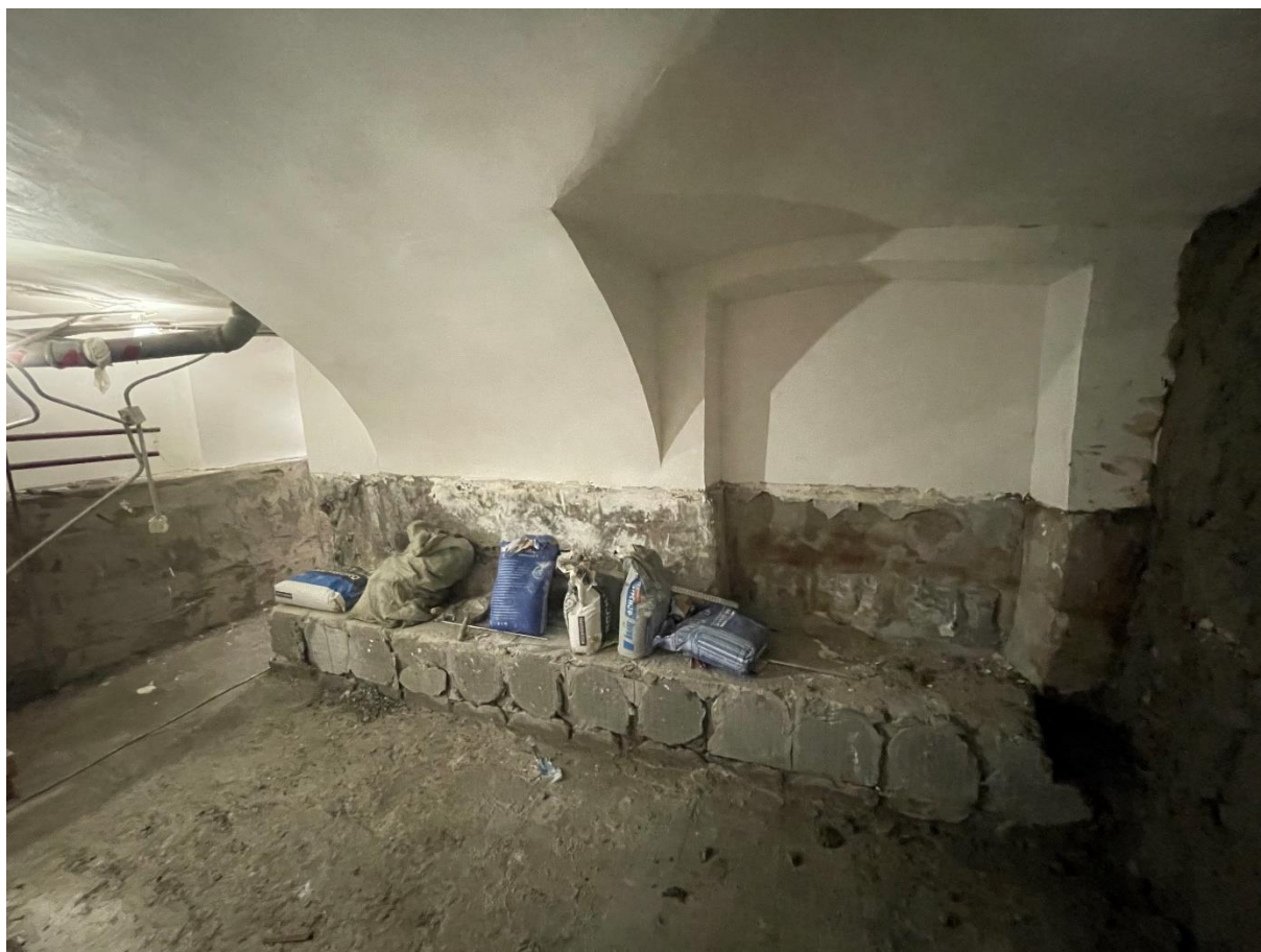
Фото 1. Вид на подвальные помещения.
