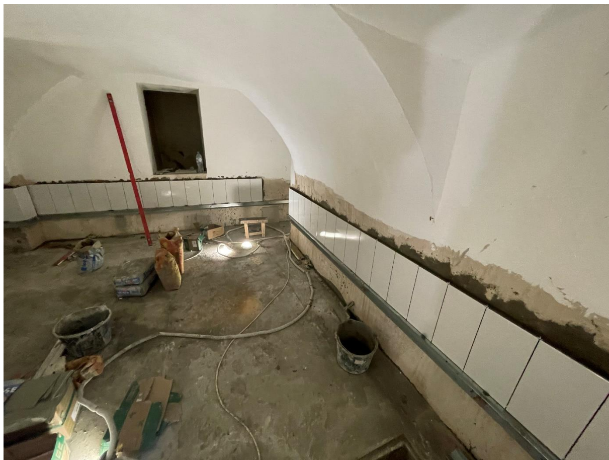
Фото 2. Вид на подвальные помещения.
