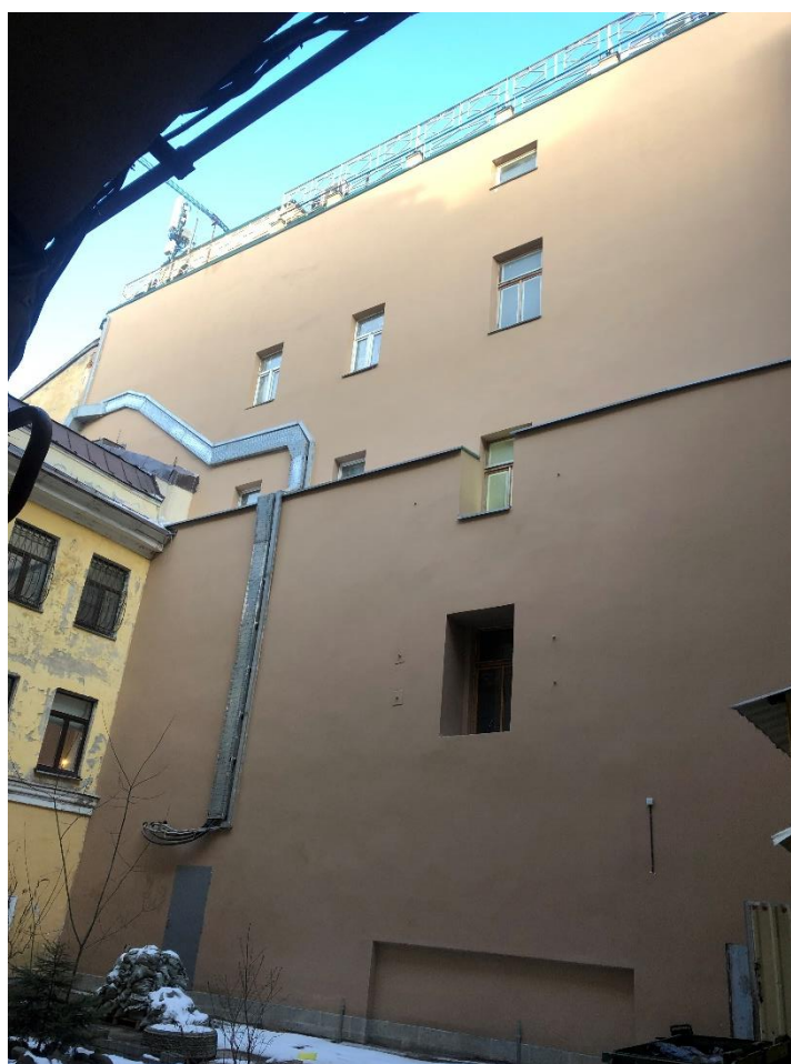
Фото 2. Вид на дворовый фасад.
