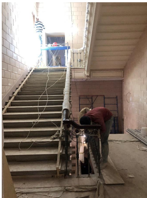
Фото 14. Вид на лестницу.
