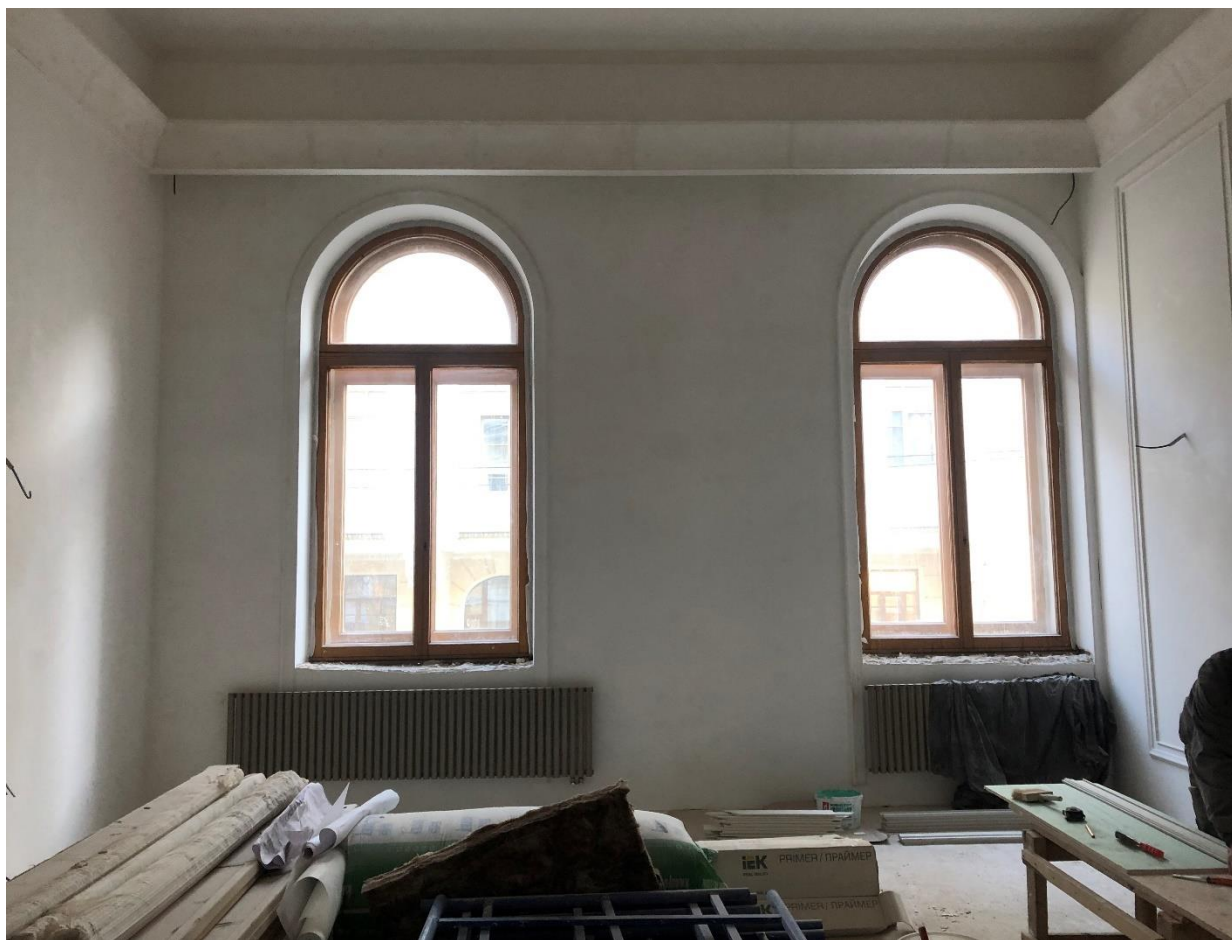
Фото 12. Вид на внутренние помещения 2-го этажа.
