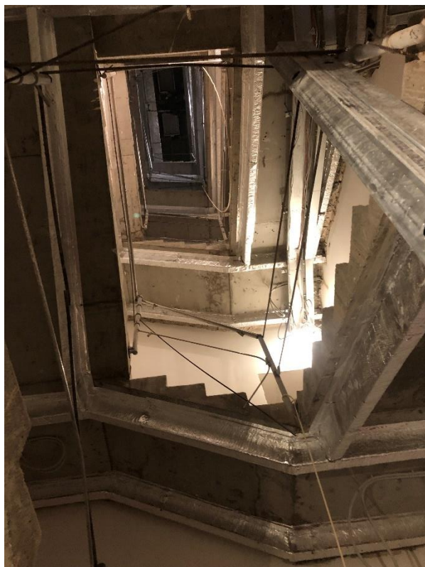
Фото 5. Вид на внутренние помещения 1-го этажа.
