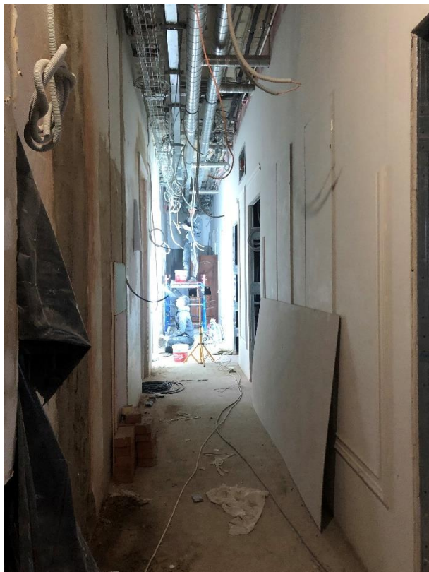
Фото 15. Вид на внутренние помещения 4-го этажа.
