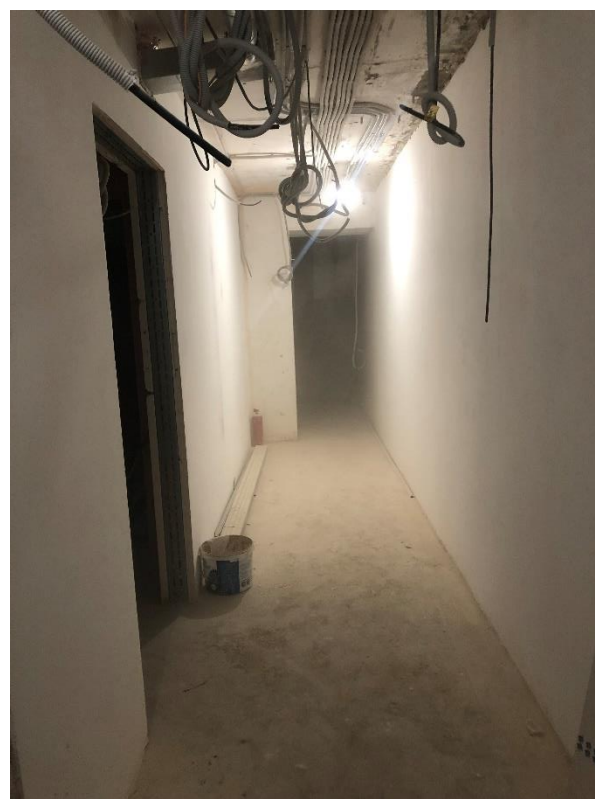
Фото 24. Вид на внутренние помещения 4-5-го этажа.
