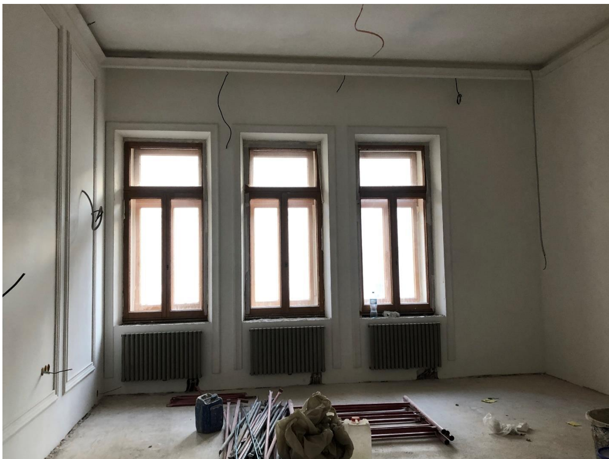
Фото 18. Вид на внутренние помещения 4-го этажа.
