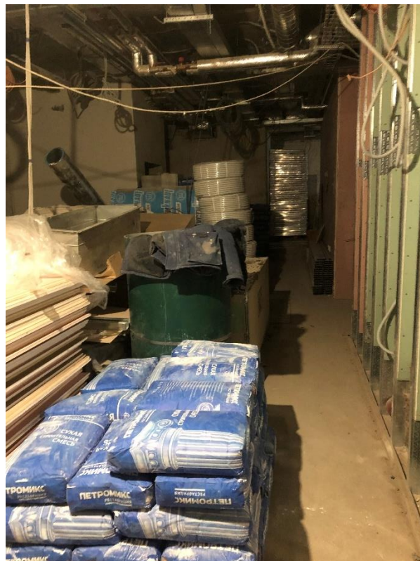
Фото 2. Вид на внутренние помещения 1-го этажа.
