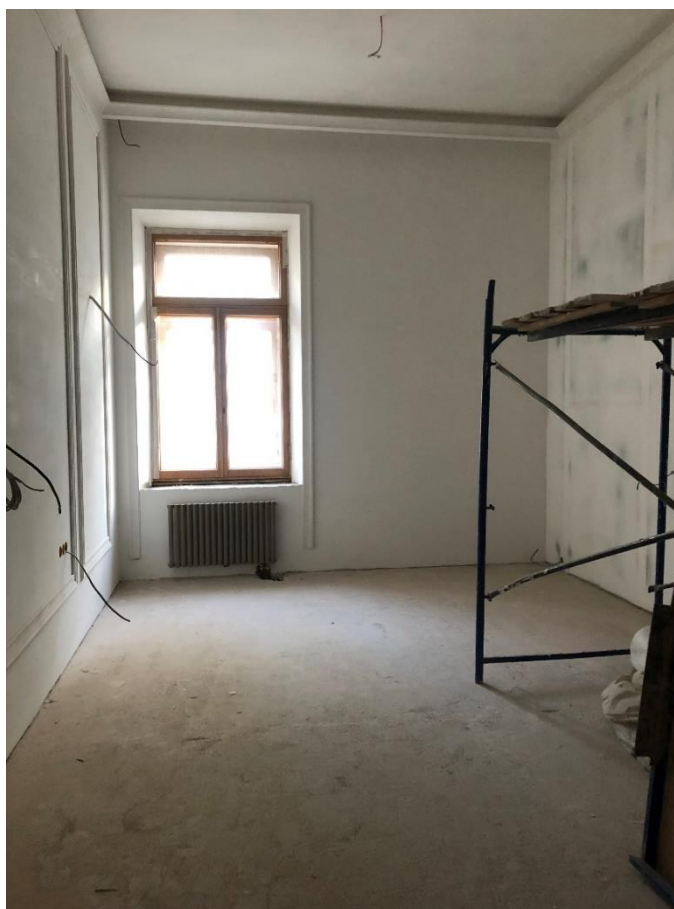
Фото 17. Вид на внутренние помещения 4-го этажа.
