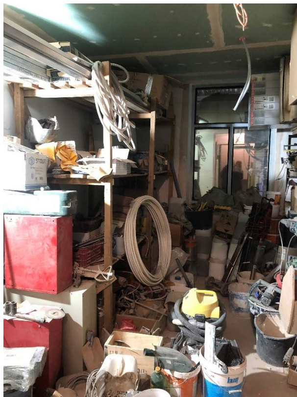
Фото 20. Вид на внутренние помещения 3-го этажа.
