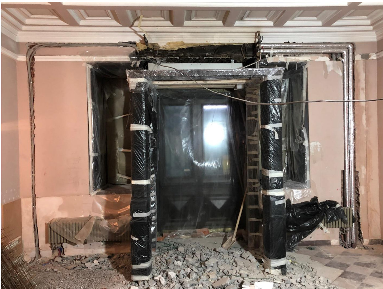
Фото 9. Вид на внутренние помещения 1-го этажа.
