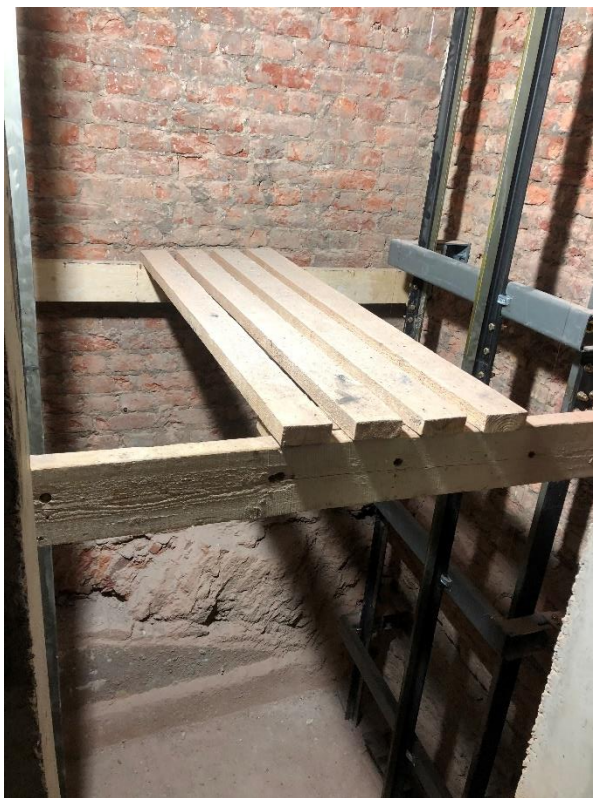
Фото 6. Вид на внутренние помещения 1-го этажа.
