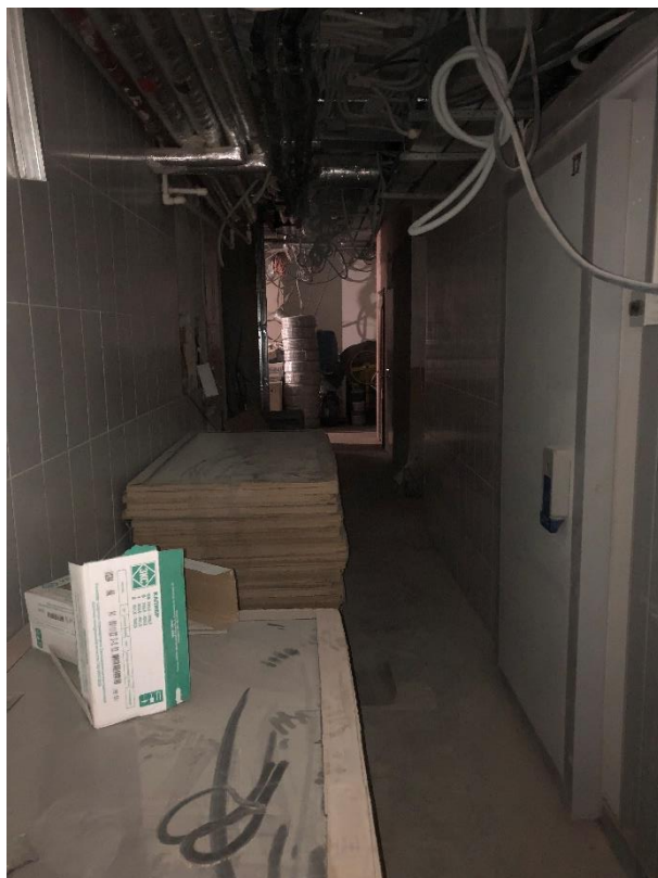
Фото 7. Вид на внутренние помещения 1-го этажа.
