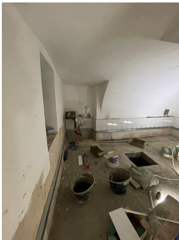
Фото 4. Вид на подвальные помещения.
