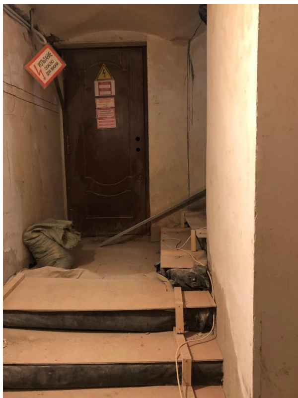
Фото 10. Вид на лестницу.
