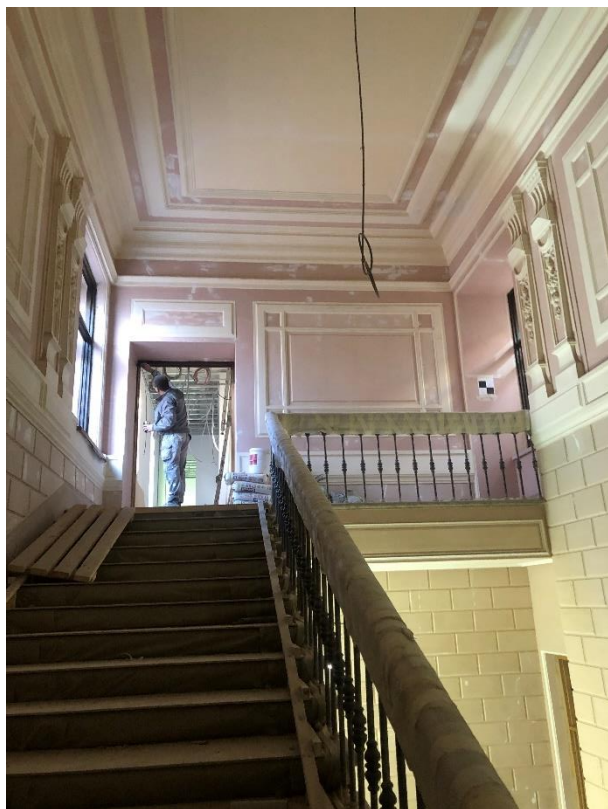
Фото 19. Вид на лестницу.
