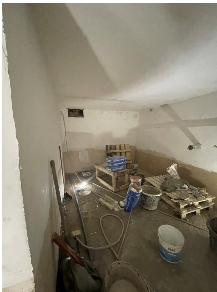
Фото 5. Вид на подвальные помещения.
