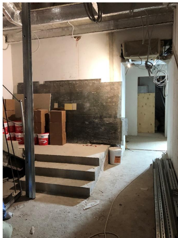
Фото 4. Вид на внутренние помещения 1-го этажа.
