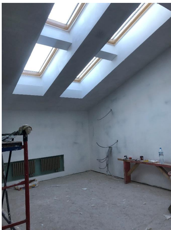
Фото 23. Вид на внутренние помещения 4-5-го этажа.
