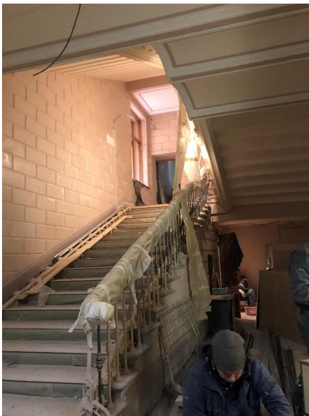
Фото 8. Вид на внутренние помещения 1-го этажа.
