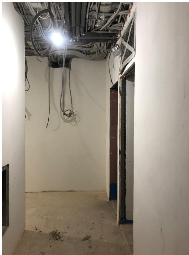
Фото 21. Вид на внутренние помещения 4-5-го этажа.
