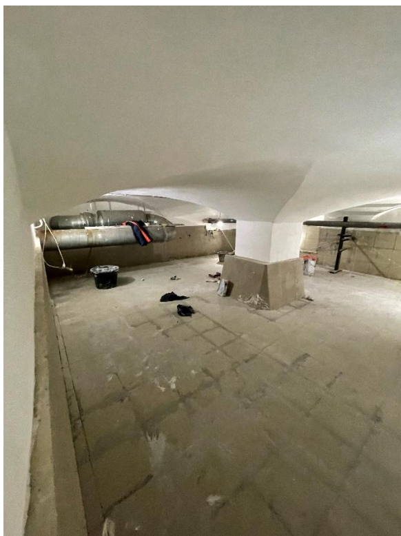
Фото 3. Вид на подвальные помещения.
