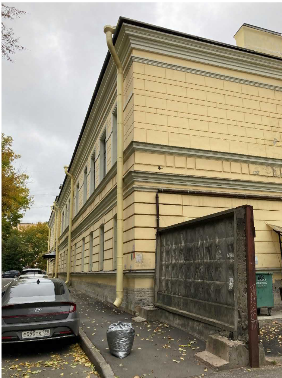
Фото 8. Фасад здания со стороны пер. Ногина, д.2
