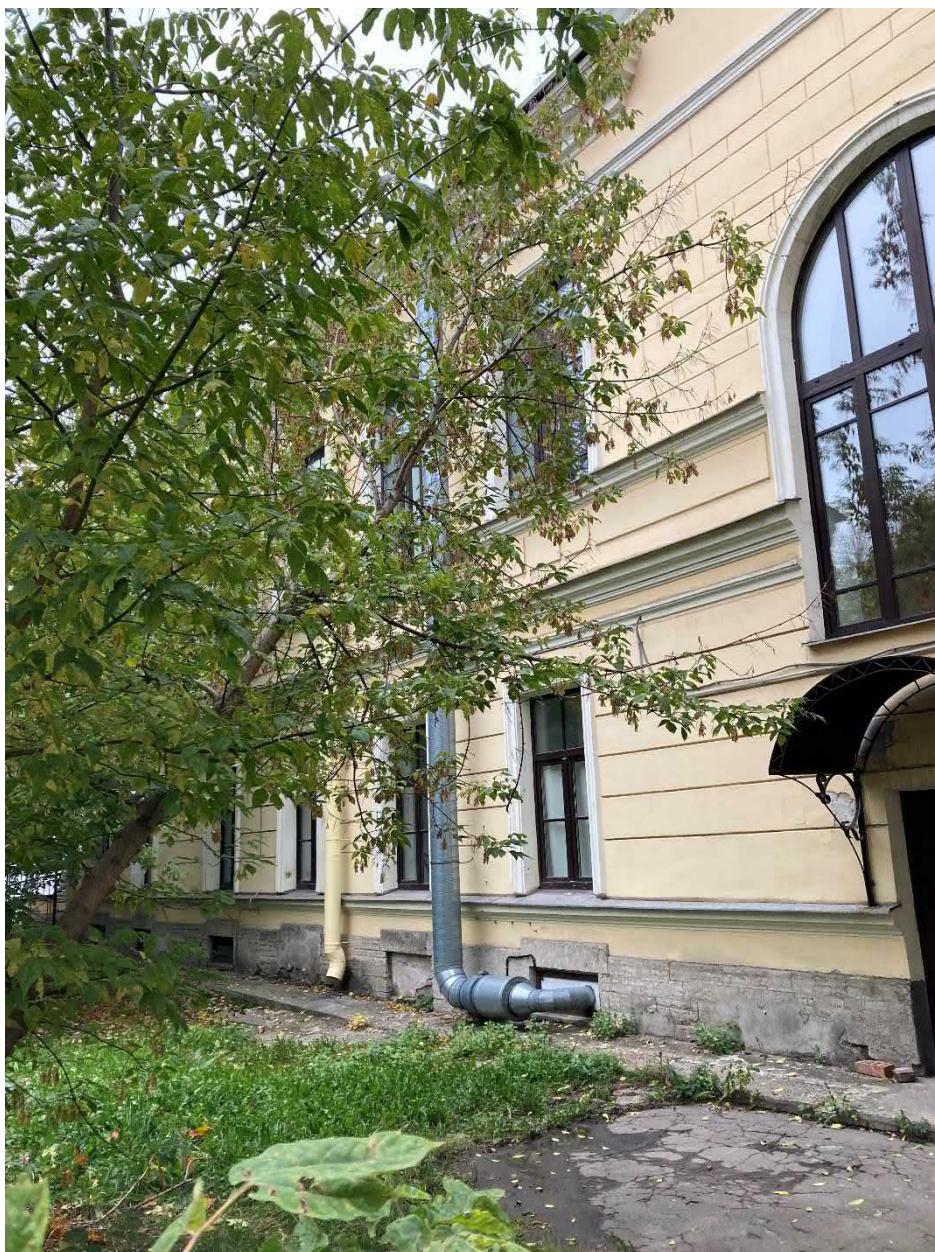
Фото 14. Фасад здания со стороны двора
