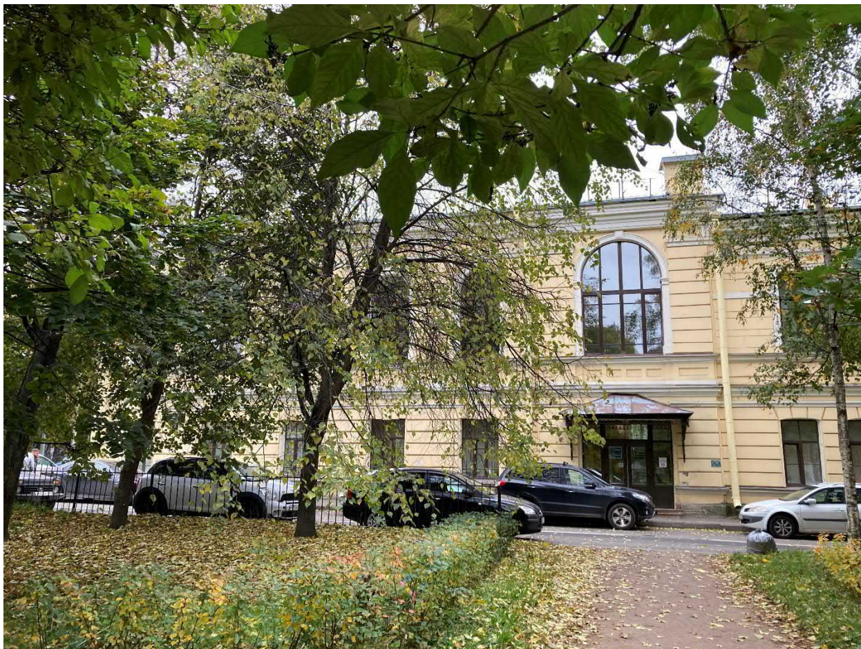
Фото 7. Фасад здания со стороны пер. Ногина, д.2
