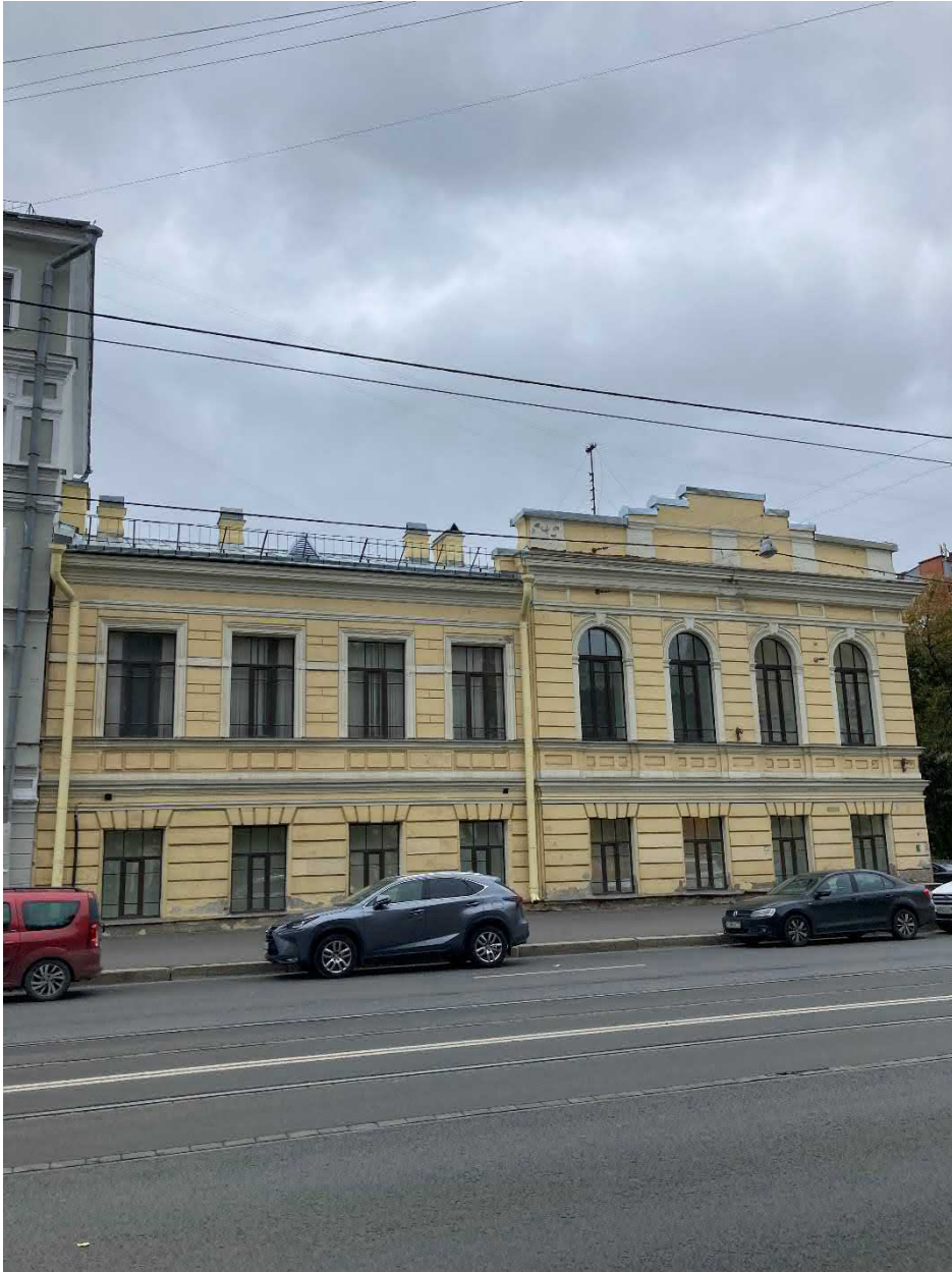
Фото 1. Фасад здания со стороны пр.Обуховской Обороны, д.85
