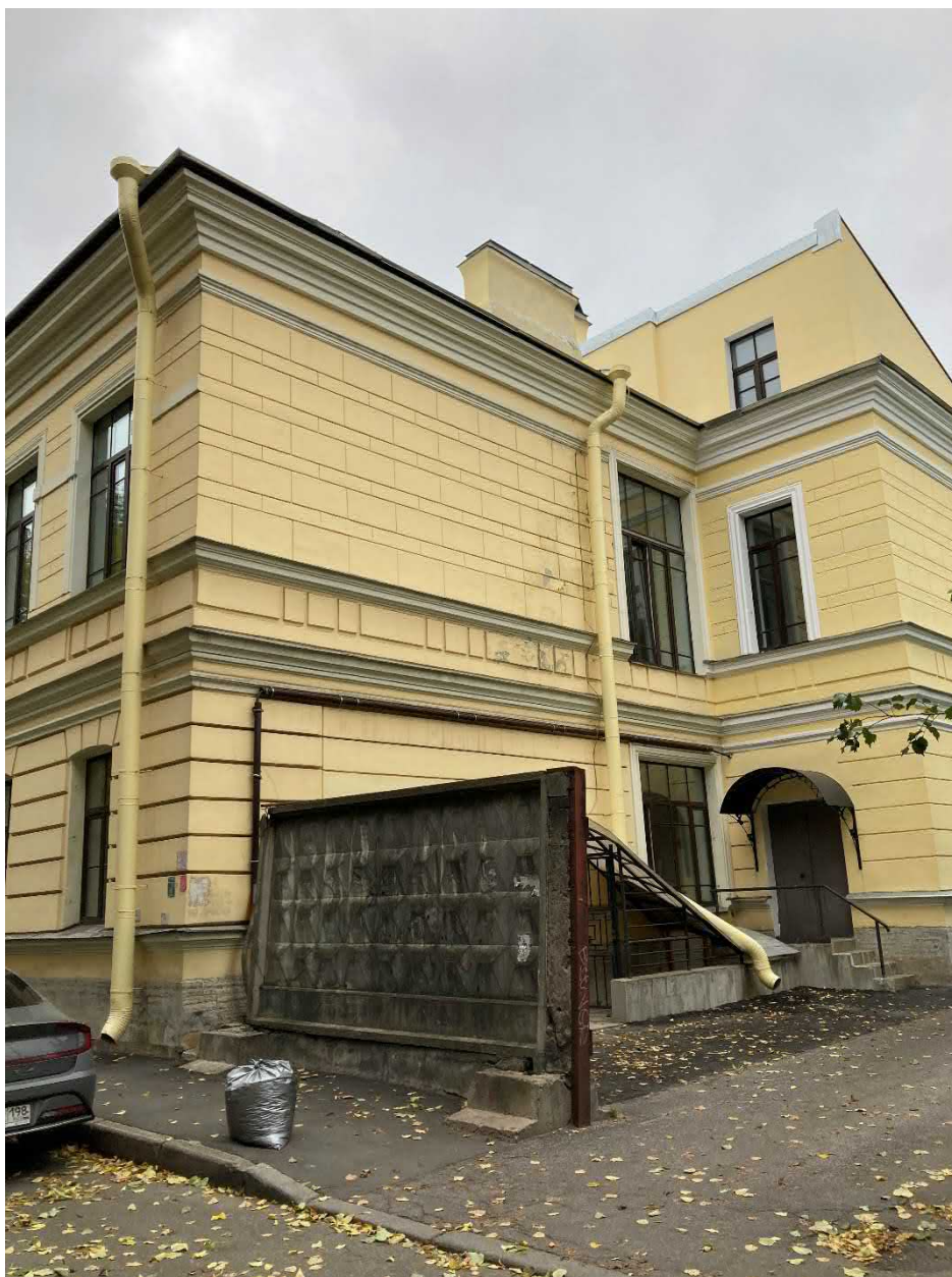
Фото 9. Фасад здания со стороны пер. Ногина, д.2. Вид со стороны двора
