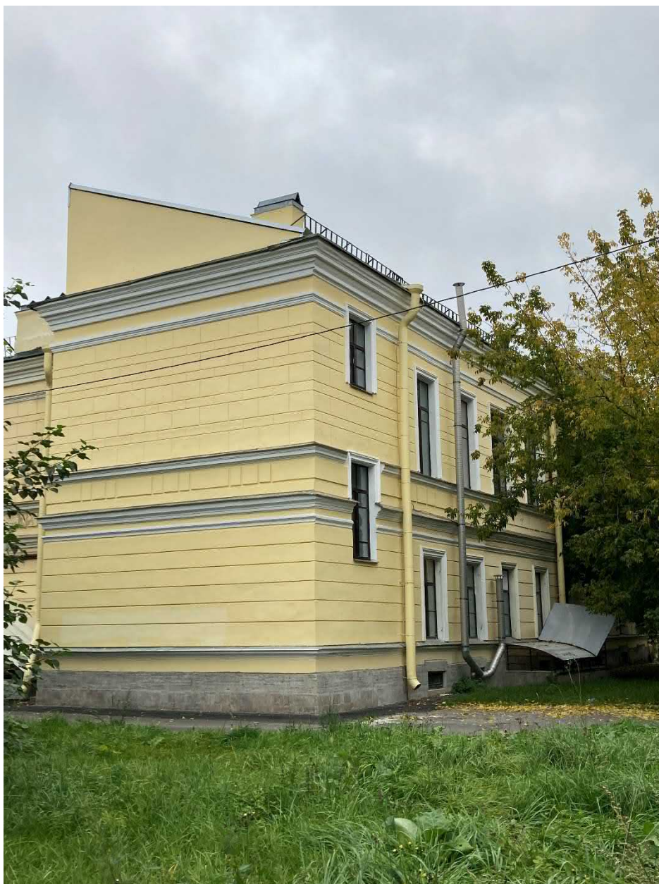
Фото 11. Фасад здания со стороны двора
