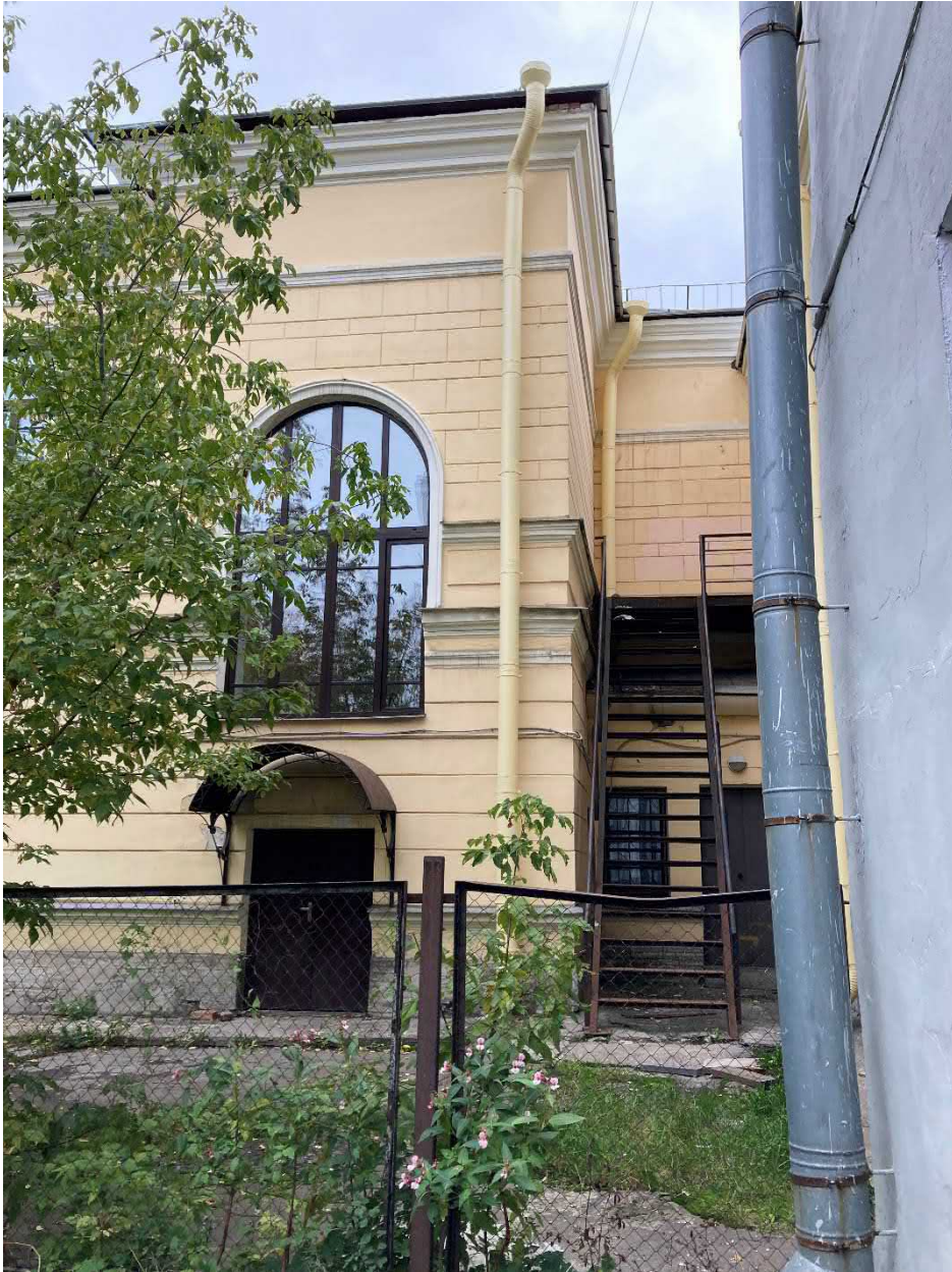
Фото 15. Фасад здания со стороны двора
