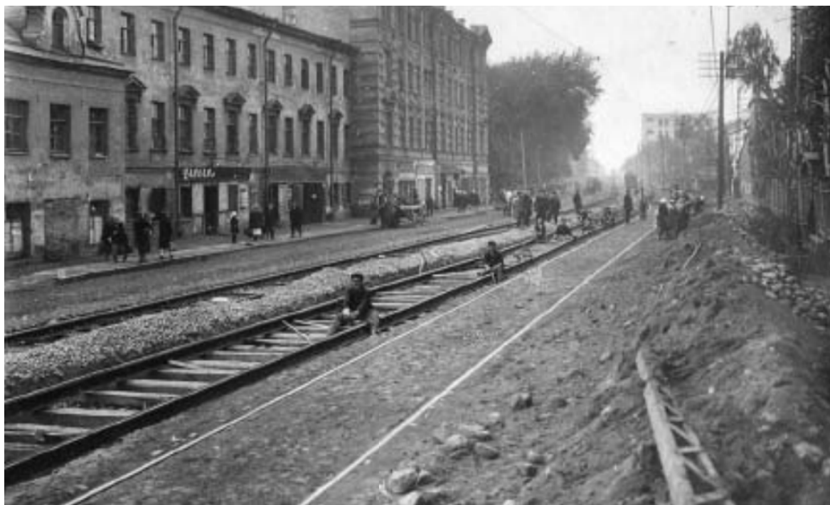
Илл.10. Проспект Села Смоленского. Прокладка трамвайной линии. Фото 1927 г. www.history.gradpetra.net
