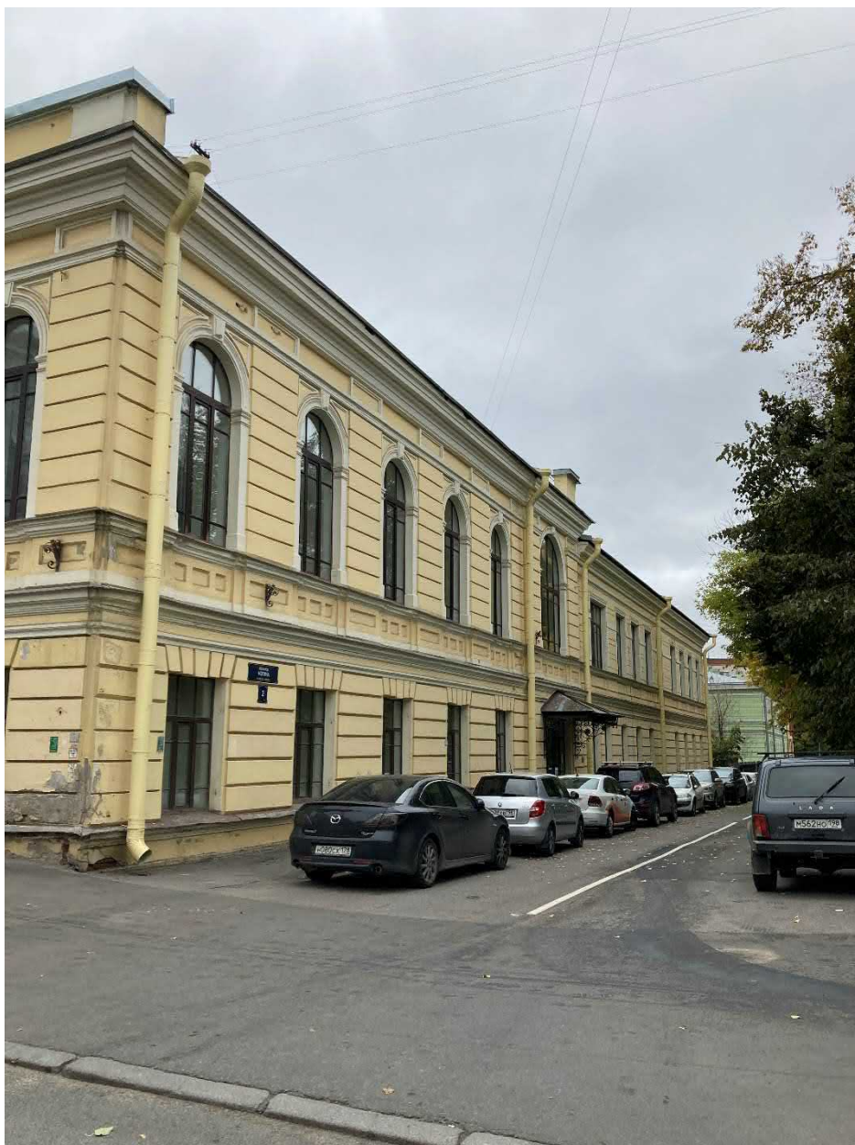
Фото 4. Фасад здания со стороны пер. Ногина, д.2
