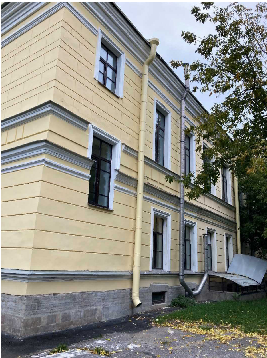
Фото 12. Фасад здания со стороны двора
