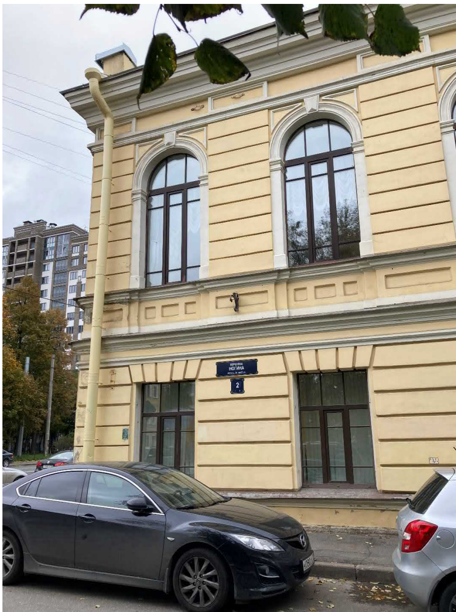
Фото 5. Фасад здания со стороны пер. Ногина, д.2
