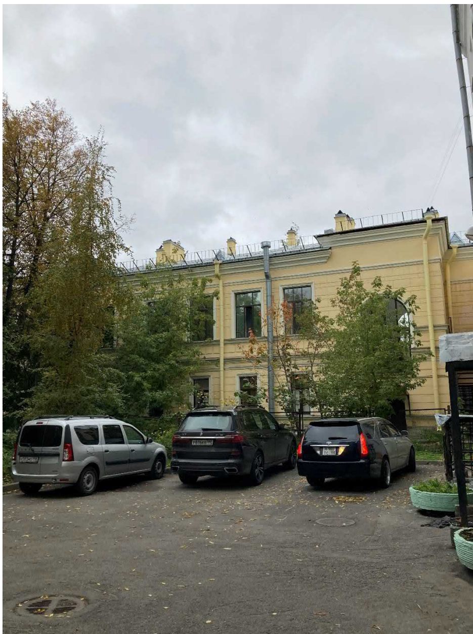
Фото 13. Фасад здания со стороны двора
