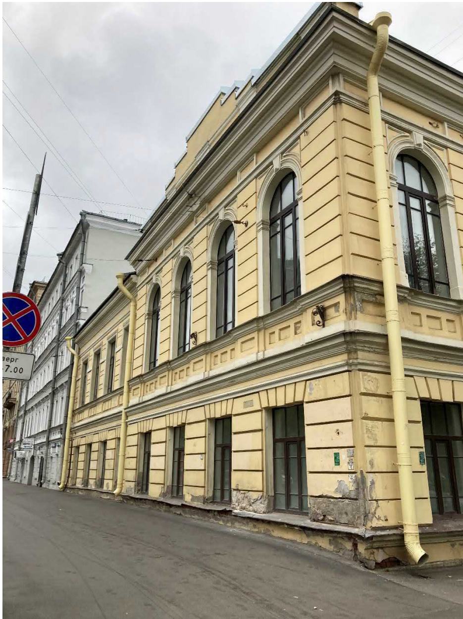
Фото 2. Фасад здания со стороны пр.Обуховской Обороны, д.85.
