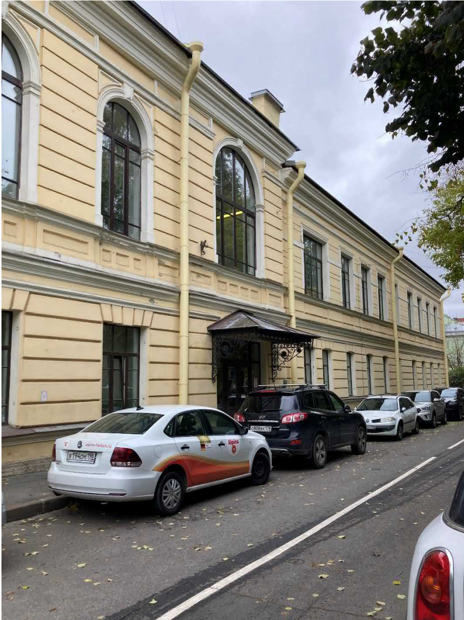
Фото 6. Фасад здания со стороны пер. Ногина, д.2
