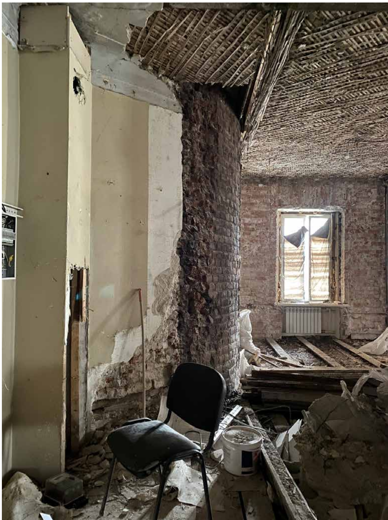
Фото 17. Вид на помещения квартиры № 2 объекта культурного наследия.
