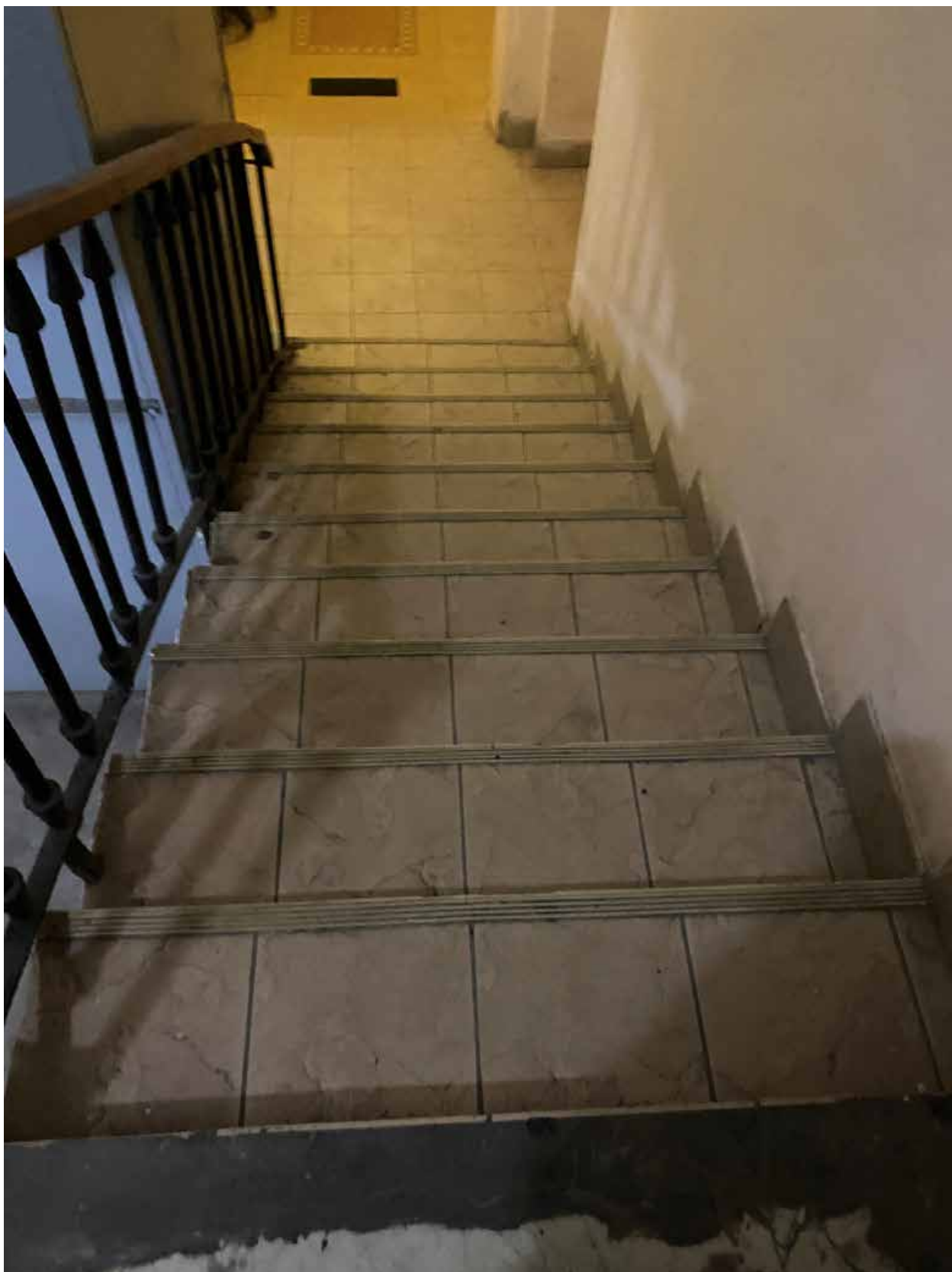
Фото 6. Фрагмент лестницы, ведущей в квартиру № 2, объекта культурного наследия.
