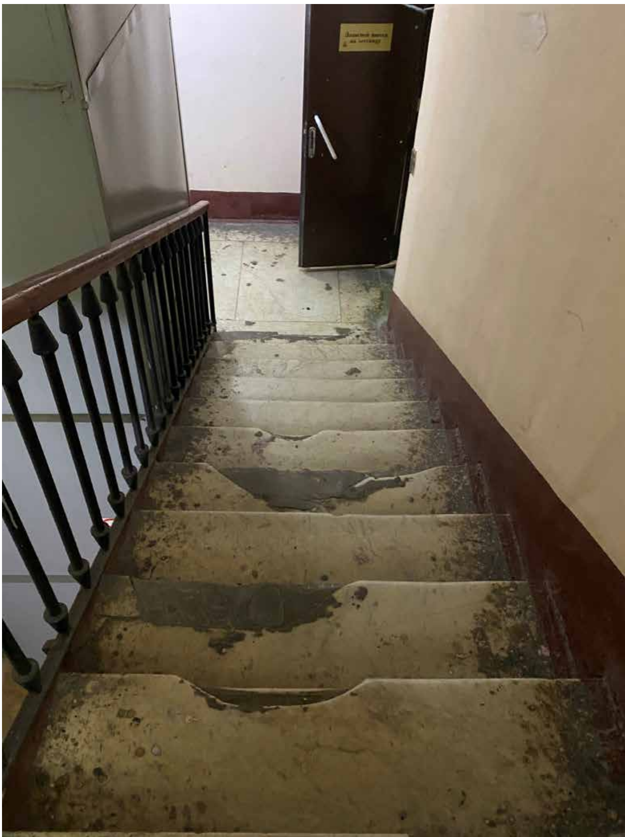
Фото 7. Фрагмент лестницы, ведущей в квартиру № 2, объекта культурного наследия.
