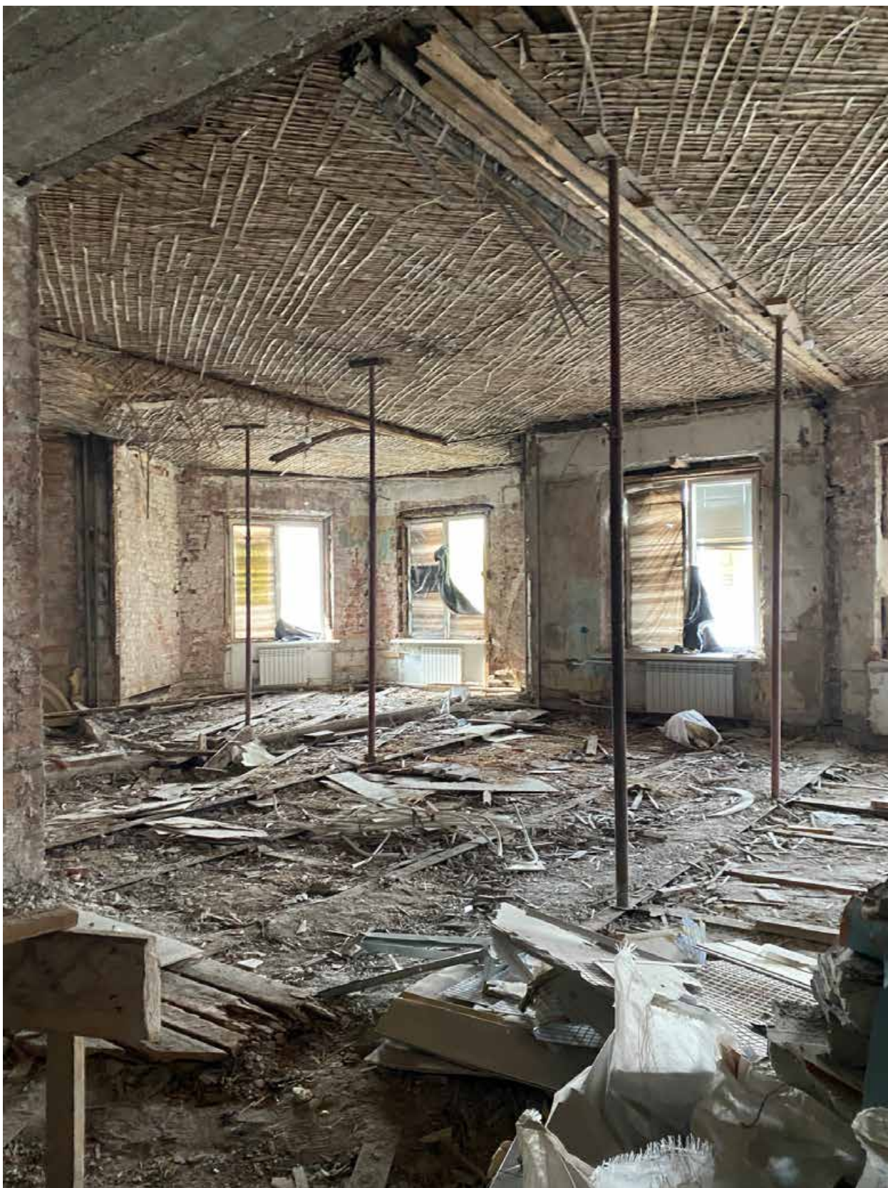
Фото 11. Вид на помещения квартиры № 2 объекта культурного наследия.
