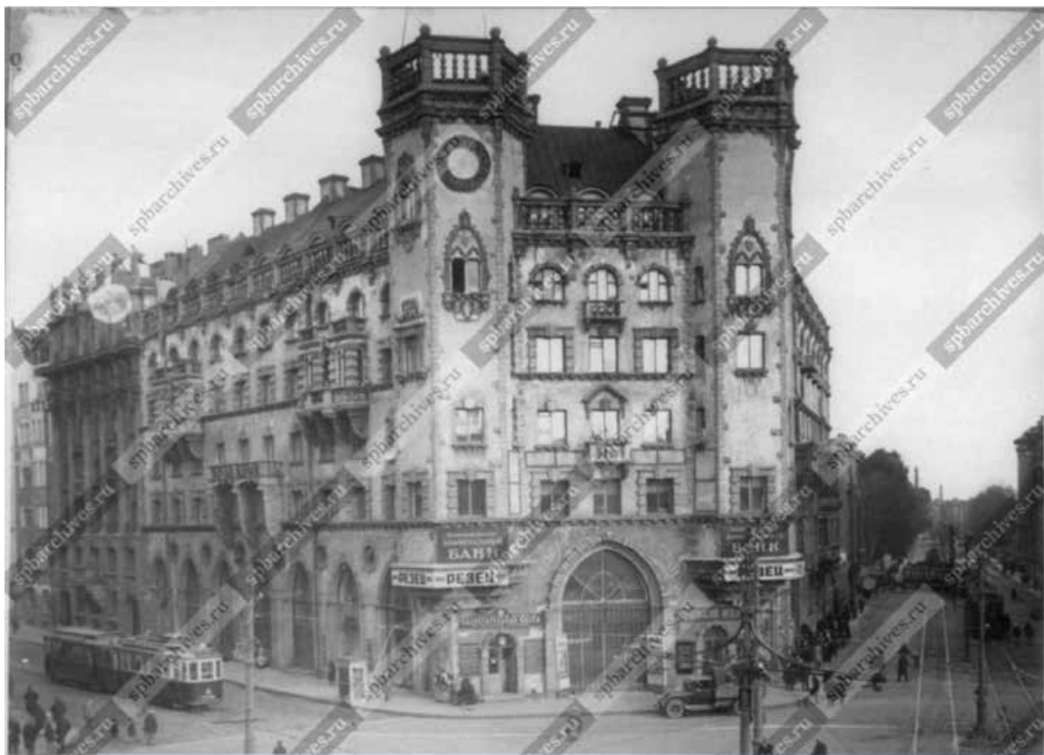
104. Общий вид здания кинотеатра "Резец", 1925 г. - ЦГАКФФД СПб – Фотодокумент Вр 67557
