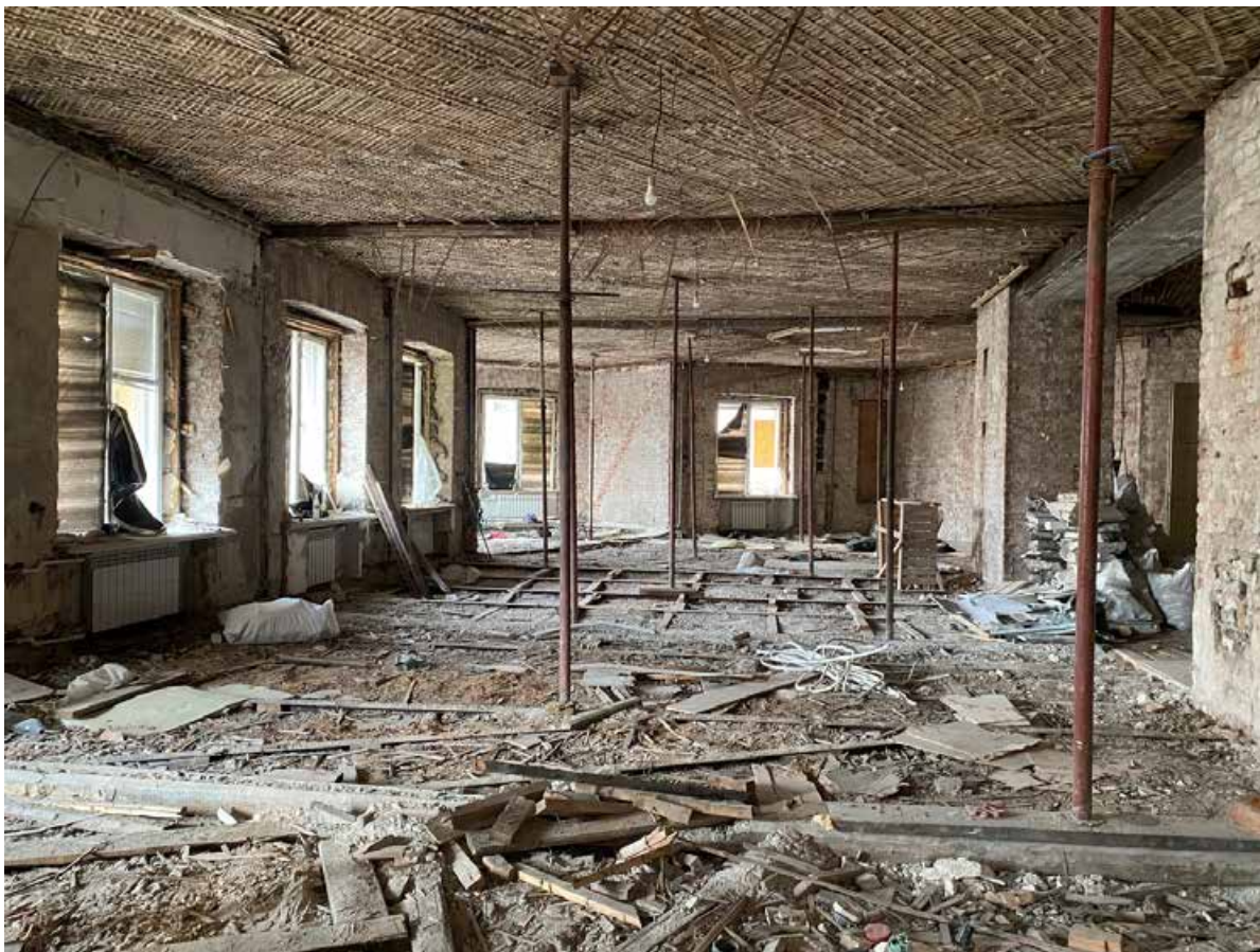
Фото 19. Вид на помещения квартиры № 2 объекта культурного наследия.
