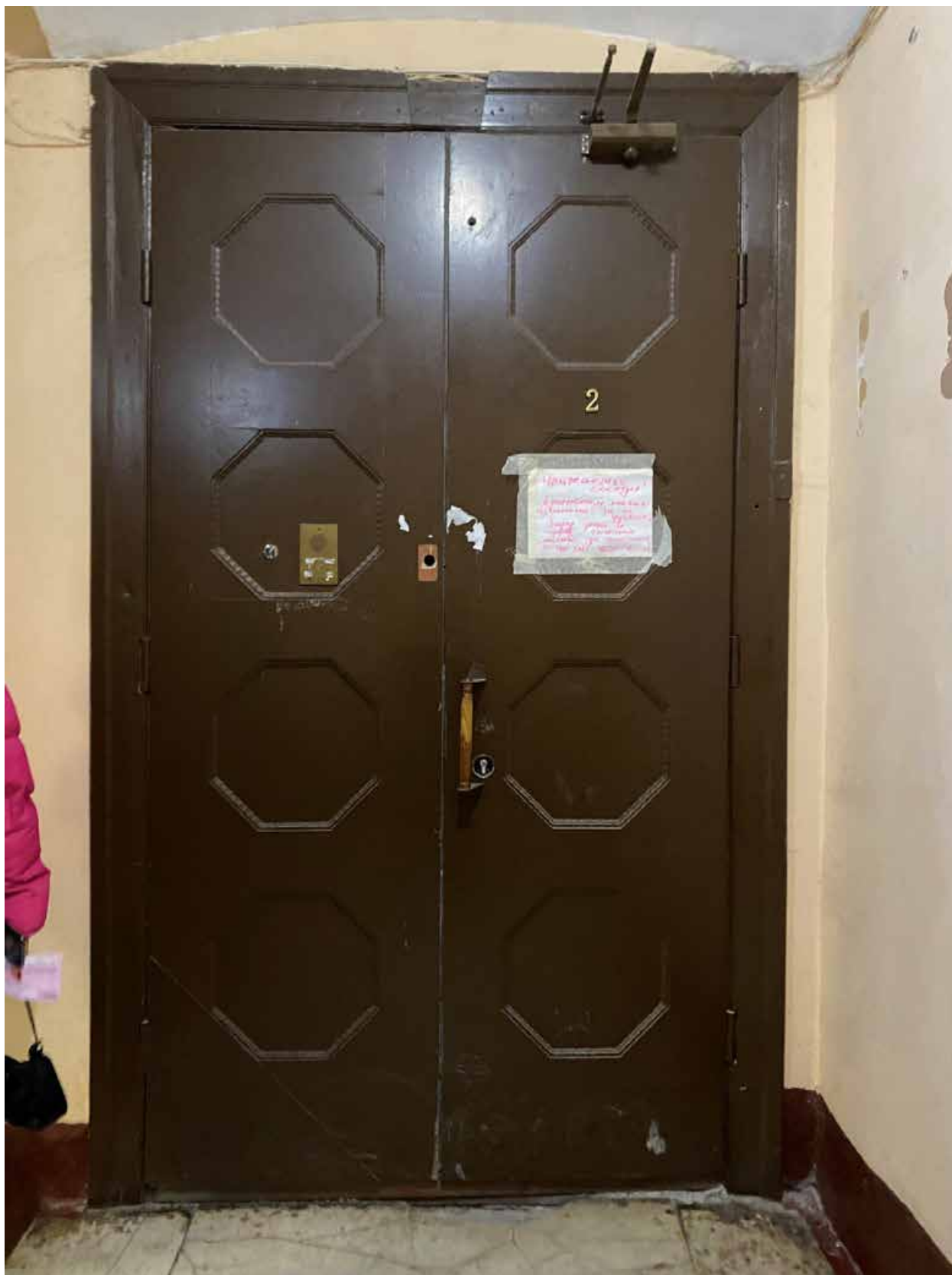
Фото 8. Вид на входную дверь в квартиру № 2 объекта культурного наследия.
