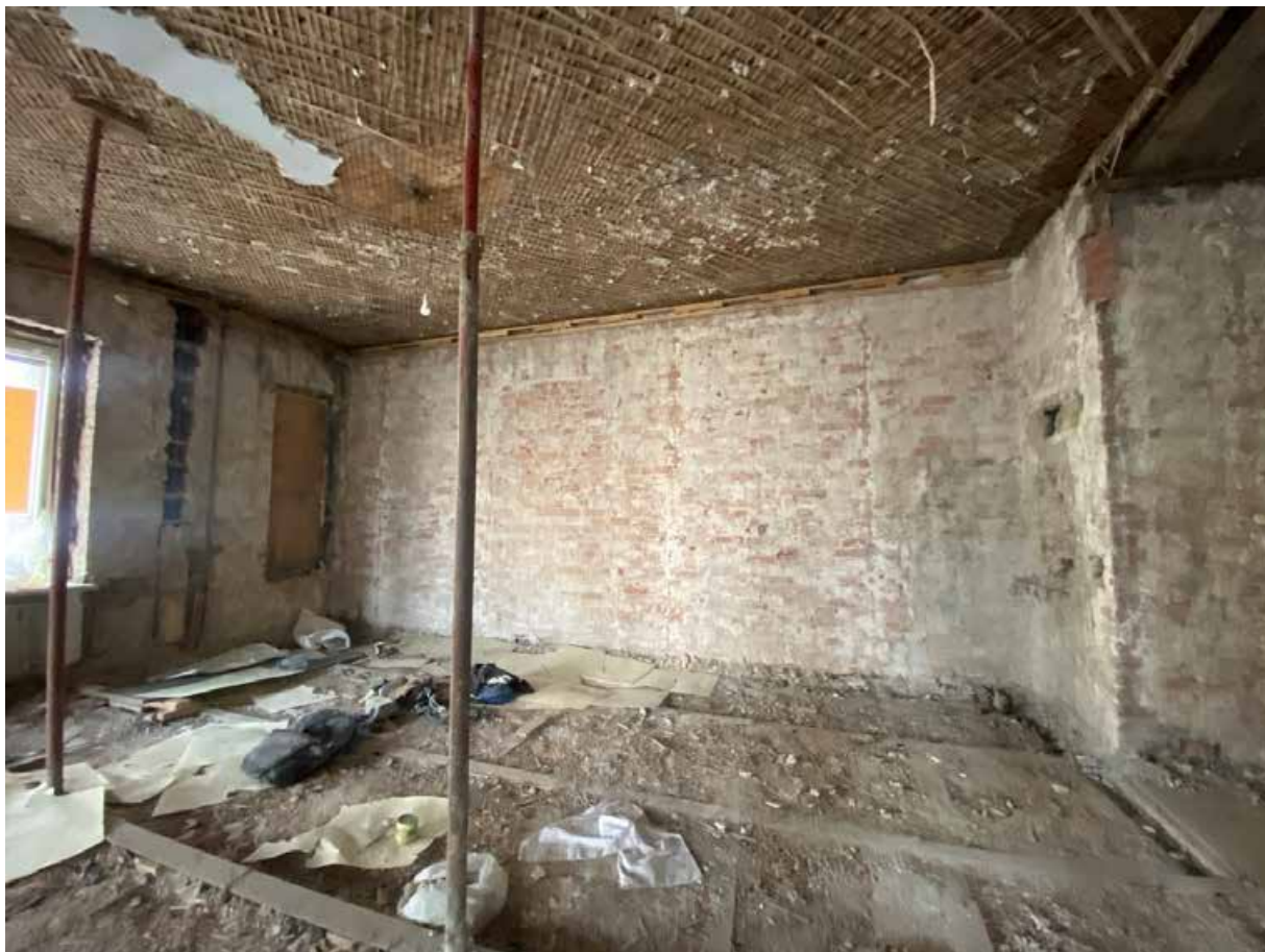
Фото 21. Вид на помещения квартиры № 2 объекта культурного наследия.
