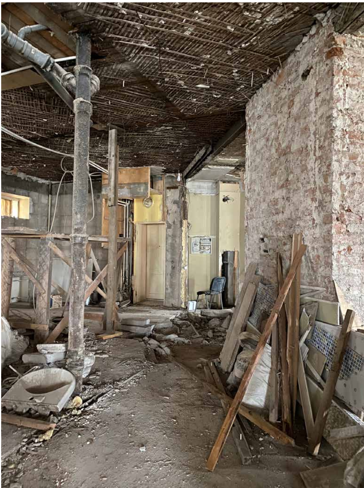
Фото 13. Вид на помещения квартиры № 2 объекта культурного наследия.
