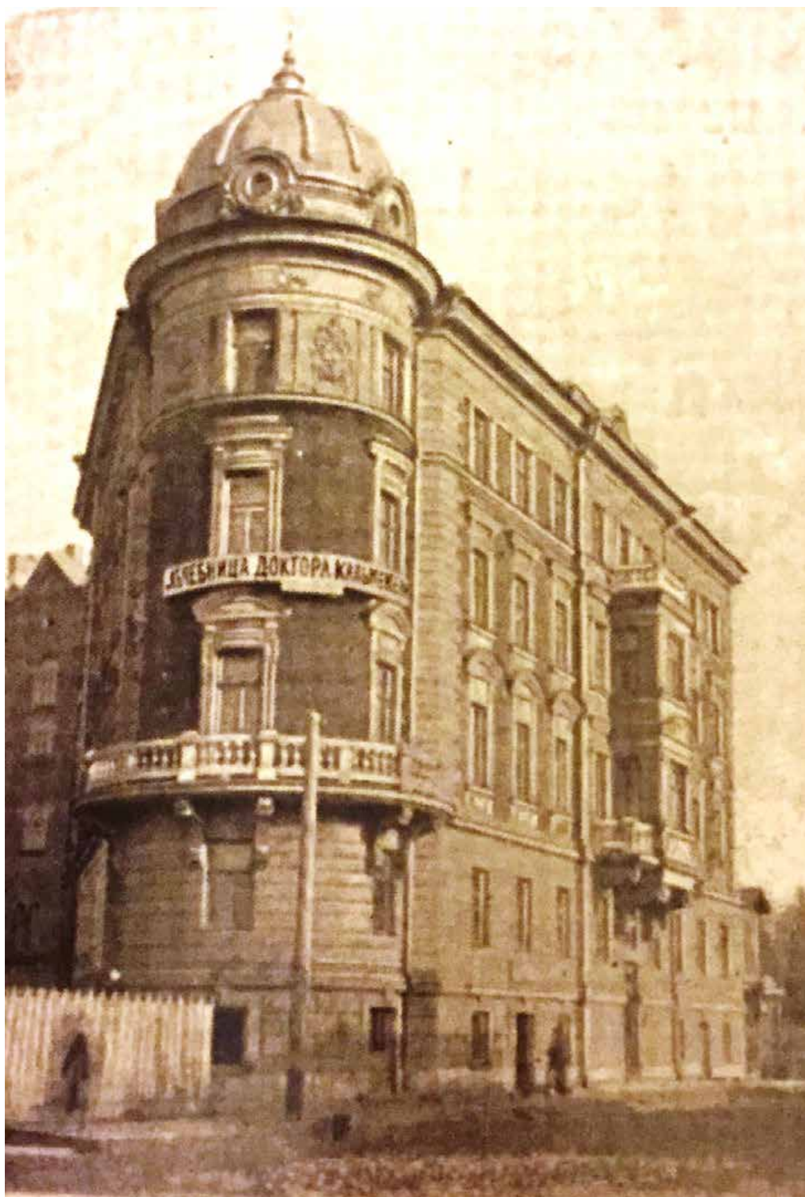
100. Дом № 35 по Каменноостровскому проспекту до перестройки, 1899-1913 гг. [Электронный ресурс] URL: https://pastvu.com/p/673728
