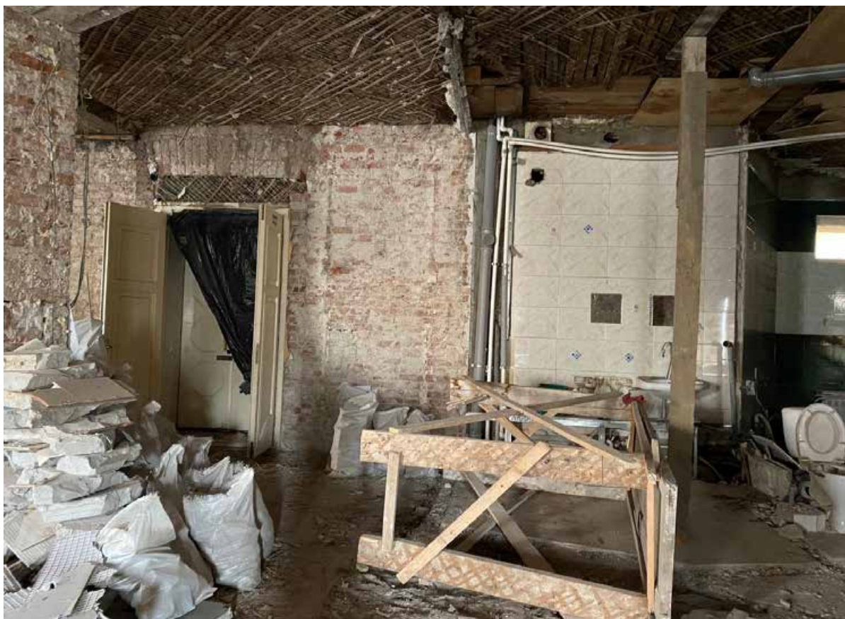
Фото 20. Вид на помещения квартиры № 2 объекта культурного наследия.
