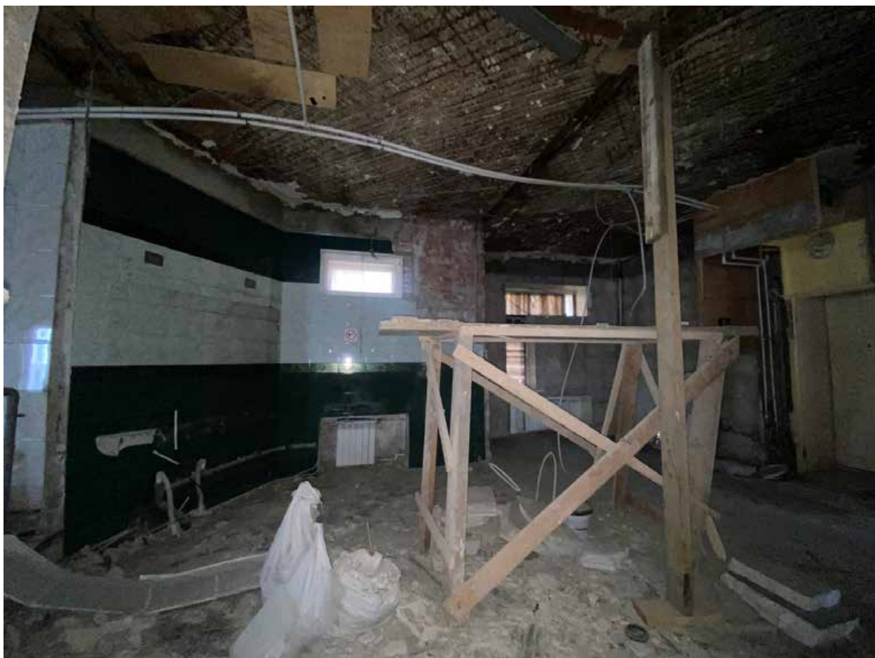
Фото 14. Вид на помещения квартиры № 2 объекта культурного наследия.
