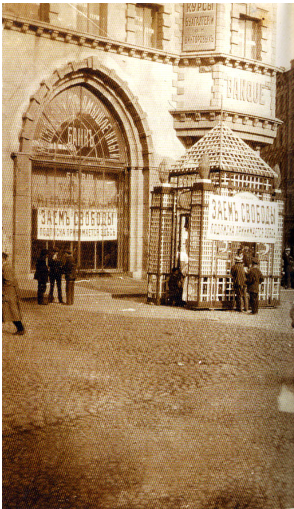
102. Угол Каменноостровского проспекта и Архьерийской улицы, 1917 г. [Электронный ресурс] URL: https://pastvu.com/p/673730
