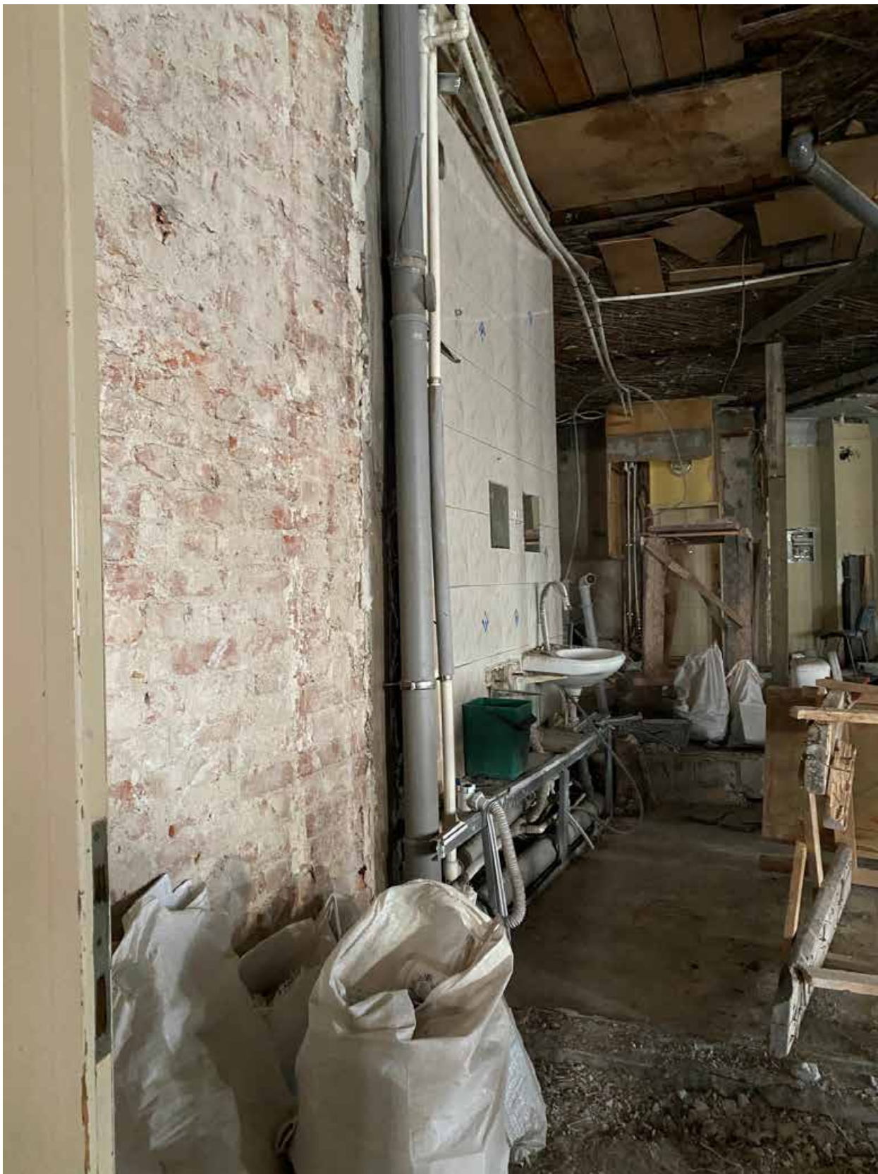
Фото 10. Вид на помещения квартиры № 2 объекта культурного наследия.
