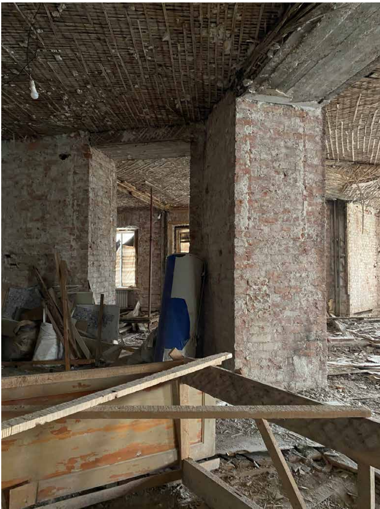
Фото 12. Вид на помещения квартиры № 2 объекта культурного наследия 7.
