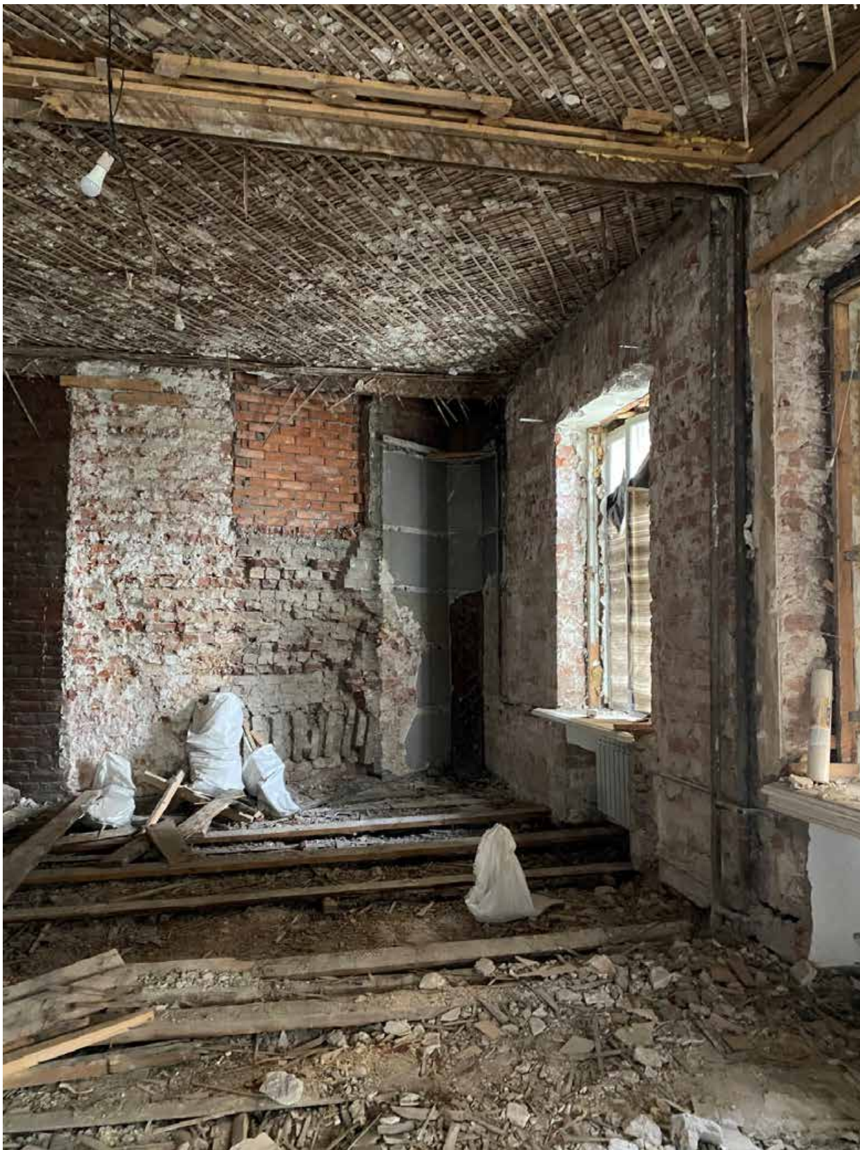
Фото 18. Вид на помещения квартиры № 2 объекта культурного наследия.
