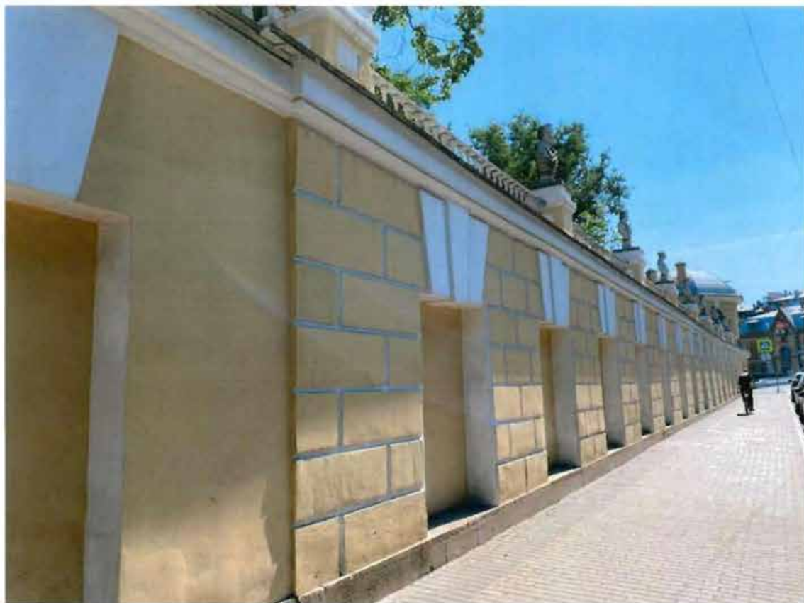
3. Фрагмент западного фасада объекта культурного наследия.
