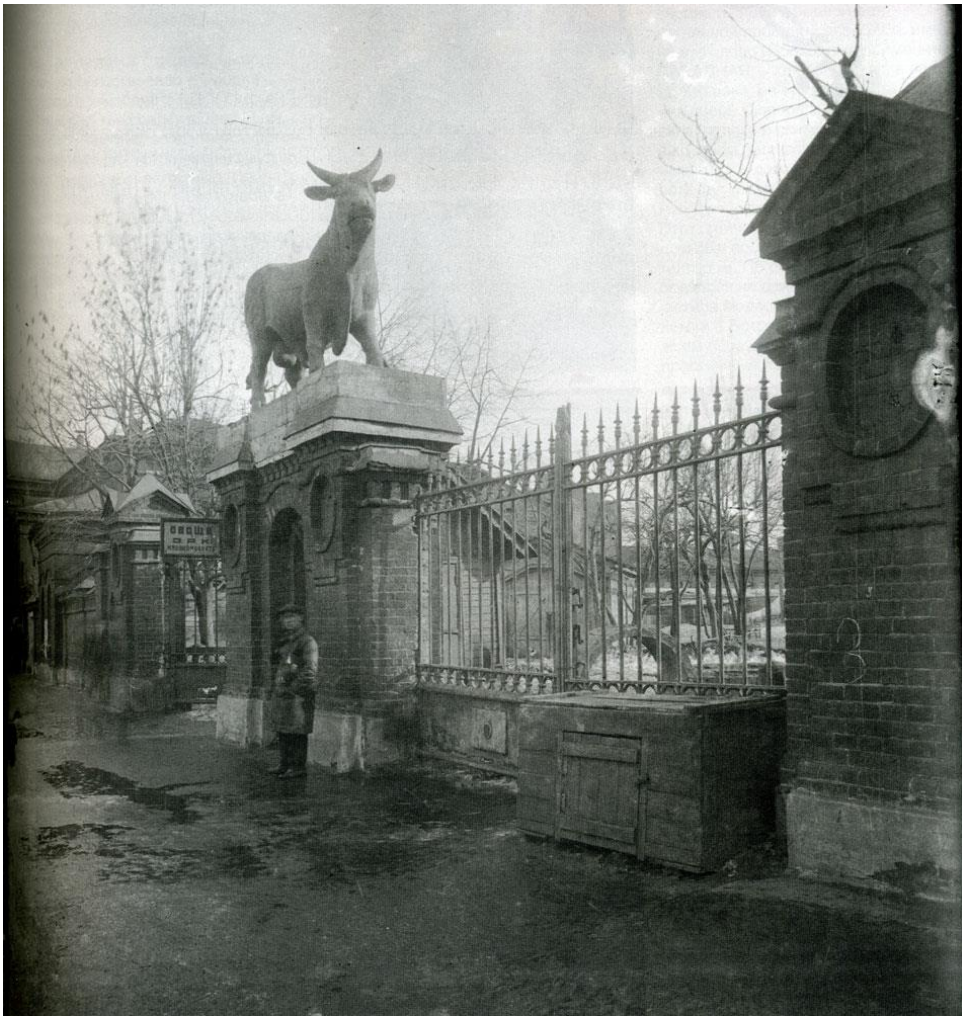
Илл. 32. Пилон ворот и вид на бывшее здание Мясной биржи. 1932 // Москомнаследие
