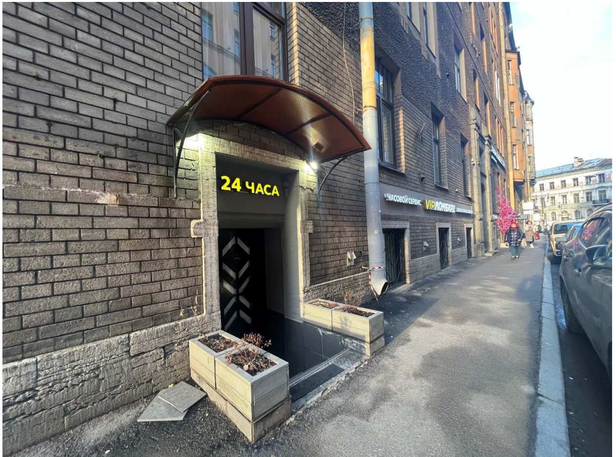
Фото №4. Дворовый фасад (северный) по Волынскому переулку, фрагмент, вход в помещение 8-Н.
