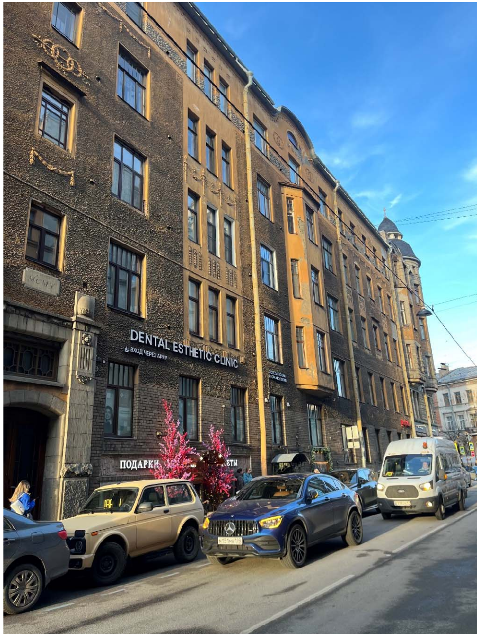
Фото №1. Лицевой фасад (южный) по Волынскому переулку.
