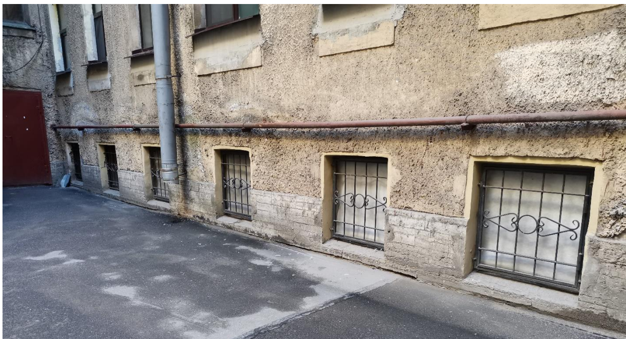
Фото 3, 4 Оконные заполнения помещения 4-Н.
