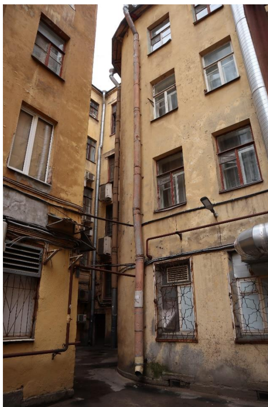
Фото 10. Северный (дворовый) фасад здания, фрагмент
