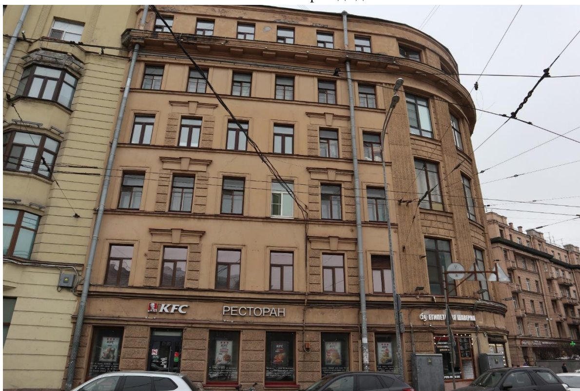
Фото 2. Юго-западный фасад здания
