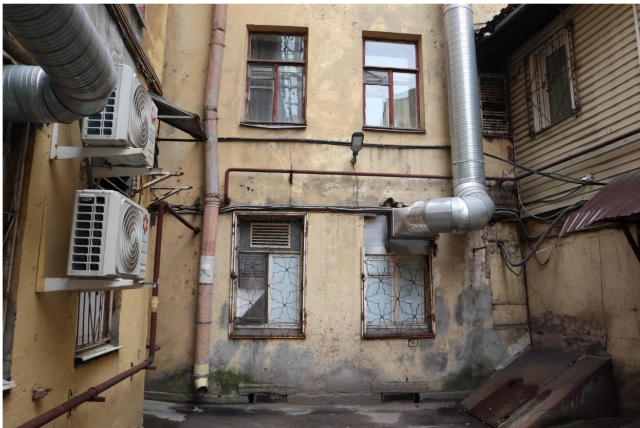
Фото 9. Северный (дворовый) фасад здания, фрагмент
