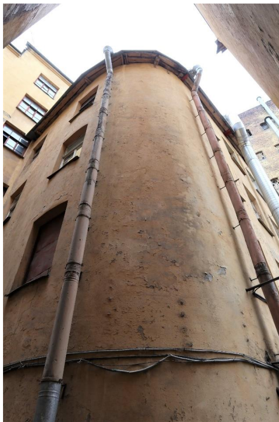
Фото 13. Северный (дворовый) фасад здания, фрагмент
