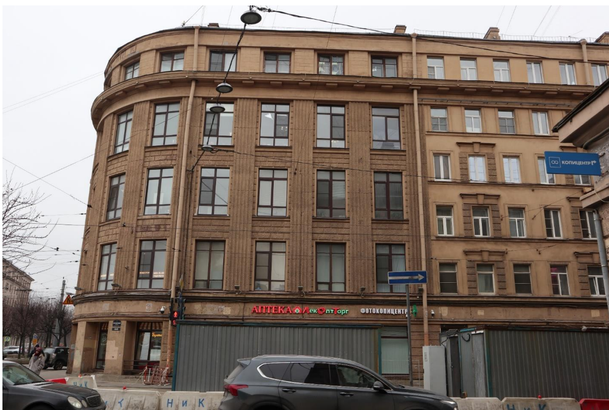
Фото 6. Юго-восточный фасад здания
