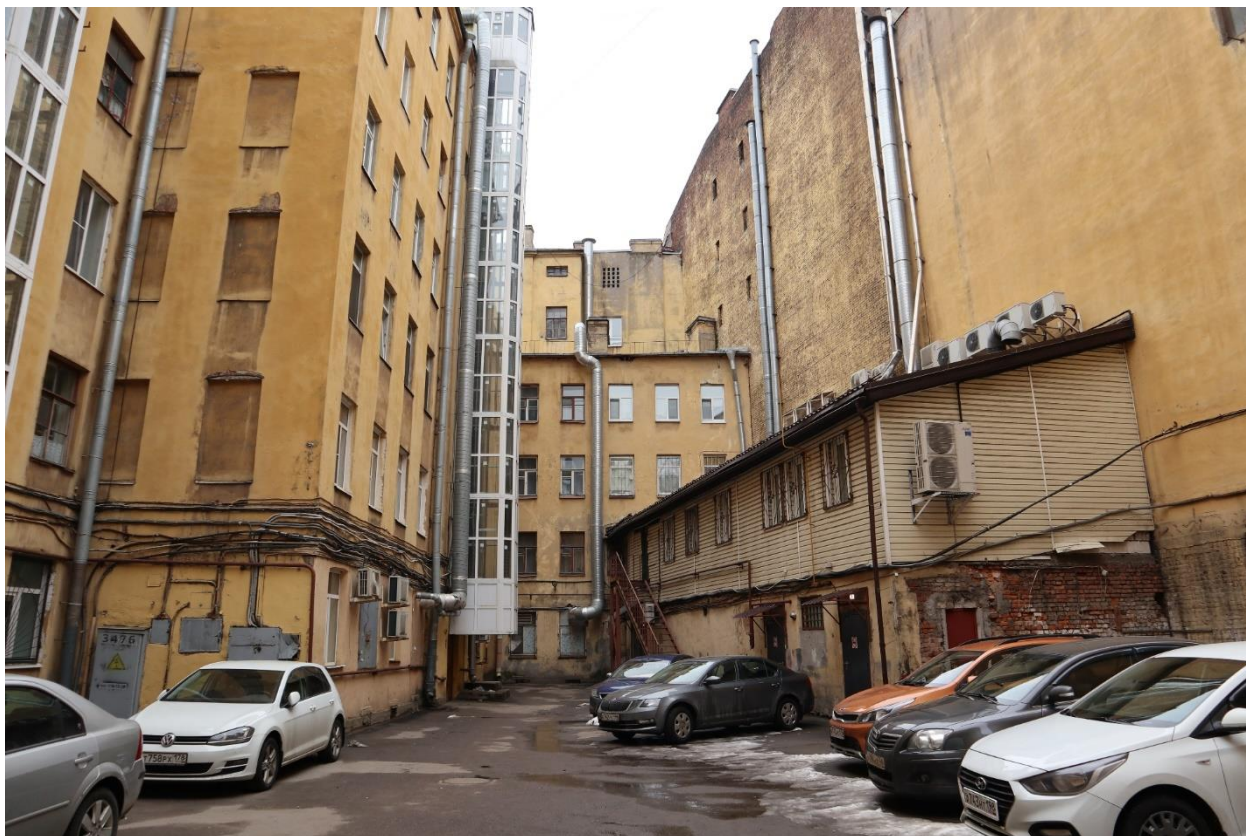
Фото 7. Северный (дворовый) фасад здания, фрагмент
