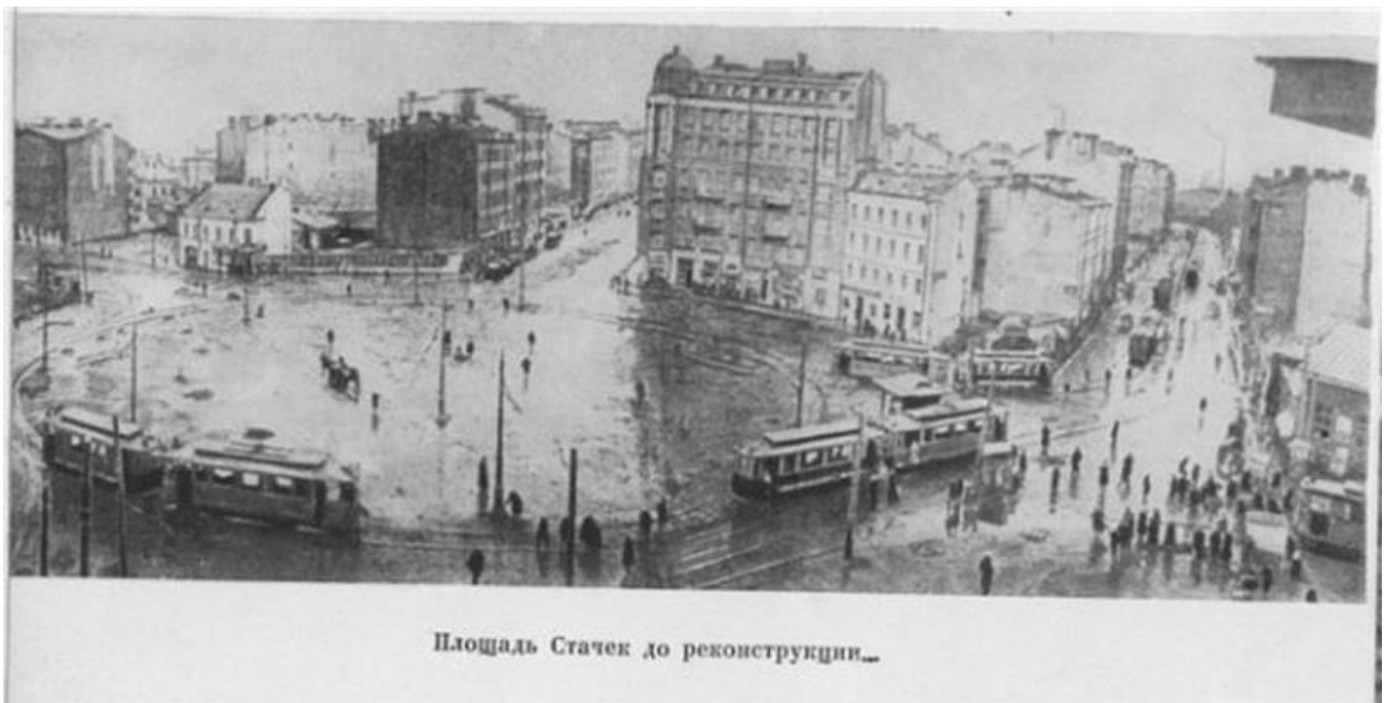
Илл. 16. Площадь Стачек до реконструкции. 1928 г.// https://pastvu.com/p/113299
