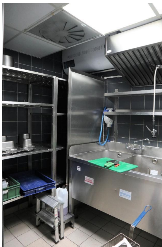
Фото 1.9. 1 этаж, помещение 5Н (4)
