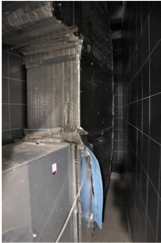
Фото 2.8. 2 этаж, помещение 5Н (8)
