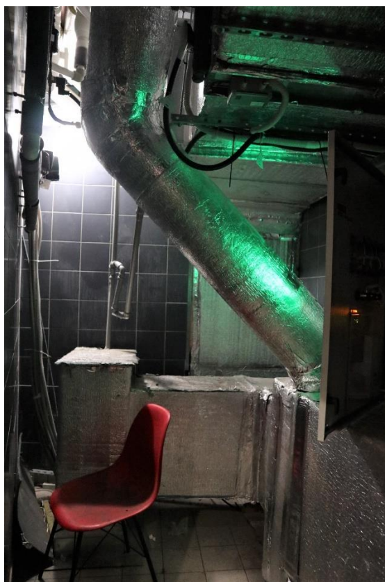
Фото 2.7. 2 этаж, помещение 5Н (8)
