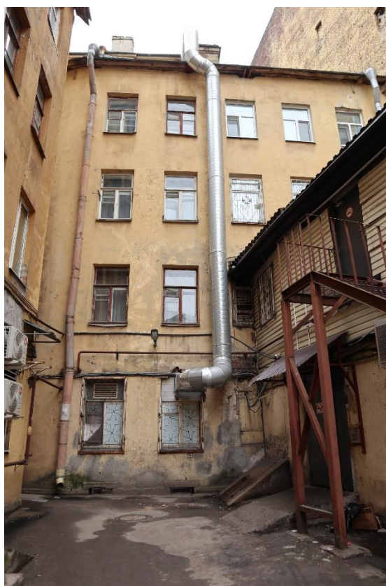
Фото 8. Северный (дворовый) фасад здания, фрагмент
