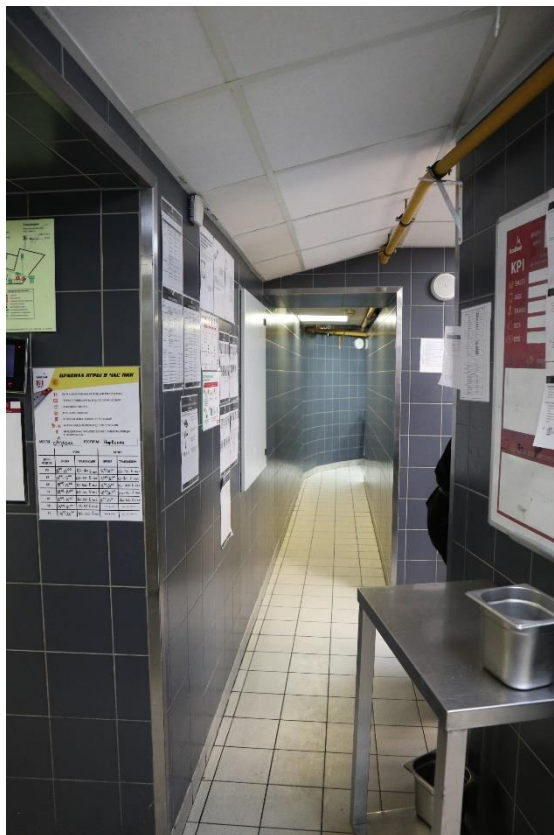
Фото 1.5. 1 этаж, помещение 5Н (3,4)
