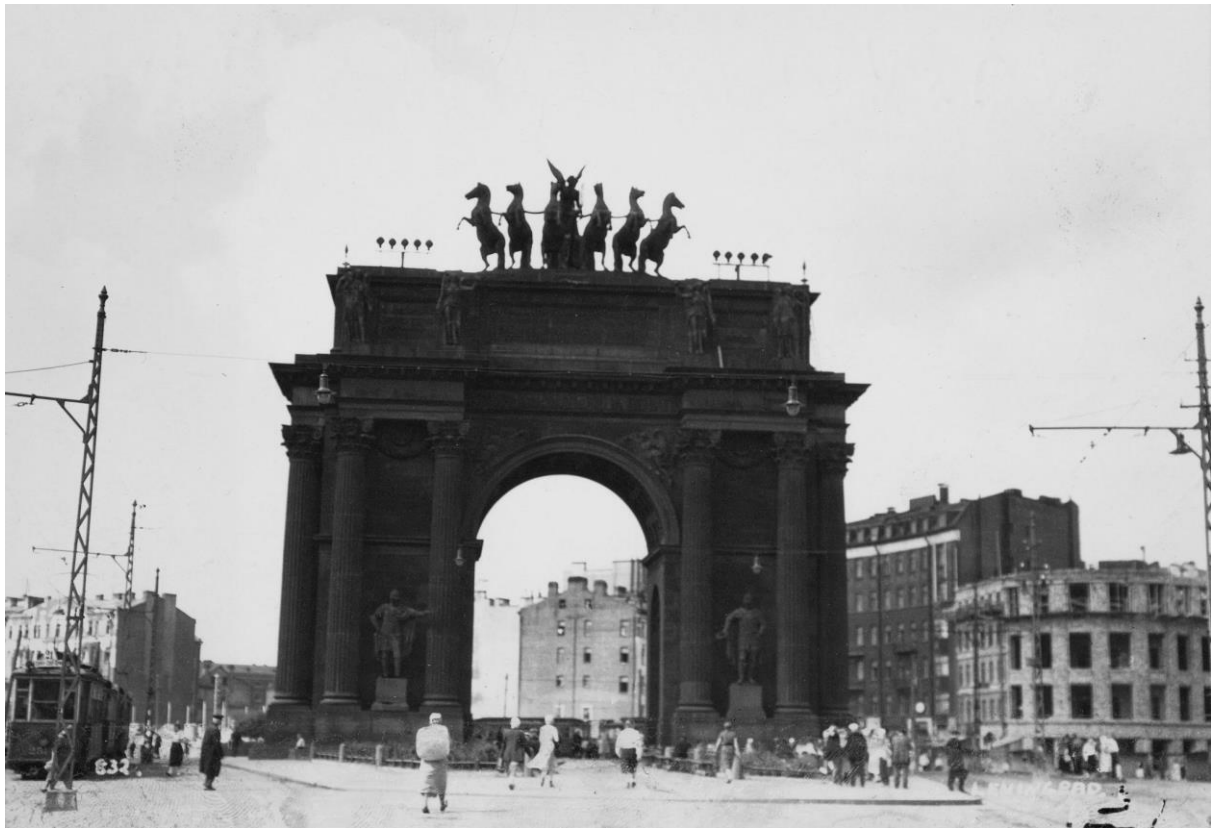
Илл. 21. Триумфальная арка на Площади Стачек. 1934 г. https://pastvu.com/p/841279
