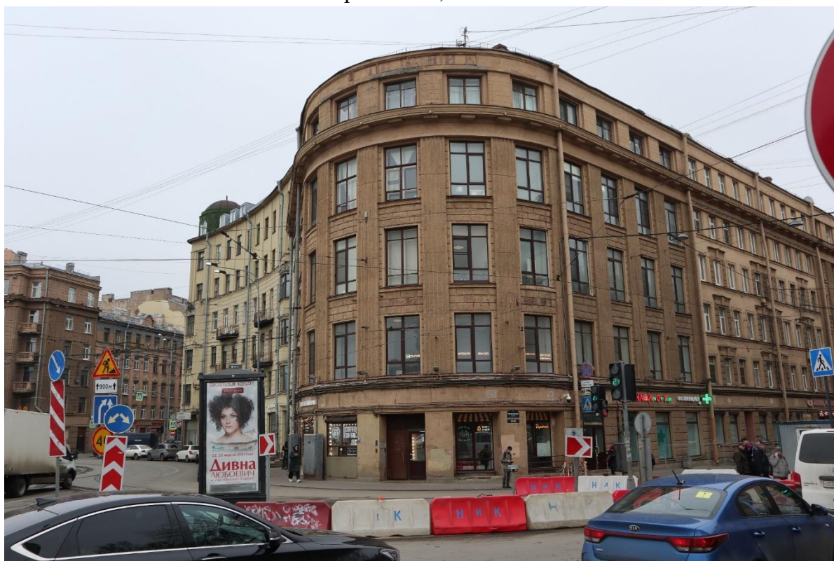
Фото 1. Южный фасад здания
