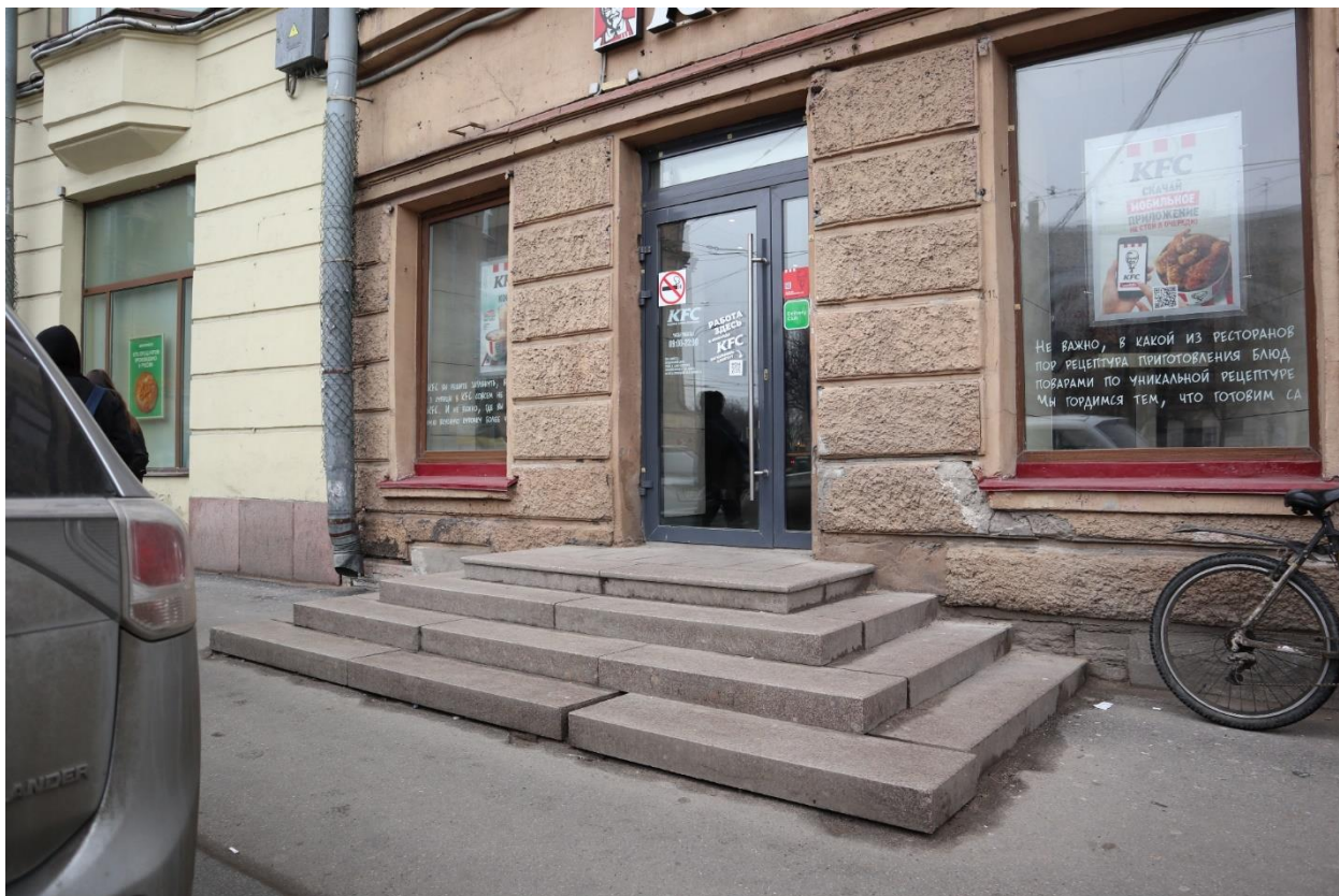
Фото 3. Юго-западный фасад здания, фрагмент
