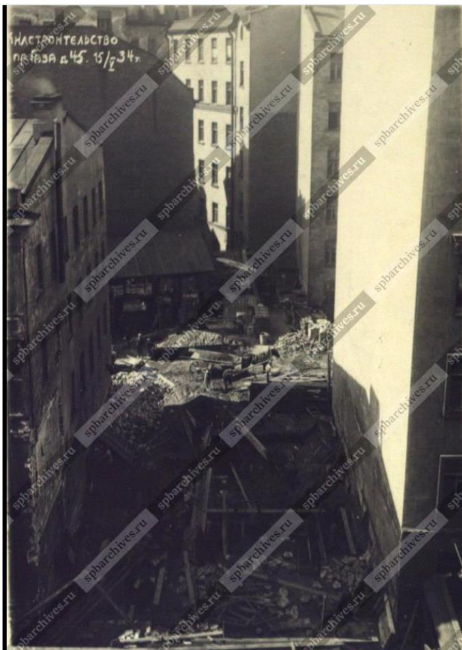
Илл. 22. Строительство дома №45 по проспекту Газа. Дата съемки 1934 г. Автор съемки не установлен. // ЦГАКФФД СПб. Фотодокумент Гр 56391
