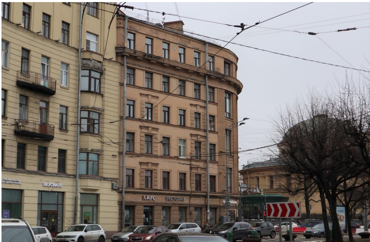
Фото 5. Юго-западный фасад здания
