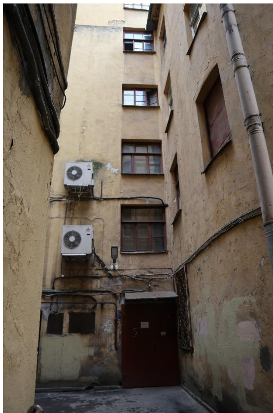
Фото 11. Северный (дворовый) фасад здания, фрагмент
