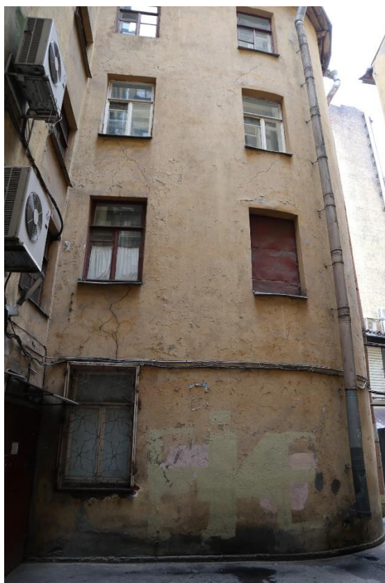
Фото 12. Северный (дворовый) фасад здания, фрагмент
