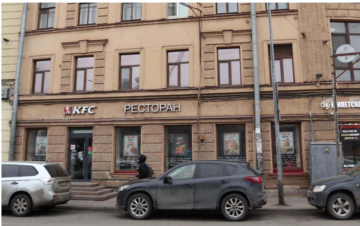
Фото 4. Юго-западный фасад здания, фрагмент
