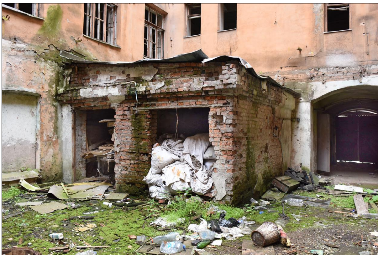
7. Выявленный объект культурного наследия «Здание, в котором размещались издательство и типография Ф.А. Брокгауза и И.А. Ефрон». Одноэтажная надворная пристройка в юго-западном углу двора.
