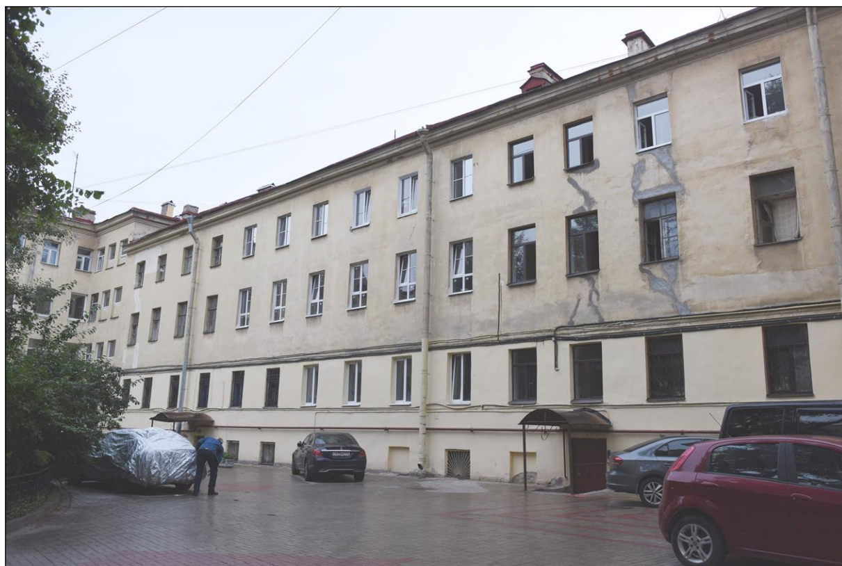
28. Выявленный объект культурного наследия «Дом Касаткина-Ростовского». Первый (от наб. р. Мойки) двор. Западный дворовый флигель, примыкающий к участку дома № 86-88 по наб. р. Мойки (ОКН федерального значения «Дом Монферрана О. (Ратькова-Рожнова Я.В.).
