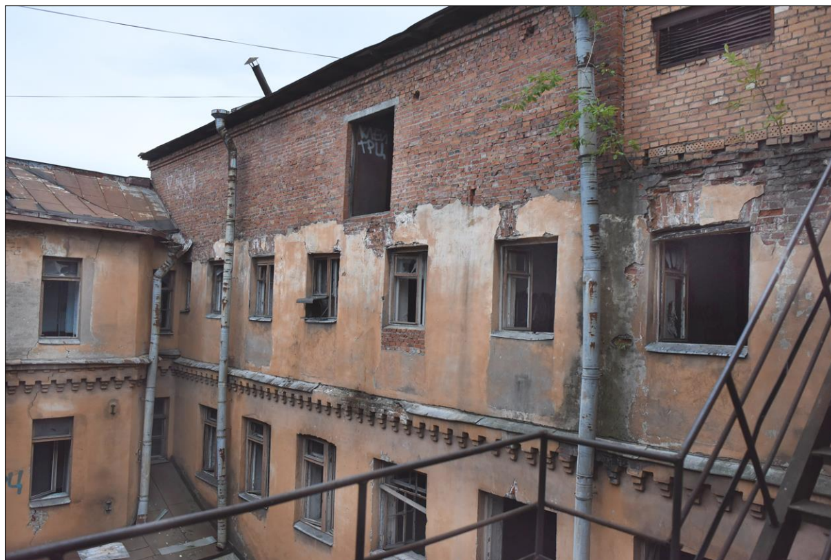
18. Выявленный объект культурного наследия «Здание, в котором размещались издательство и типография Ф.А. Брокгауза и И.А. Ефрон». Фрагмент северного фасада южного дворового флигеля. Вид с металлической наружной лестницы в северо-западном углу двора.
