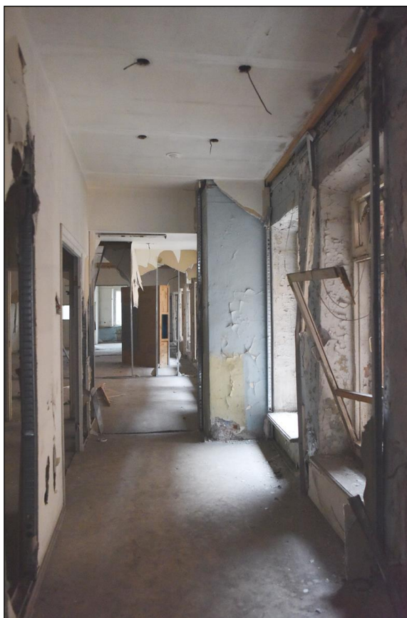
13. Выявленный объект культурного наследия «Здание, в котором размещались издательство и типография Ф.А. Брокгауза и И.А. Ефрон». Помещения 3, 6, 7 3-го этажа. Часть перегородок демонтирована.
