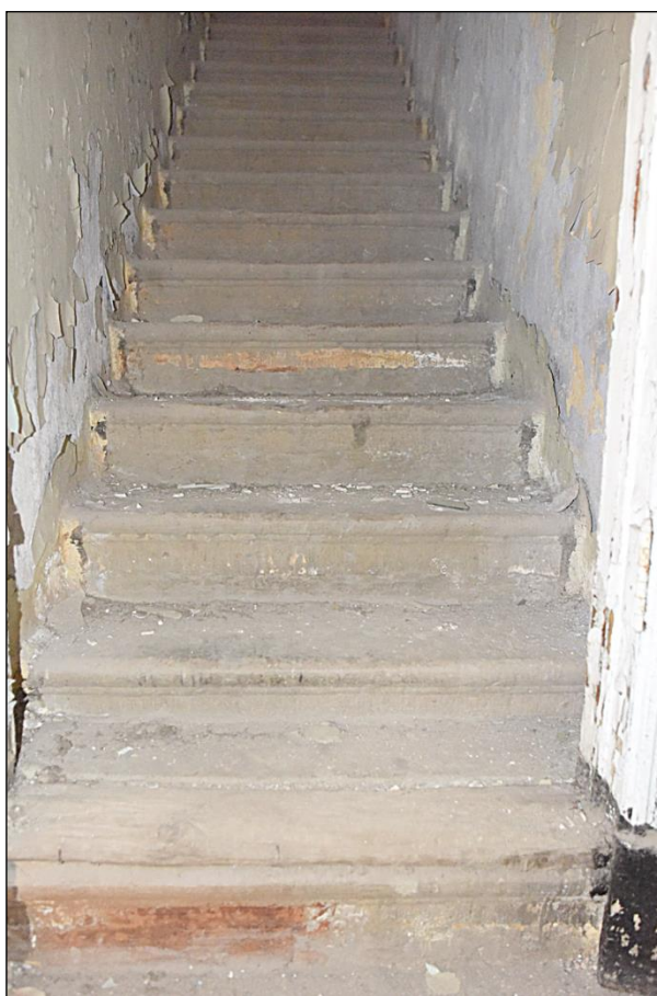
15. Выявленный объект культурного наследия «Здание, в котором размещались издательство и типография Ф.А. Брокгауза и И.А. Ефрон». Лестница дворового флигеля. Площадка 3-го этажа.
