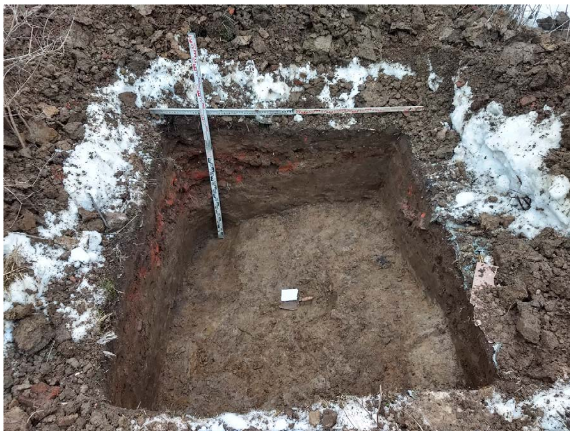
Рис. 53. Усть-Славянка-2023. КН_78:12:0721302:7169. Шурф 2, фиксация по уровню окончания работ, вид на восток.
