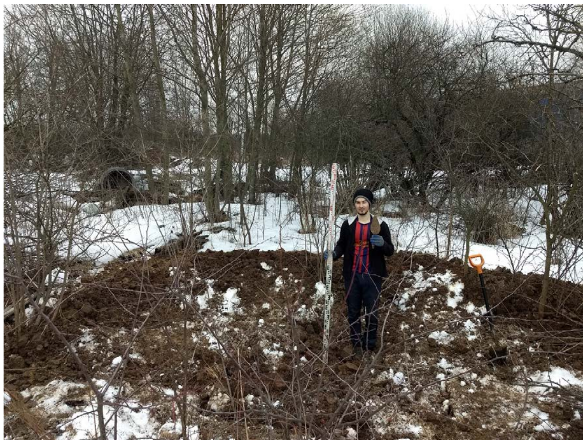
Рис. 55. Усть-Славянка-2023. КН_78:12:0721302:7169. Шурф 2 после рекультивации, вид на север.
