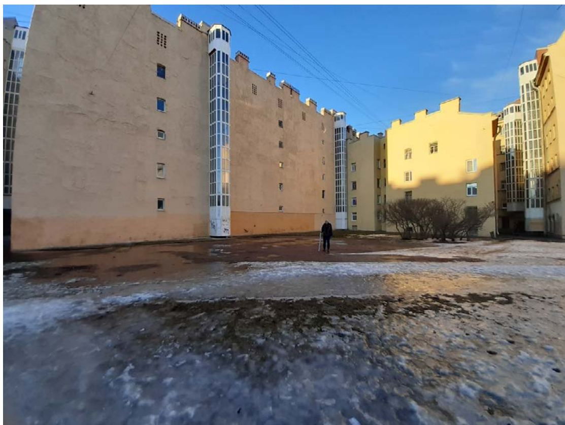
Рис. 24. СПб-2023. Василеостровский район, Гавань. Общий вид участка обследования. Точка фотофиксации 2. Вид с ЮВ.
