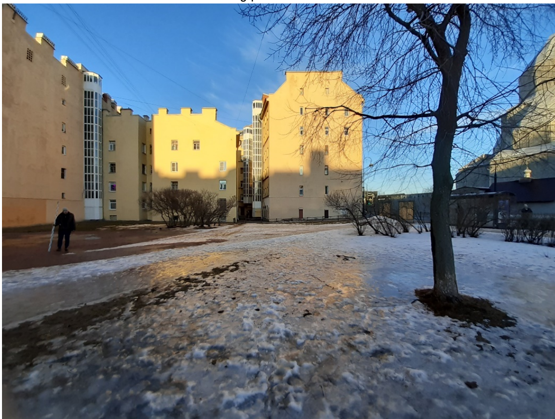
Рис. 23. СПб-2023. Василеостровский район, Гавань. Общий вид участка обследования. Точка фотофиксации 1. Вид с В.
