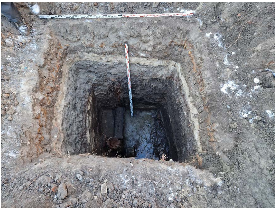
Рис. 54. СПб-2023. Василеостровский район, Гавань. Шурф 1. Фиксация по материковой поверхности и остаткам деревянной конструкции. Вид с Ю.
