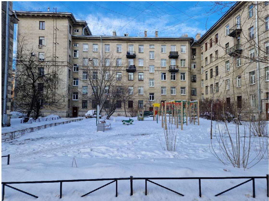
Рис. 48. СПб-2023. Василеостровский район, Гавань. Общий вид участка обследования. Точка фотофиксации 20. Вид с В.
