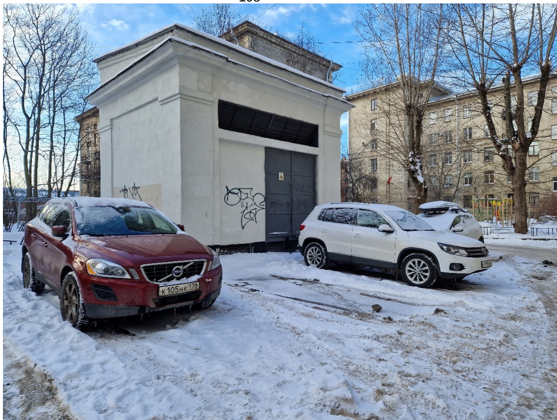
Рис. 51. СПб-2023. Василеостровский район, Гавань. Общий вид участка обследования. Точка фотофиксации 23. Вид с С.
