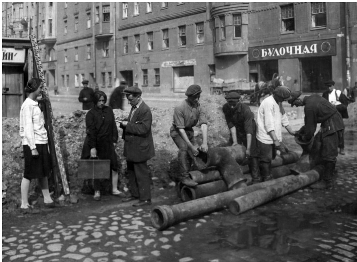
33. Ремонтные работы на Измайловском проспекте. https://pastvu.com/p/1003956
