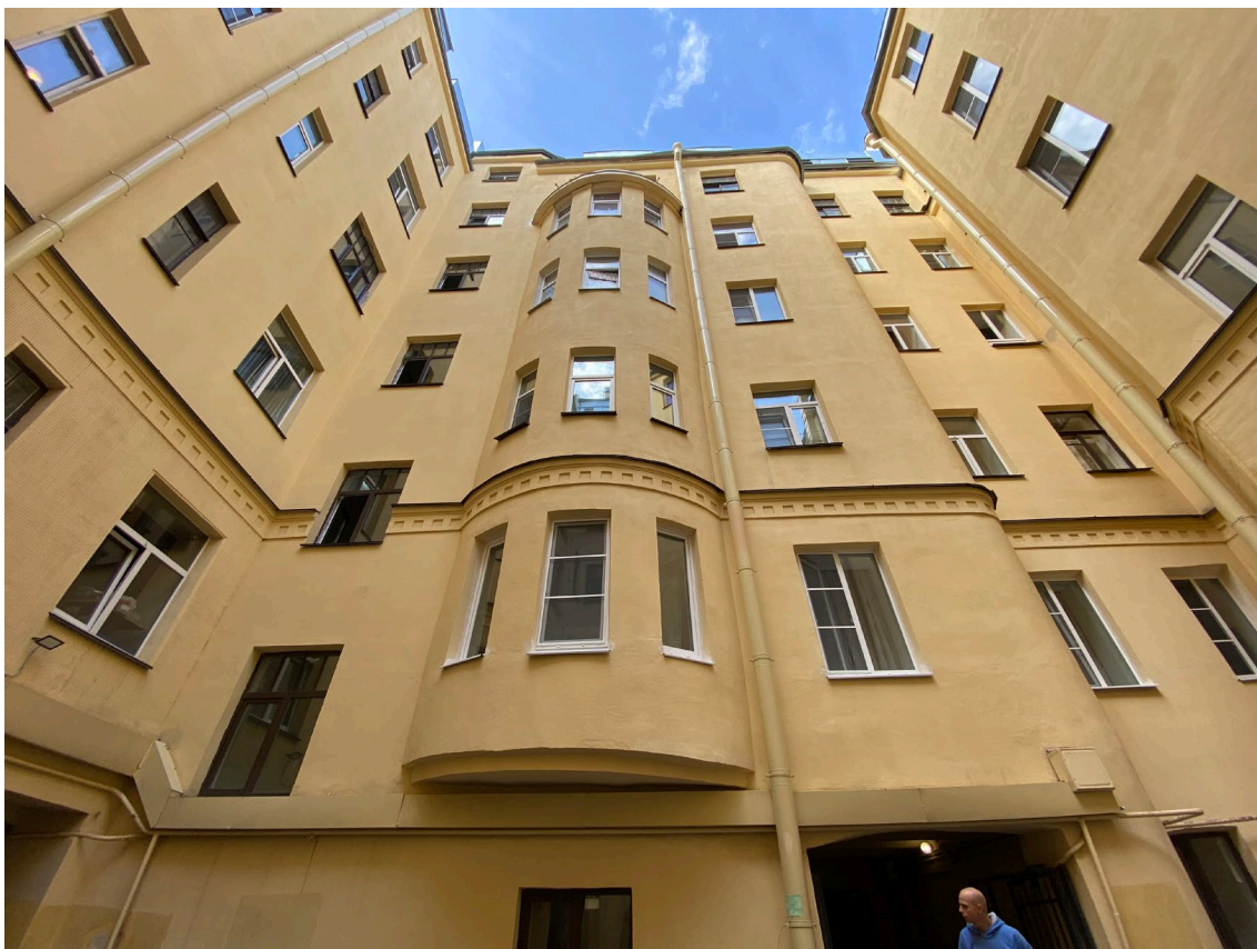
3. Вид на дворовые фасады.
