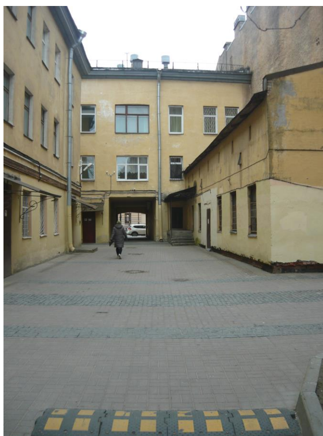
Фото 5. Внутренний двор со стороны ул. Большая Конюшенная.
