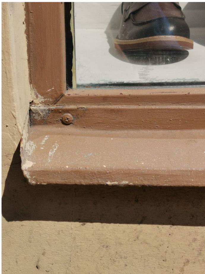
*Фото№5: Фрагмент существующего оконного заполнения в неудовлетворительном состоянии. Многочисленные слои красочного состава. Неправильная установка отлива*
