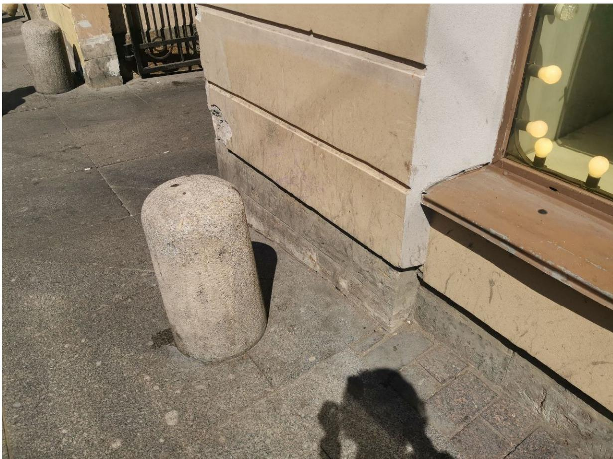
*Фото№11: Фрагмент фасада у оконного заполнения. Общее загрязнение фасада, механические повреждения штукатурного слоя*
