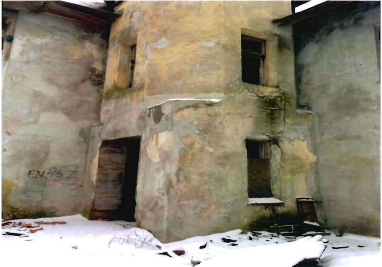
4. Вход со стороны северо-западного фасада.
