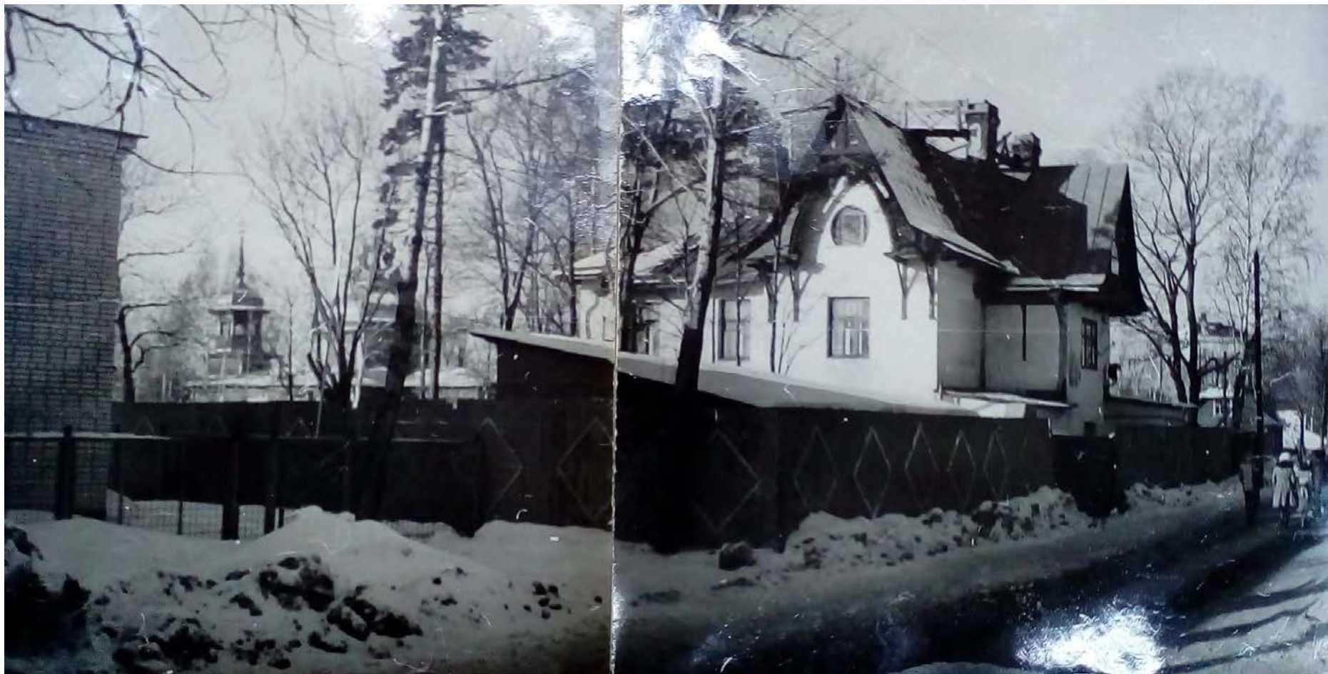
13. Вид на северо-восточный и юго-восточный фасады рассматриваемого здания. 1981. Архив КГИОП.
