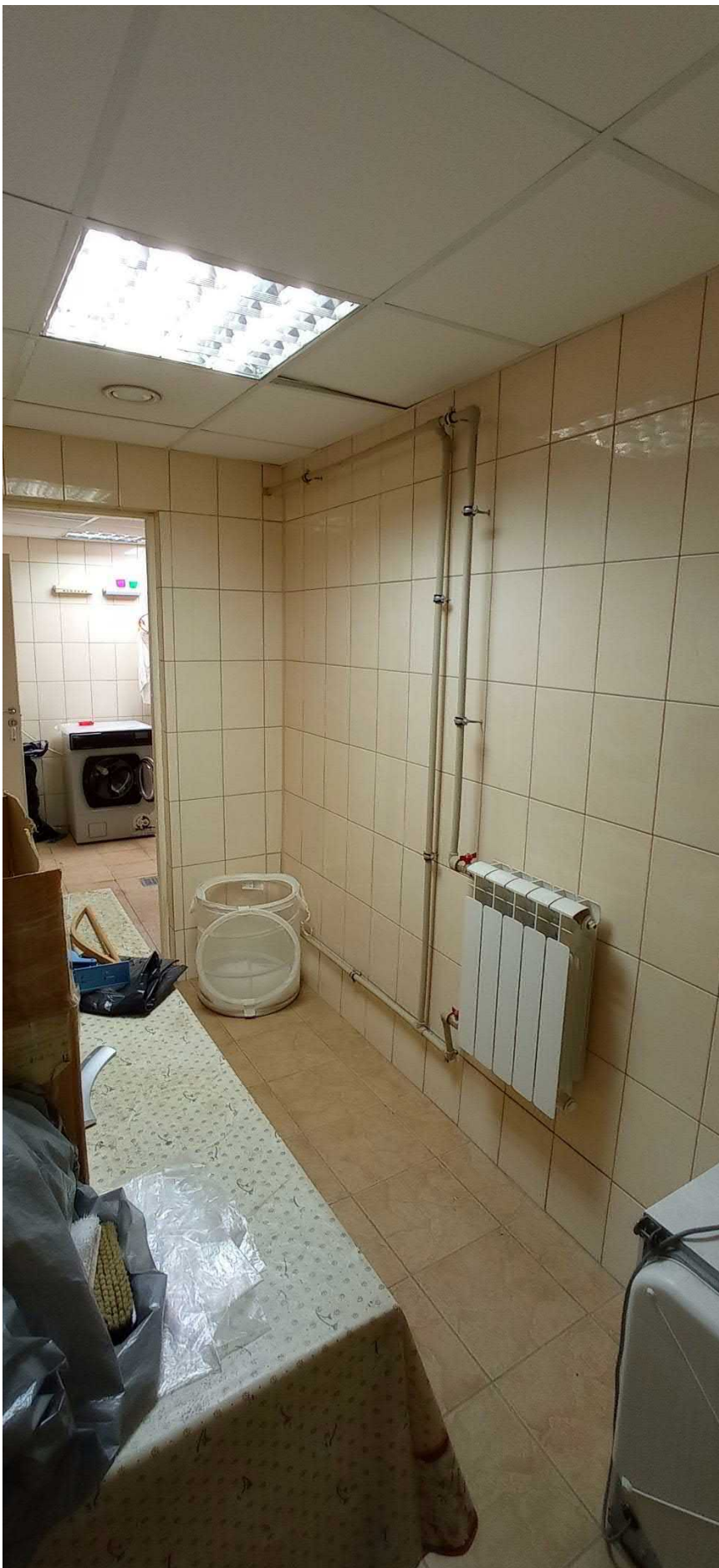
Фото 18. Подсобное помещение постирочной
