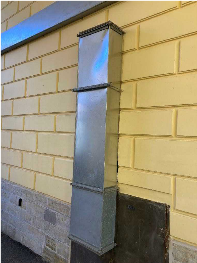
Фото 4. Арка со стороны наб. канала Грибоедова. Существующий воздухозабор
