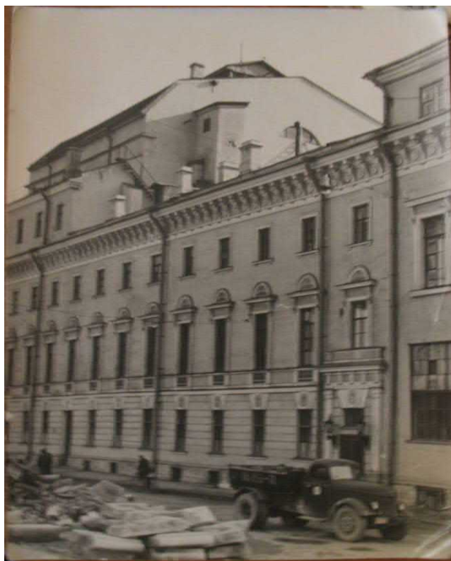
Илл. 28. Фасад Михайловского театра по Инженерной улице. Фото до 1957 г. Фото из собрания театра.
