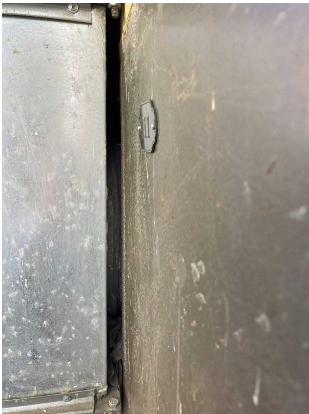
Фото 6. Арка со стороны наб. канала Грибоедова. Существующий воздухозабор. Выход воздухозабора из металлической двери подвала.
