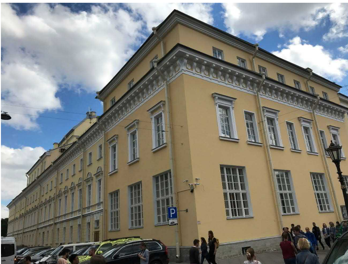
Фото 2. Михайловский театр. Фасад со стороны Инженерной ул. и наб. канала Грибоедова. В подвальном этаже видны окна душевых
