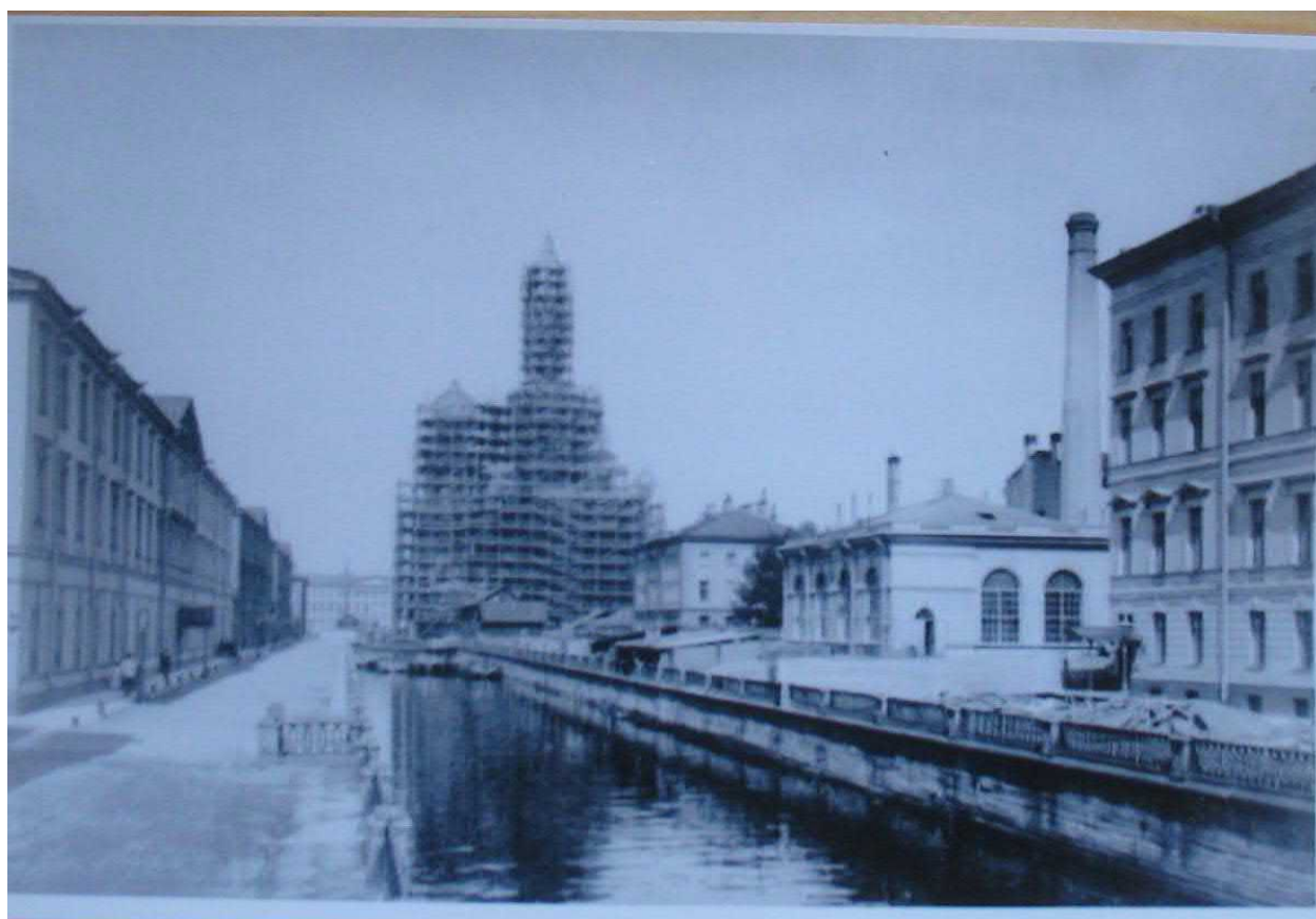
Илл. 16. Электростанция Михайловского театра. 1908 г. Фото из собрания театра.
