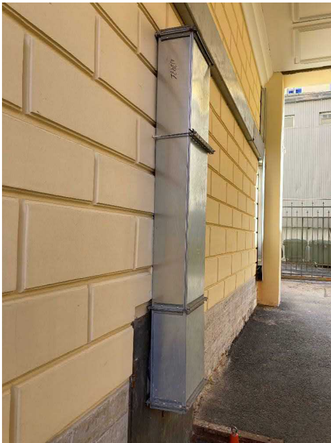
Фото 5. Арка со стороны наб. канала Грибоедова. Существующий воздухозабор
