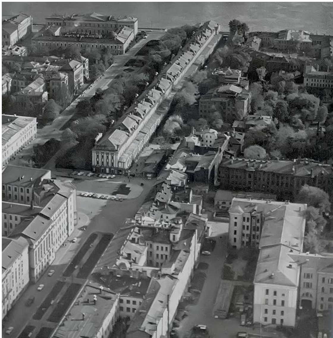
23. Здание Двенадцати Коллегий. Санкт-Петербургский (Ленинградский) Университет. Вид с «птичьего полета». 1970-е гг. Фотография. Опубликовано в: Ленинград. Достопримечательности. Сост. Серпокрыл С. М. -Л., 1974.
