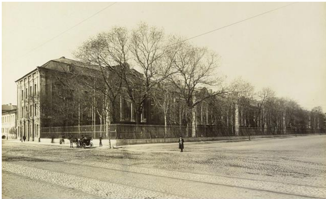
19. Здание Двенадцати Коллегий. Императорский Санкт-Петербургский Университет. Вид вдоль главного фасада. 1908 г. Фотография.
