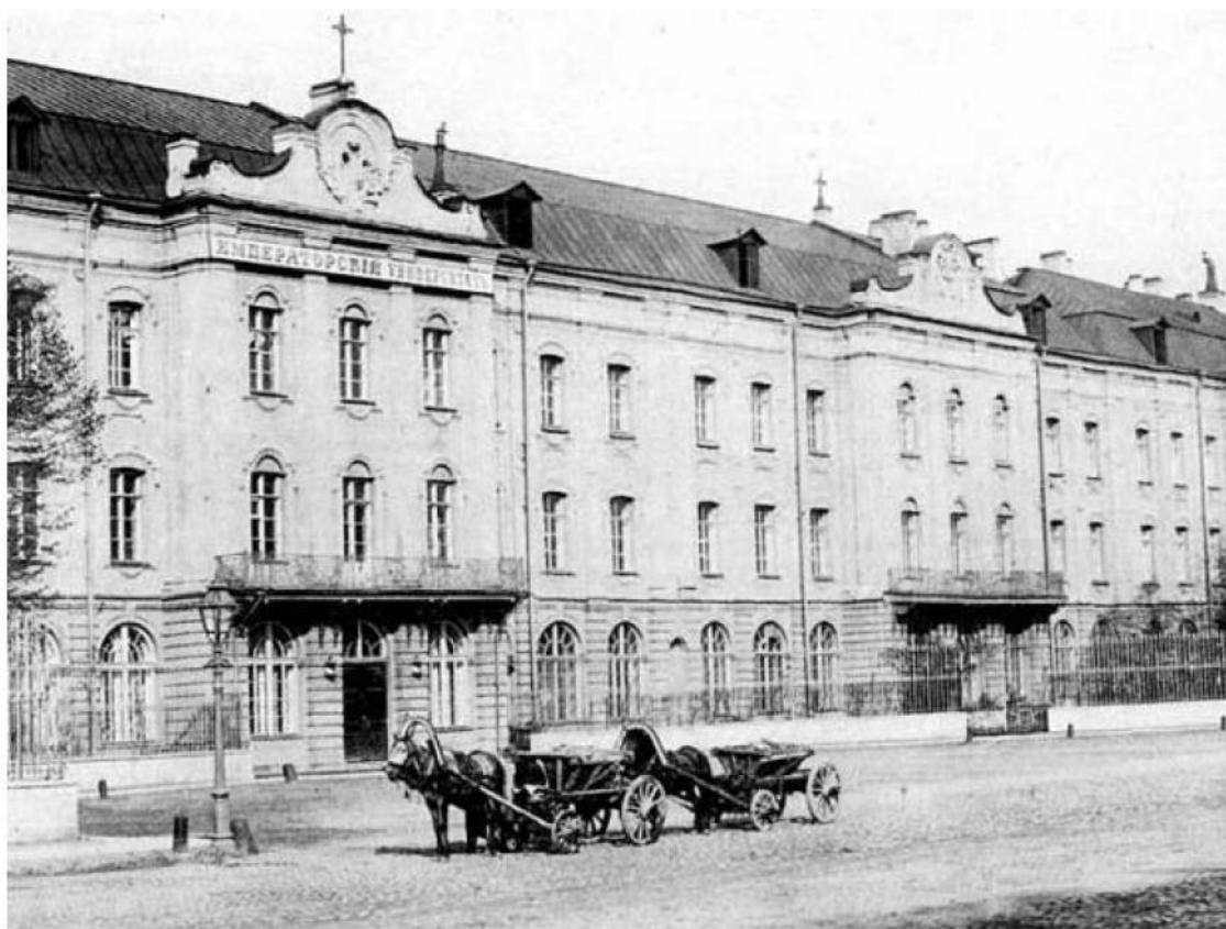
12. Здание Двенадцати Коллегий. Императорский Санкт-Петербургский Университет. Фрагмент главного фасада. 1898 г. Фотография.
