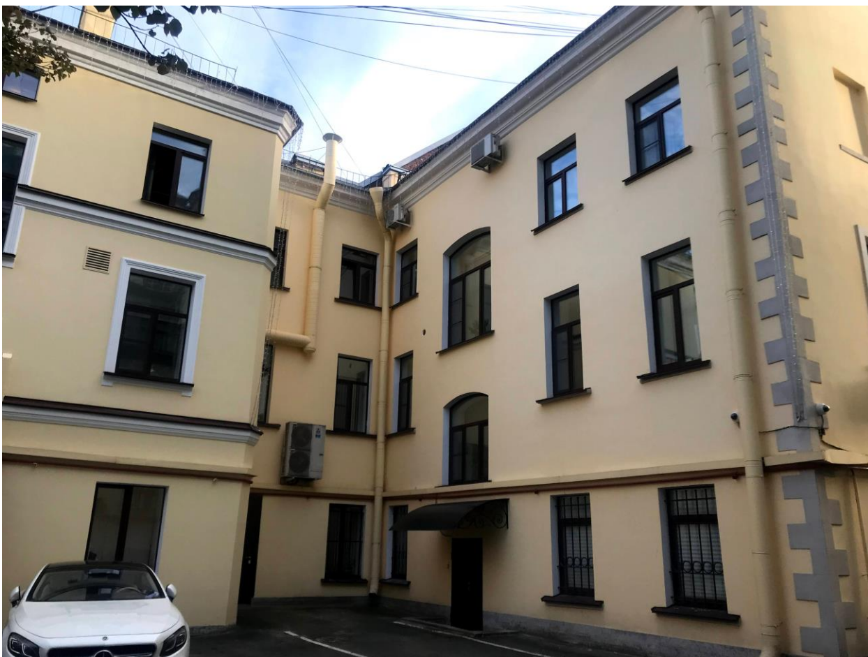
Фото 5. Дворовой фасад лицевого здания.
