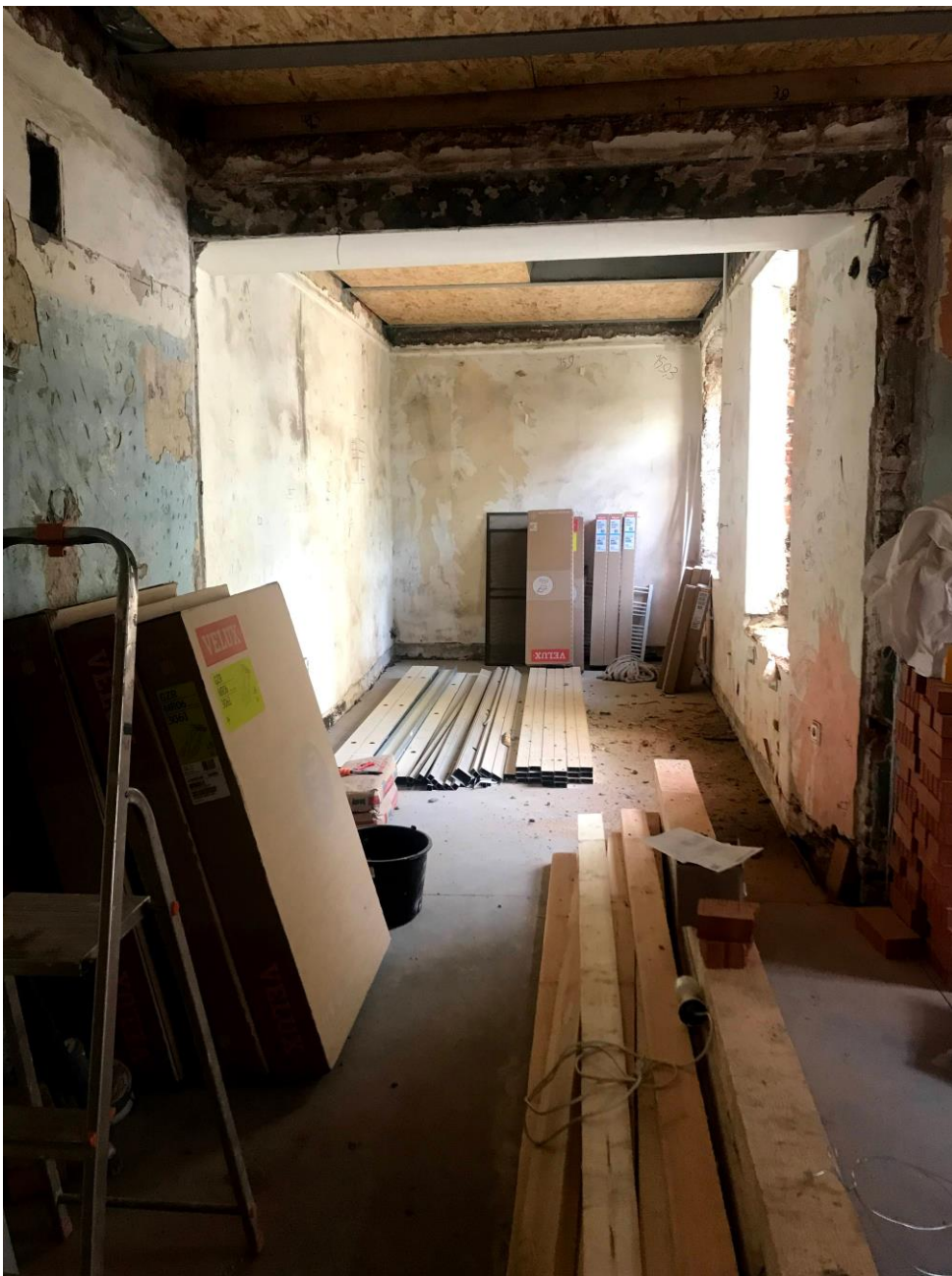
Фото 55. Флигель. Помещение 3 этажа.
