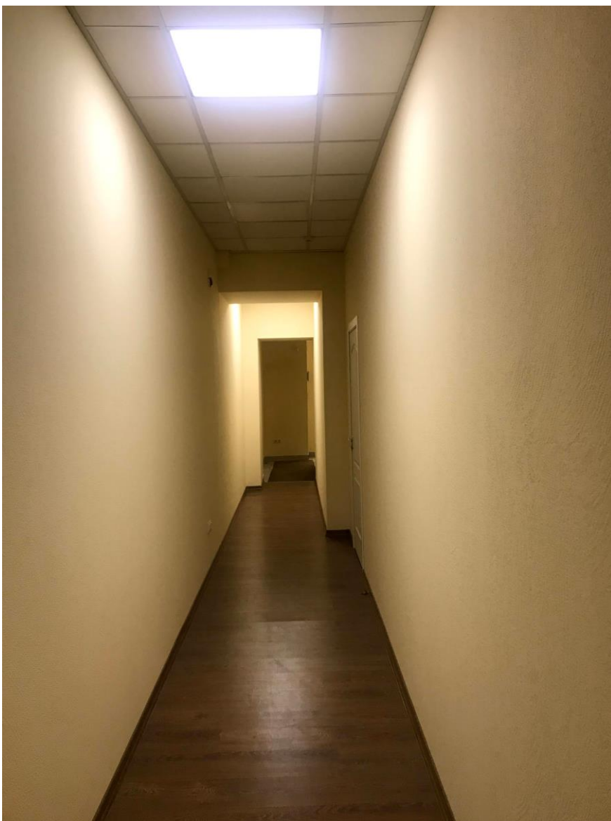
Фото 44. Флигель. Коридор 1 этажа
