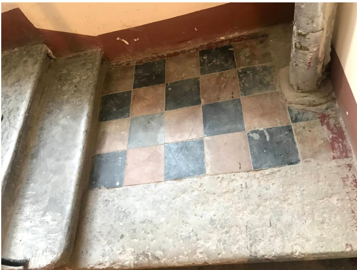
Фото 54. Флигель. Площадка лестницы между 2 и 3 этажами.
