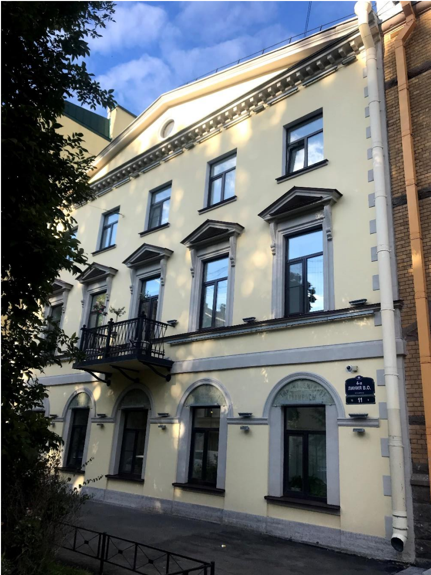
Фото 2. Лицевой фасад здания
