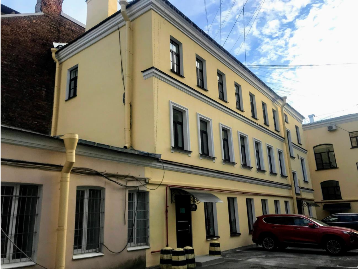
Фото 3. Дворовой флигель. Фасады.
