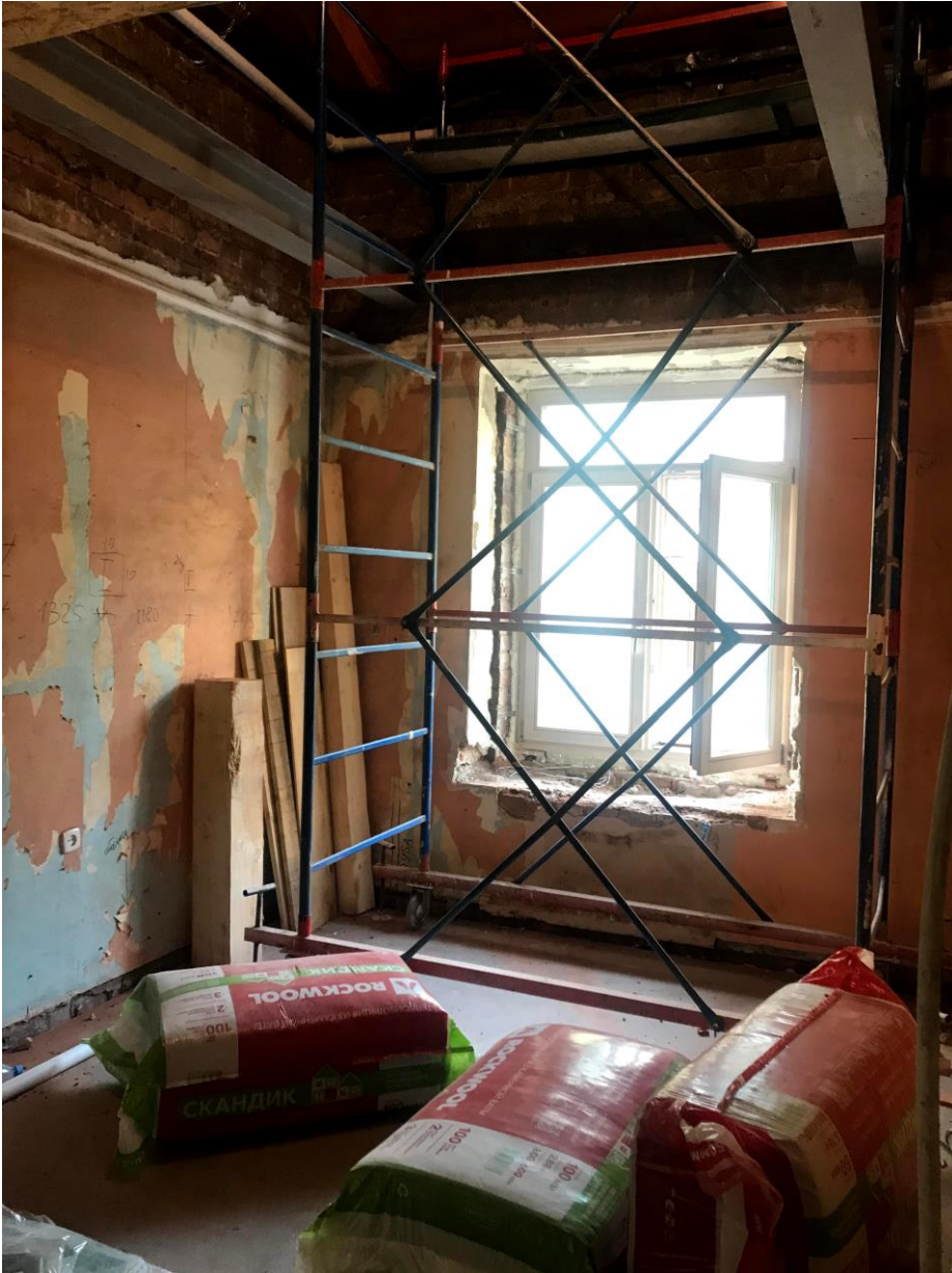
Фото 56. Флигель. Помещение 3 этажа.
