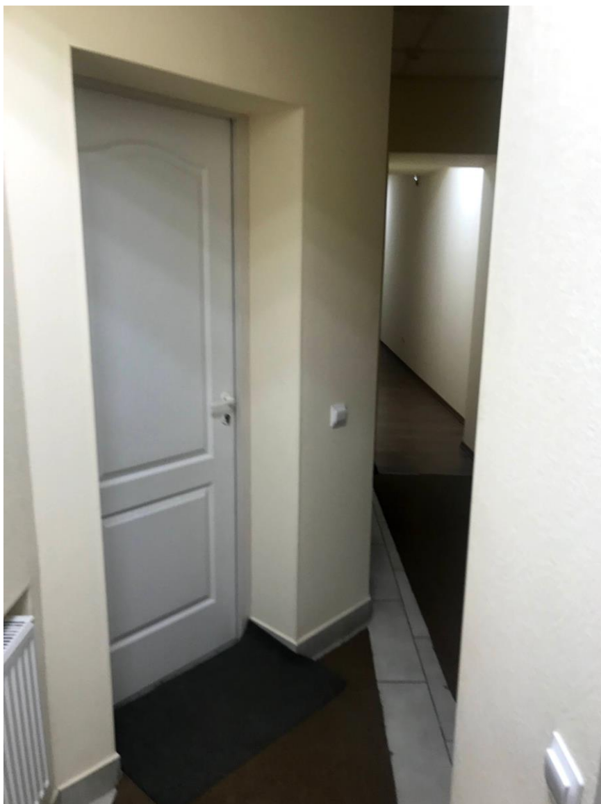
Фото 41. Флигель. Коридор 1 этажа.
