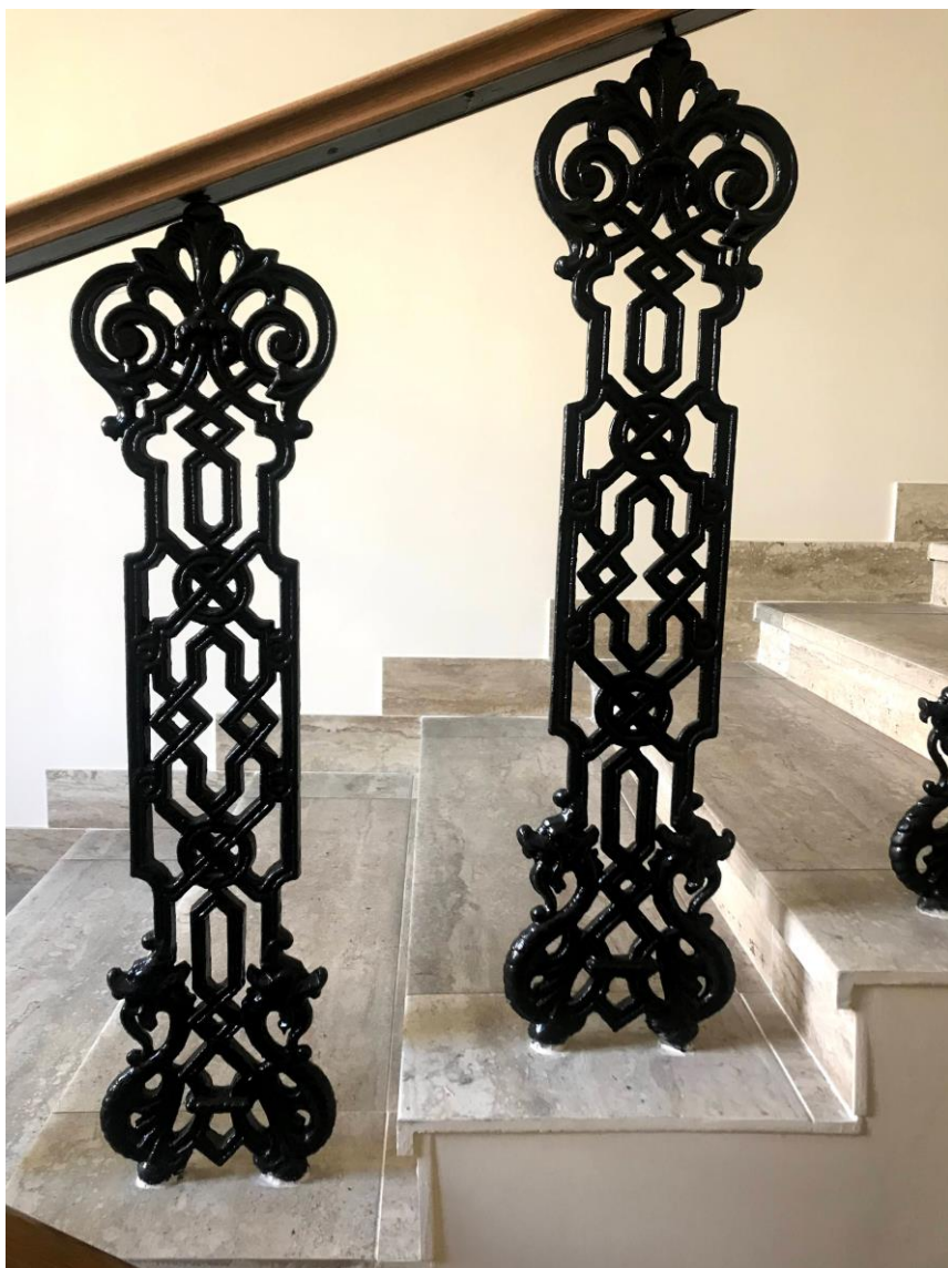
Фото 14. Фрагмент ограждения центральной лестницы.
