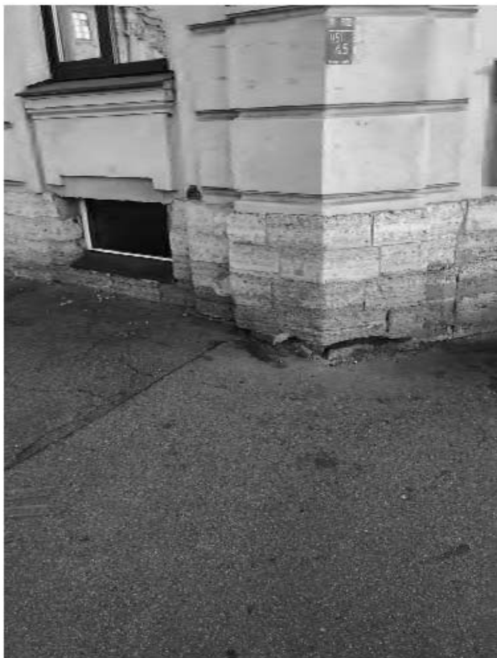
Фото №28. Фрагмент приямка цоколя дома по адресу Биржевая линия 16 с дорожным покрытием со стороны наб. Макарова
