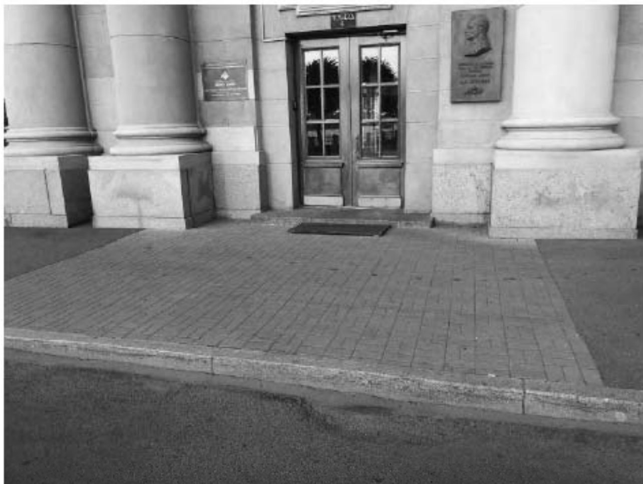
Фото №16. Общій вид тротуара перед парадним входом в здание по адресу наб. Макарова д. 8
