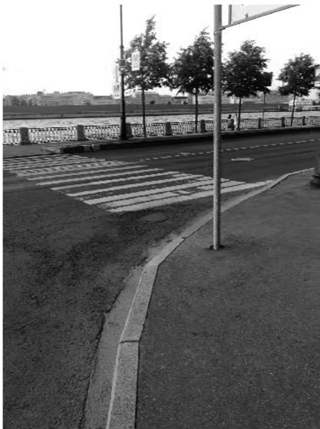
Фото №12. Общий вид на перекресток со стороны Биржевой линии
