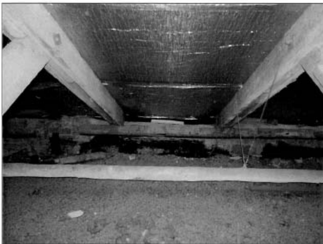
26. Стропильная система. Фрагмент.
