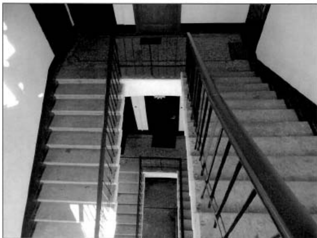
36. Подъезд № 8. Лестница. Общий вид.
