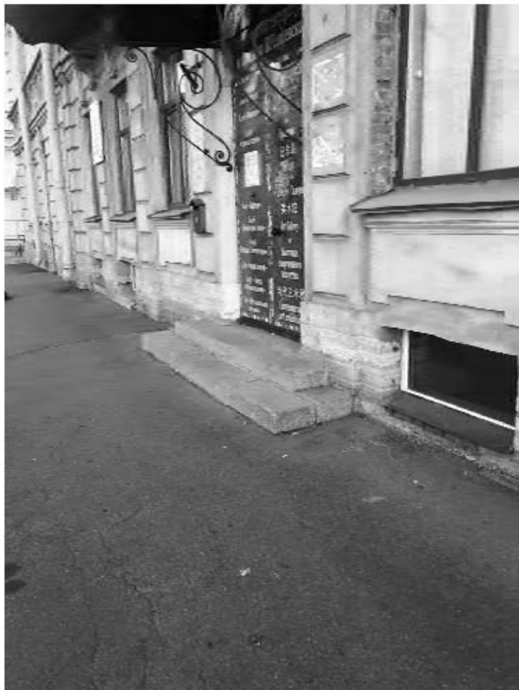
Фото №26. Общий вид на парадный вход
