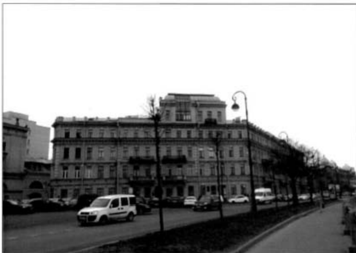
2. Общий вид с северо-востока.
