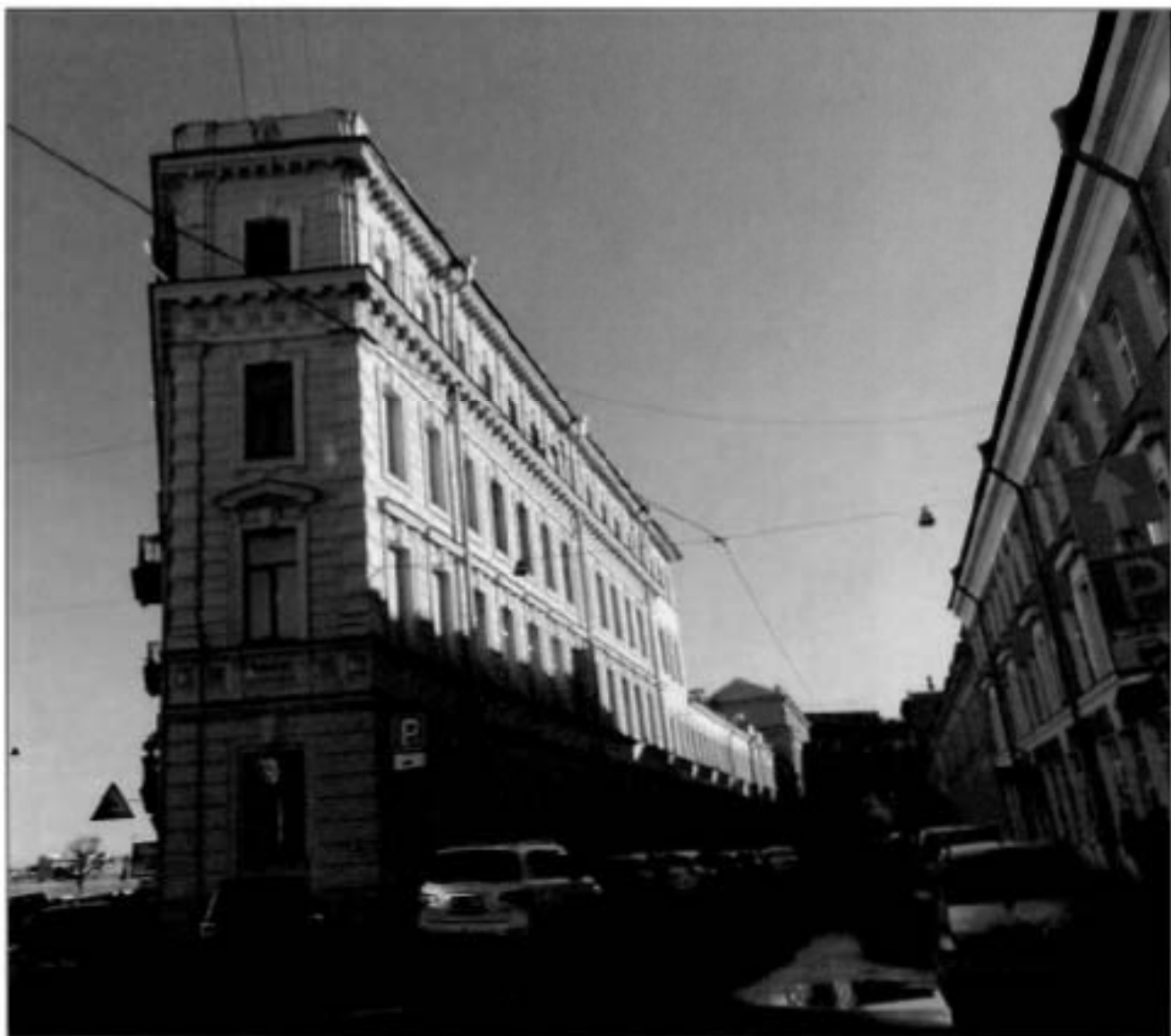
5. Общий вид с юго-запада.
