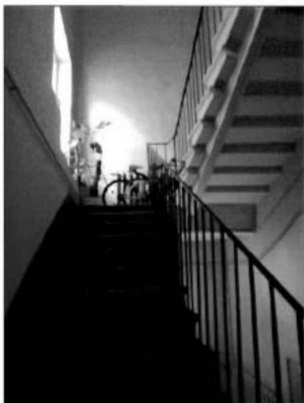
29. Подъезд № 2. Лестница. Общий вид.
