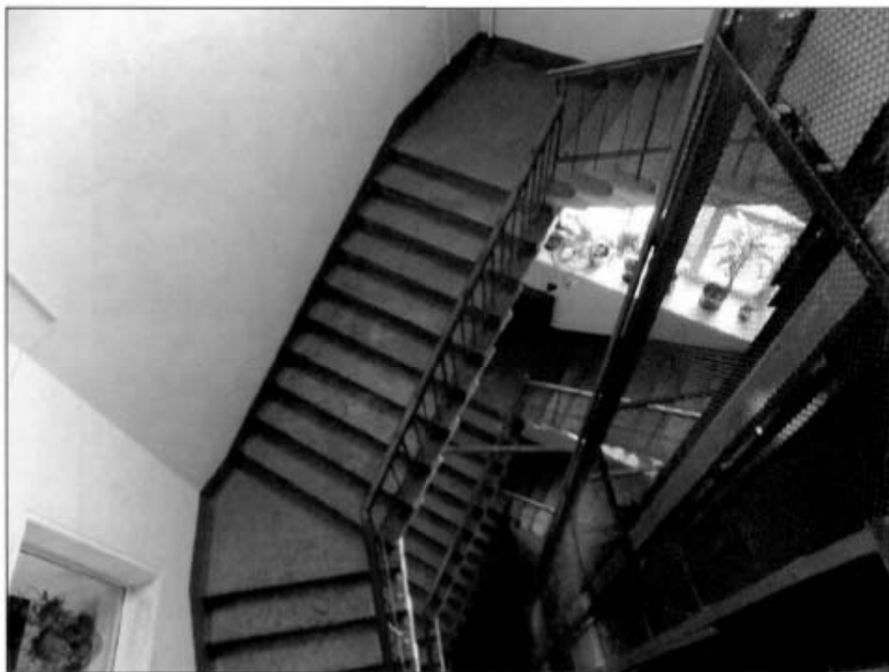
28. Подъезд № 1. Лестница. Общий вид.
