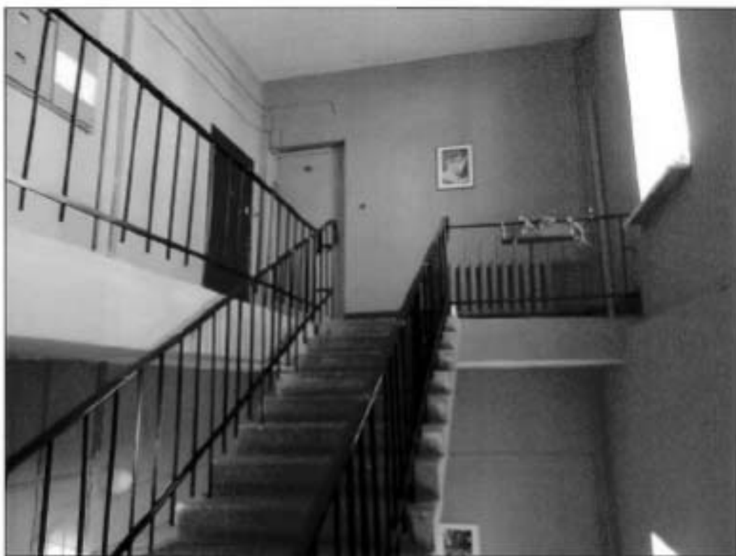
31. Подъезд № 4. Лестница. Общий вид.
