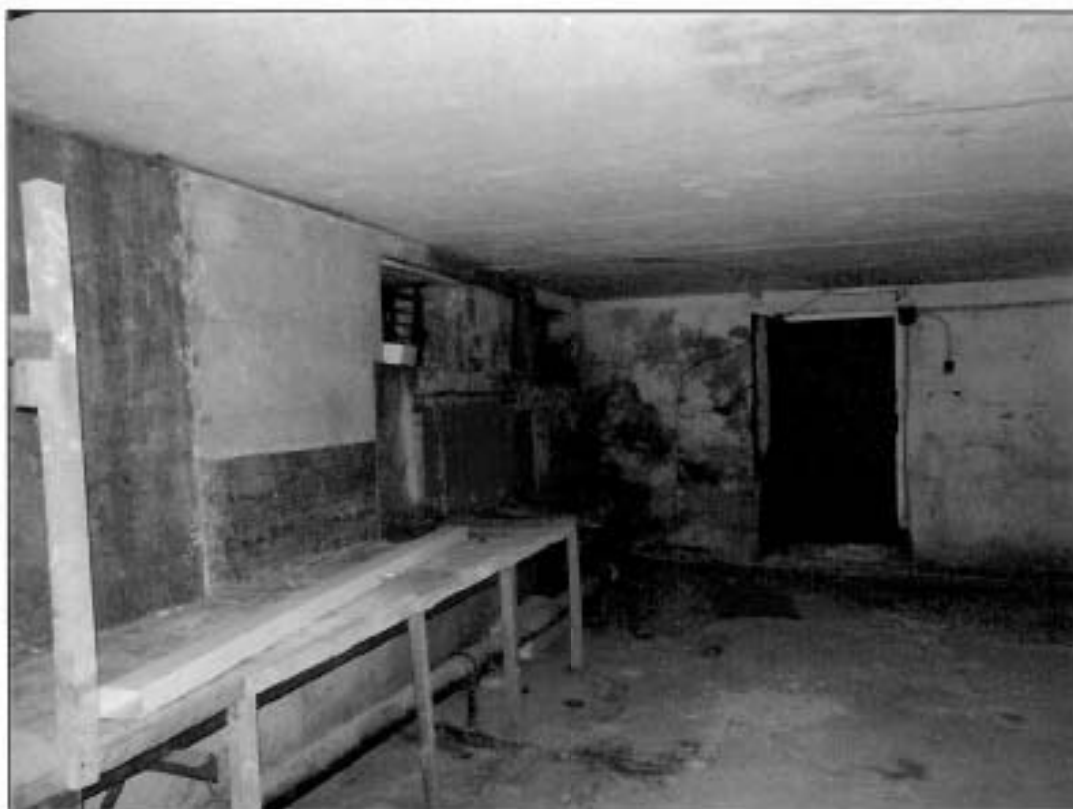
27. Помещение в уровне подвального этажа.
