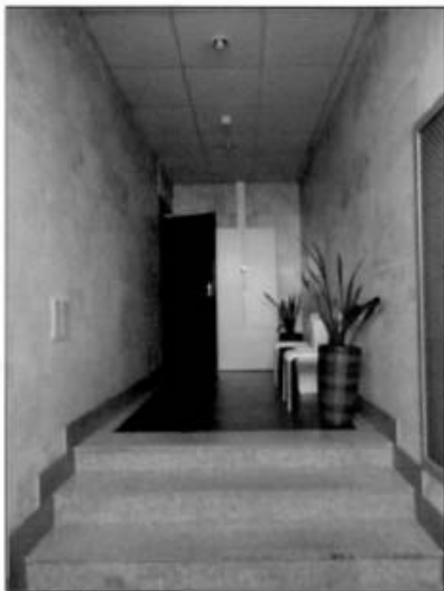
42. Помещение в уровне первого этажа.
