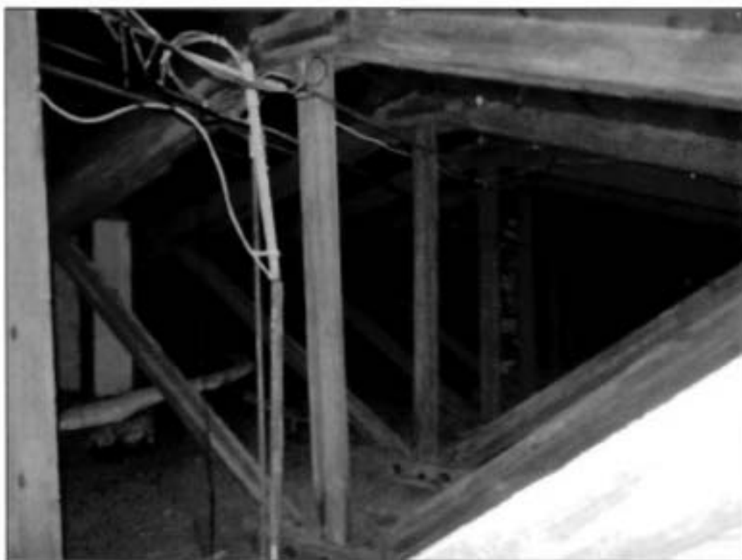
25. Стропильная система. Общий вид.
