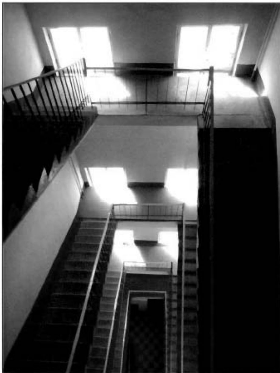
39. Подъезд № 10. Лестница. Общий вид.
