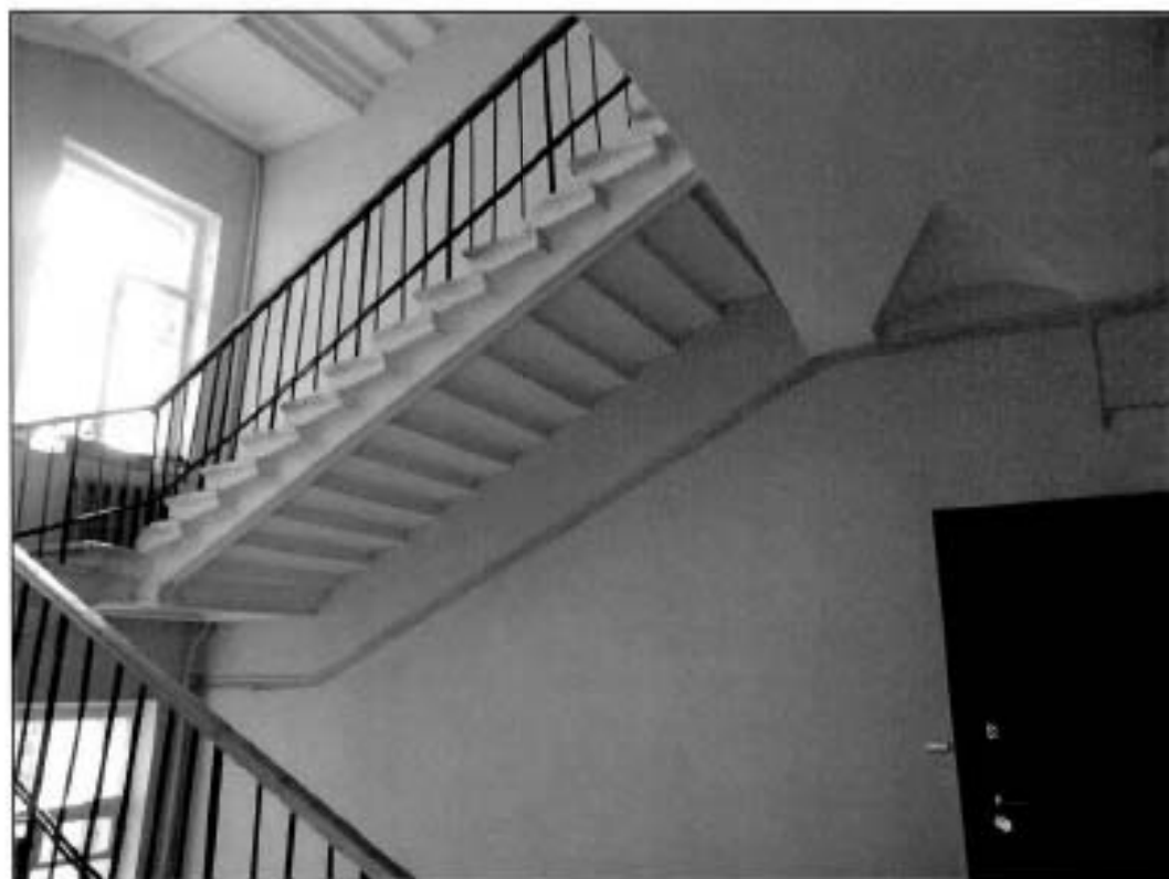
34. Подъезд № 7. Лестница. Общий вид.
