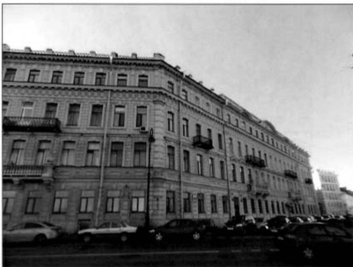
3. Общий вид с северо-запада.
