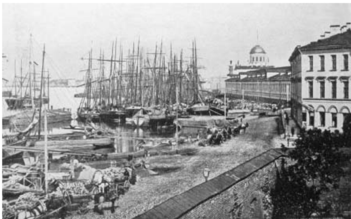
Ил. 49. Тучкова набережная у старого Гостиного двора. Фотография 1860- х гг. Опубл.: Санкт-Петербург. Энциклопедия. СПб.-М., 2006. С. 485.
