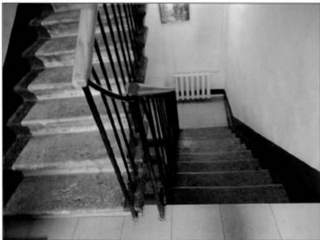
32. Подъезд № 5. Лестница. Общий вид.
