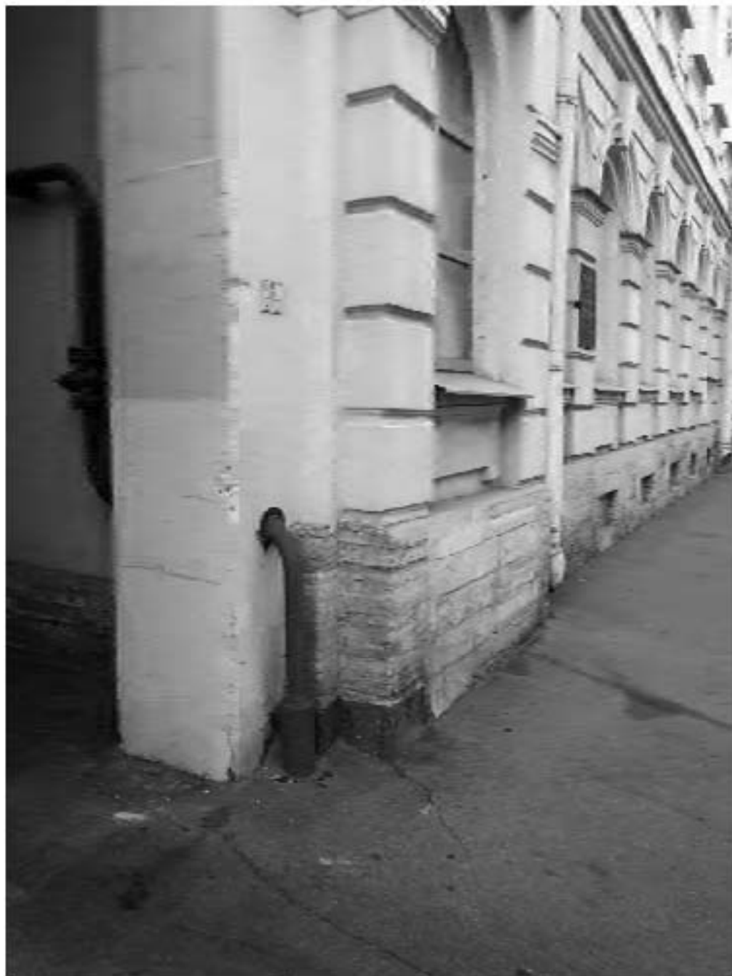
Фото №21 Фрагмент арочного проезда дома по адресу Биржевой пер. д. 1 со стороны Биржевого пер.
