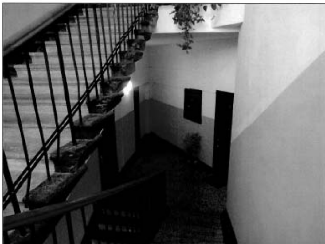
33. Подъезд № 6. Лестница. Общий вид.
