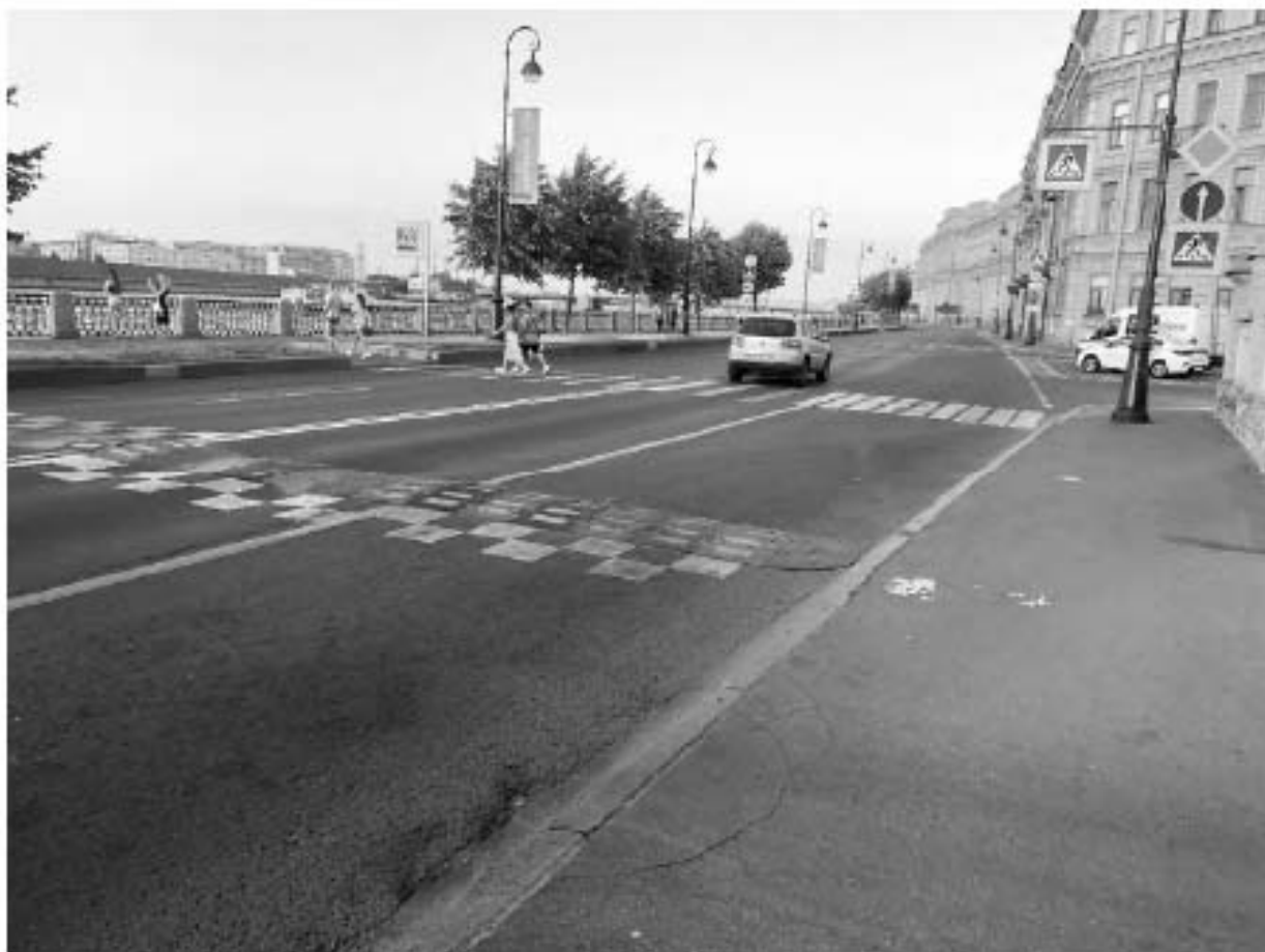
Фото №33 Общий вид на перекресток и пешеходную часть наб. Макарова и Волховского пер со стороны здания по адресу наб. Макарова д.12
