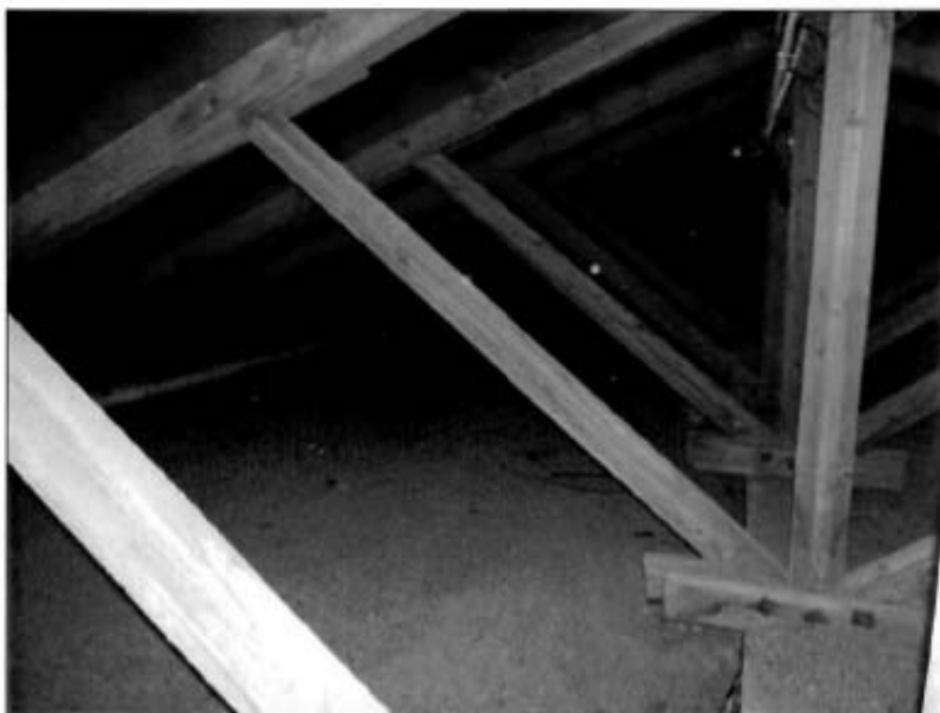
24. Стропильная система. Общий вид.
