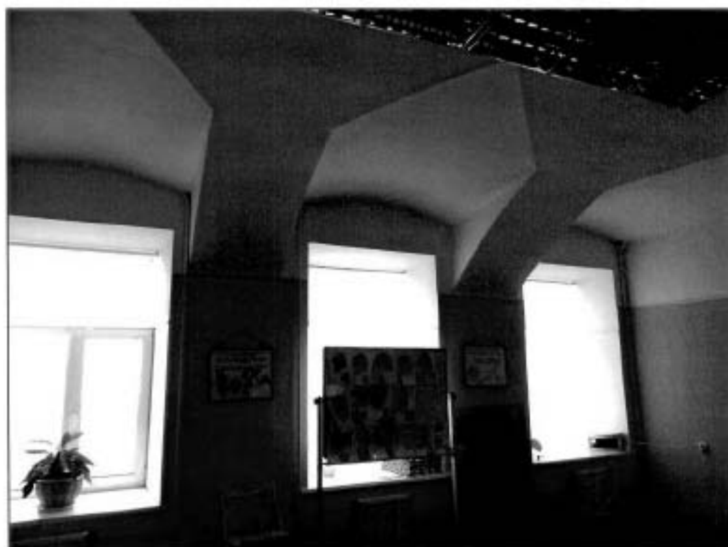
41. Помещение в уровне первого этажа.
