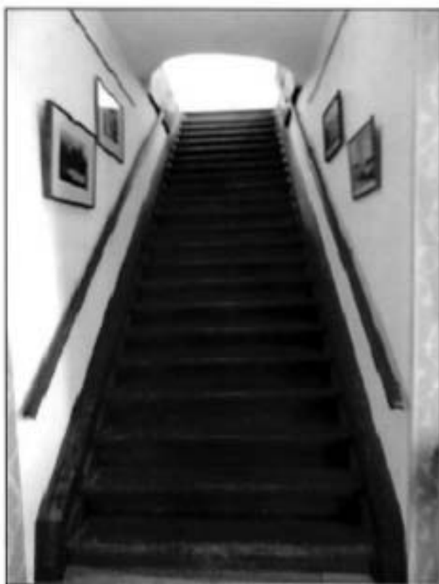
43. Внутрисконная деревянная лестница в уровне четвертого этажа.
