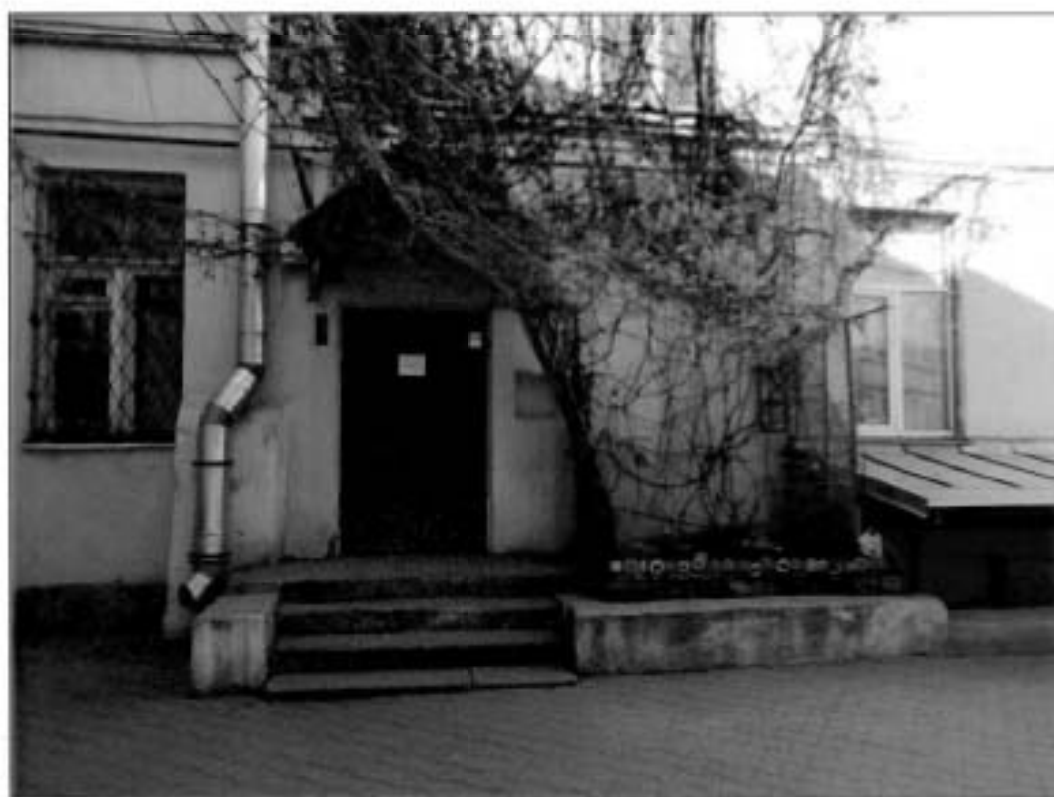
21. Внутренний двор. Подъезд № 7.
