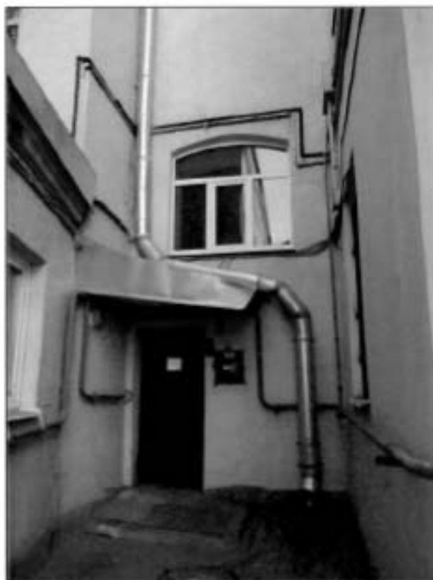
20. Внутренний двор. Подъезд №6.
