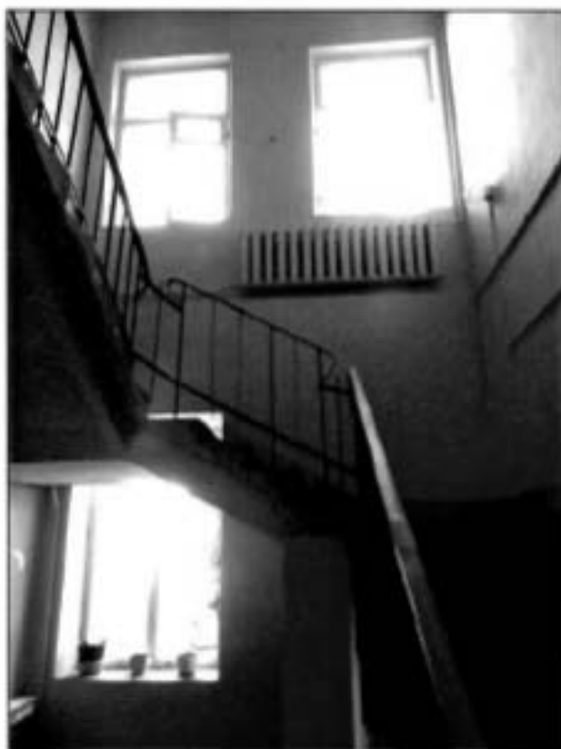
30. Подъезд № 3. Лестница. Общий вид.
