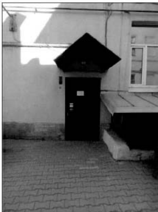
22. Внутренний двор. Подъезд № 10.
