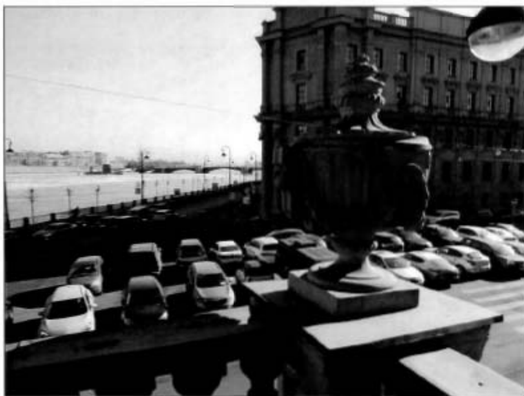
13. Северо-восточный фасад. Вазон в оформлении ограждения балкона в уровне 2-го этажа.
