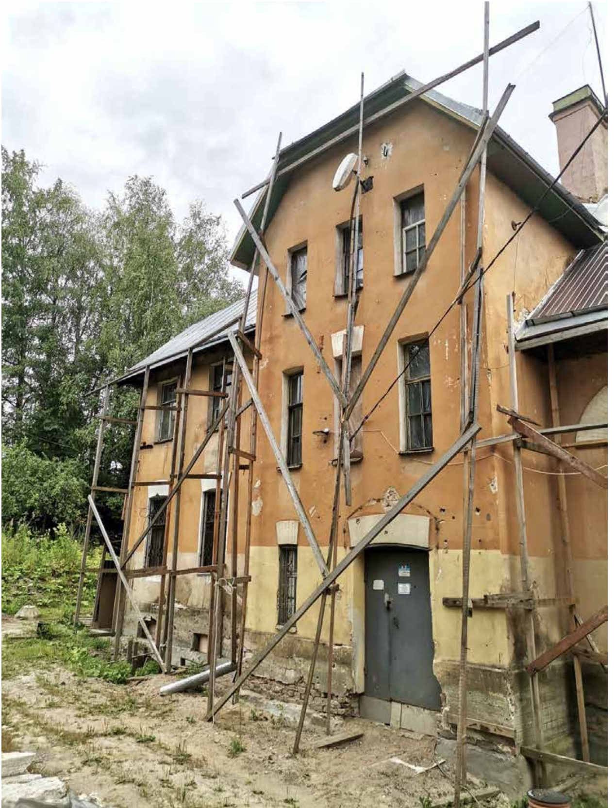
Фото 13. Выявленный ОКН «Павловская электрическая станция (с 2 службами и оградой)». Здание Павловской электростанции (г. Павловск, ул. Надгорная, д. 16 лит. А). Вид с северо-востока. Фрагмент. Съёмка 20.07.2021 г.
