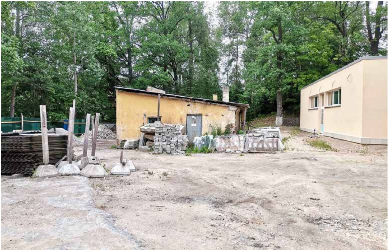
Фото 03. Выявленный ОКН «Павловская электрическая станция (с 2 службами и оградой)». Служебные корпуса (г. Павловск, ул. Надгорная, д. 16 лит. Б, В). Вид с юго-востока. Съёмка 20.07.2021 г.
