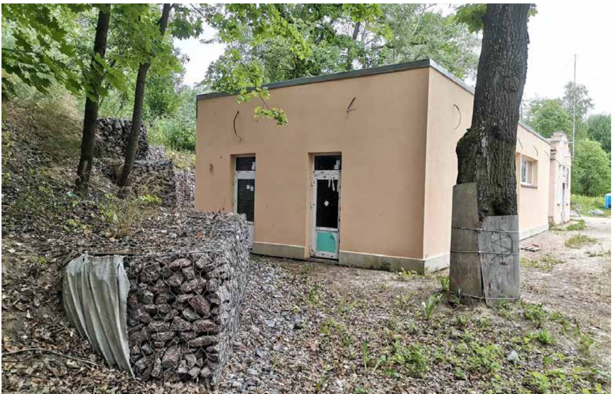
Фото 08. Выявленный ОКН «Павловская электрическая станция (с 2 службами и оградой)». Территория Павловской электростанции, служебные корпуса (г. Павловск, ул. Надгорная, д. 16 лит. В; д. 16а лит. А). Вид с северо-запада. Съёмка 20.07.2021 г.
