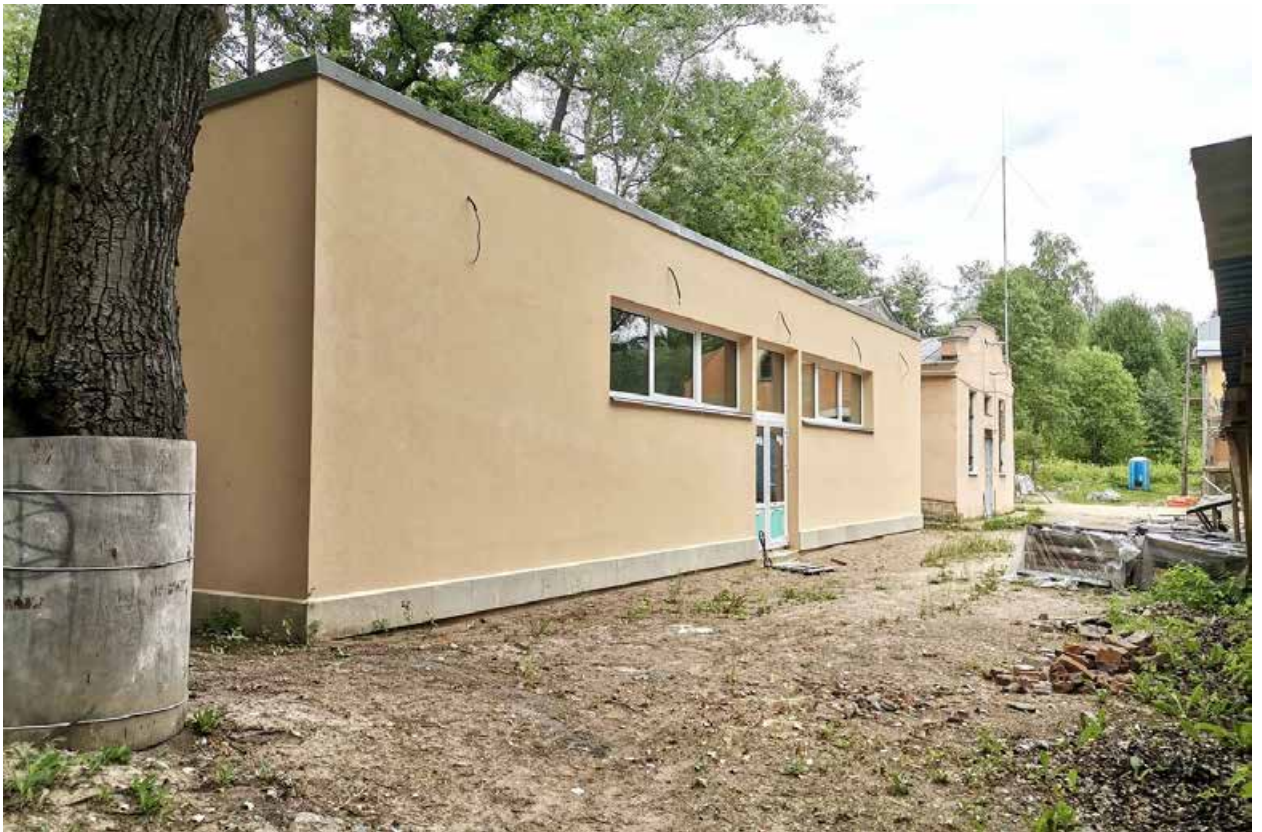
Фото 07. Выявленный ОКН «Павловская электрическая станция (с 2 службами и оградой)». Территория Павловской электростанции, служебные корпуса (г. Павловск, ул. Надгорная, д. 16 лит. В; д. 16а лит. А). Вид с северо-запада. Съёмка 20.07.2021 г.
