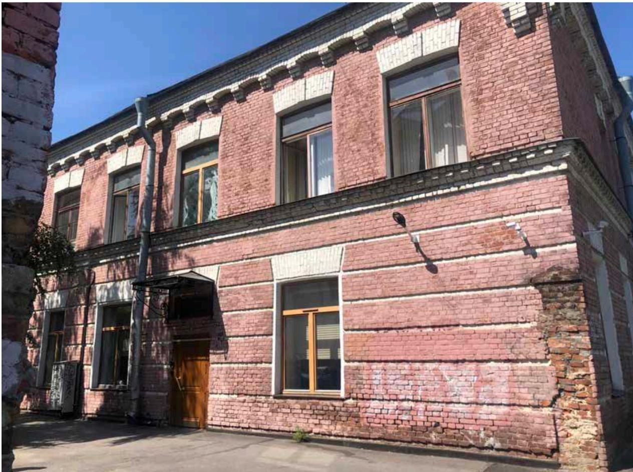
Фото №14. Угловая часть дворового фасада. Кирпичная кладка покрашена. Венчает фасад профилированный карниз из кирпича. Местами кирпичная кладка нарушена, зафиксированы сколы.
