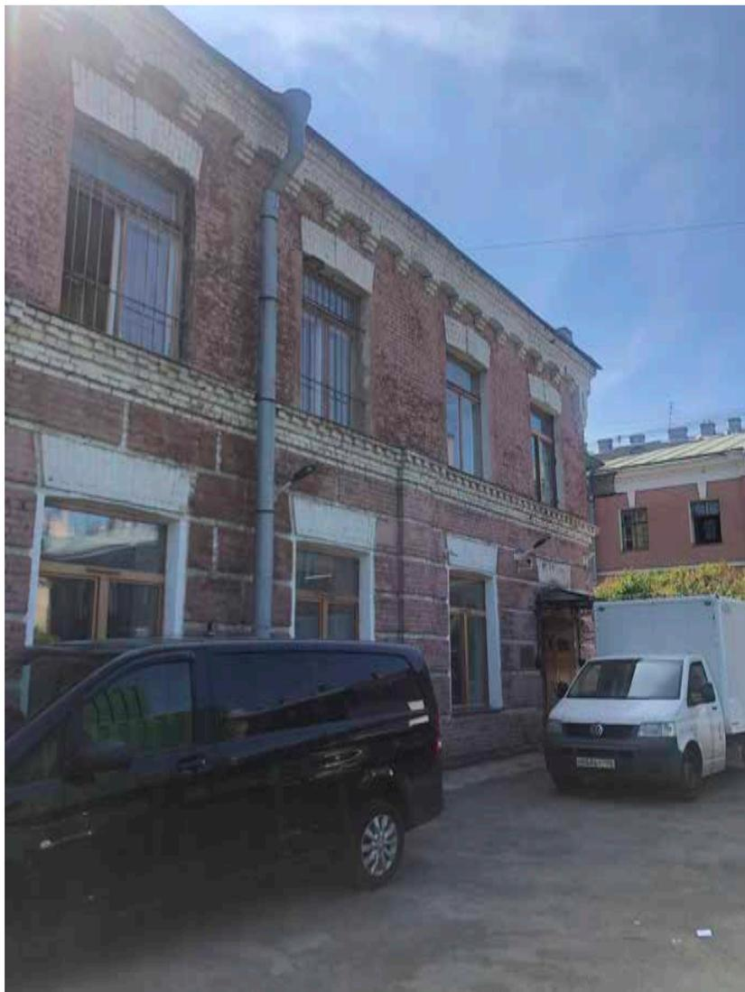
Фото №8. Часть дворового фасада. Кирпичная кладка покрашена. Венчает фасад профилированный карниз из кирпича. Над существующим входом имеется карниз.
