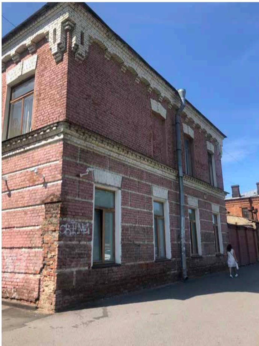
Фото №2. Общий вид фасада со стороны улицы Введенского канала. Кирпич покрашен краской, местами кирпичная кладка нарушена, зафиксированы сколы.
