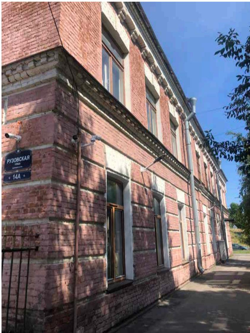
Фото №12. Общий вид фасада. Кирпичная кладка покрашена. Венчает фасад профилированный карниз из кирпича.
