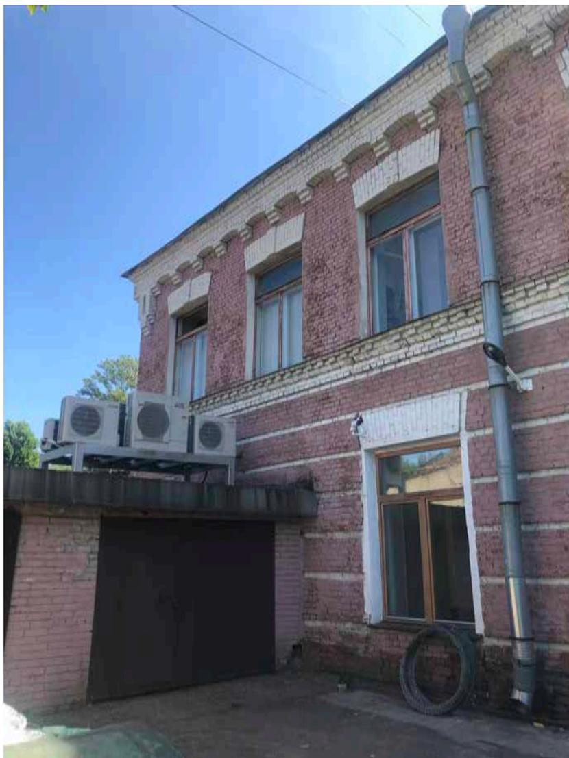
Фото №10. Часть дворового фасада. Кирпичная кладка покрашена. Венчает фасад профилированный карниз из кирпича.
