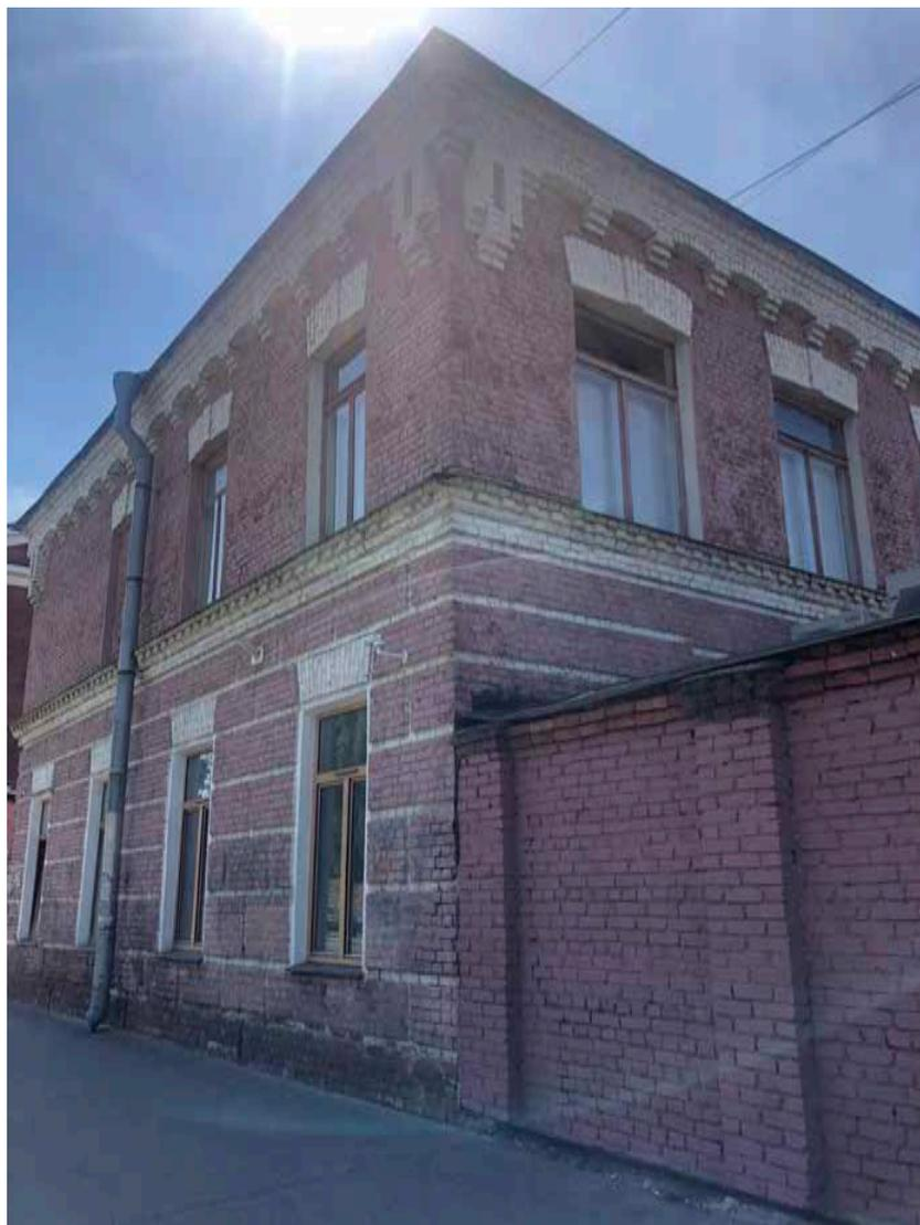
Фото №17. Общий вид фасада со стороны улицы Введенского канала. Кирпичная кладка покрашена. Венчает фасад профилированный карниз из кирпича.
