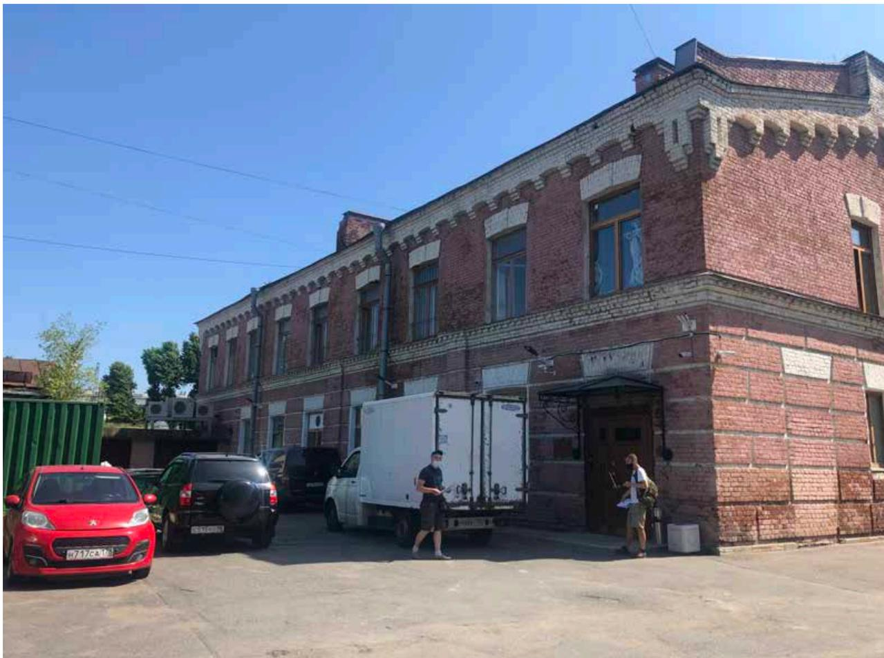
Фото №7. Общий вид фасада. Часть оконных проемов 1 этажа заложена, кирпичная кладка покрашена. Венчает фасад профилированный карниз из кирпича. Над существующим входом имеется карниз.
