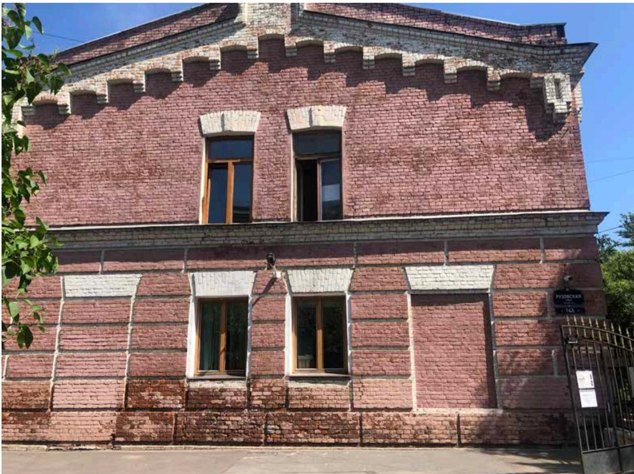
Фото №5. Общий вид фасада. Часть оконных проемов 1 этажа заложена, кирпичная кладка покрашена. Венчает фасад профилированный карниз из кирпича.
