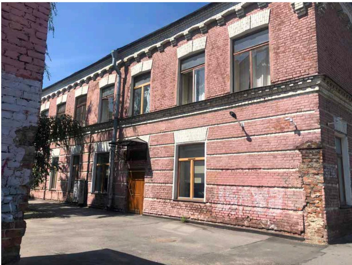
Фото №3. Общий вид фасада. Кирпич покрашен краской, местами кирпичная кладка нарушена, зафиксированы сколы.
