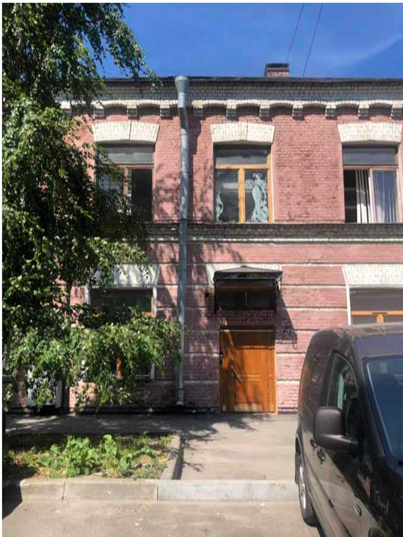
Фото №16. Часть фасада. Кирпичная кладка покрашена. Венчает фасад профилированный карниз из кирпича. Существующий вход с кованым металлическим козырьком.
