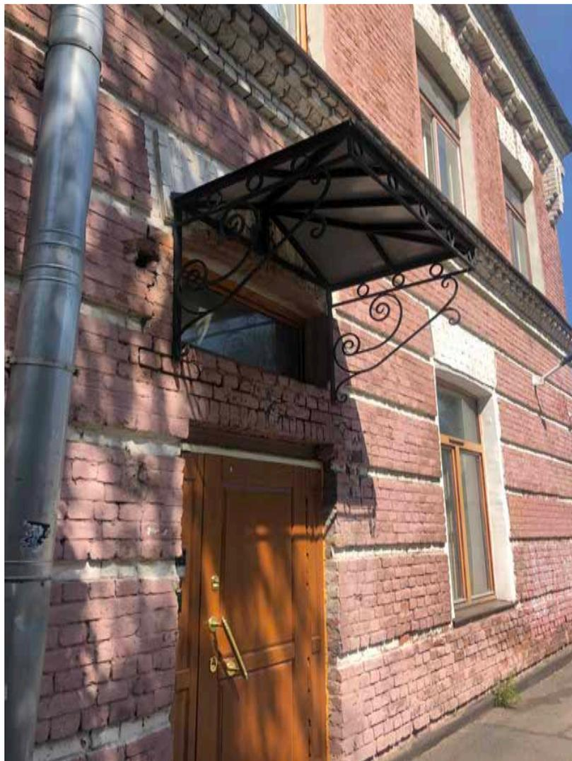
Фото №15. Часть фасада. Кирпичная кладка покрашена. Венчает фасад профилированный карниз из кирпича. Существующий вход с кованым металлическим козырьком.
