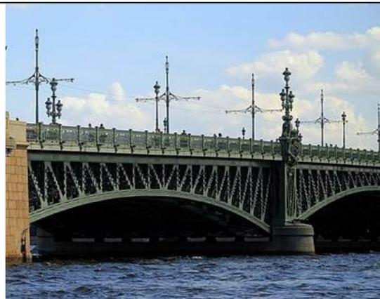
разводной пролет (местоположение, конфигурация, габариты) – однокрылый металлический цельносварный пролет;
