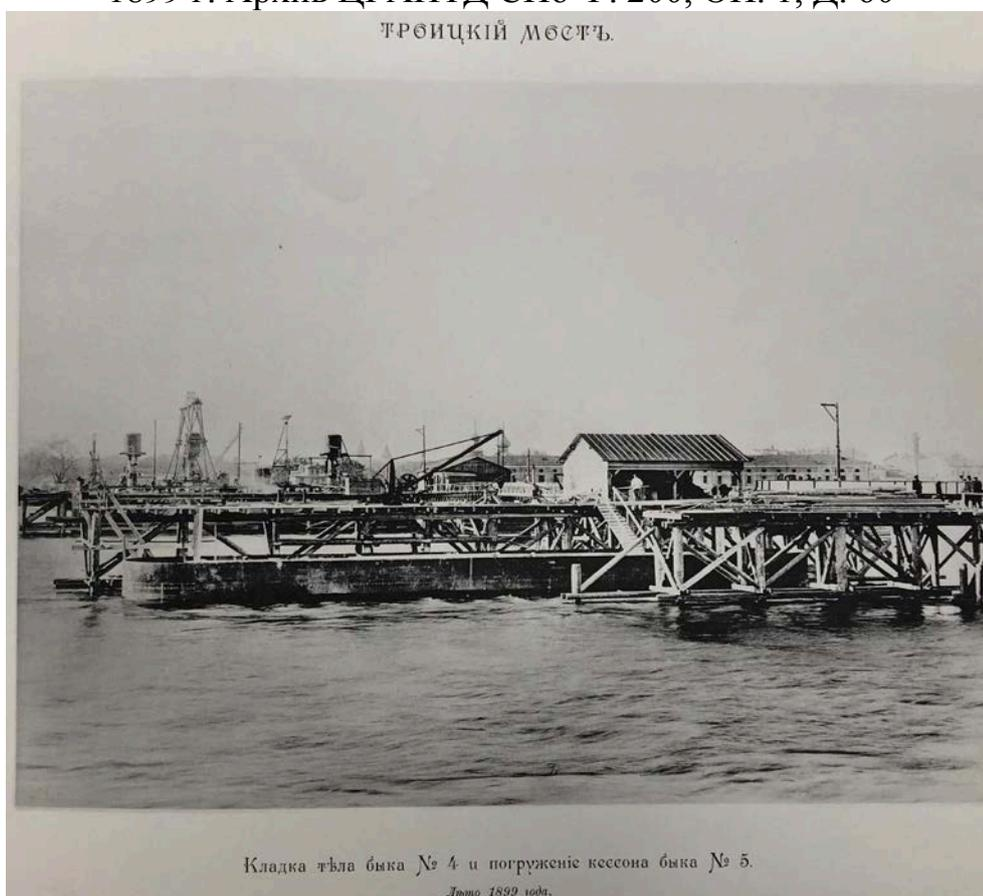
9. Троицкий мост. Кладка тела быка №4 и погружение кессона быка №5. Дата фото: 1899 г. Архив ЦГАНТД СПб Ф. 200, ОП. 1, Д. 60
