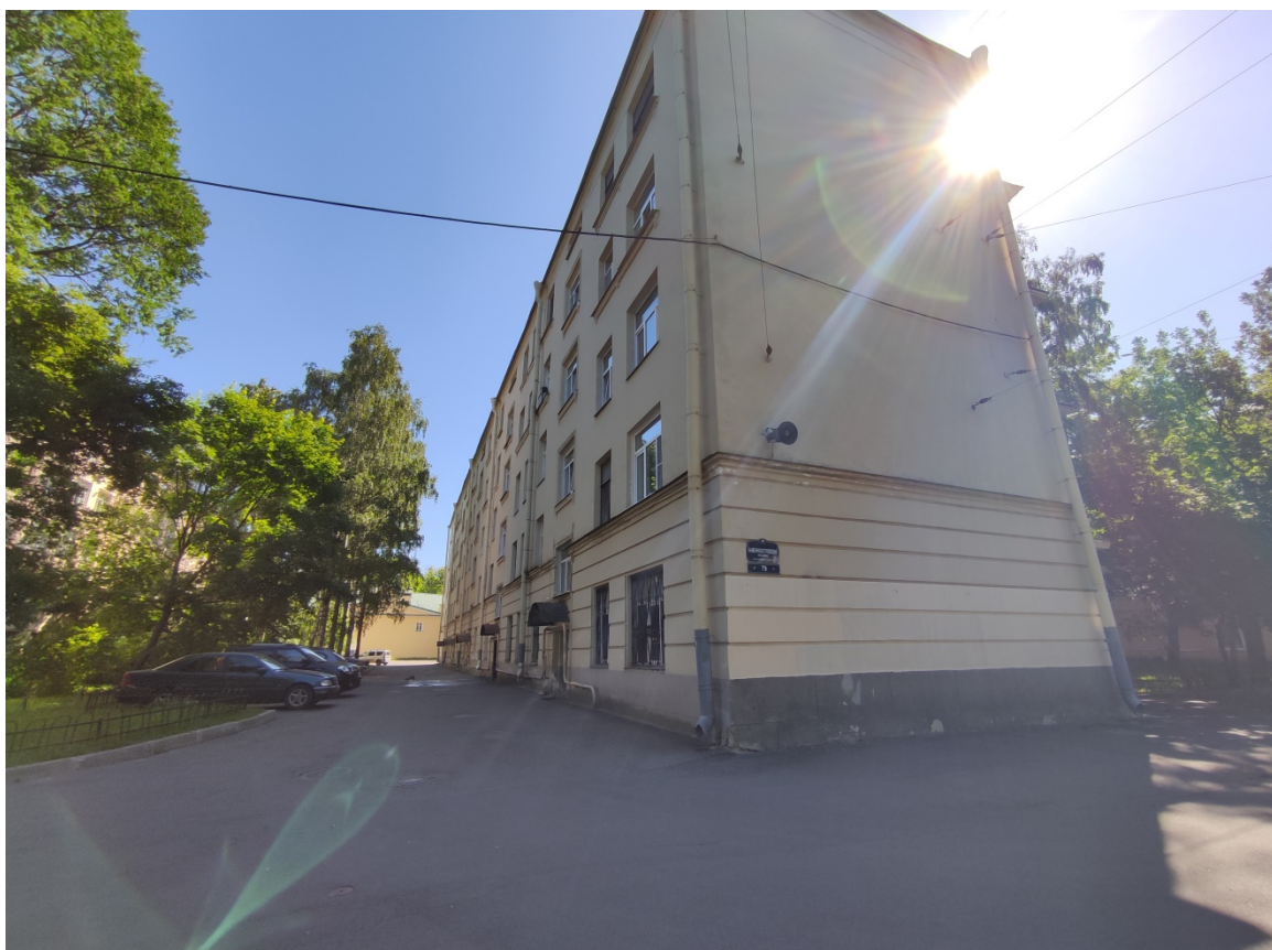
Фото 6. Угол дома 79. Вид с запада.
