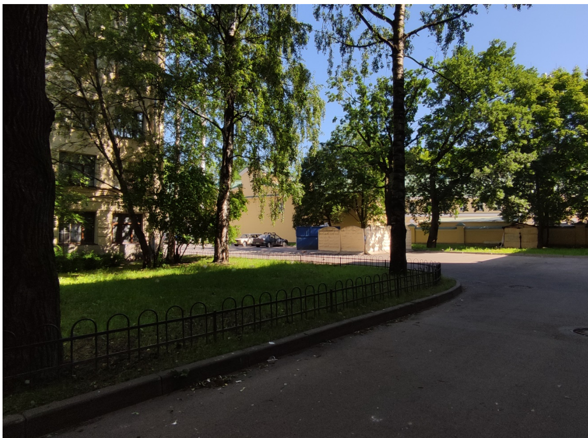
Фото 5. Площадка и угол дома 79. Вид с запада.
