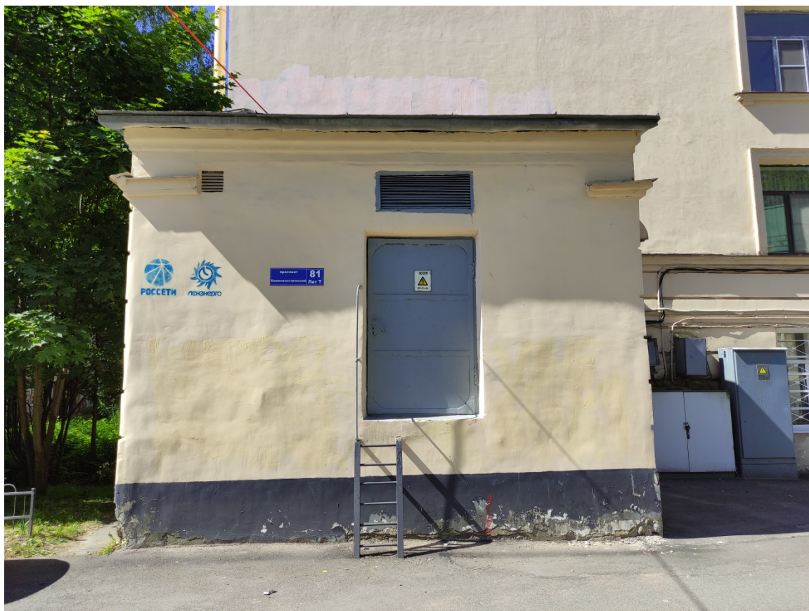
Фото 1. Вид на трансформаторную подстанцию с востока.
