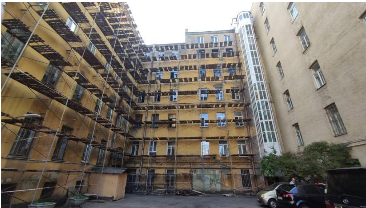
Фото 12. Фрагмент дворового фасада выявленного объекта культурного наследия «Дом Т.М. Любищевой»
