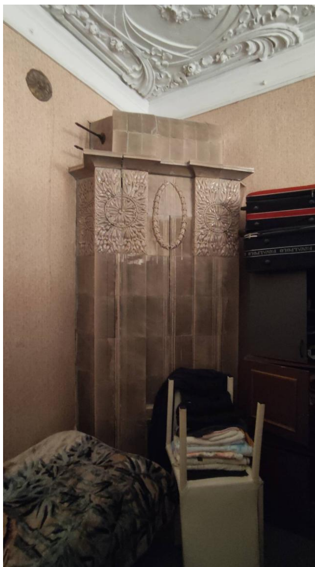
Фото 30. Интерьер квартиры №2, расположенной в выявленном объекте культурного наследия «Дом Т.М. Любищевой», ч.п.9, угловая печь
