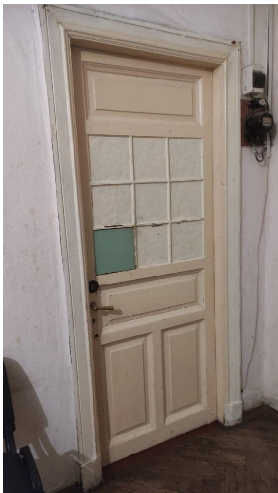
Фото 32. Интерьер квартиры №2, расположенной в выявленном объекте культурного наследия «Дом Т.М. Любищевой», ч.п.11, входное дверное заполнение в пом. №12
