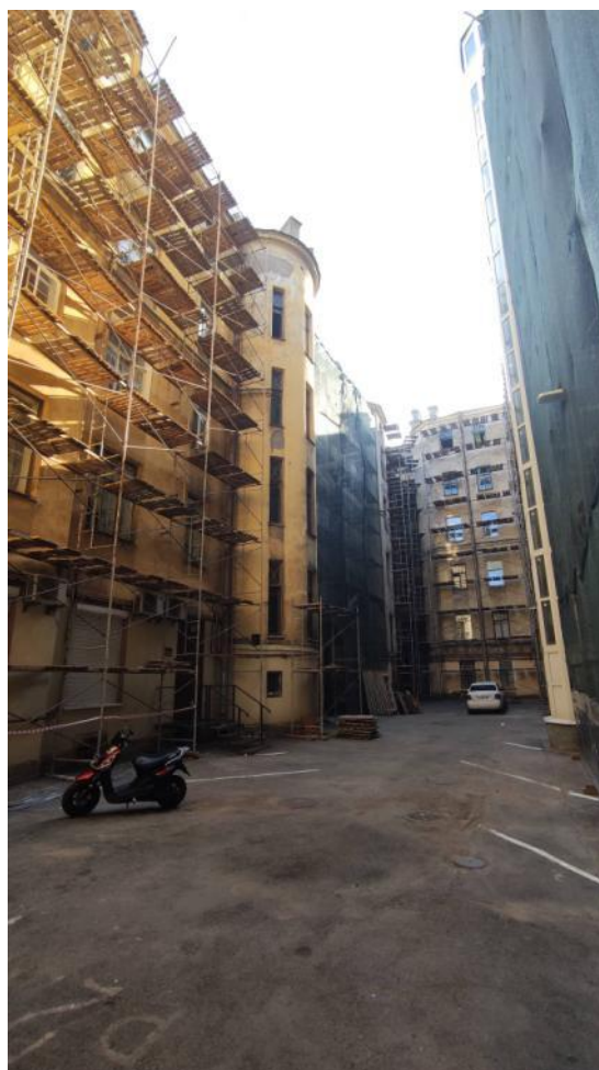
Фото 6. Фрагмент дворового фасада выявленного объекта культурного наследия «Дом Т.М. Любищевой»
