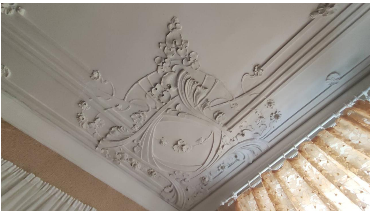
Фото 28. Интерьер квартиры №2, расположенной в выявленном объекте культурного наследия «Дом Т.М. Любичевой», ч.п.9, лепное угловое панно с цветочно-лиственным декором
