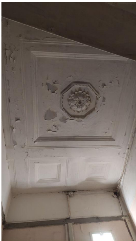
Фото 34. Интерьер квартиры №2, расположенной в выявленном объекте культурного наследия «Дом Т.М. Любищевой», ч.п.13, оформление потолка
