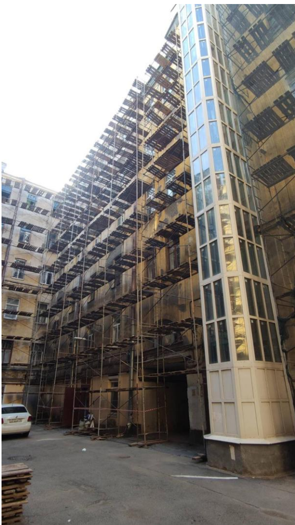
Фото 10. Фрагмент дворового фасада выявленного объекта культурного наследия «Дом Т.М. Любищевой»
