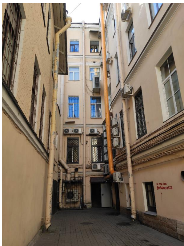
Фото №5. Фрагмент дворовых фасадов. Вход на лестничную клетку со стороны двора
