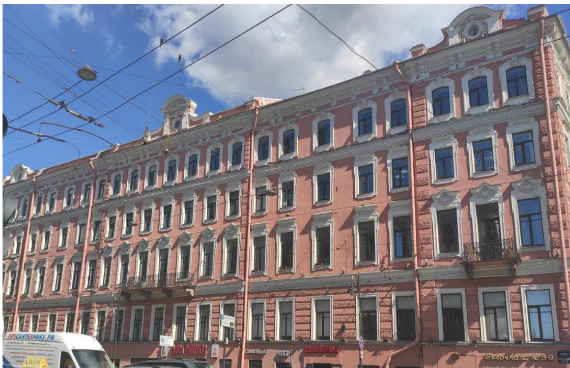
Фото №2. Фасады здания по Литейному проспекту
