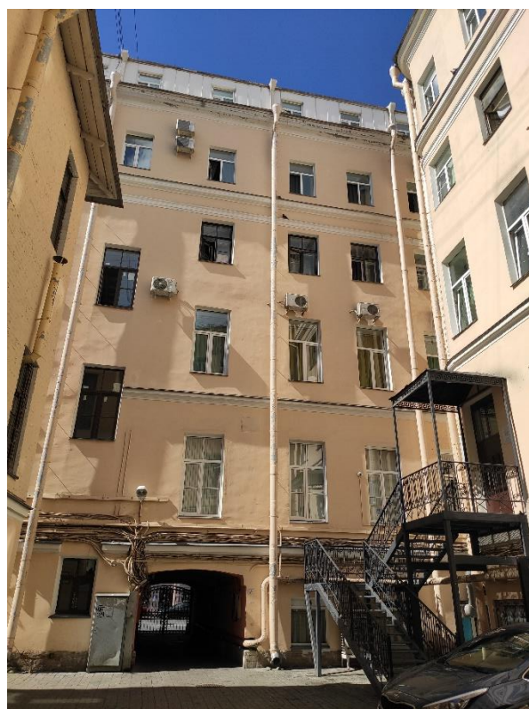
Фото №6. Фрагмент дворовых фасадов. Арочный проезд.
