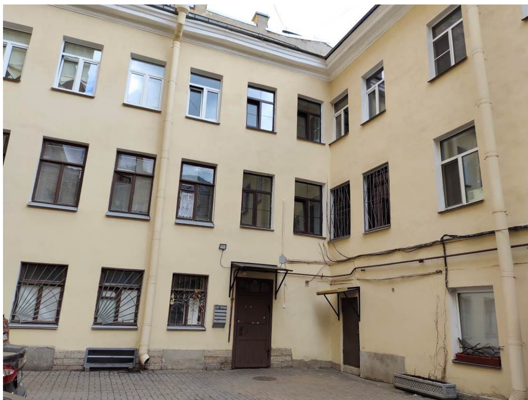
7. Выявленный объект культурного наследия «Дом Капушкина»: Гагаринская ул. 19 лит. А, Гангутская ул.,18. Внутренний двор.
