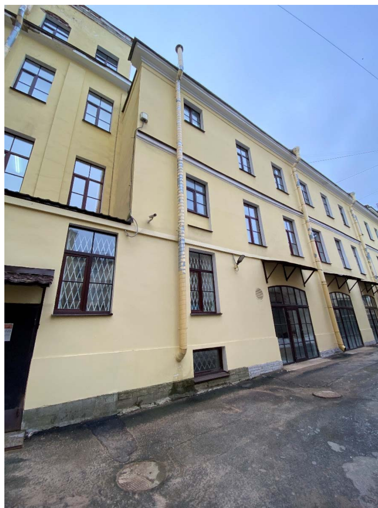
Фото №12. Северо-восточный фасад дворового флигеля, фрагмент.
