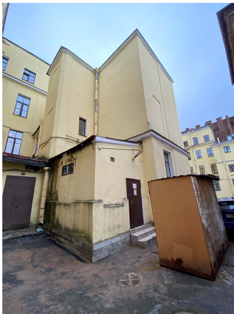
Фото №17. Северо-западный дворовый фасад, трехэтажный объем здания.
