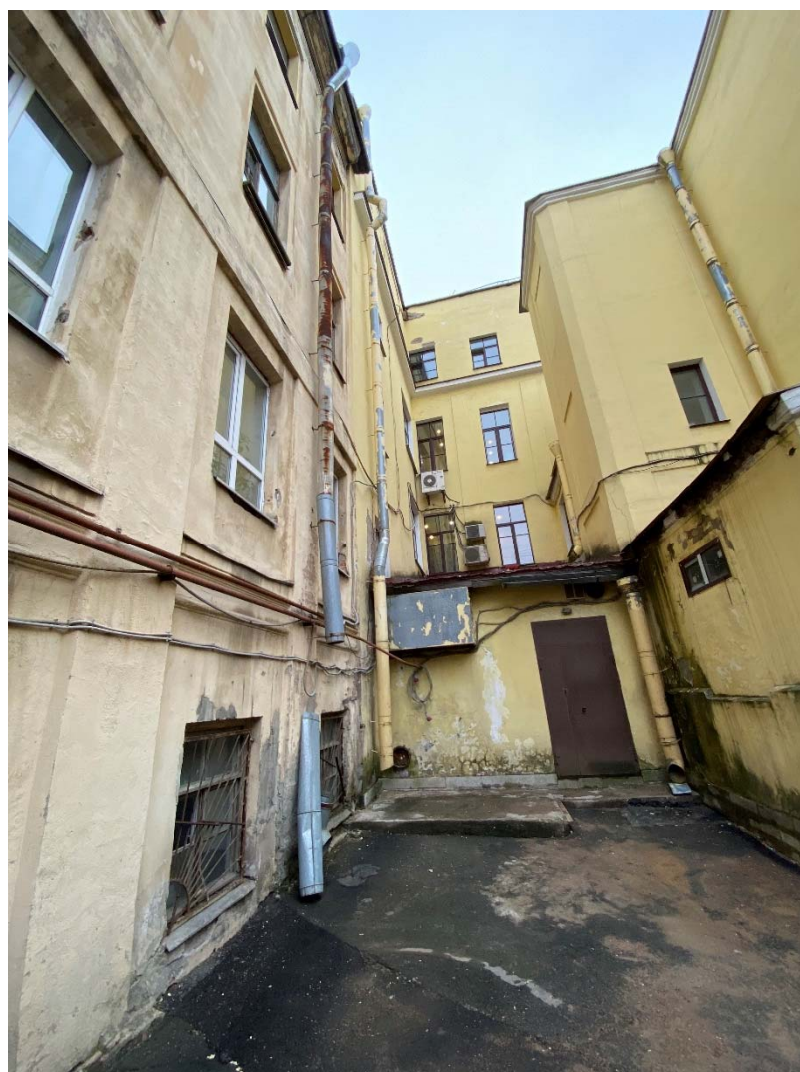
Фото №18. Северо-западный дворовый фасад, поздняя пристройка.
