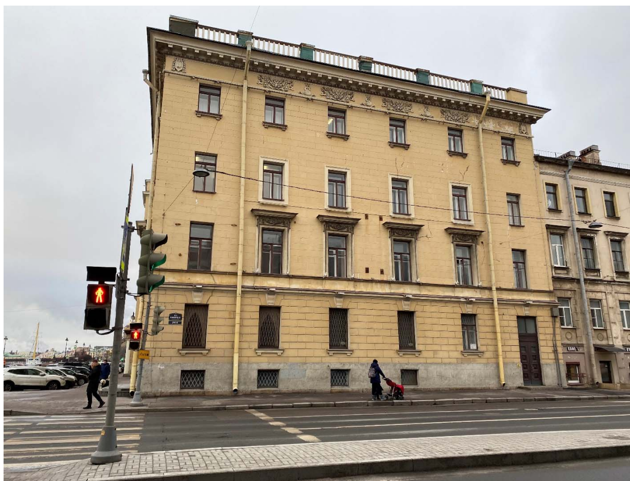
Фото №9. Северо-восточный фасад, общий вид.
