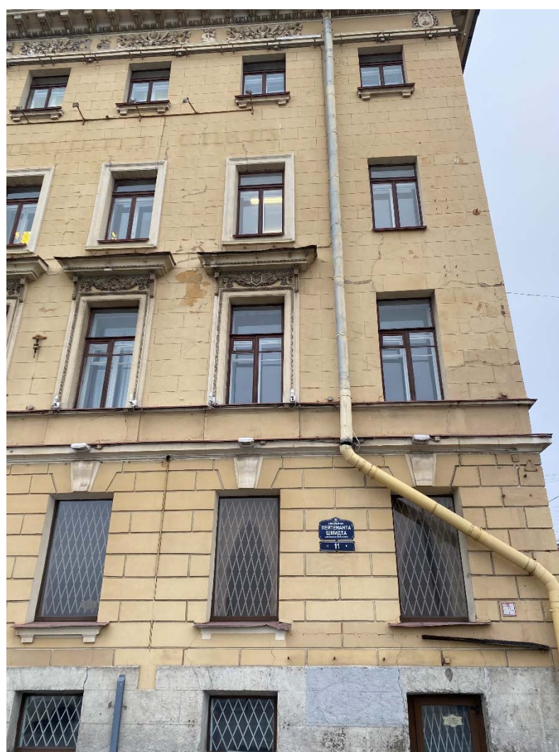
Фото №3. Юго-западный фасад, фрагмент.
