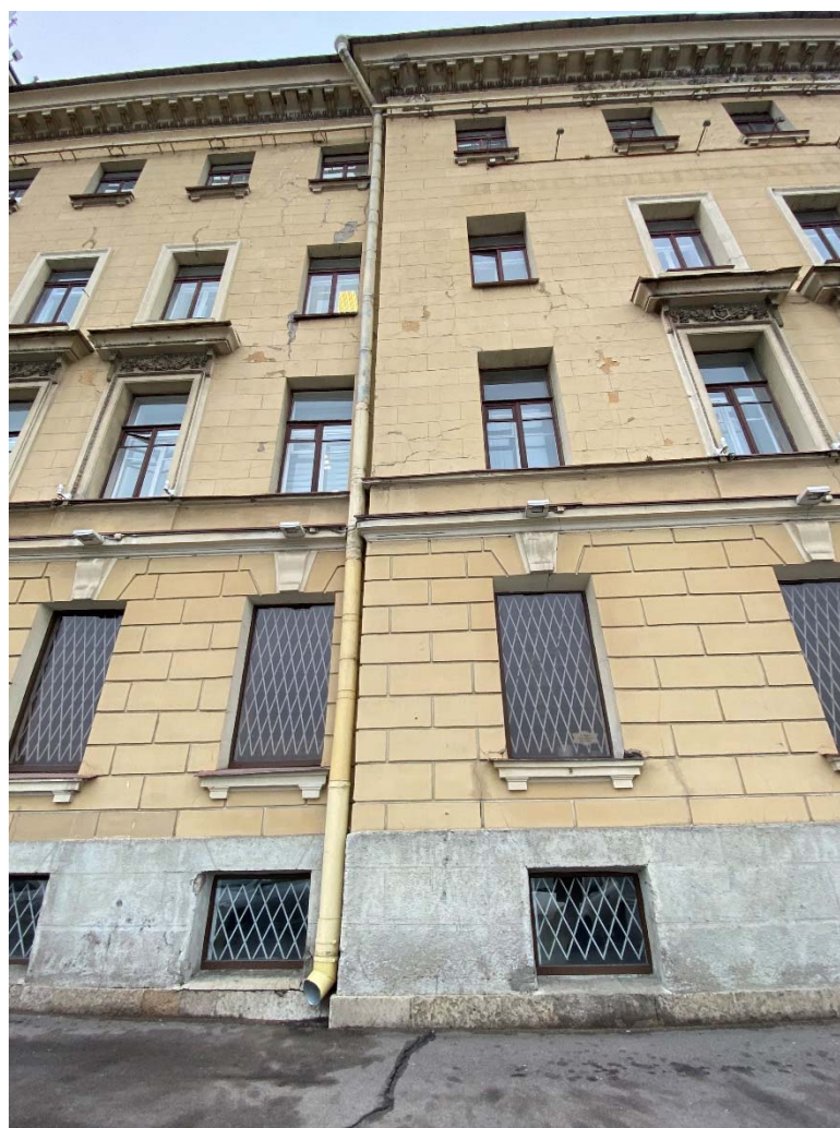
Фото №4. Юго-западный фасад, фрагмент.
