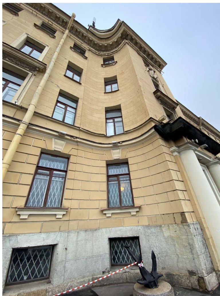
Фото №7. Юго-западный фасад, фрагмент.
