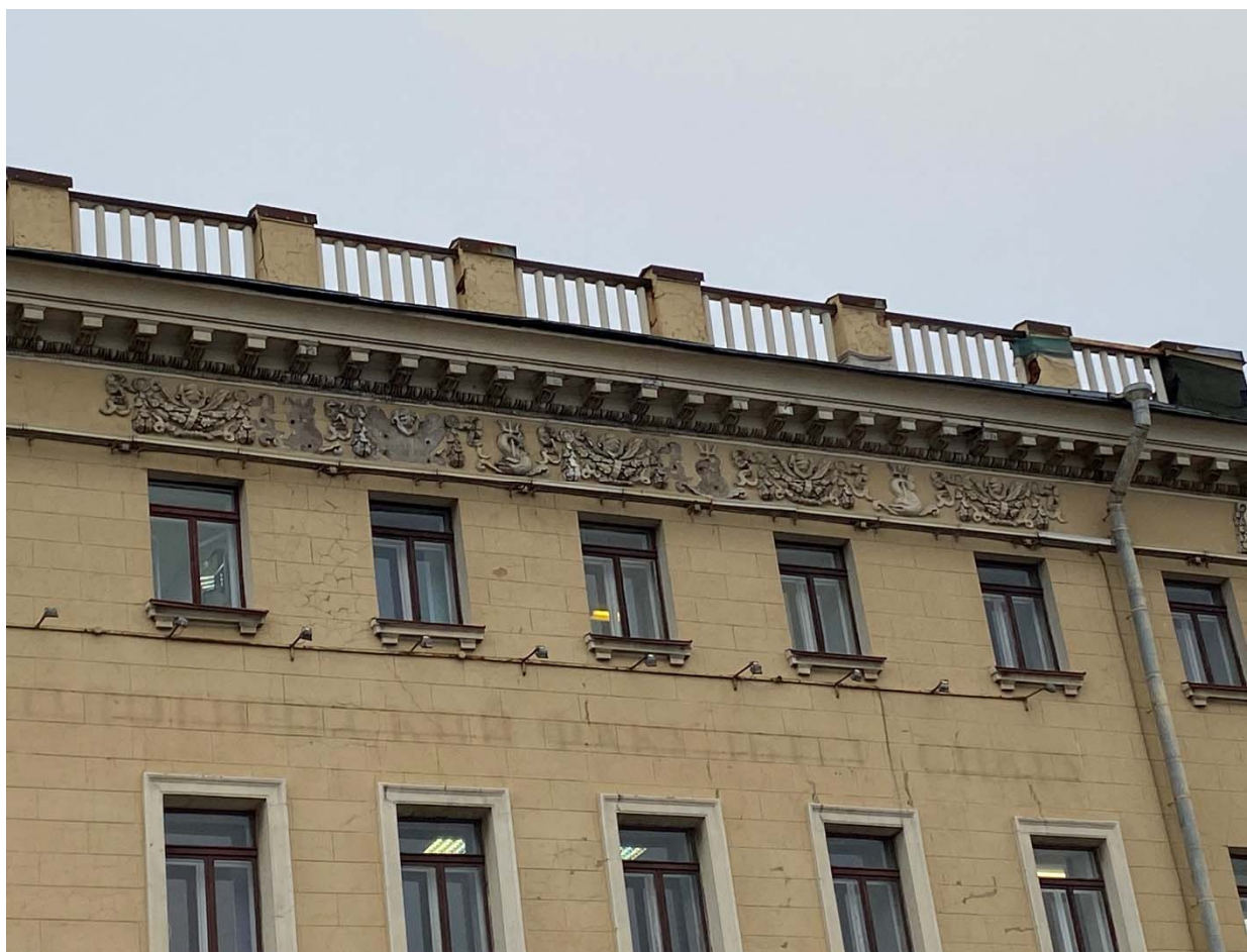
Фото №2. Юго-западный фасад, фрагмент, карнизная часть.
