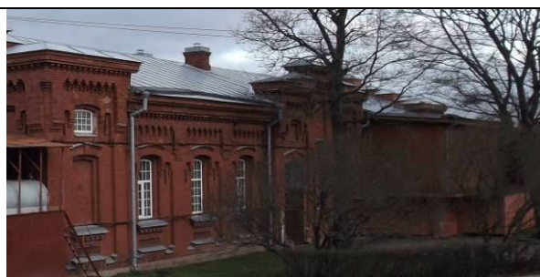
Южный фасад юго-западного корпуса
