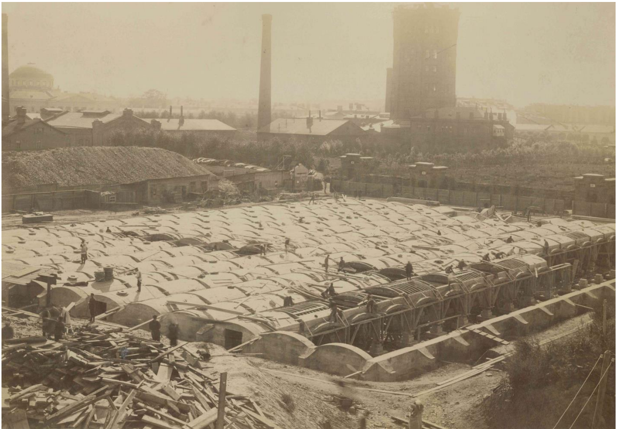
Илл. 5. Строительство фильтров. кон. 1880-х гг.
