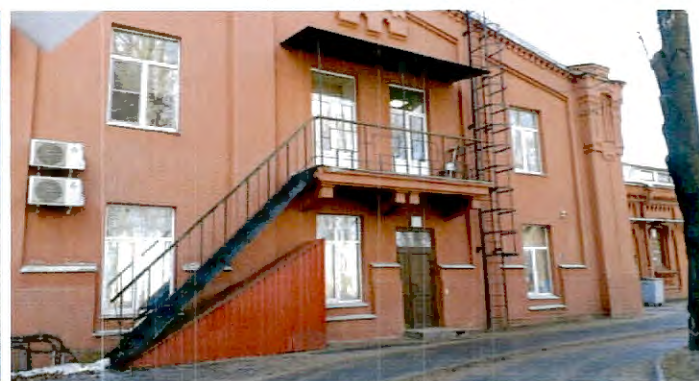
4. Северный фасад здания
