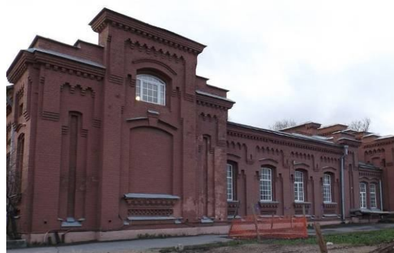
Северный фасад северо-восточного корпуса
