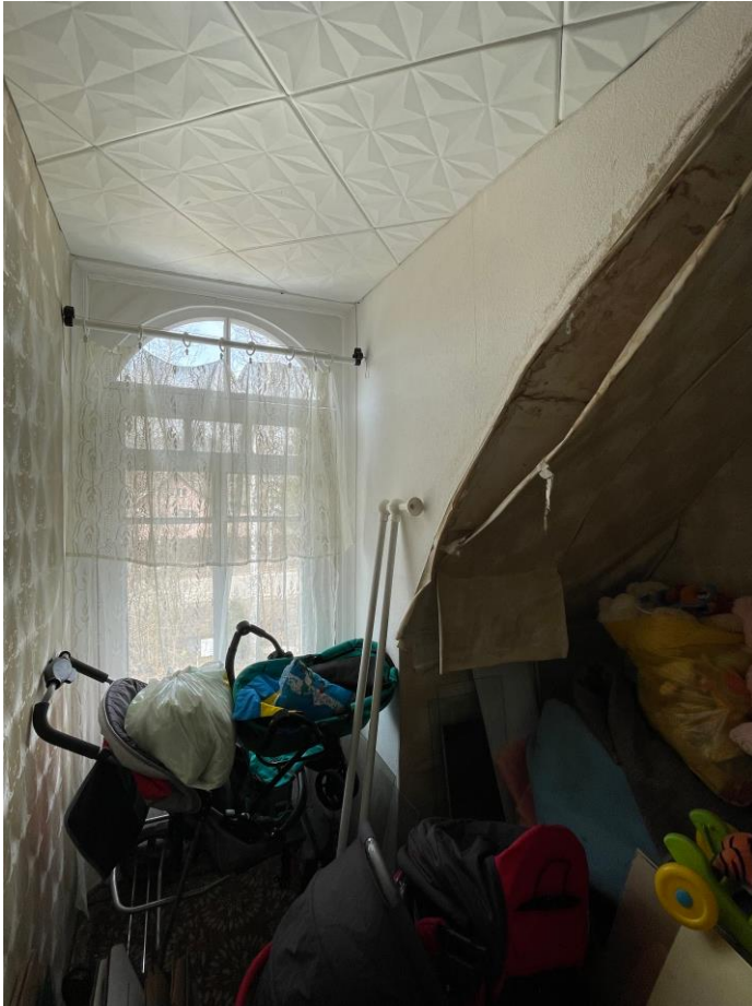
Фото 20. Помещение в объеме мансарды.
