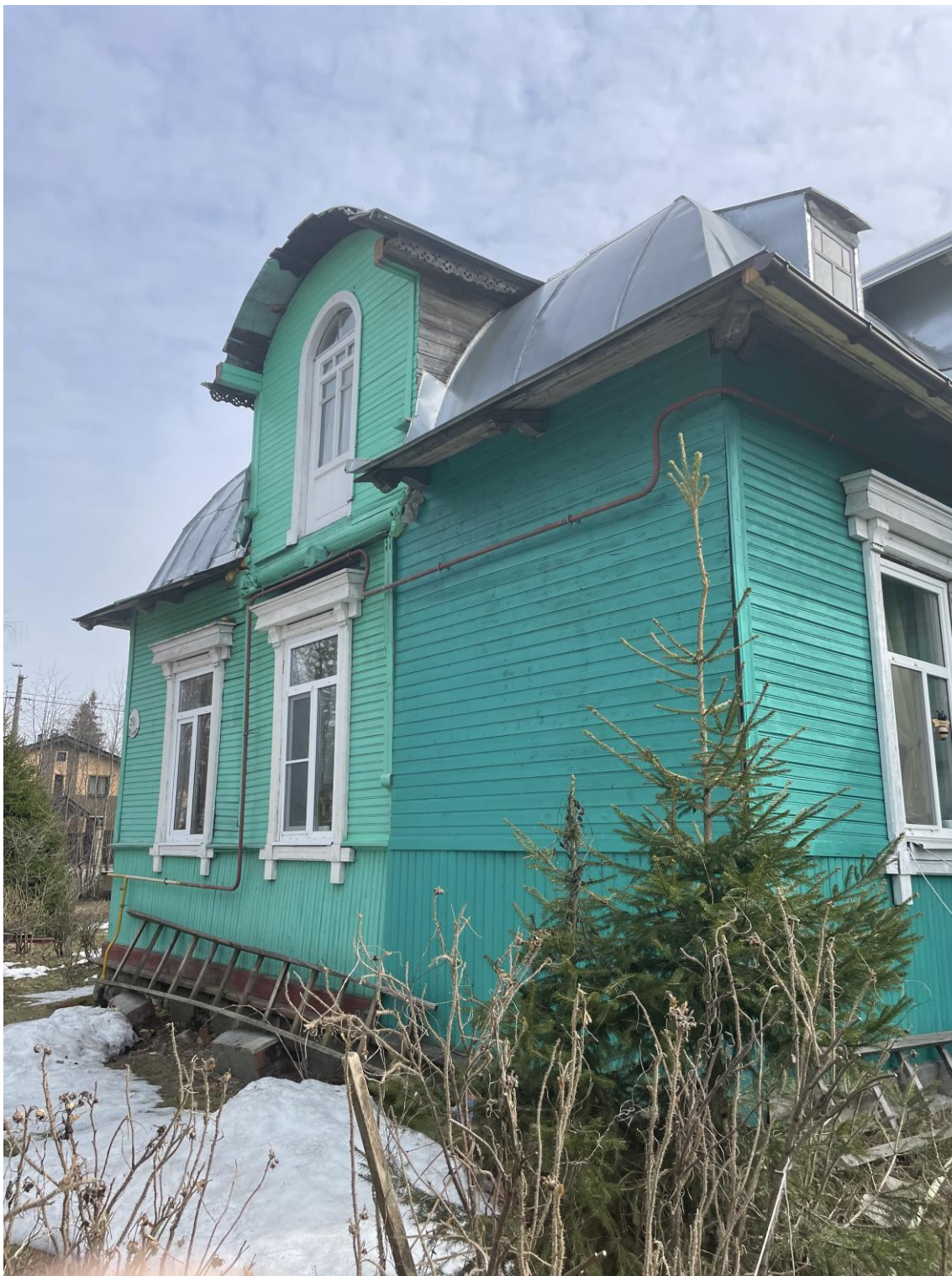
Фото 2. Северо-западный фасад здания.
