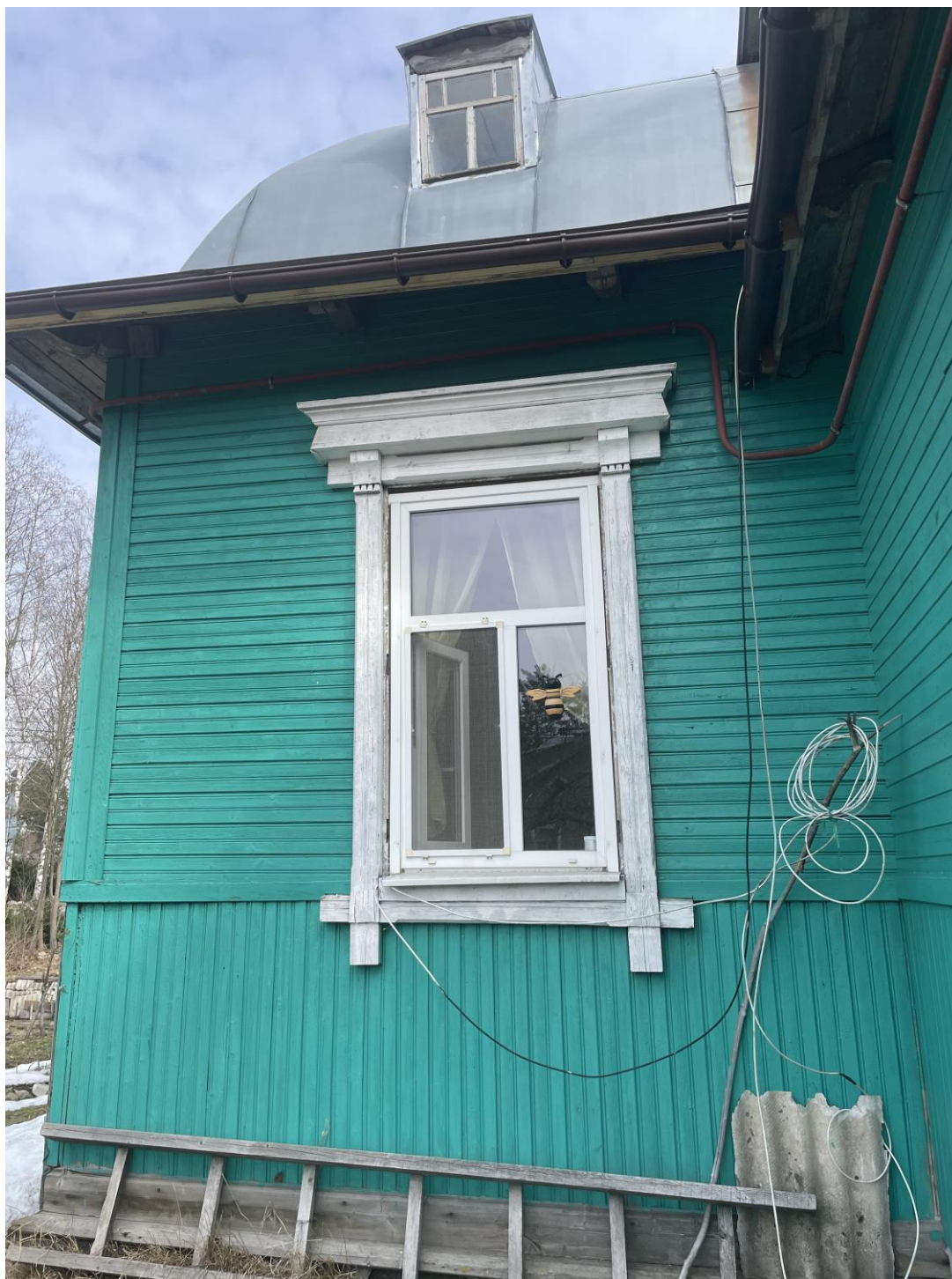
Фото 3. Фрагмент юго-западного фасада.
