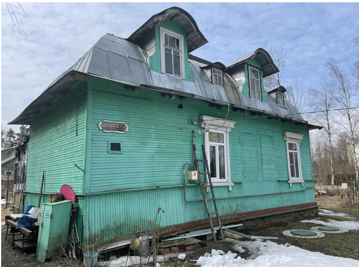
Фото 6. Северо-восточный фасад здания.
