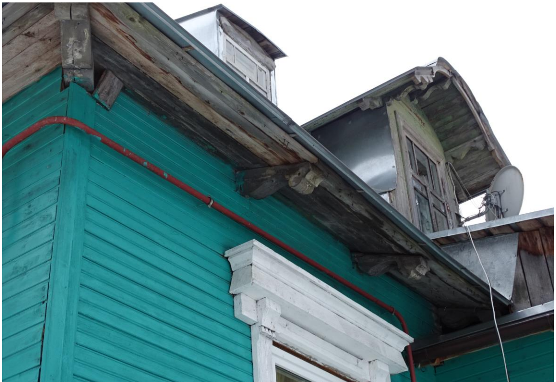
Илл. 36. Юго-западный фасад. Фрагмент. Фотография 2021 г.
