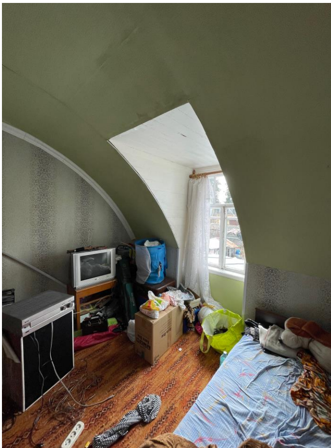
Фото 18. Помещение в объеме мансарды.
