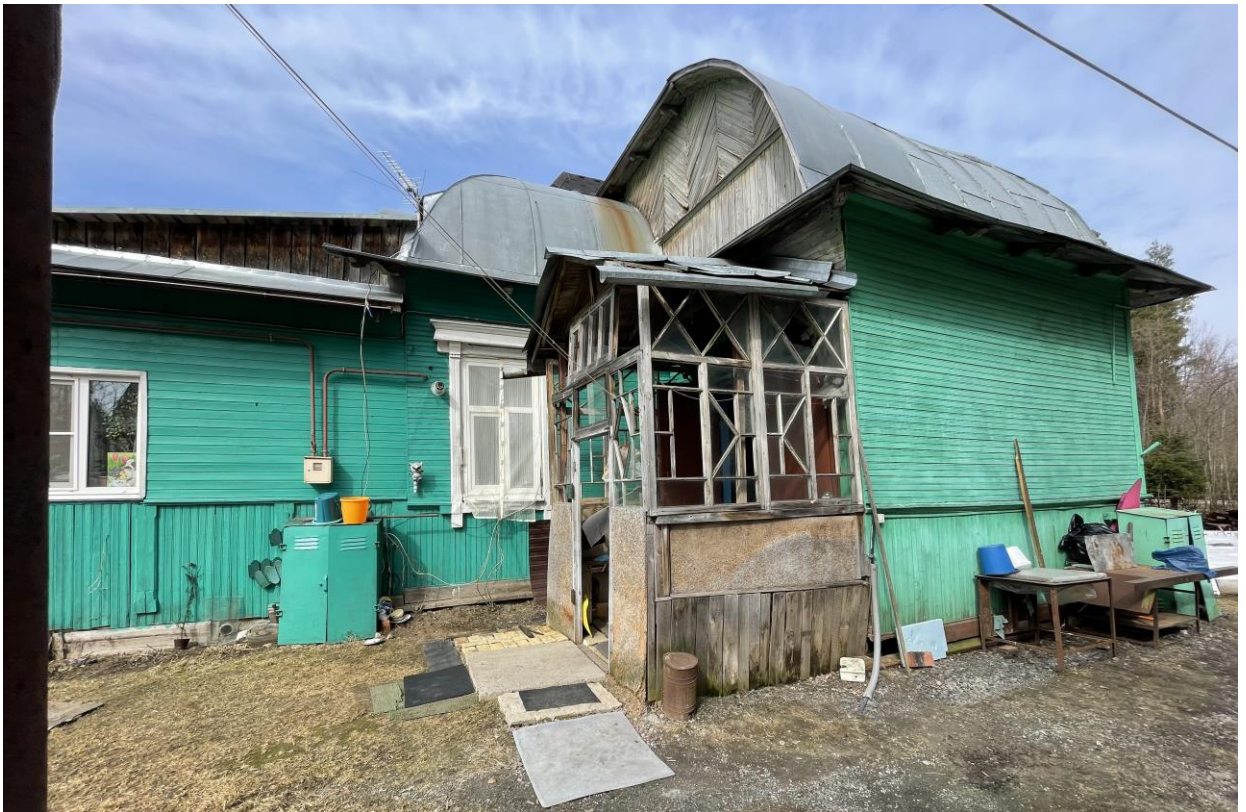
Фото 5. Юго-восточный фасад здания.
