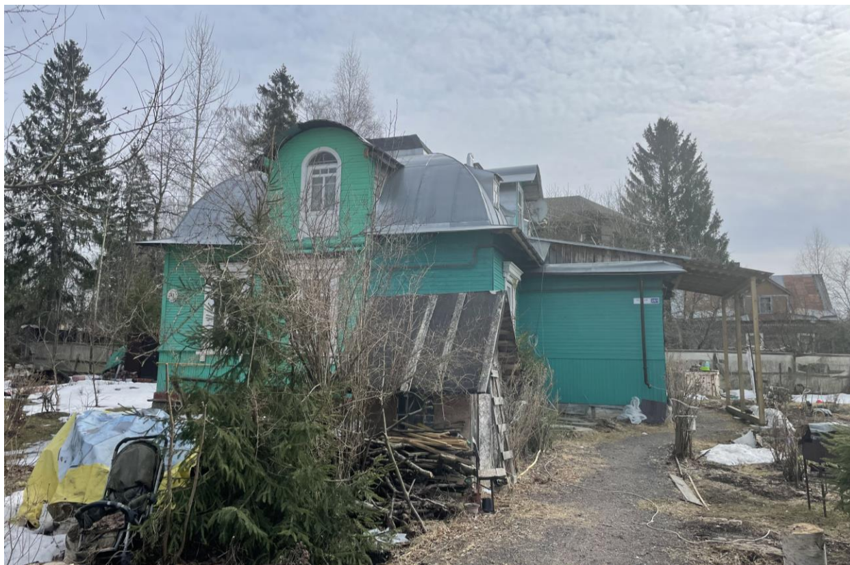
Фото 1. Северо-западный фасад здания.
