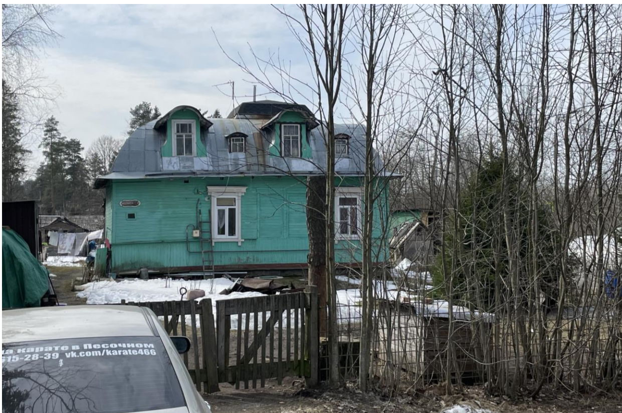
Фото 7. Северо-восточный фасад здания.
