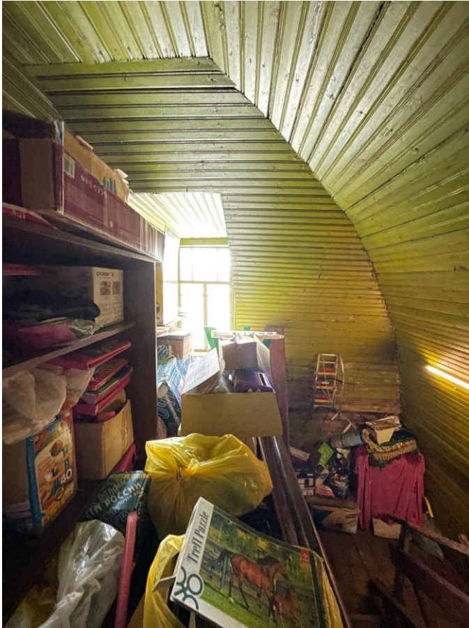
Фото 16. Мансарда. Помещение при лестнице с 1 этажа.
