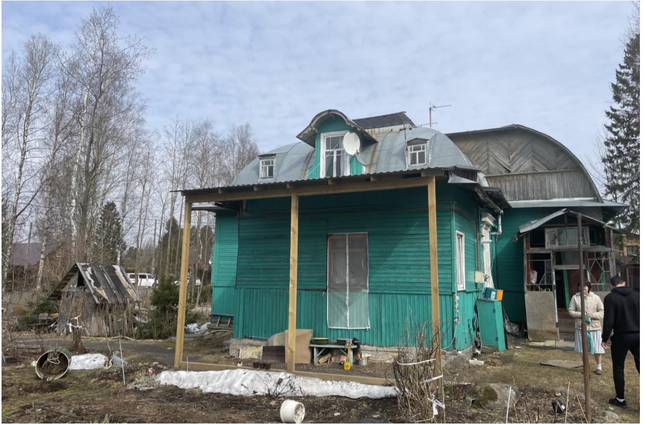
Фото 4. Юго-западный фасад здания.
