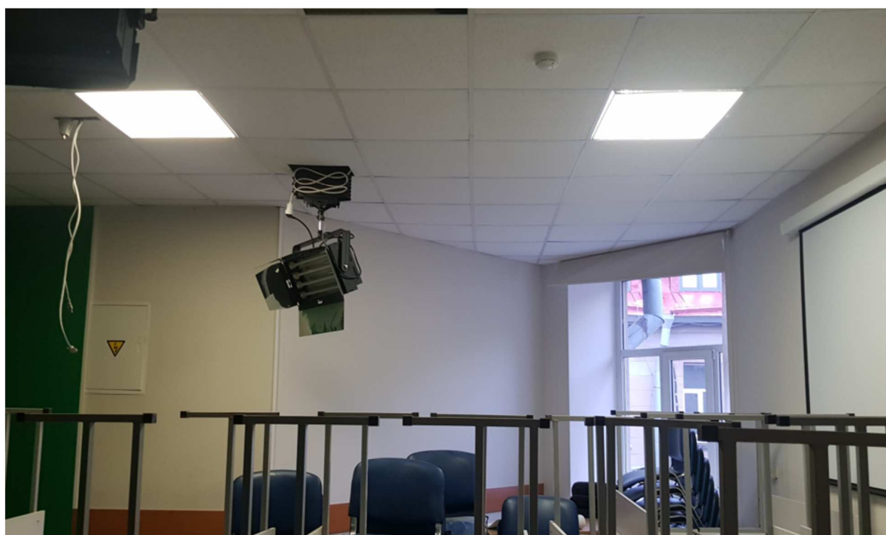
5. 6-й этаж. Помещение северного крыла.
