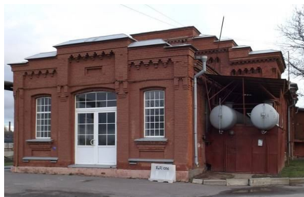
Ризалит западного фасада юго-западного корпуса
