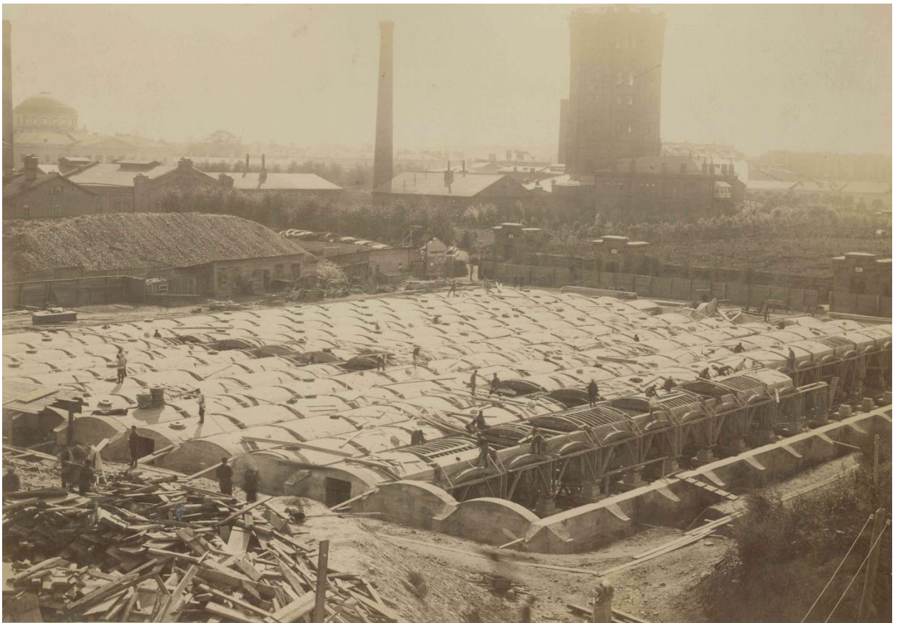
Илл. 7. Строительство фильтров. кон. 1880-х гг.
