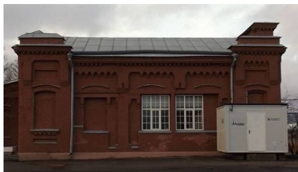
Восточный фасад северо-восточного корпуса
