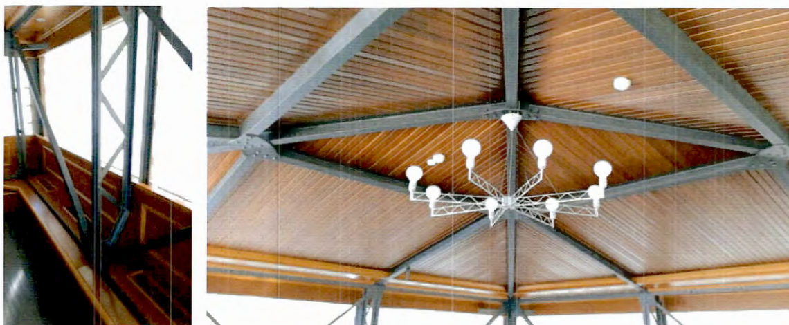
8, 9. Металлический клепаный каркас
